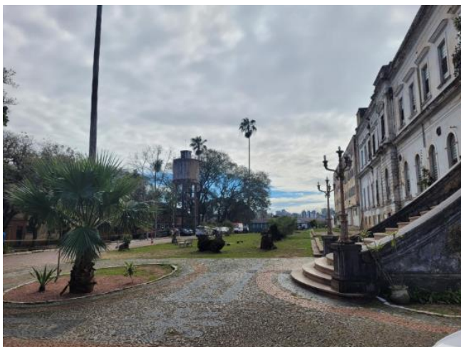
Foto 05: Vista ao lado do prédio tombado na direção norte
