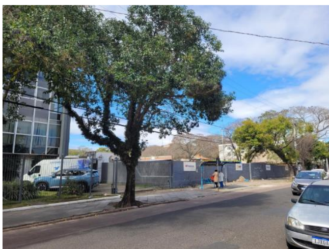
Foto 21: Vista a partir da rua Guilherme Alves, na altura do terreno objeto de solicitação de autorização.
