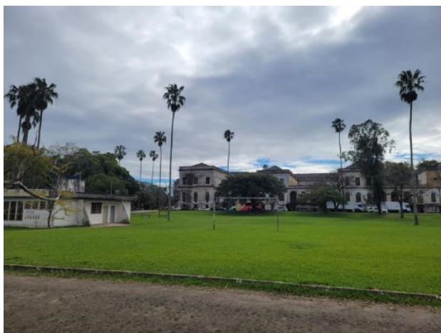
Foto 01: Vista do Hospital a partir da Av. Bento Gonçalves
