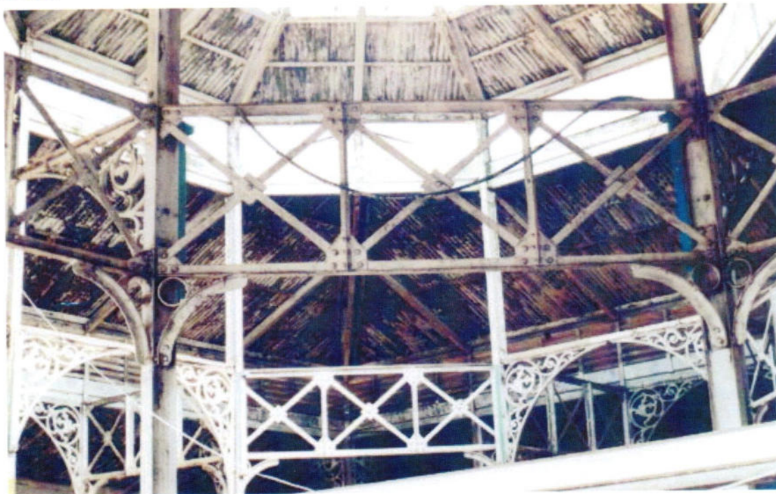
30. Estrutura Metálica de sustentação da cobertura de vidro (Levantamento Cadastral, 2003)
