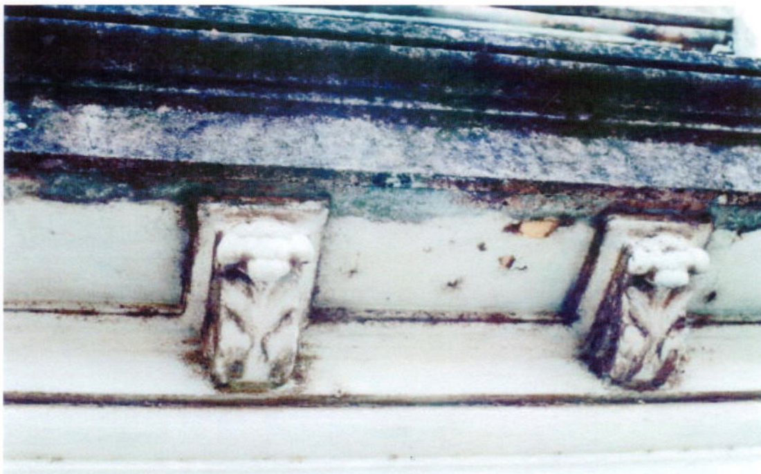
19. Detalhe 2 da Fachada do Mercado (Levantamento Cadastral, 2003)
