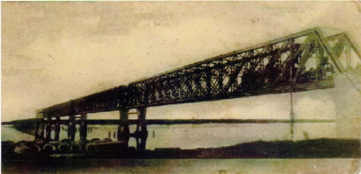
11. Ponte sobre o Rio Ibicuí em 1929 (Fonte: http://www.fotostar.hpg.com.br )
