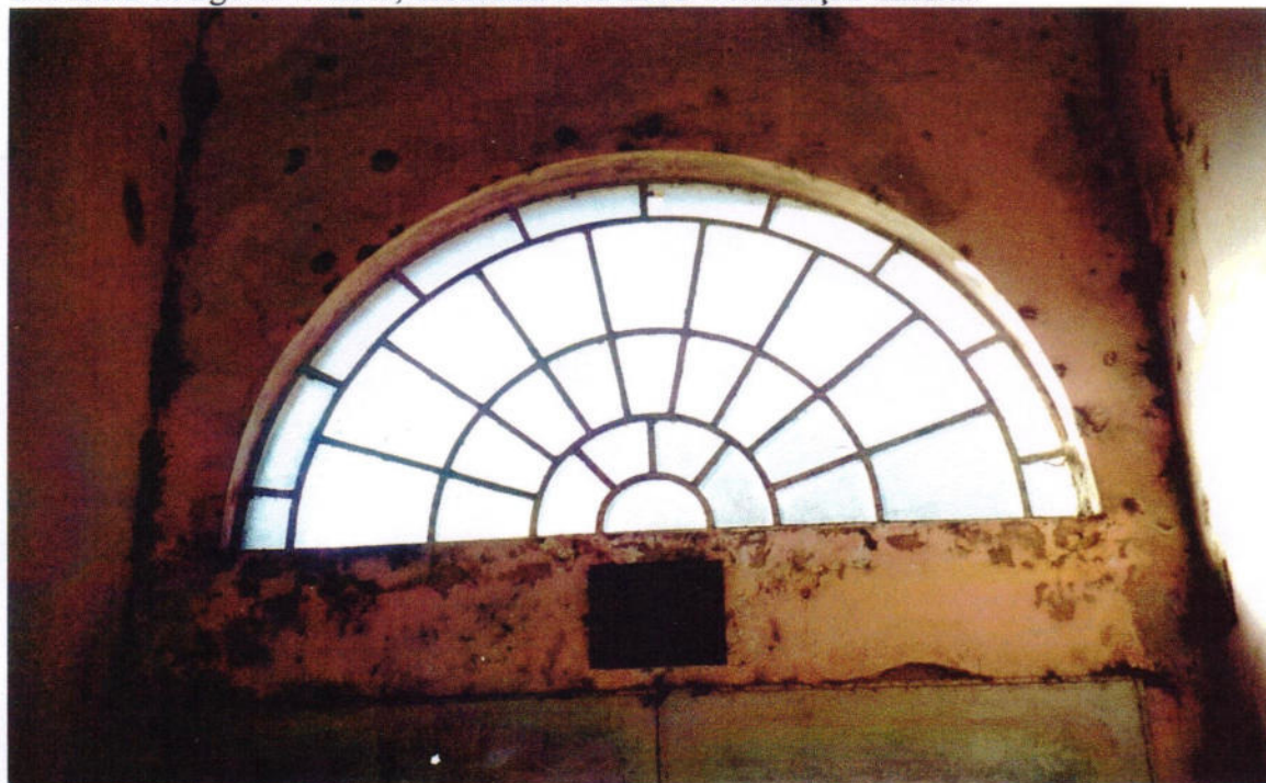
Elemento translúcido localizado no hall de entrada do acesso principal
