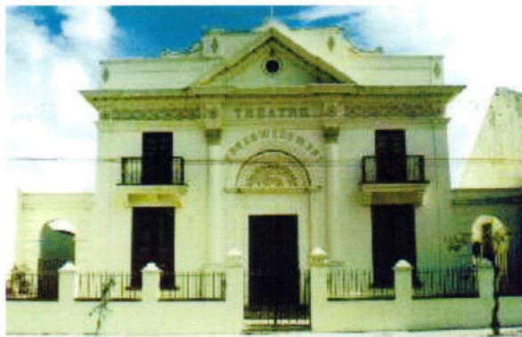
14. Vista atual do Theatro Prezewoodski, após restauração
