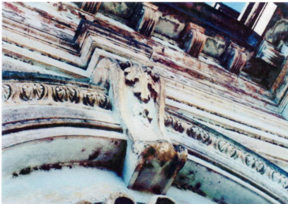
18. Detalhe da Fachada do Mercado (Levantamento cadastral, 2003)
