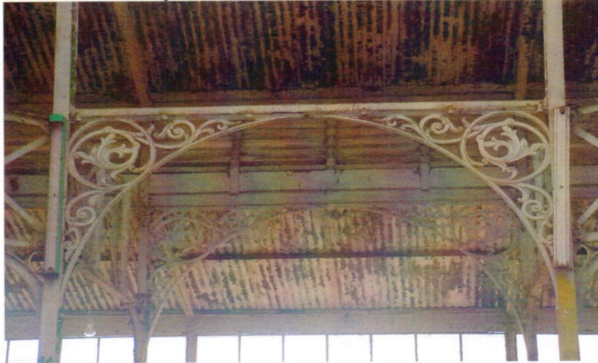
28. Detalhe da Estrutura Metálica de Sustentação da Cobertura do Mercado (Levantamento Cadastral, 2003)
