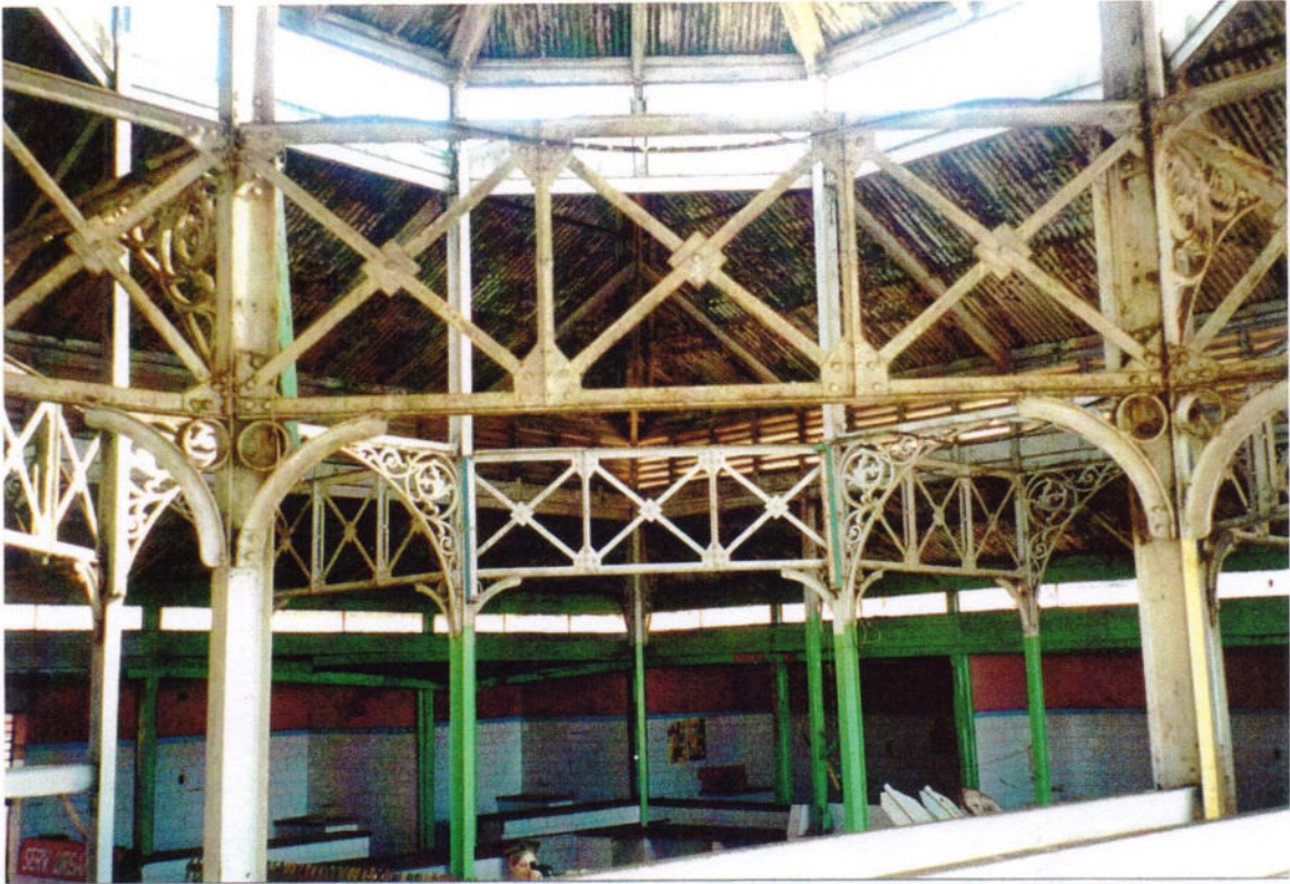
Estrutura metálica octagonal que sustenta a cobertura da área central.
