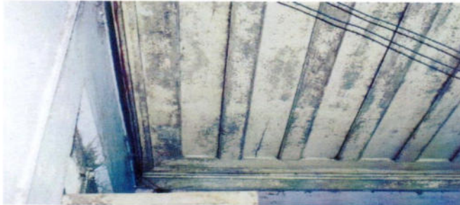
24. Detalhe de forro interno (Levantamento Cadastral, 2003)
