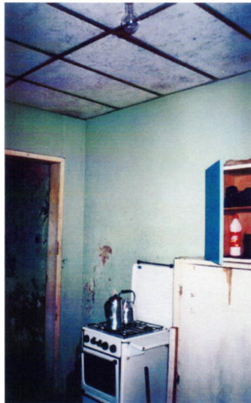
23. Detalhe de forro pacote (Levantamento Cadastral, 2003)
