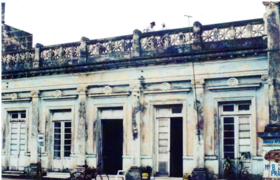
27. Trecho da Fachada Sul do Mercado, com o detalhe das portas (Levantamento Cadastral, 2003)
