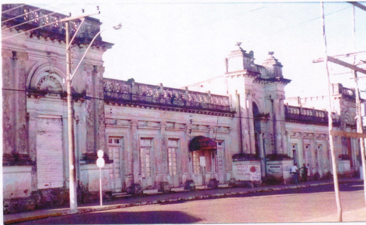
Fachada com acesso principal - Fachada Sul
