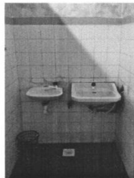
2 Segundo Pavimento - Sanitário Feminino
