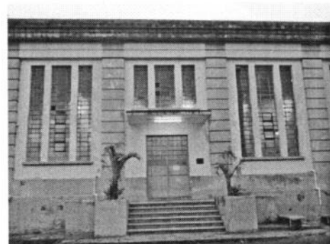
5 Prédio do Ginásio - Fachada Noroeste
