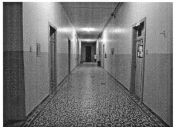
4 Terceiro Pavimento - Circulação
