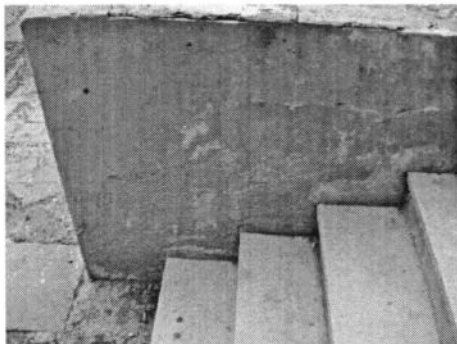
4 Ginásio - Detalhe do degrau da escada secundária
