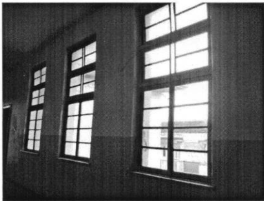
1 Terceiro Pavimento - Esquadrias da circulação
