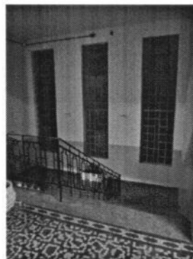
2 Terceiro Pavimento - Vista da escada principal
