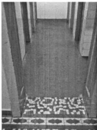
3 Segundo Pavimento - Sanitários
