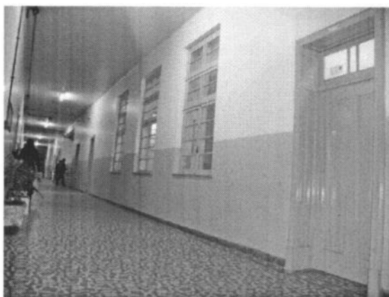
3 Segundo Pavimento - Circulação e esquadrias
