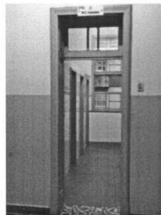
4 Segundo Pavimento - Sanitário feminino
