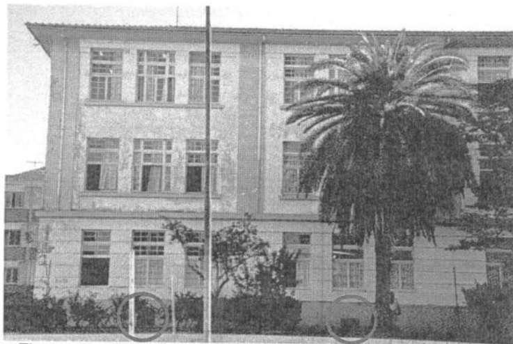
Figura 42 – Localização das gateiras na base da edificação. FONTE: a autora, 2011.
