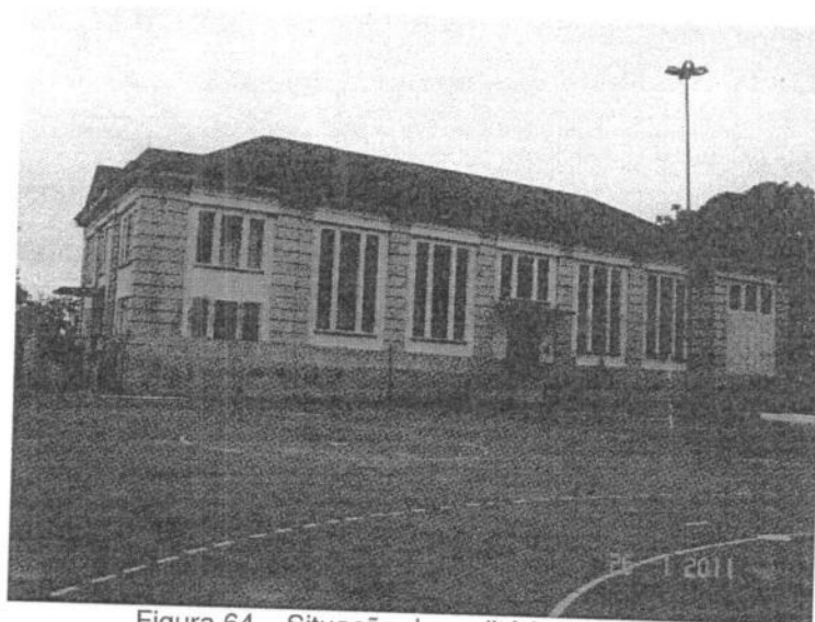
Figura 64 – Situação do auditório em 2011. FONTE: a autora, 2011.
