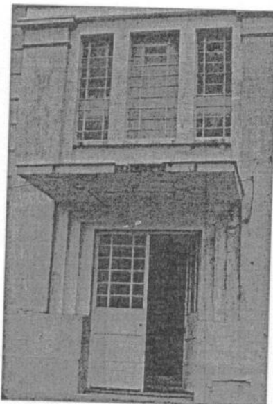
Figura 55 – Aberturas: uso de caixilhos de ferro e vedação em vidro. FONTE: a autora.
