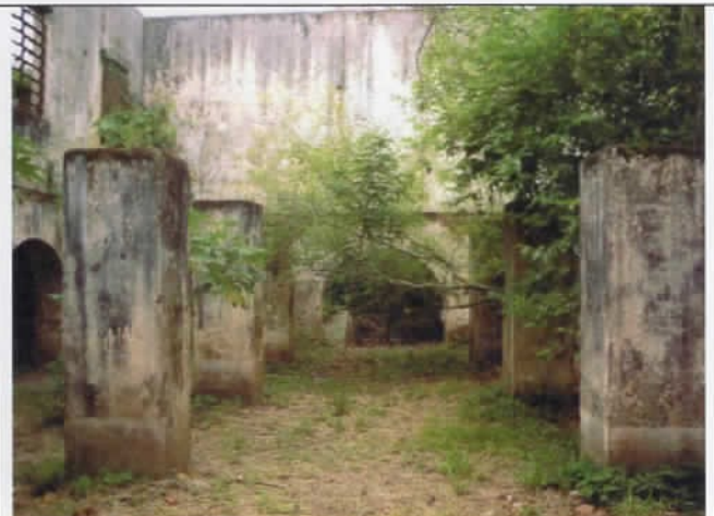
Foto interna da Casa da Guarda.
