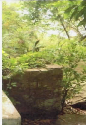
Construção de tijolos
