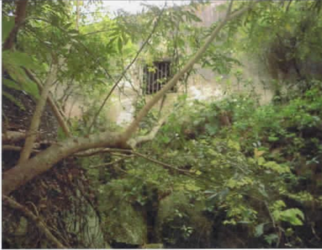
Parede posterior do prédio do presídio.
