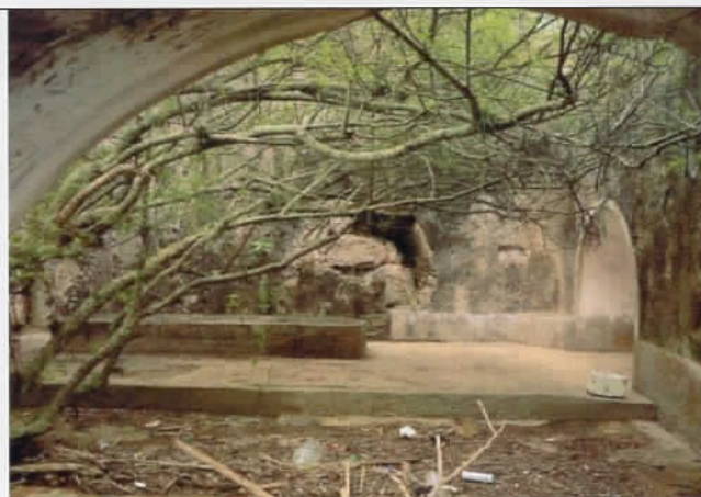
À direita, acesso à parede supramencionada.
