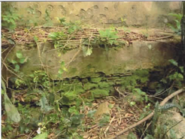
Imagem da parede lateral externa do presídio.
