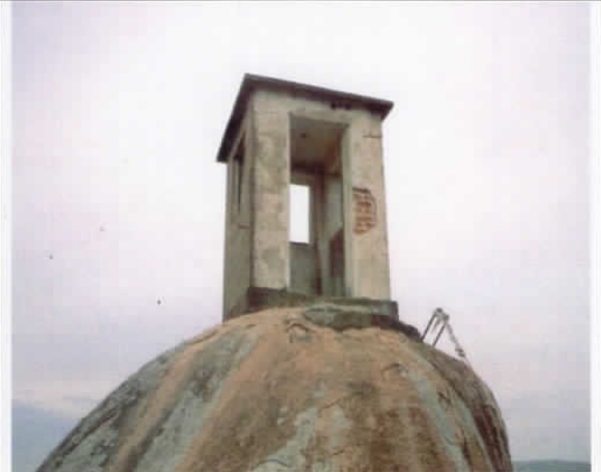
Guarita também localizada à direita desta edificação.
