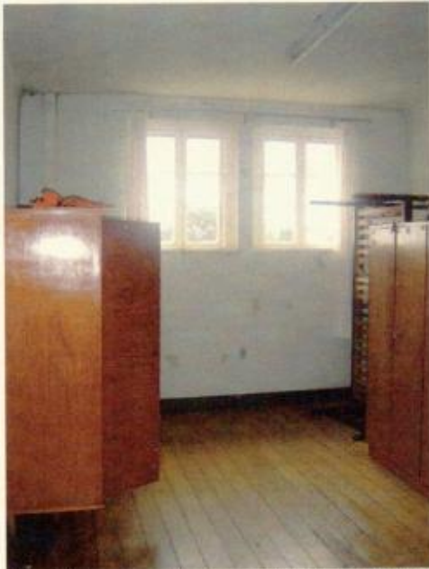
Sala 325 – assoalho de madeira, pintura descascada e manchas de umidade nas paredes
