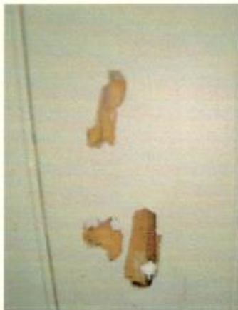
Detalhe ação dos cupins – na parede e no assoalho
