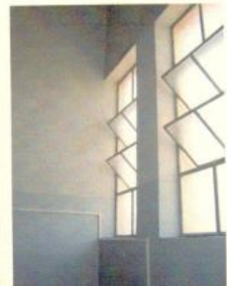
janelas em perfis metálicos
