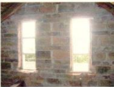
Tijolos portantes e originais compõem a parede que serve de um dos frontões pequenos da fachada principal
