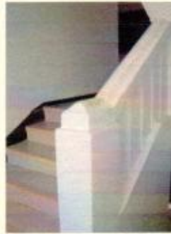
Guarda-corpo de alvenaria
