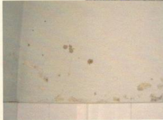
Estar/Jantar – apartamento para estudantes – acesso pelo lado direito da escada – sinais de umidade
