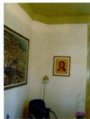
Parede com chanfro e forro de estuque
