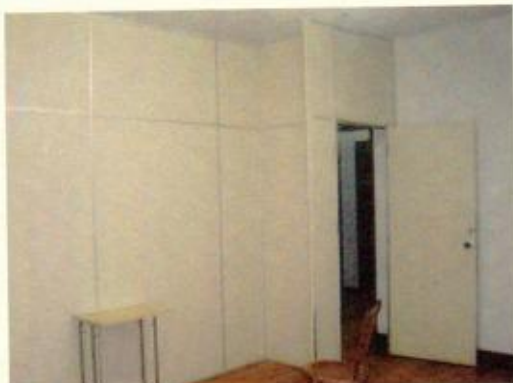
Sala 328 – Divisórias Navais para compartimentar os espaços – umidade no teto e paredes
