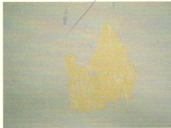
Sala 308 – paredes- da direita em alvenaria e da esquerda em madeira – Pintura descascada
