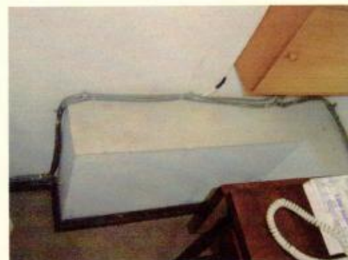
Sala 367 – reforço da estrutura
