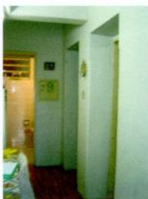
Paredes com 45 cm de espessura
