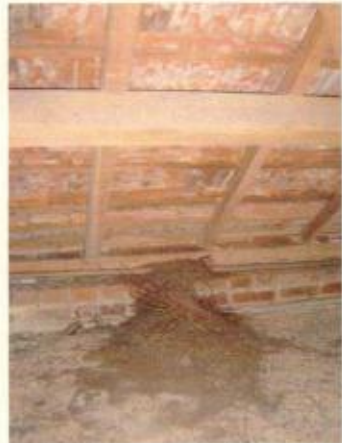
Estrutura do telhado em bom estado Acúmulo de sujeira indicando que há vazamentos no telhado
