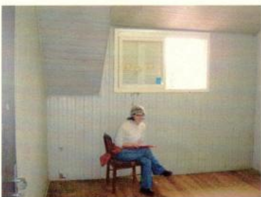
Sala 304 – detalhe caimento do telhado
