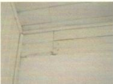
Sala 306 – parede de alvenaria e madeira – Rachadura na parede de alvenaria do lado esquerdo do quarto
