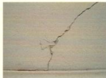
Sala 306 – parede de alvenaria e madeira – Rachadura na parede de alvenaria do lado esquerdo do quarto
