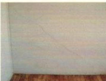
Sala 306 – parede de alvenaria e madeira – Rachadura na parede de alvenaria do lado esquerdo do quarto
