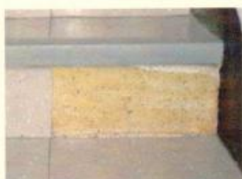
Detalhe piso original de granitina
