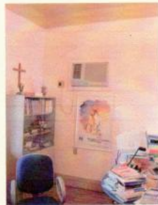
Aparelho de ar - condicionado
