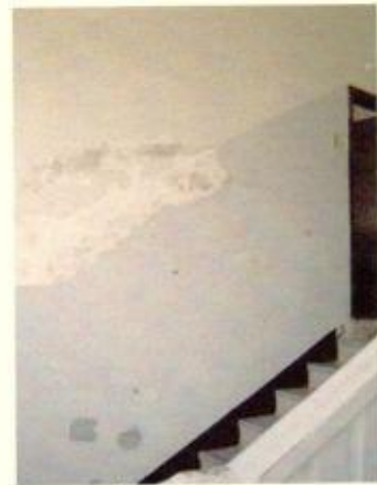
Pintura descascada
