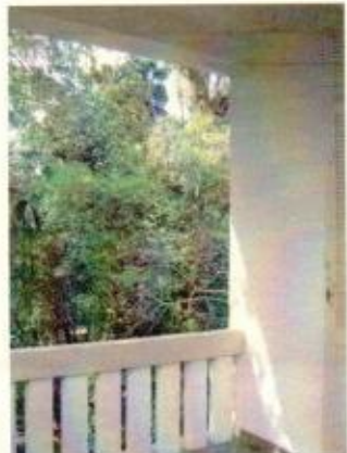
Varanda 2º pav. – guarda-corpo em alvenaria
