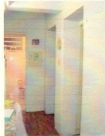
Paredes de 45 cm
