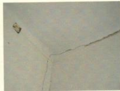
Rachaduras rentes às canaletas e que se prolongam – assoalho em madeira
