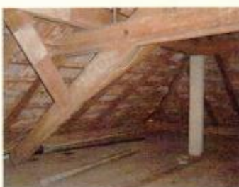
Estrutura de madeira
