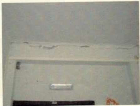
Corredor que dá para o Centro Diretivo/EST Detalhe canaletas e rachaduras Acesso ao Arquivo Histórico
