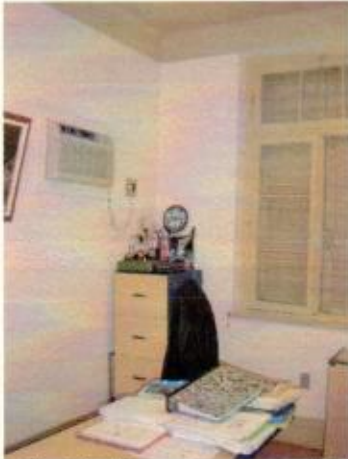
Sala Administração – ar condicionado
