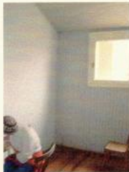
Sala 315 SUL- forro de madeira -paredes da esquerda em alvenaria e da direita em madeira
