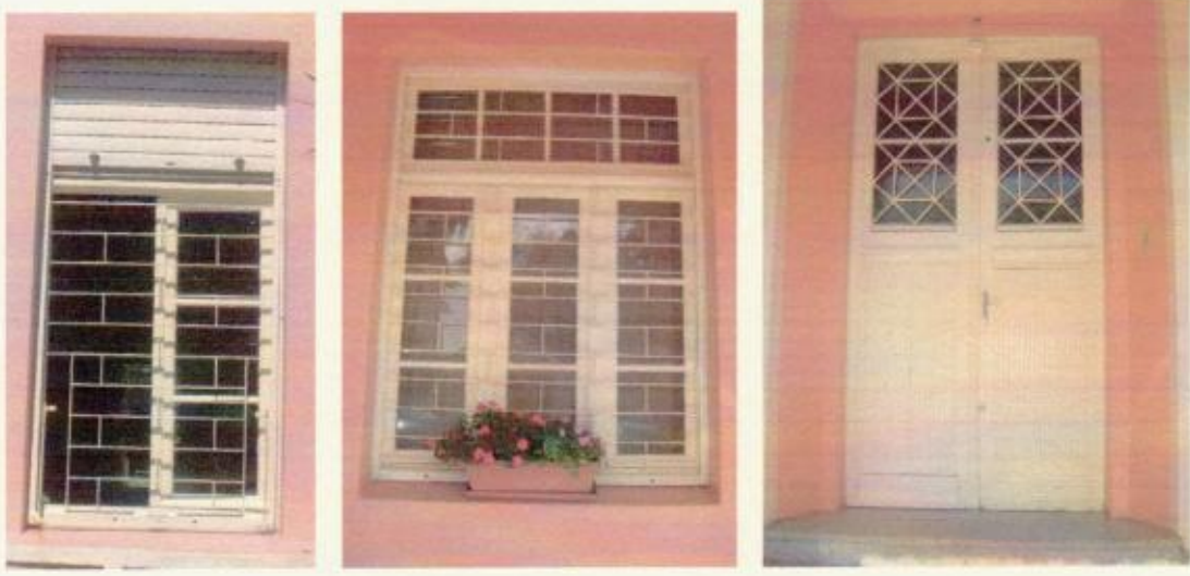
Esquadrias originais em madeira – Foto agosto 2005
