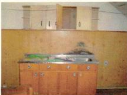
Cozinha SUL- com revestimento de madeira retendo a umidade exercida pelo uso da pia – piso danificado
