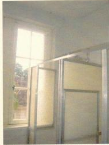
Banheiro com acesso a partir da sala 323 – os perfis do box ficam aparentes na fachada principal do prédio
