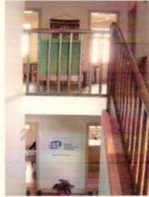
acesso ao 2º pav.
