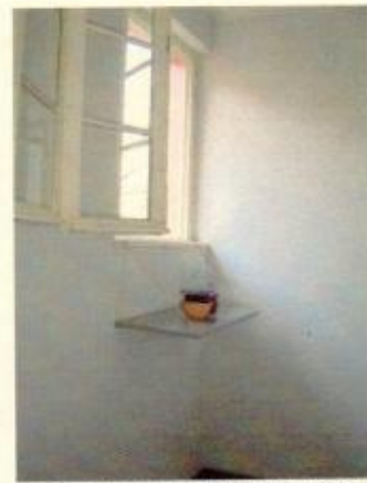
Corredor interrompido por parede do depósito do Arq. Histórico
