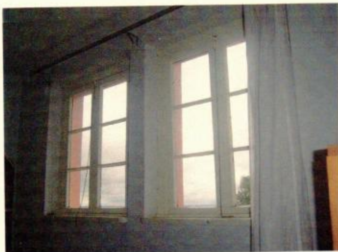
Sala 322 – janelas em bom estado
