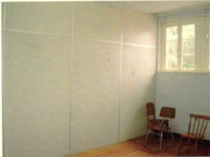
Sala 327 – Divisórias Navais – assoalho de madeira – teto irregular
