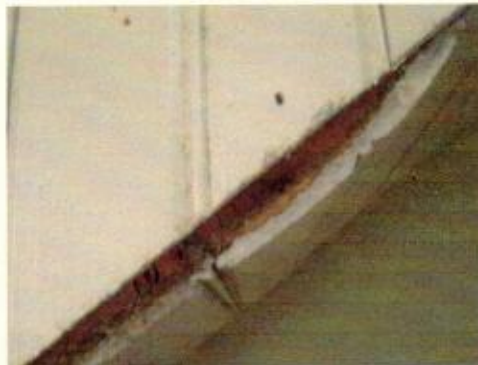
Detalhe da ação do tempo na madeira
