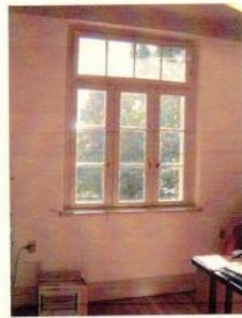
Janela com abertura superior
