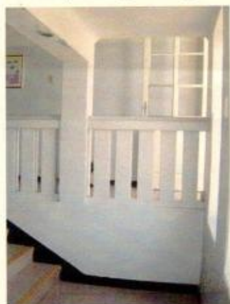
Guarda-corpo do corredor
