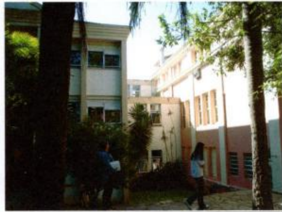
Fachada lateral direita, possuindo elemento de conexão com a biblioteca
