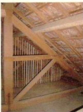
Detalhe tesoura em bom estado
