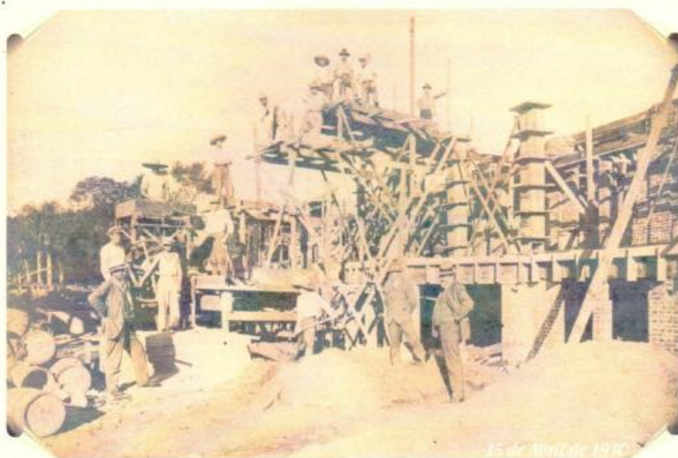
15 de Abril de 1940 formas de concreto para pilares do antigo refeitório
