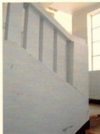
Alvenaria rachada
