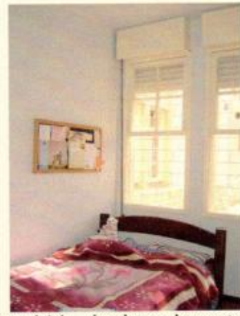
Dormitório – janelas em bom estado
