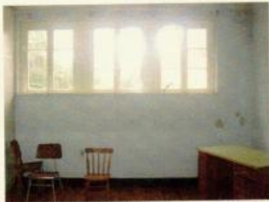
Sala 327 - Manchas e descascamentos na parede - umidade
