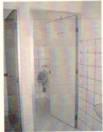
Parede de gesso com perfis de alumínio – parte superior em vidro
