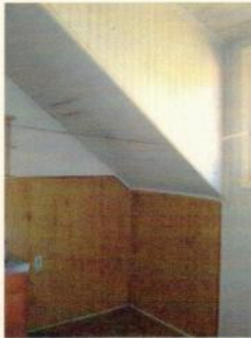
Cozinha SUL- madeira das paredes com cupins e pintura descascadas – portas abrem para dentro dos espaços
