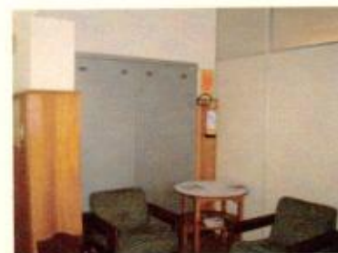
Divisória Naval dividindo espaços
