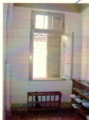
Janela em perfeito estado
