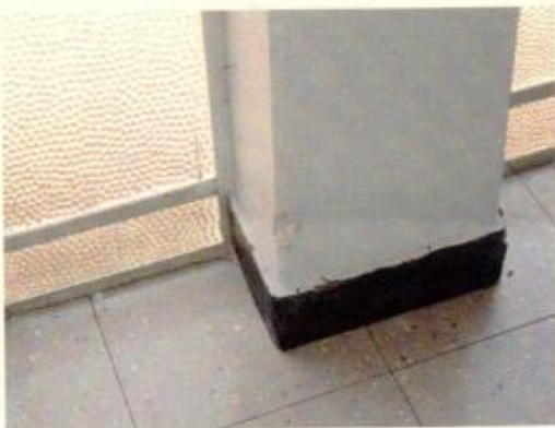
Alvenaria descascada
