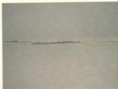
Rachaduras rentes às canaletas e que se prolongam – assoalho em madeira
