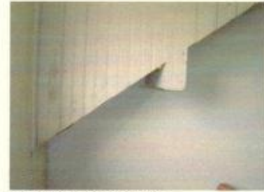
Caimento do telhado
