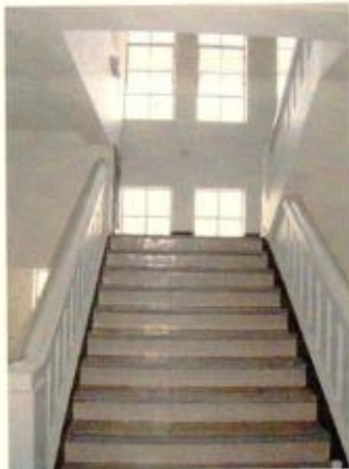
Escada de acesso ao 4º pav
