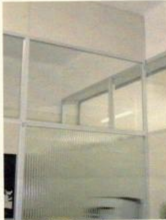
Divisórias Navais com bandeiras fixas em vidro
