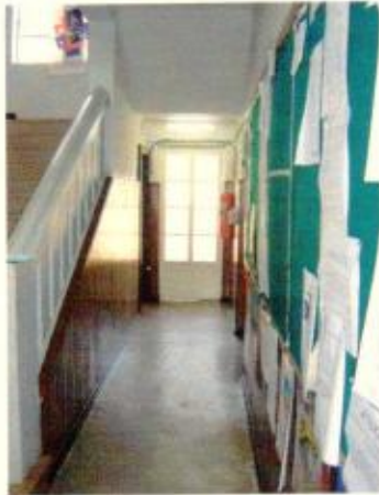
Corredor de acesso à rua
