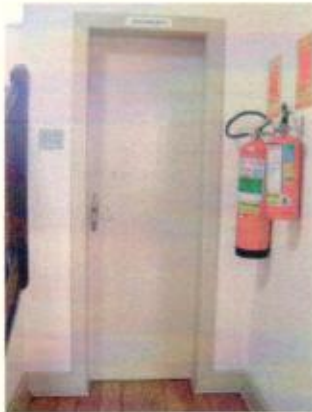
Abertura de acesso ao banheiro
