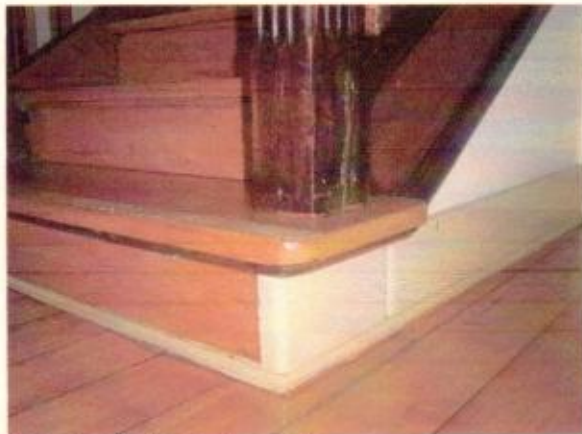
Detalhe do degrau da escada
