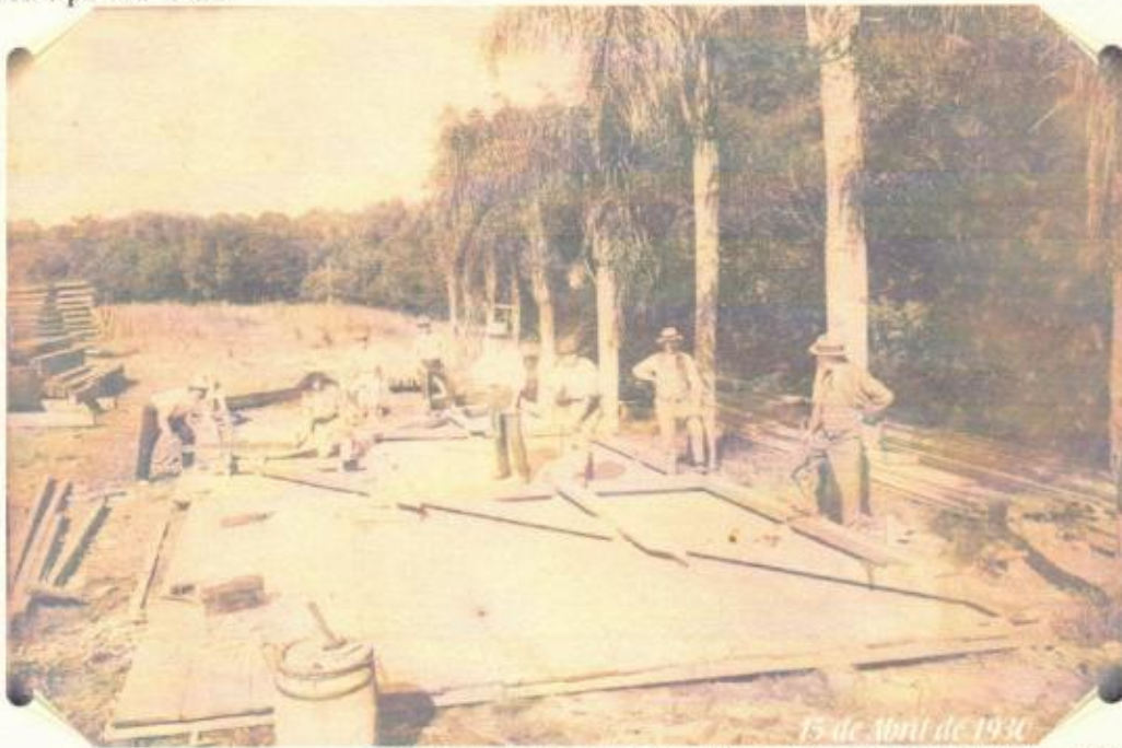
construção das tesouras de madeira - foto Arquivo Histórico IECLB
