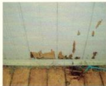
Detalhe ação dos cupins – na parede e no assoalho
