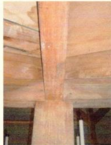
Detalhe encaixes da estrutura
