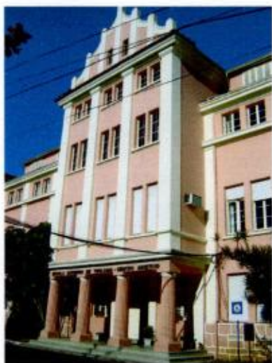
Volume central com pórtico no térreo
