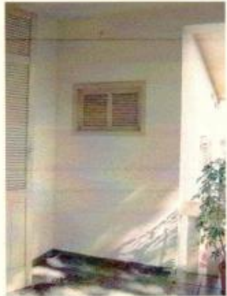
Grelha de madeira- depósito
