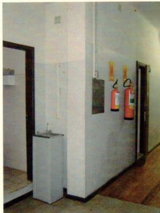
Bebedouro – Extintores – Central de distribuição de energia
