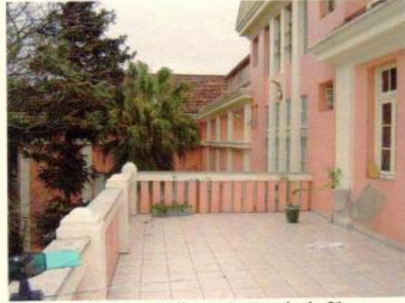
Terraço do 3º pavimento – guarda-corpo em alvenaria, piso cerâmico semelhante à varanda do 2º pav.
