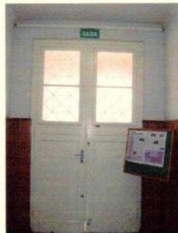
Porta principal de acesso
