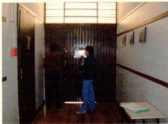
Porta de acesso à sala multimídia
