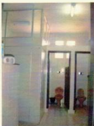
Banheiro com divisória navais
