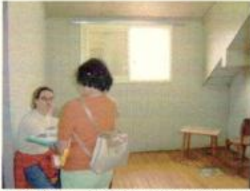
Sala 307 – paredes em alvenaria e madeira
