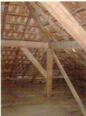
Madeiramento do telhado em bom estado de conservação
