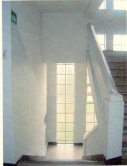
Detalhe do depósito embaixo da escada do 3º pav
