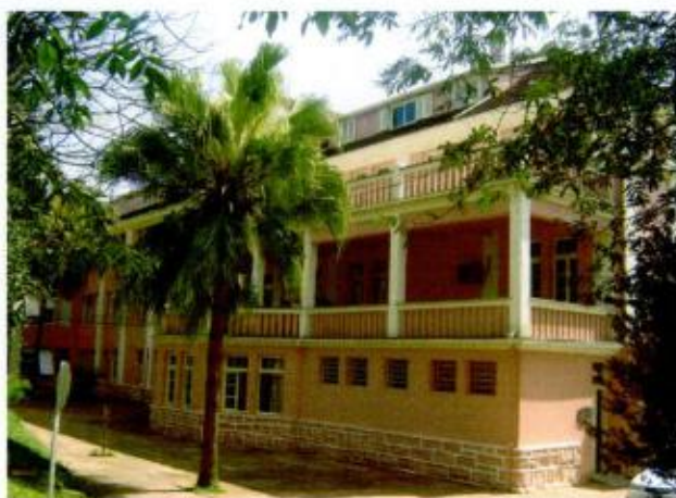
Terraço coberto no segundo pavimento e descoberto no terceiro piso
