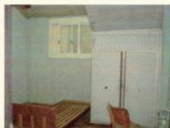
Sala 318 SUL – parede de alvenaria do lado esquerdo e madeira do lado direito – revestimentos de forro e paredes de madeira em péssimo estado de conservação – presença de cupins – Armário embutido
