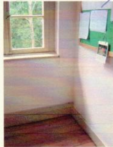
Rodapé com canaletas
