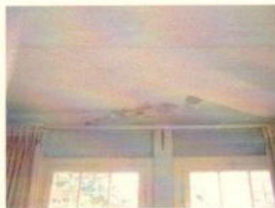
infiltração que vem do terraço
