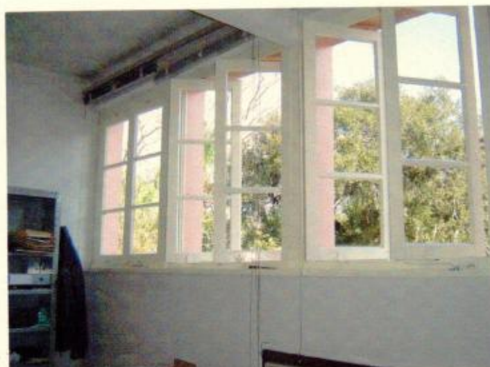
Conjunto de janelas em bom estado
