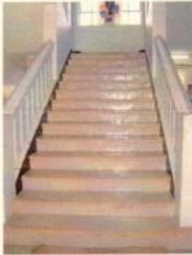
Escada de acesso ao segundo pavimento
