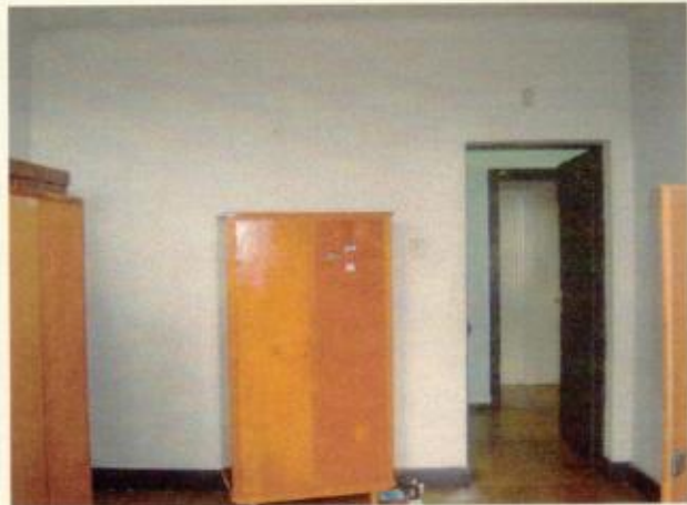
Sala 325 – assoalho de madeira, pintura descascada e manchas de umidade nas paredes
