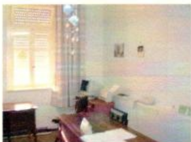
Sala 363 – viga de reforço
