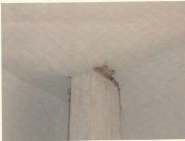
Sala 325 – pilar de madeira colocado para conter o possível desmoronamento do teto
