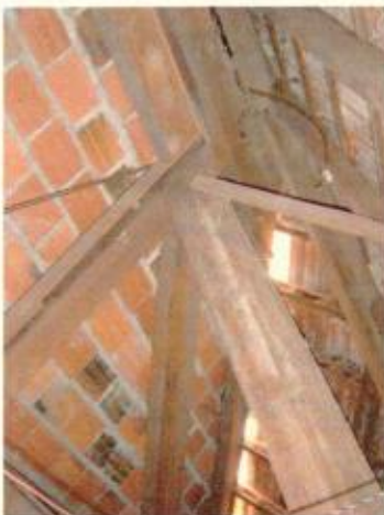
Madeiramento do telhado em boas condições de conservação
