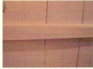
Depósito – parede de gesso do lado de fora e madeira do lado dentro
