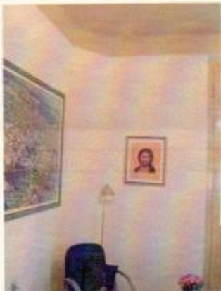
Detalhe do chanfro paredes
