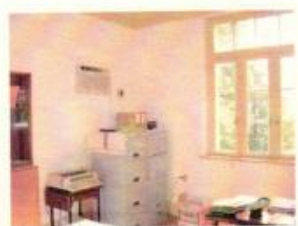
Aparelho de ar-condicionado
