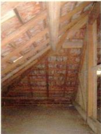
Estrutura do telhado em bom estado Acúmulo de sujeira indicando que há vazamentos no telhado
