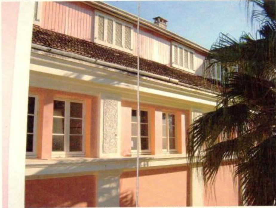
mansarda em madeira aproveitando inclinação do telhado
