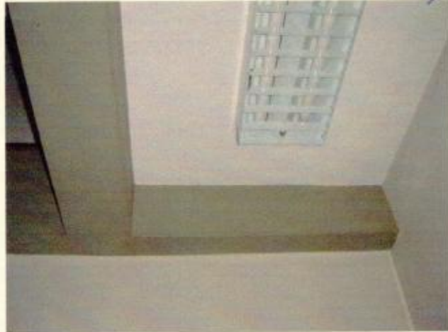
Vigas estruturais resultado do reforço da última reforma
