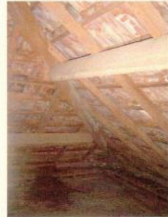
Estrutura do telhado em bom estado Acúmulo de sujeira indicando que há vazamentos no telhado
