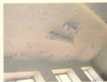
Pintura descascada
