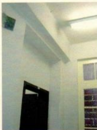
Várias estruturas sobrepostas
