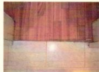
mudança de piso cerâmico banheiro para piso vinílico cozinha
