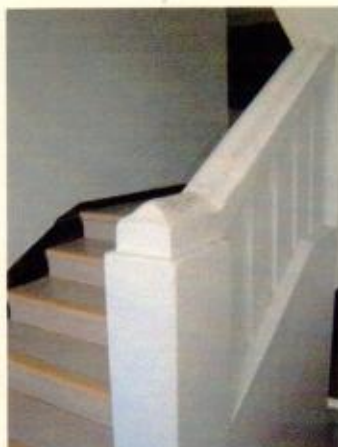
Guarda-corpo em alvenaria
