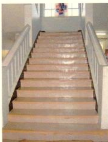
Escada de acesso ao segundo pavimento
