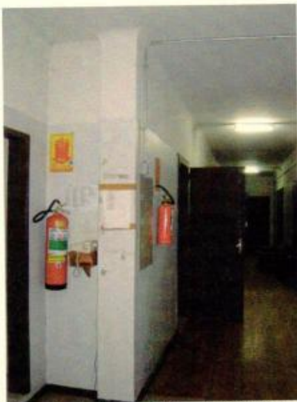
Corredor lado esquerdo – extintores e quadro de cargas
