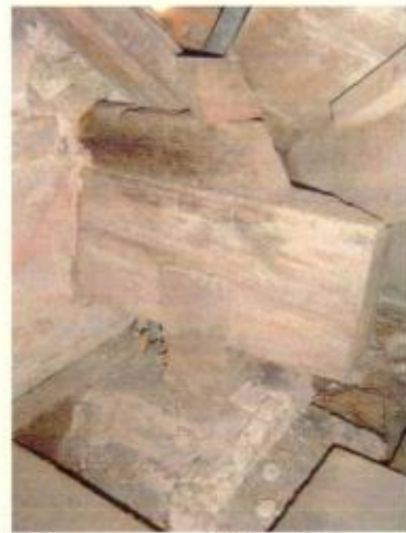
Tijolos portantes e originais compõem a parede que serve de um dos frontões pequenos da fachada principal
