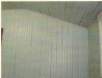
Sala 303 – caimento do forro de madeira
