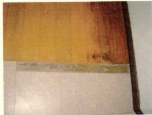
Detalhe da mudança de revestimentos de pisos
