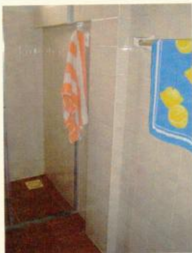
Estrutura aparente do banheiro coberta Parte dela por azulejos
