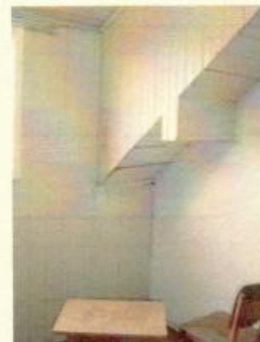
Caimento do telhado Acompanhado pelo forro
