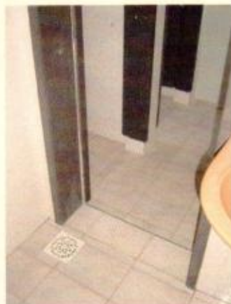
Desnível para a parte reformada
