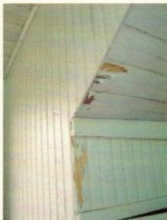
Sala 318 SUL – parede de alvenaria do lado esquerdo e madeira do lado direito – revestimentos de forro e paredes de madeira em péssimo estado de conservação – presença de cupins – Armário embutido
