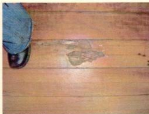
assoalho lâminas 13 cm. incidência cupins
