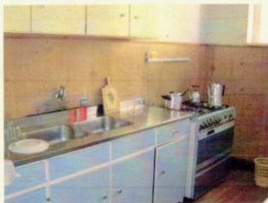
Lambris como revestimento de parede
