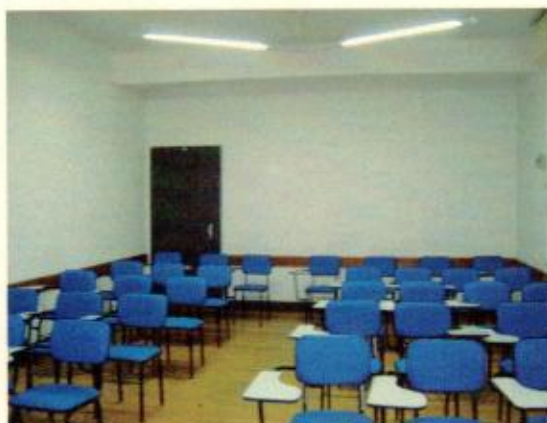
Sala 382 – porta de acesso ao depósito
