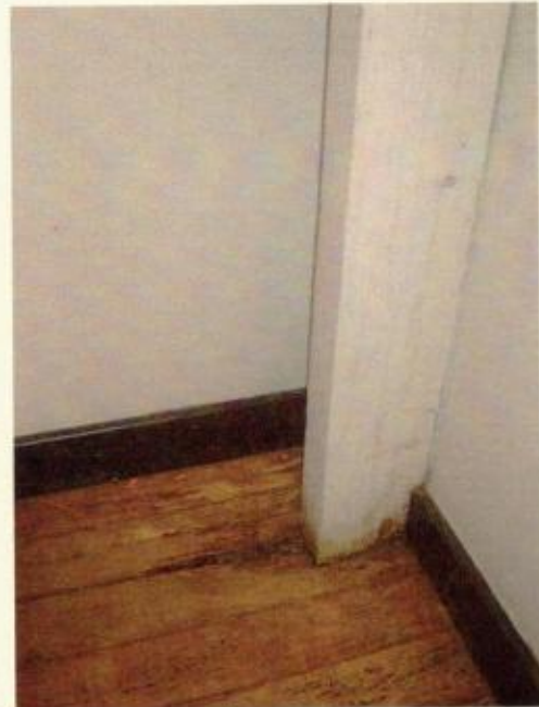
Sala 325 – pilar de madeira colocado para conter o possível desmoronamento do teto
