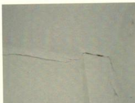
Detalhe rachaduras
