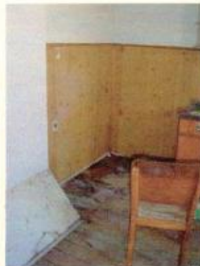
Cozinha SUL- com revestimento de madeira retendo a umidade exercida pelo uso da pia – piso danificado
