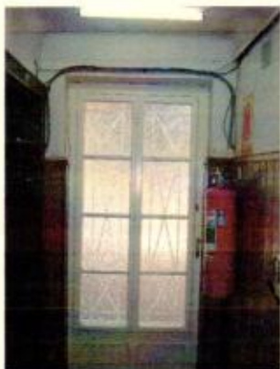
extintor de água pressurizada
