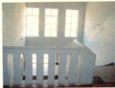
Guarda-corpo em alvenaria
