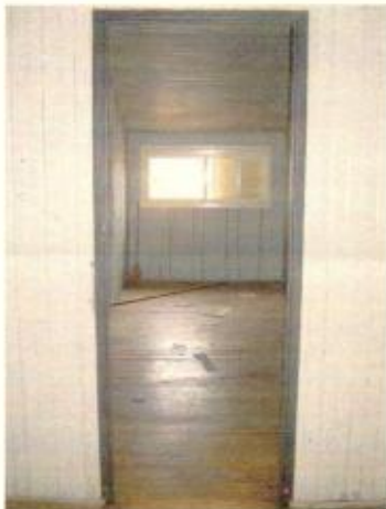
Porta de acesso a sala 311
