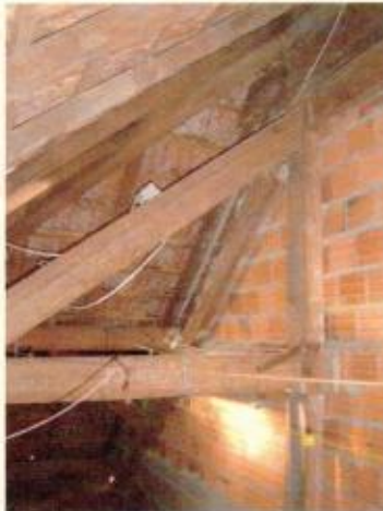
Madeiramento do telhado em boas condições de conservação
