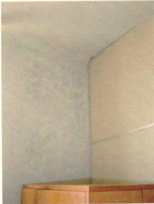
Sala 322 manchas de umidade e detalhe acabamento entre a parede e o teto
