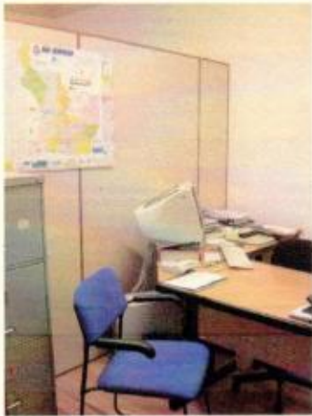
Divisórias navais dividindo duas salas
