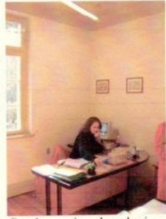
Canaletas acima do rodapé
