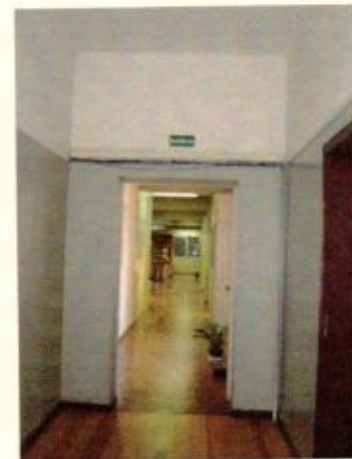
Etapa posterior de construção
