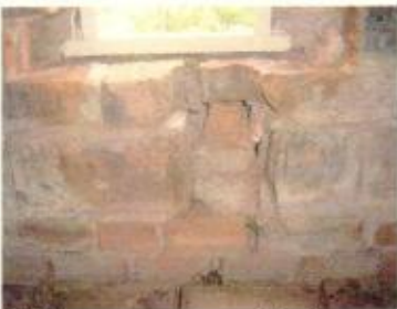
Tijolos portantes e originais compõem a parede que serve de um dos frontões pequenos da fachada principal
