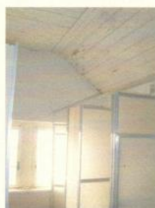
Forro de madeira, box visíveis pela fachada principal
