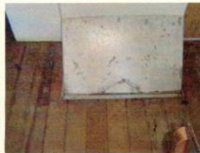
Cozinha SUL- com revestimento de madeira retendo a umidade exercida pelo uso da pia – piso danificado
