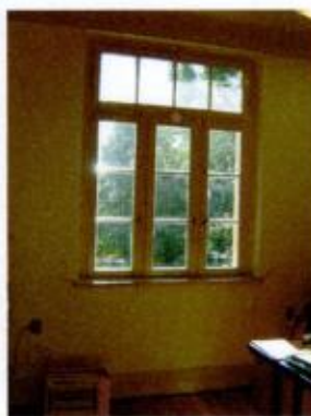
Janelas de madeira originais com bandeira
