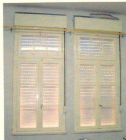
Janelas em bom estado
