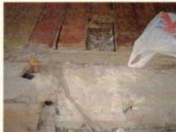
Parede com tijolos e viga estrutural em concreto executados recentemente
