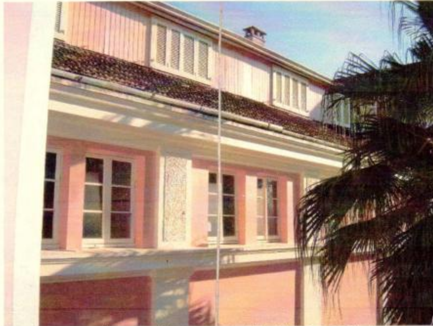
mansarda em madeira aproveitando inclinação do telhado
