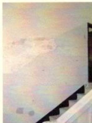
Pintura descascada
