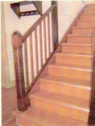
Anti-derrapante nos degraus
