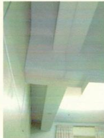
Sala 353 – estruturas do prédio
