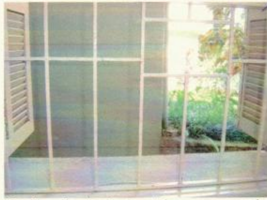
Parede em frente a janela restringe a passagem do Sol e do vento
