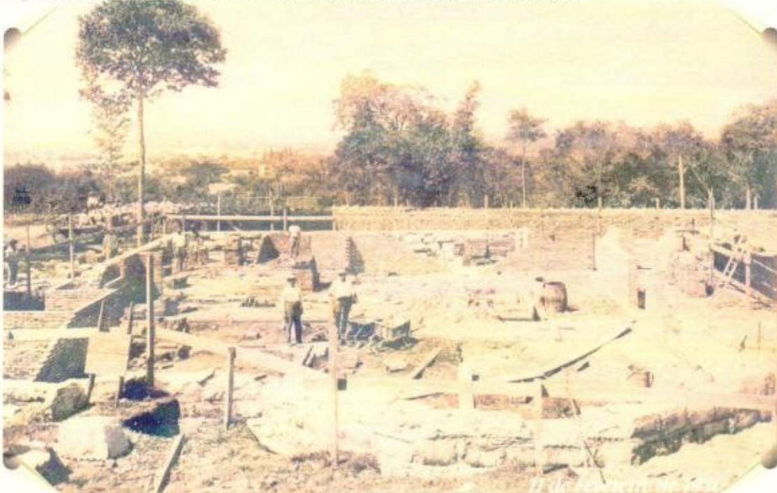
fundação em pedras no terraço que forma o antigo refeitório - foto Arquivo Histórico IECLB
