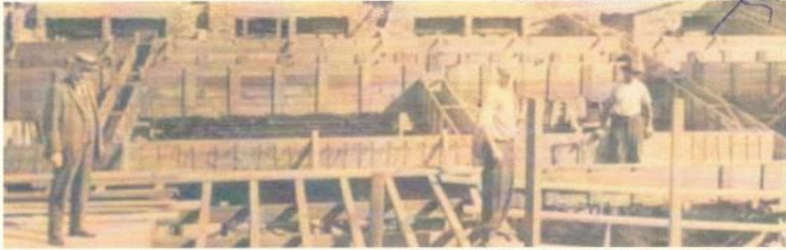
forma para vigas de amarração das paredes internas Destaque para Whiedersphan de terno - foto Arquivo Histórico IECLB
