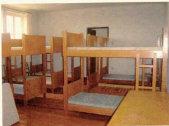
Sala 324 assoalho de madeira em bom estado
