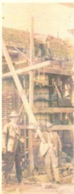
execução colunas do pórtico de acesso
