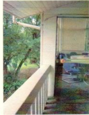
Guarda-corpo em alvenaria
