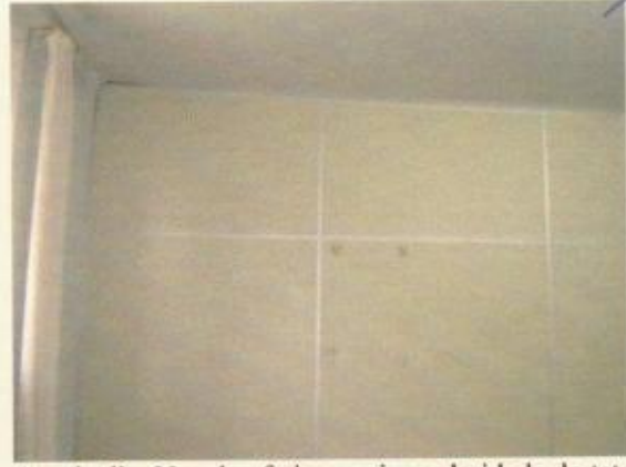
Modulações da div. Naval enfatizam a irregularidade do teto
