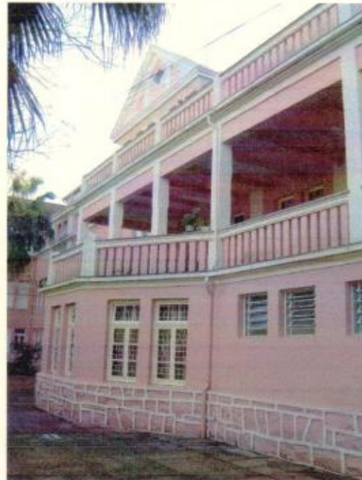
Terraços na Fachada Traseira – Foto agosto 2005
