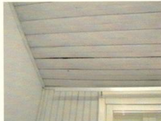
Sala 313 SUL - os dois lados das paredes são em alvenaria Forro de madeira
