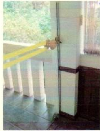
Vedação da varanda através de vidro - Lambris de madeira cobrindo peitoril - porta de vidro
