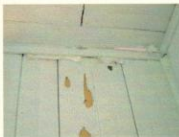
Revestimento de madeira de forro e piso em péssimas condições de conservação
