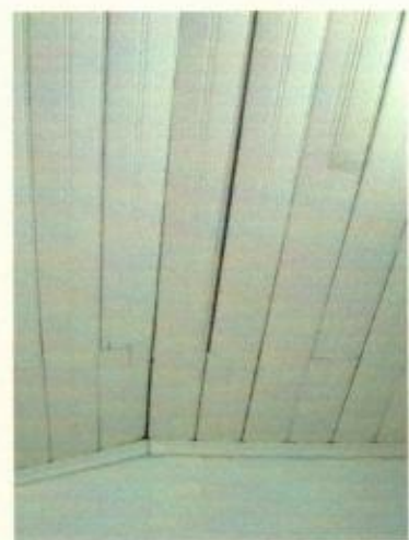
Revestimento de madeira de forro e piso em péssimas condições de conservação
