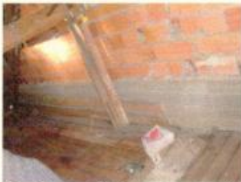
Parede com tijolos e viga estrutural em concreto executados recentemente
