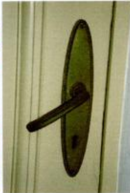
Porta interna com Ferragens originais
