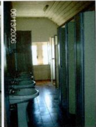
Sanitário reformado com janela original (no frontão)
