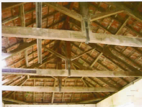
Estrutura da Cobertura /IPHAE
