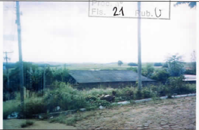
Foto 16 – Rua Zeca Netto esquina Rua Adalcina Ribeiro – Vista da quadra 712
