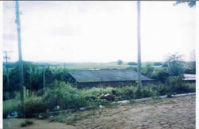
Foto 18 – Rua Adalcina Ribeiro – Vista do muro de arrimo no meio da quadra 629
