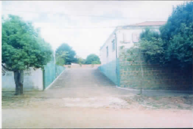
Foto 19 – Rua Professora Luisa Maraninchi – Muro de arrimo e rampa de acesso para a quadra 629
