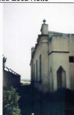
Foto 04 – Área lateral esquerda do Forte com muro de fundos
