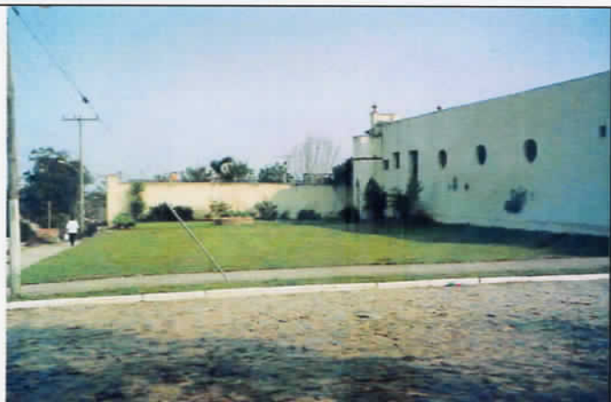
Foto 03 – Área lateral esquerda do Forte – Rua Zeca esquina Rua Florisbela Netto
