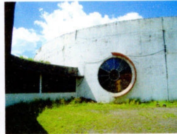
Paredes-cortina em concreto, janela circular com anteparo
