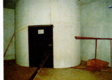
Vista interna do volume da escada embaixo do palco
