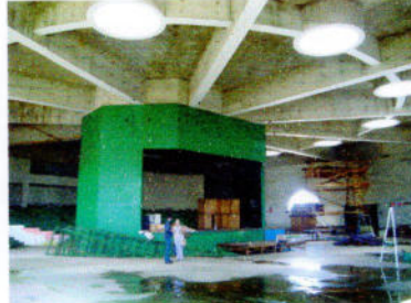
Palco central e vigas radiais em concreto armado
