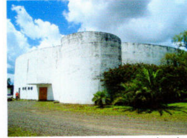
Acesso lateral, janelas redondas (sanitários) e volume da escada
