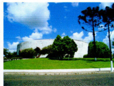
Vista da Av. Pres. Kennedy
