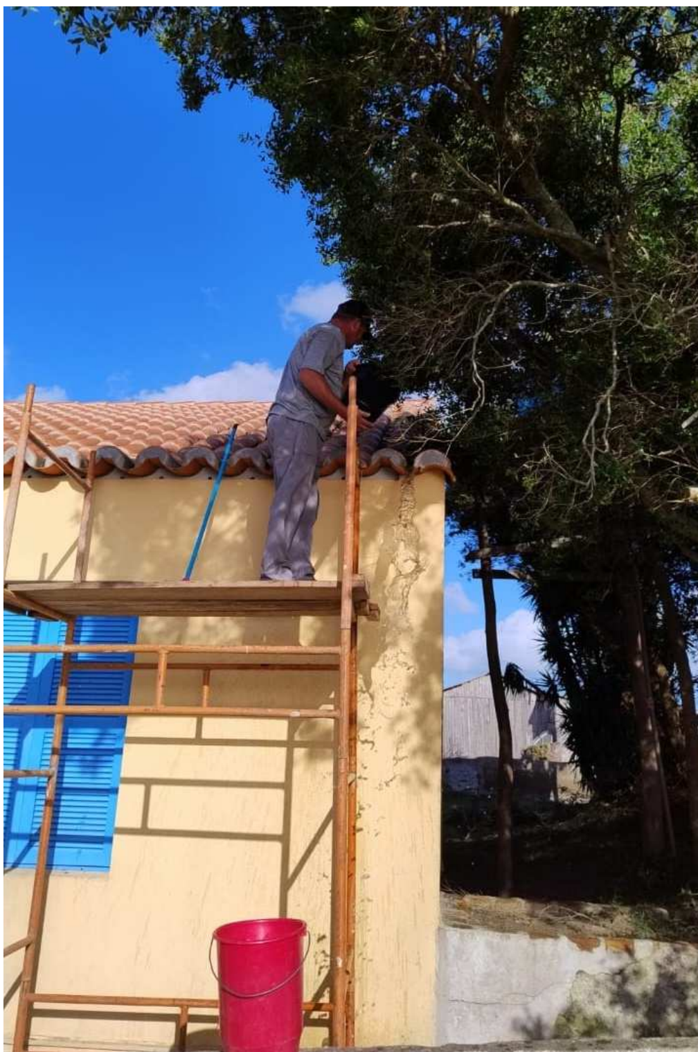
Foto 42 - Reparos na cobertura junto a sacristia. Remoção de raízes e testes com água.
