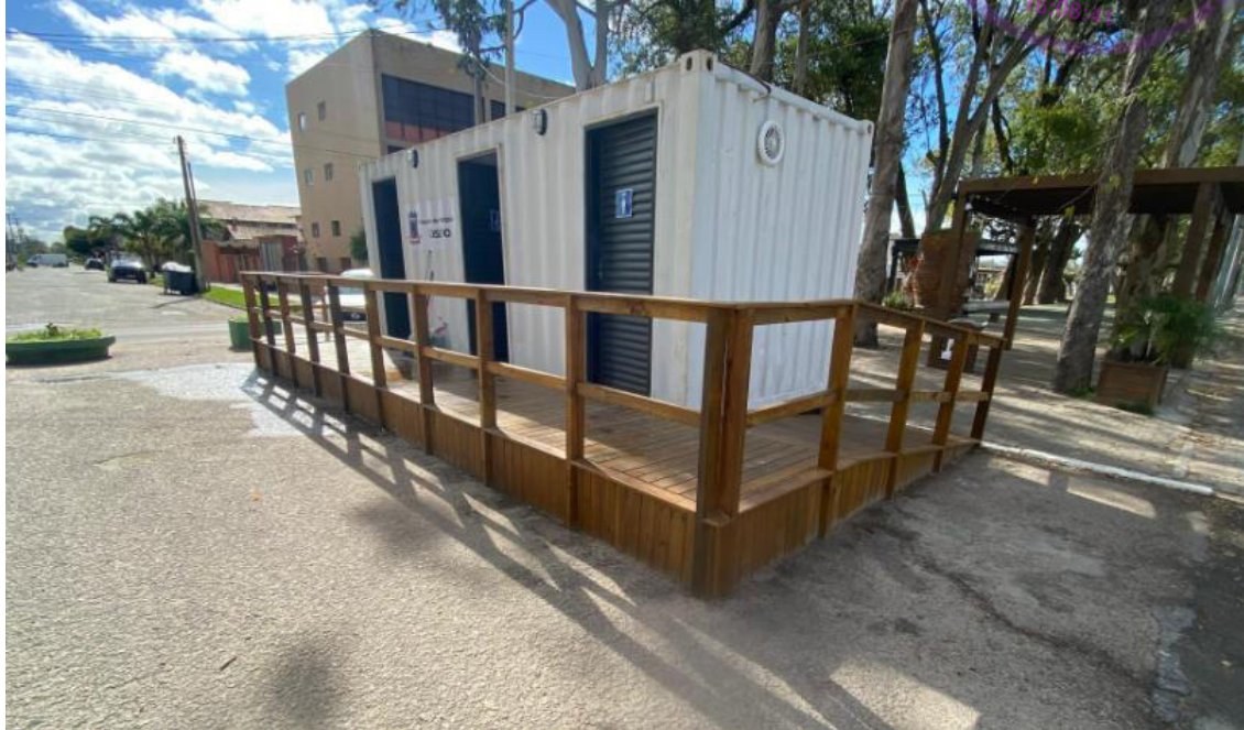
Figura 7 - Padrão de acabamento container
