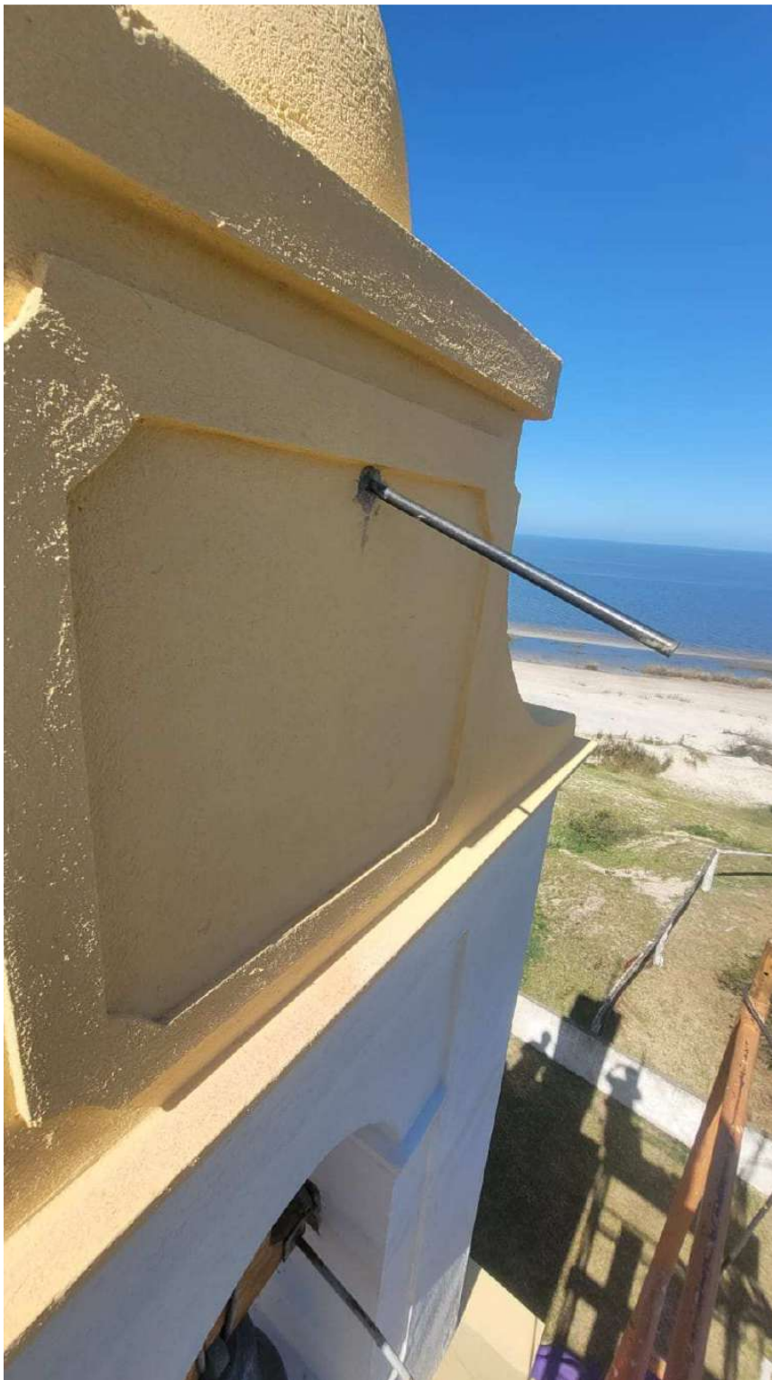
Foto 31 – Colocação da haste metálica – relógio de sol.
