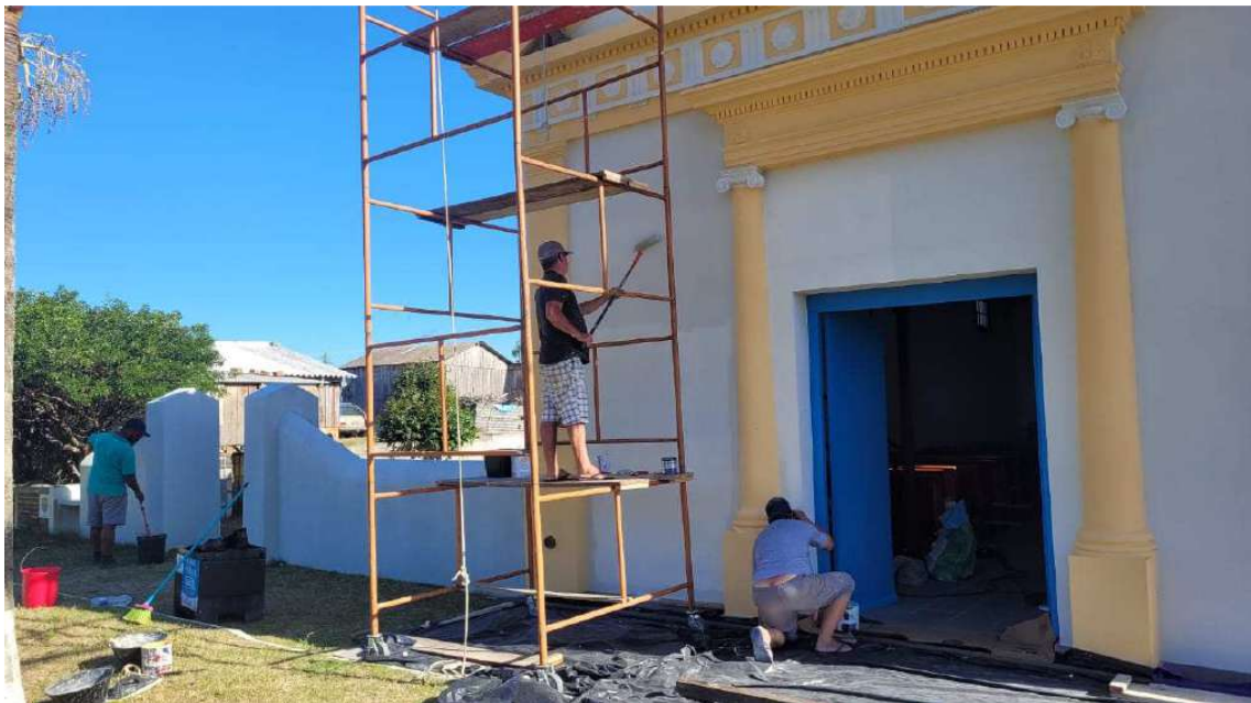
Foto 33 – Pintura fachada principal.
