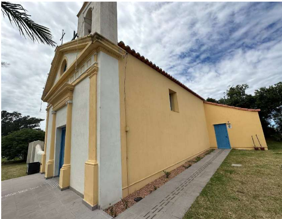
Foto 8 – Vista fachada nave principal – lado lagoa e frente sacristia.
