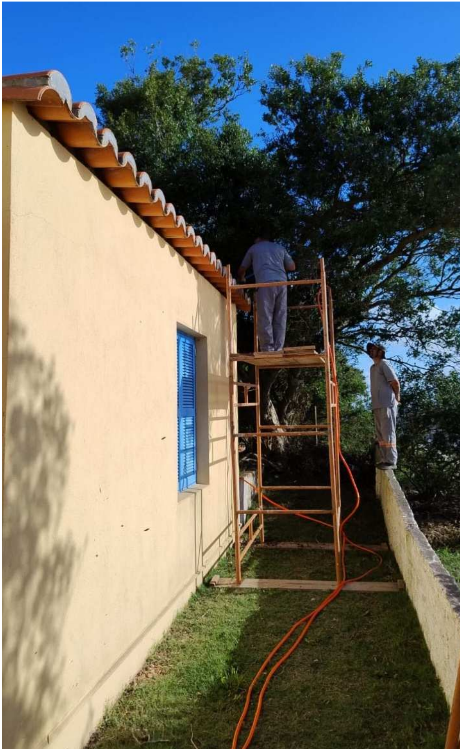
Foto 39 – Reparo na cobertura junto à sacristia.
