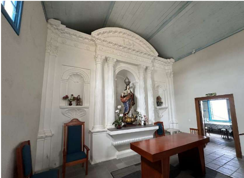
Foto 15 - Vista do forro e altar – note-se o mofo no forro.
