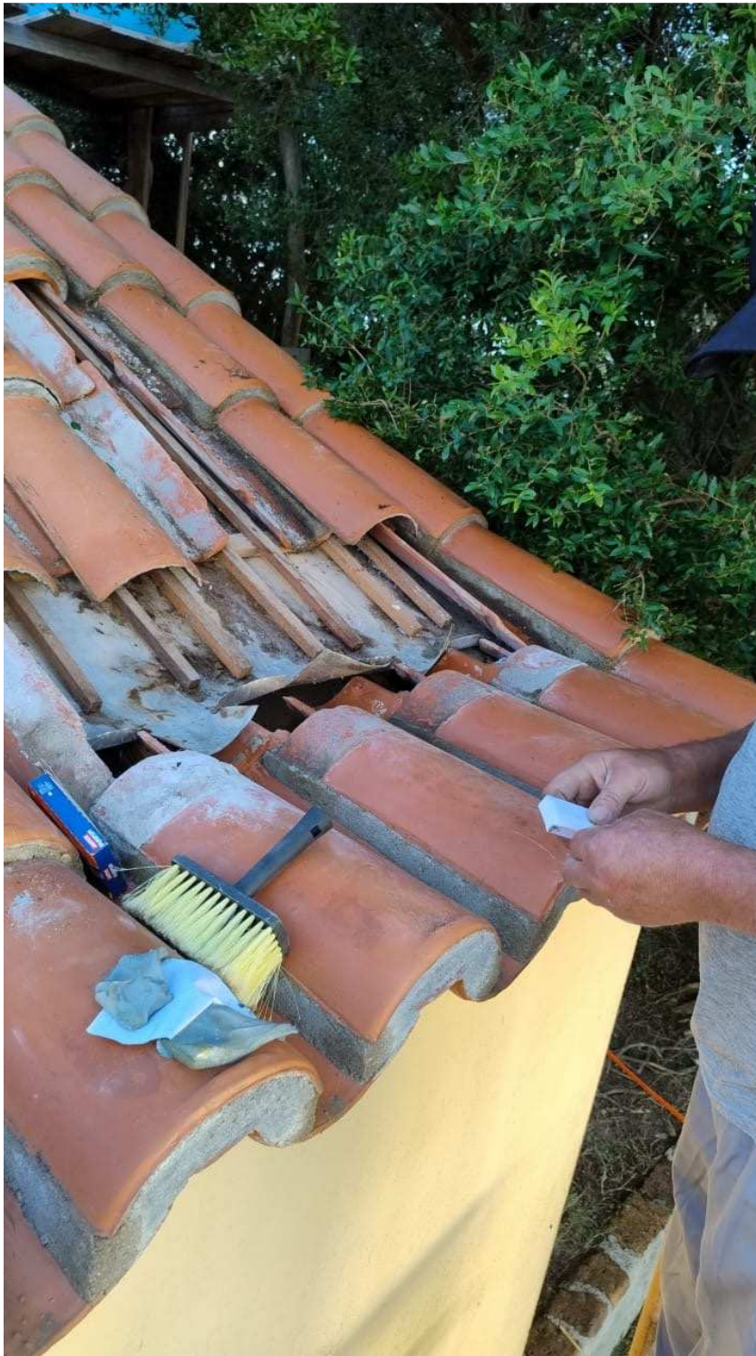
Foto 43 – Limpeza de raízes e vegetações sob as telhas, e reparos junto ao subtelhado.
