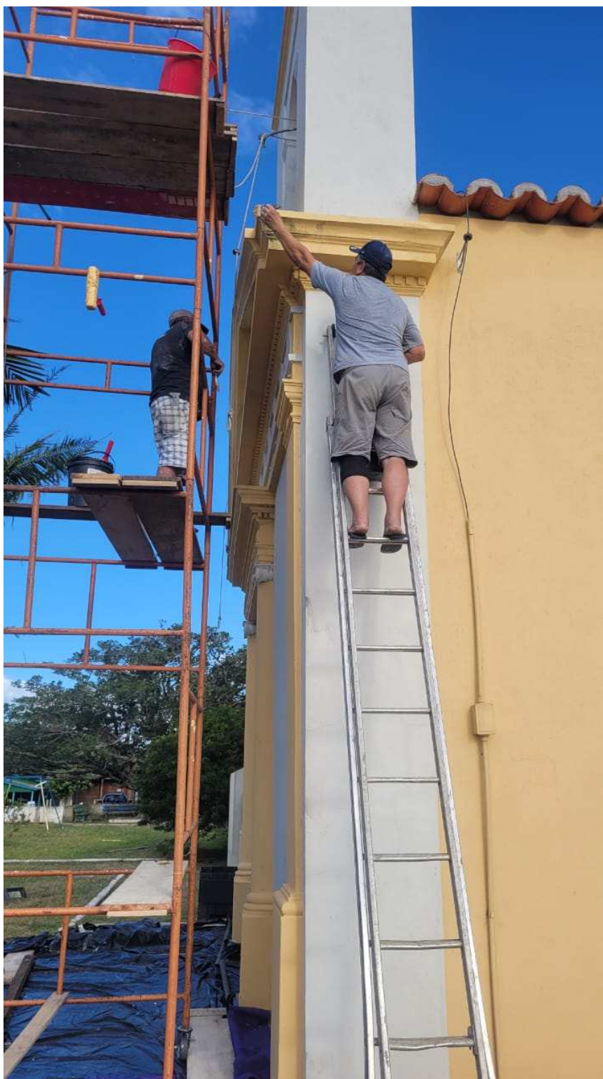
Foto 28 – Pintura da fachada principal.
