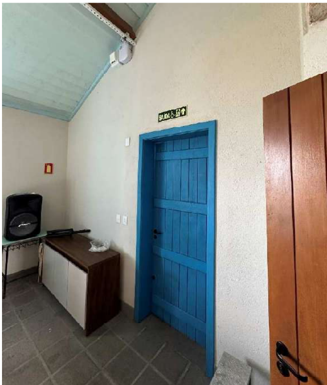
Foto 16 - Vista interna sacristia – porta de acesso.
