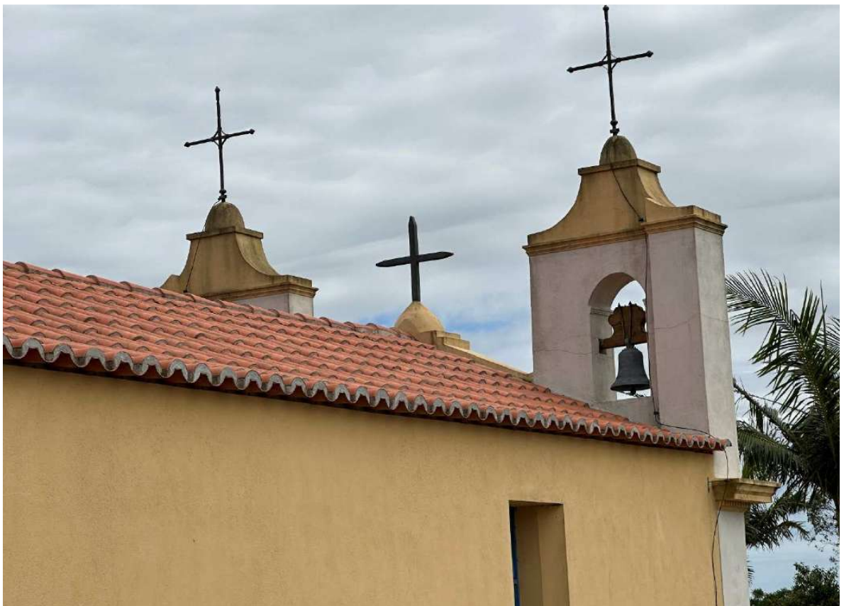
Foto 4 – Vista telhado e parte posterior das torres.
