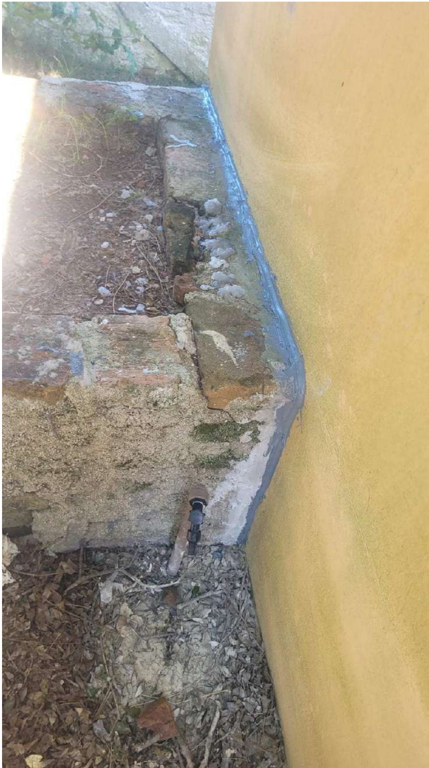
Foto 37 – Executada vedação entre alvenaria túmulo e parede fundos.
