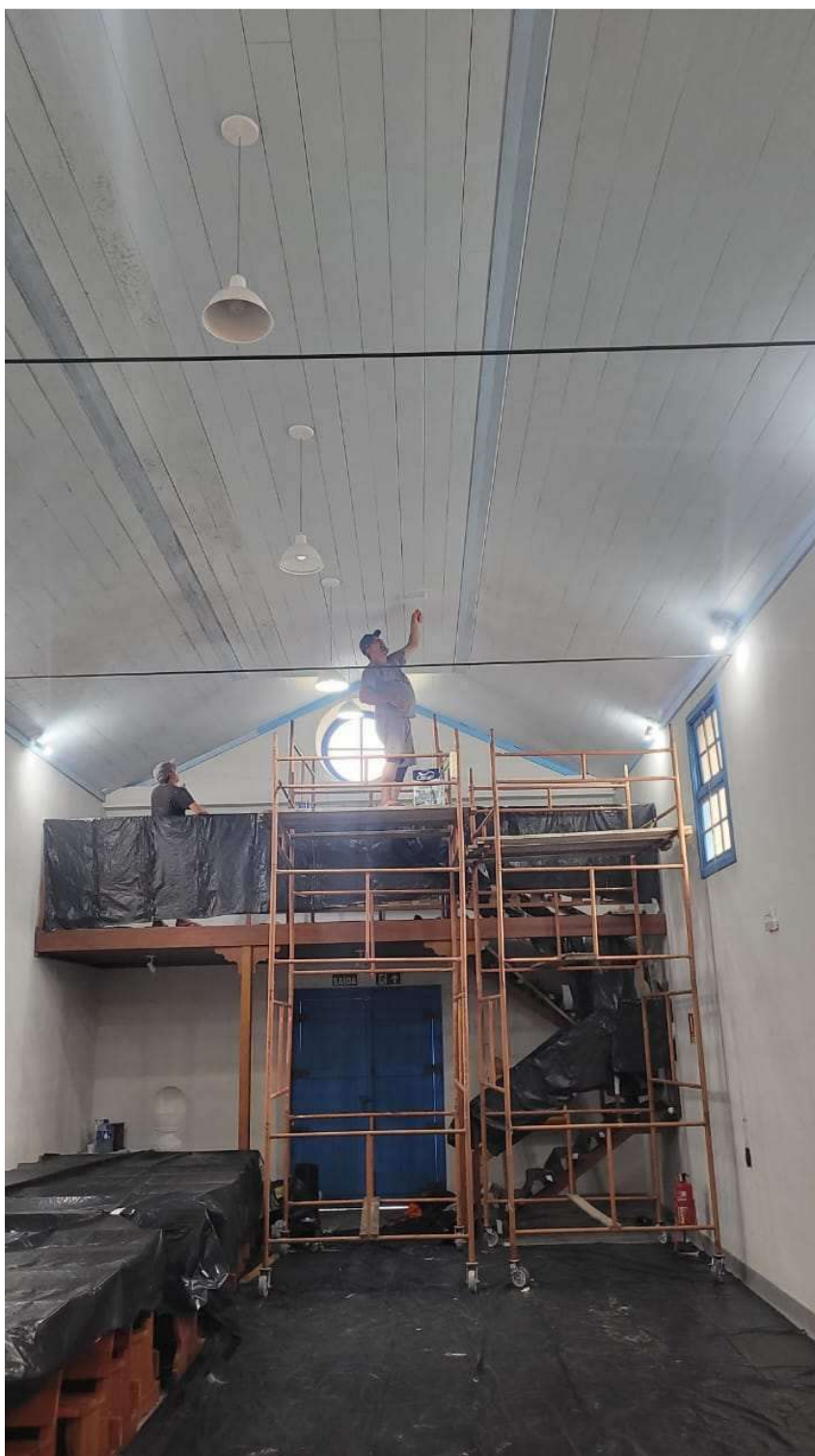
Foto 21 – Pintura do forro nave principal.
