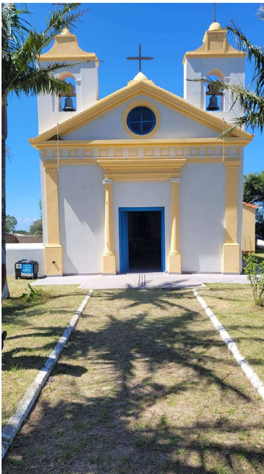
Foto 38 – Fachada principal pintada.
