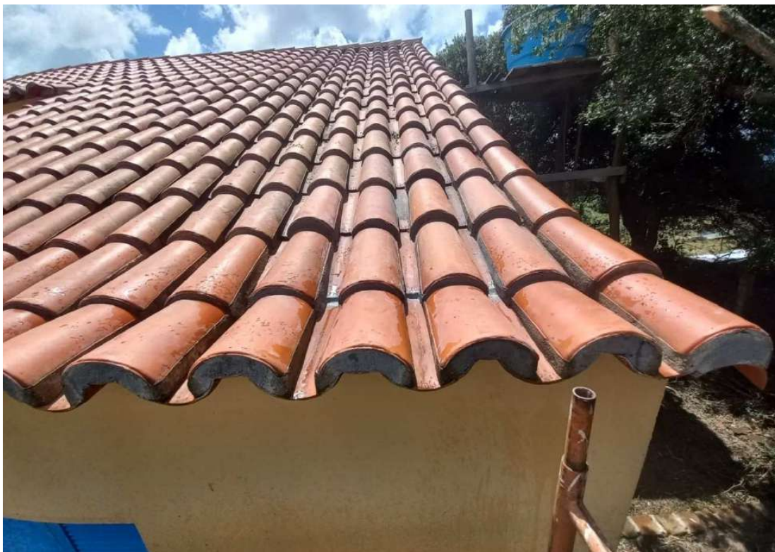
Foto 45 – Cobertura reparada junto beirado e vegetações podadas neste local.
