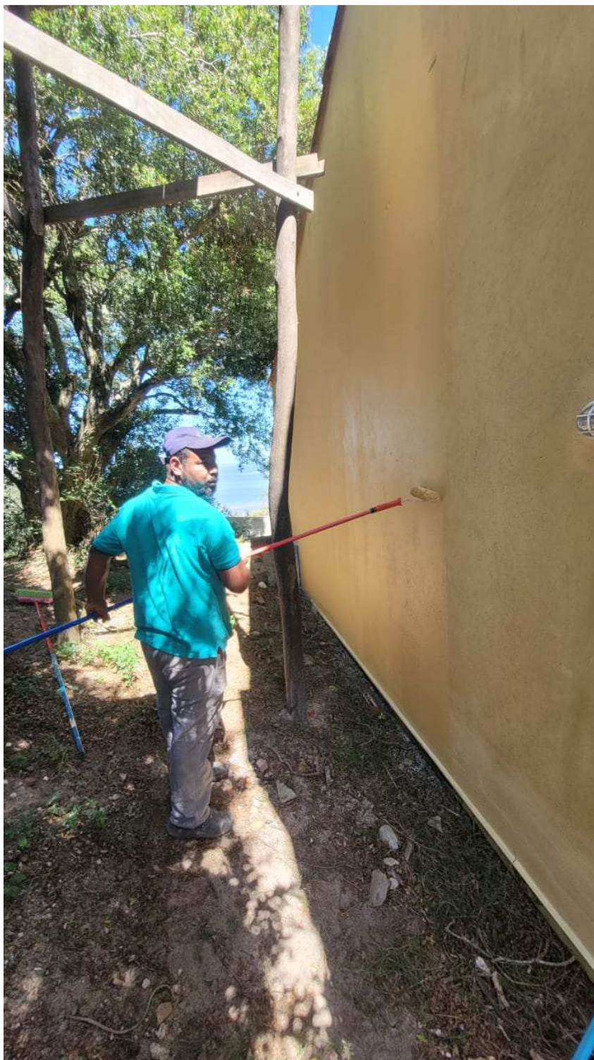
Foto 36 – Pintura parede fachada fundos.
