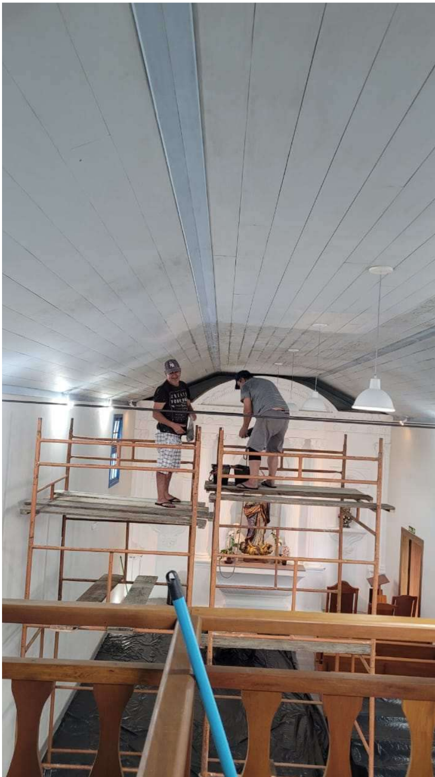
Foto 21 – Limpeza do forro nave principal.
