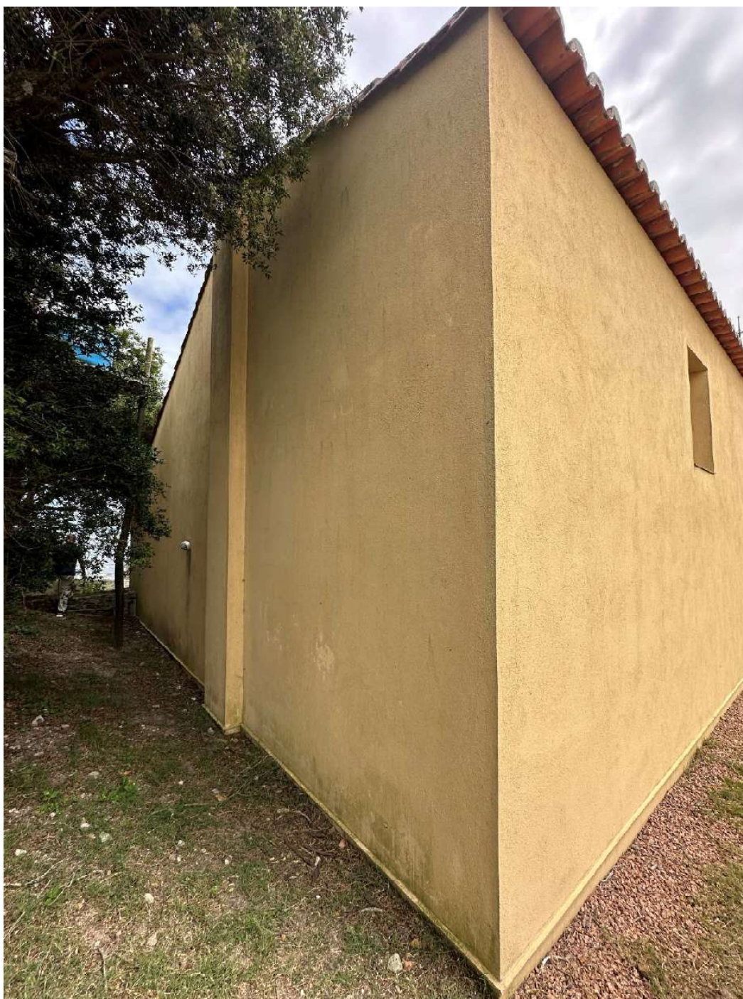
Foto 5 – vista parede fundos.
