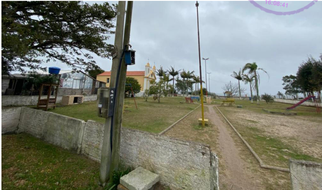
Figura 3 - Local de interligação elétrica do container
