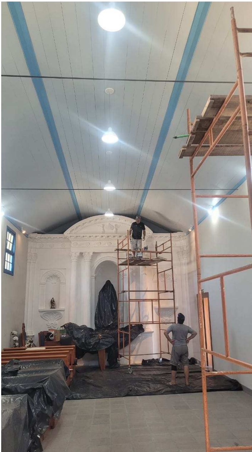
Foto 22 – Pintura do forro nave principal.
