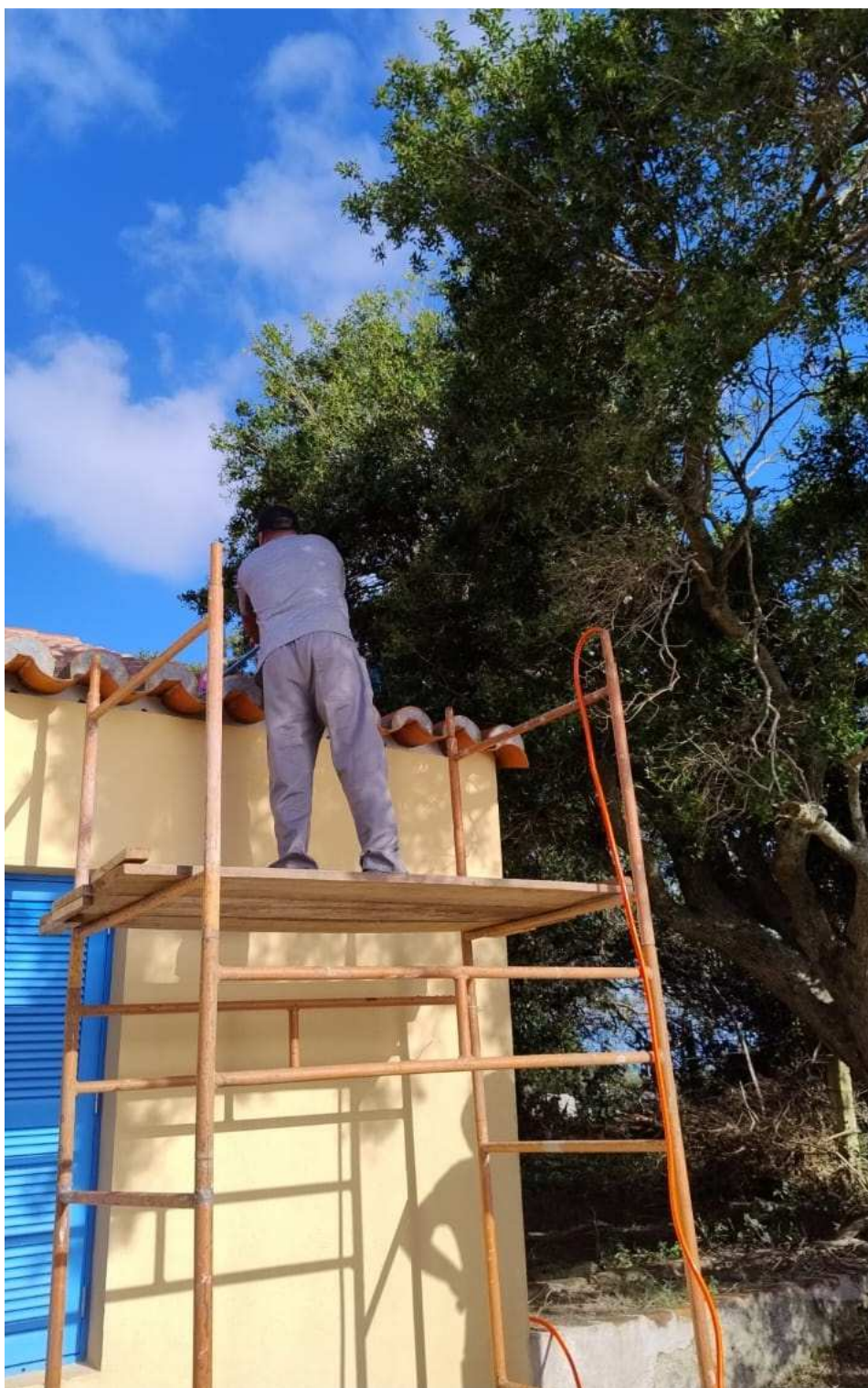
Foto 40 – Reparos na cobertura junto a sacristia.
