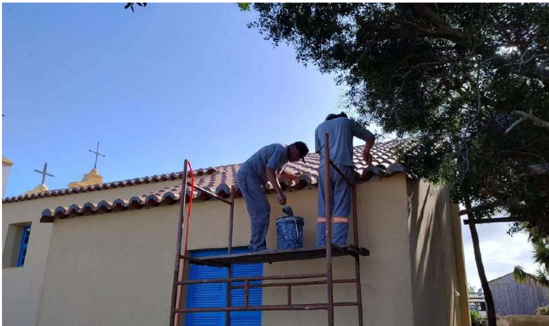
Foto 44 – Reparos no beirado junto a parede da sacristia.
