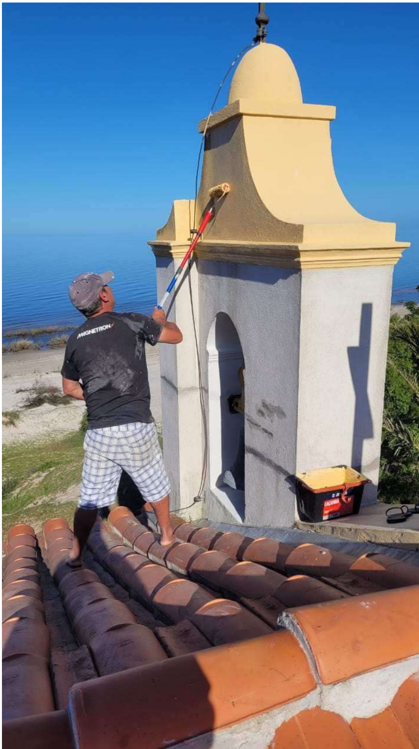
Foto 36 – Pintura das torres – fachada principal.
