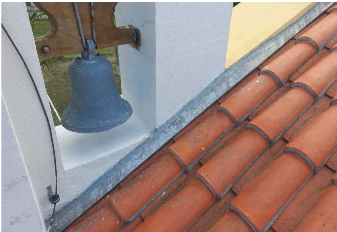
Foto 48 – Reparos e vedações junto ao algeroz na parte posterior da fachada principal.
