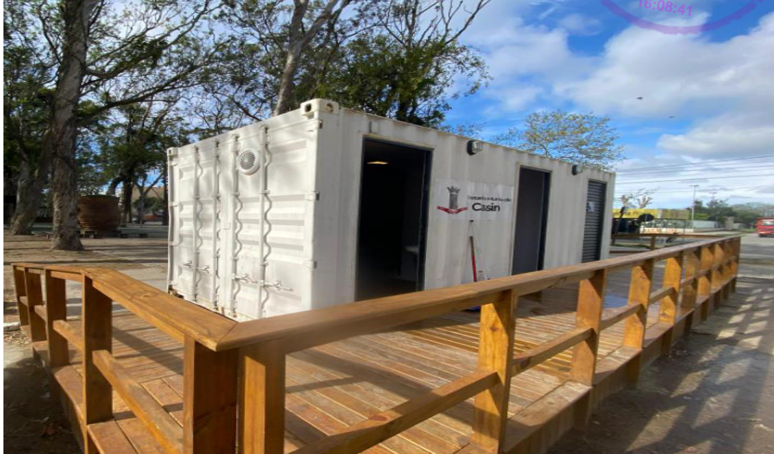
Figura 6 - Padrão de acabamento do container
