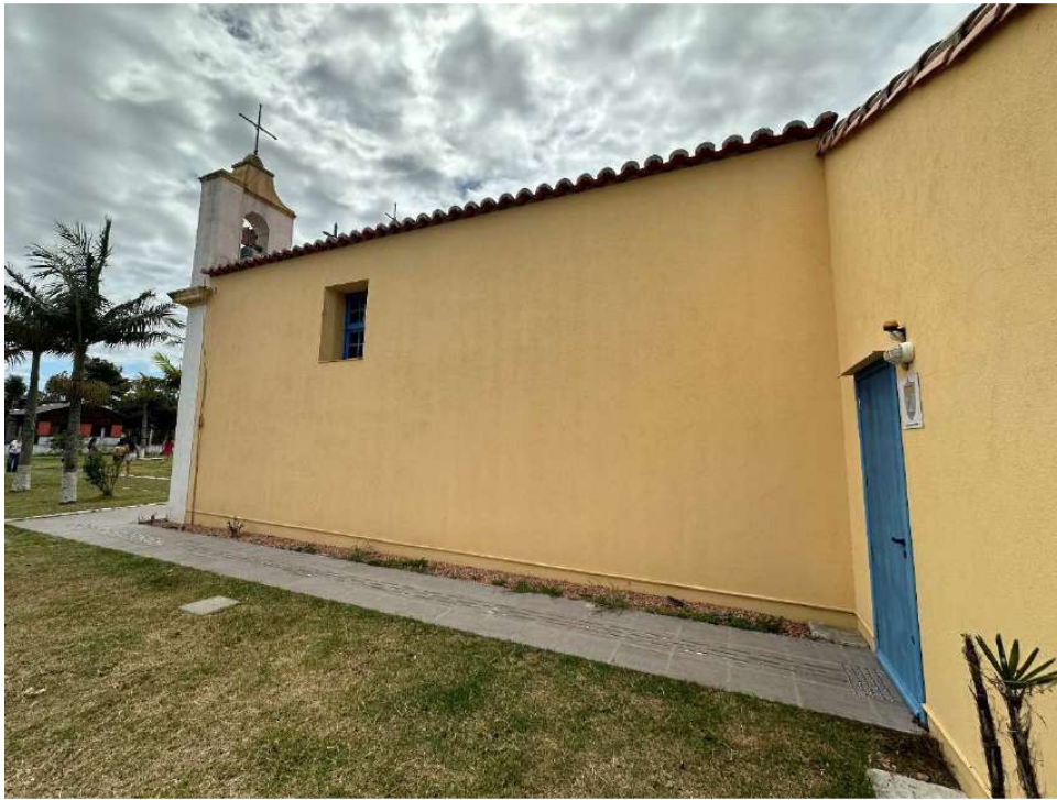
Foto 7 – Vista fachada nave principal – lado lagoa.
