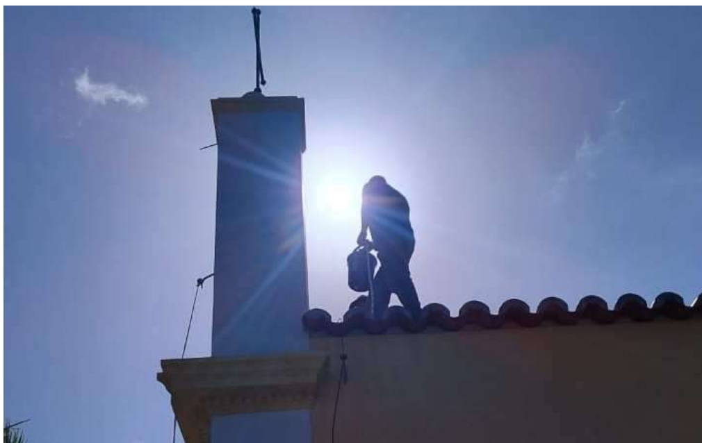
Foto 49 – Testes com água após a execução dos reparos e vedações junto ao algeroz na parte posterior da fachada principal.
