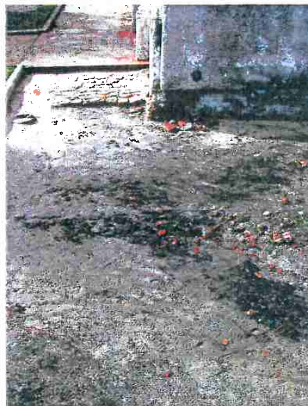
Figura 52 – provável pavimento de tijolos. Foto: LEPAN - 2007
