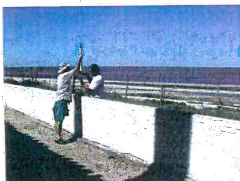
Figura 107 – instalação de aparelho medidor na área do talude que integra a falésia. Foto: Escola de Engenharia
