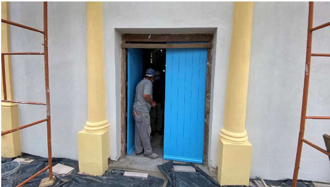
Foto 41 – Porta entrada principal, vista externa.
