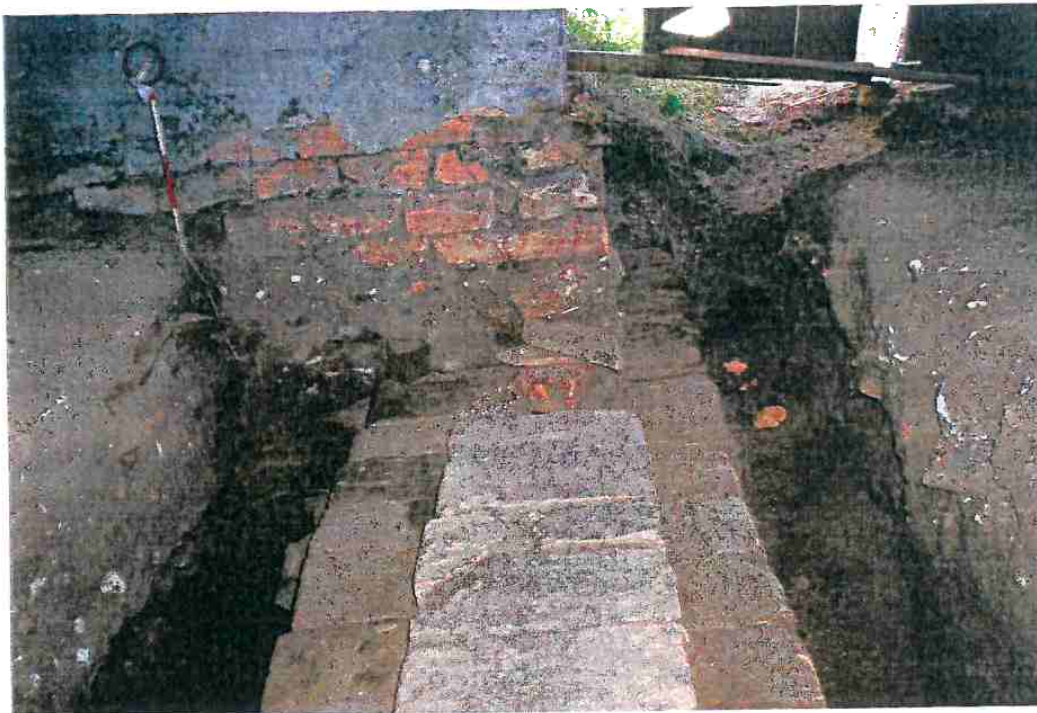
Figura 114 – parte das fundações expostas pela escavação demonstrando a diferença entre a qualidade da construção das fundações e a da parede da sacristia apoiada sobre a mesma. Foto: SUPETEC
