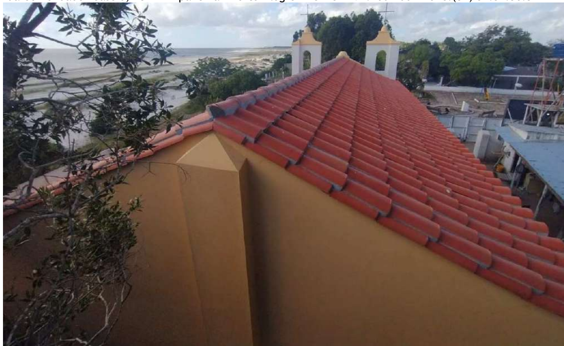
Foto 17 – Pintura das paredes externas com tinta silicato transpirável.
