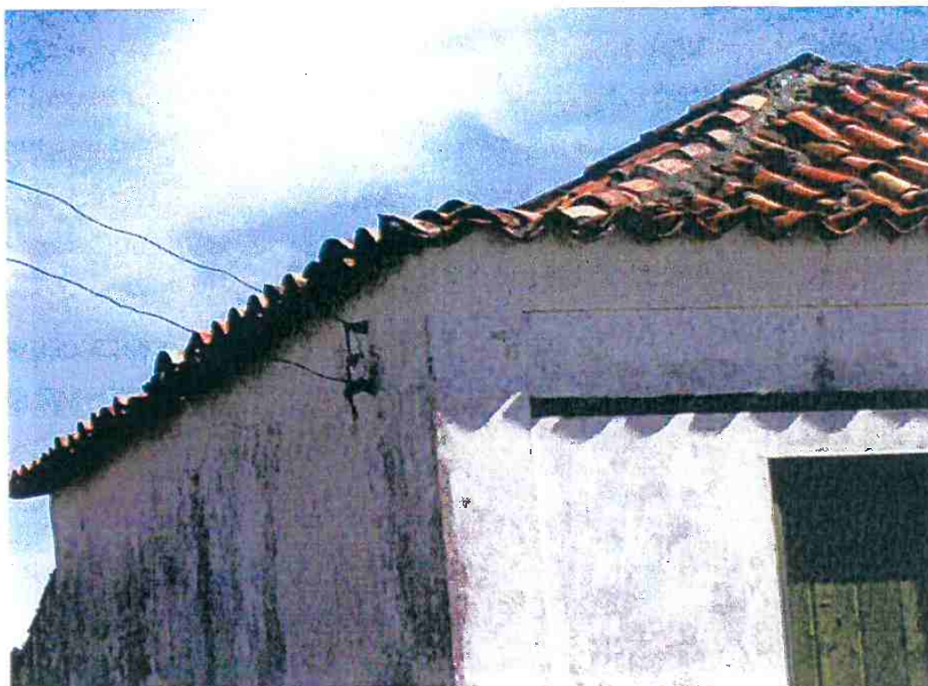
Figura 134– detalhe da cobertura de residência mostrando características de projeto do período colonial Português na 5ª seção da barra em São José do Norte. Como na capela do Taim, o beiral não possui adornos ou cimalha, mas possui inclinação suavizada no beiral pouco profundo. (Foto: Rita Gnutzmann Veiga, 2009)
