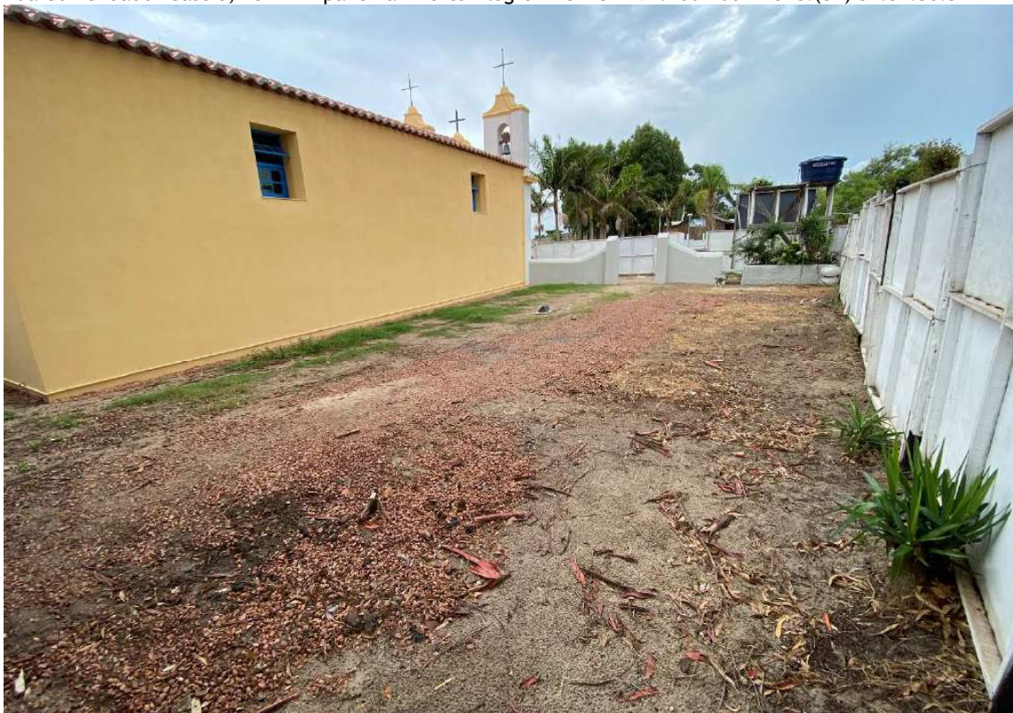
Foto 74 – Pátio limpo após a remoção dos galpões de obra.
