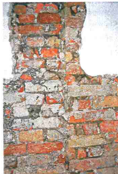
Figura 81 – detalhe da antiga porta.
