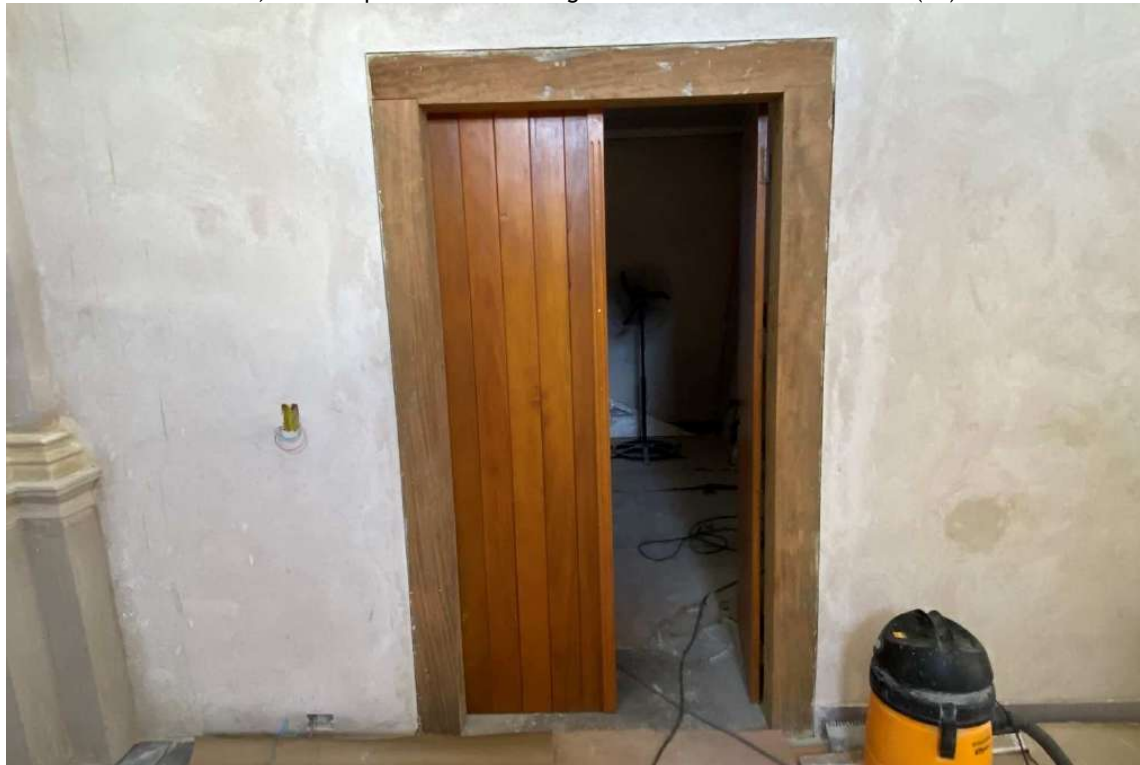
Foto 47 – Porta ligação entre nave principal e a sacristia, vista lado nave principal.
