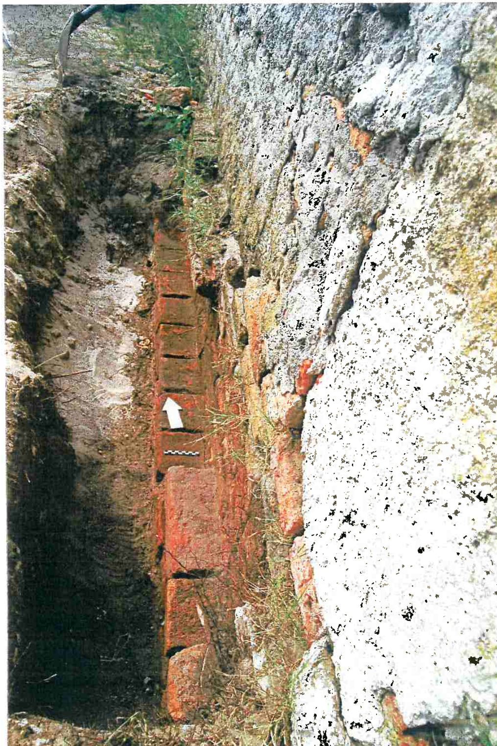
Figura 123 – fundações da parede oeste da sacristia na continuidade das fundações antigas. Foto: LEPAN
