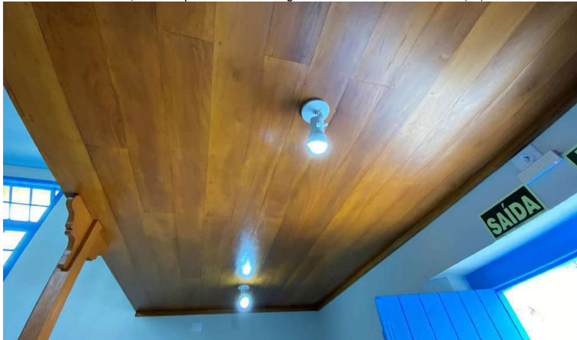
Foto 68 – Luminárias sob o forro do coro.
