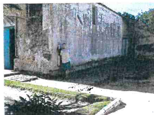
Figura 106 – instalação de aparelho medidor no referencial frontal da parede oeste. Foto: Escola de Engenharia
