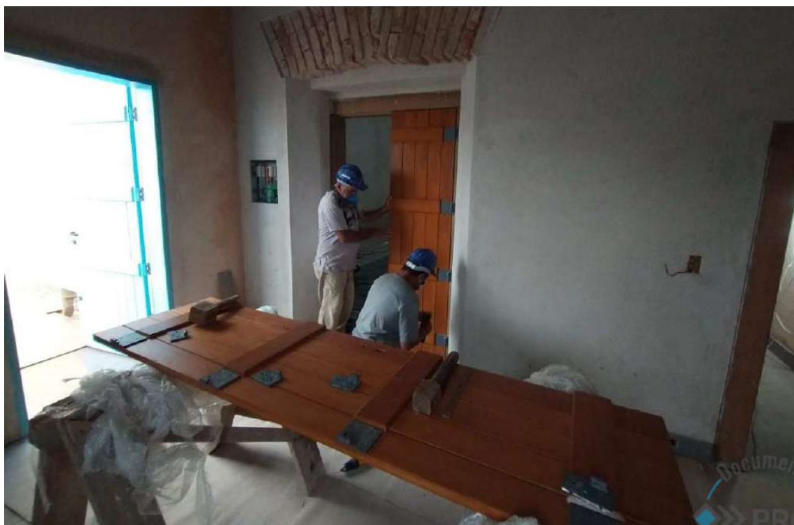
Foto 48 – Porta ligação entre nave principal e a sacristia, vista lado sacristia.
