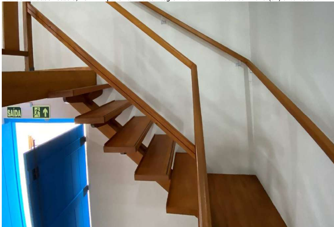
Foto 26 – Escada acesso finalizada.
