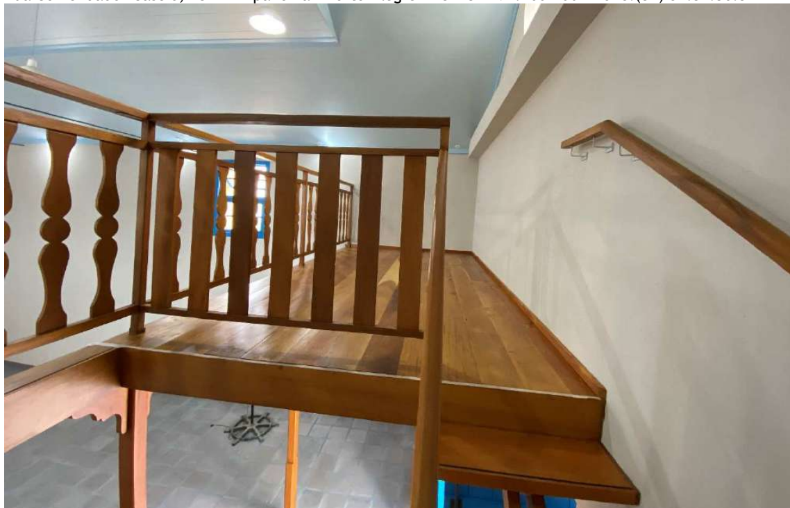
Foto 28 – Guarda corpos e assoalho coro finalizados.
