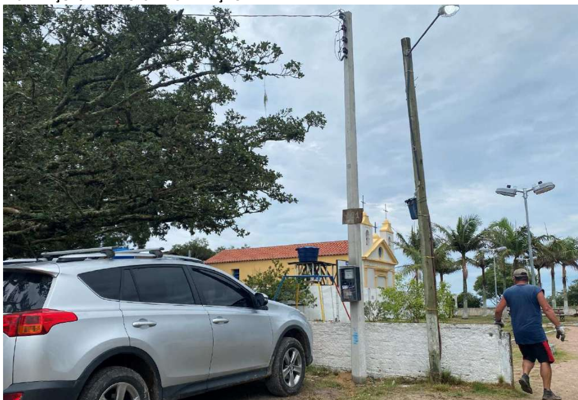
Foto 62 – Poste entrada de energia com a ligação feita pela CEEE.
