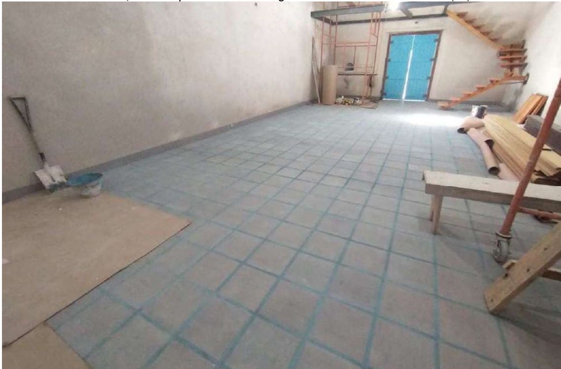
Foto 53 - Execução de rejunte colorido na nave principal.
