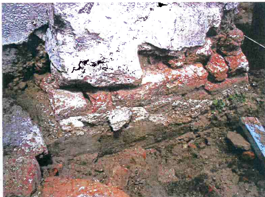
Figura 42 – pode-se observar a partir desta escavação um acabamento na base do pilar com um revestimento semelhante ao encontrado na escavação do interior da capela. Foto: Rita Gnutzmann Veiga - 2009
