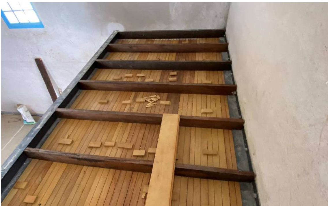
Foto 55 – Estrutura de madeira, forro e início colocação assoalho.
