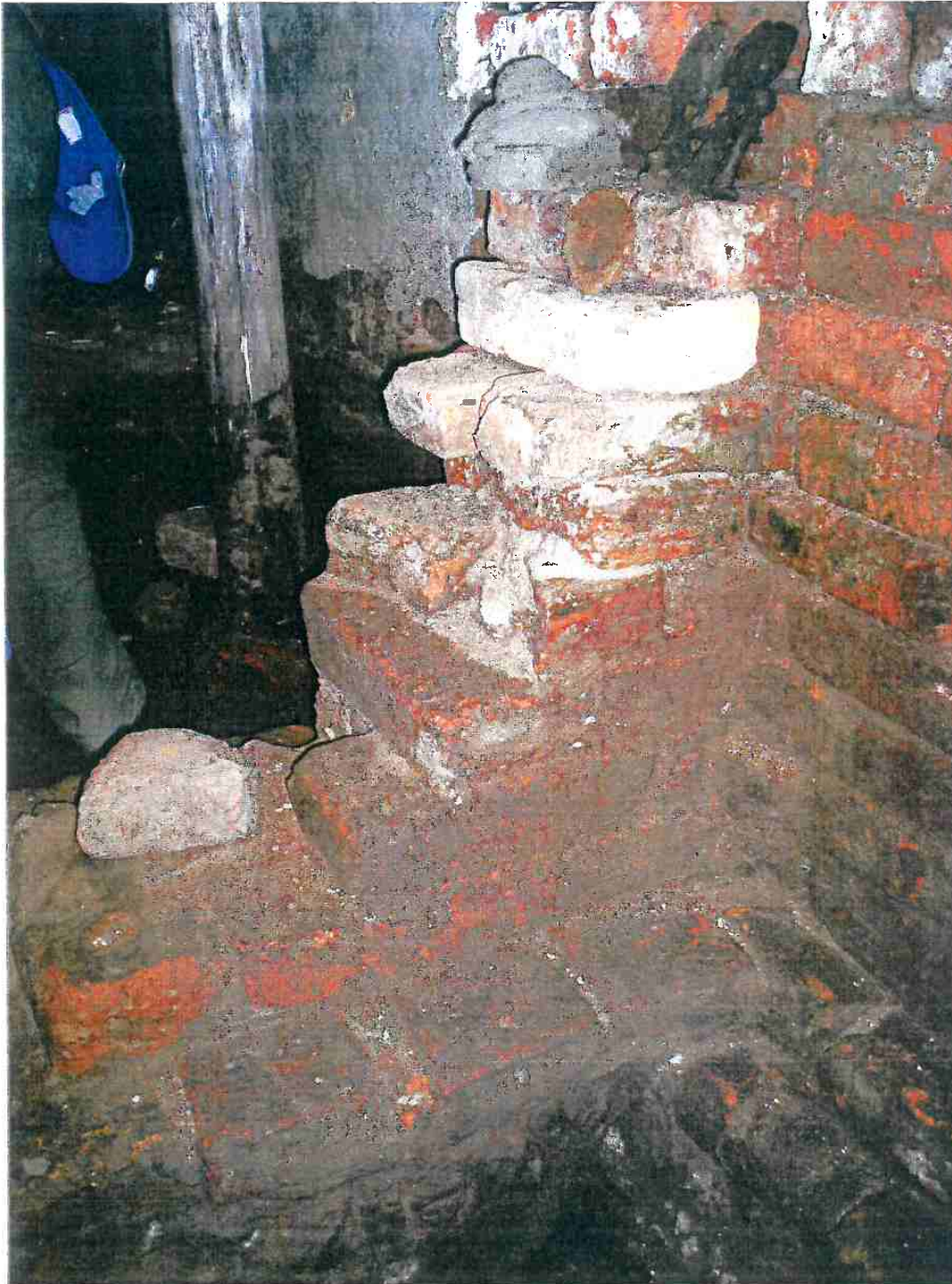
Figura 118 – parte das fundações expostas pela escavação nas proximidades da atual sacristia demonstrando a espera para uma nova construção que não se sabe se alguma vez existiu. Foto: SUPETEC
