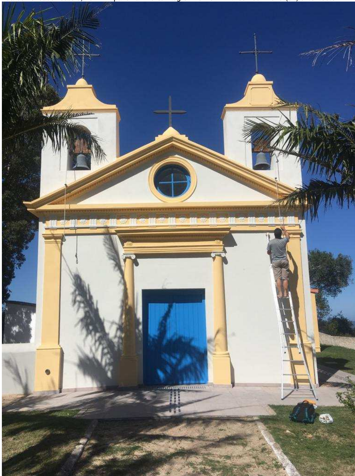
Foto 2 – Testando a corda do sino reinstalada.
