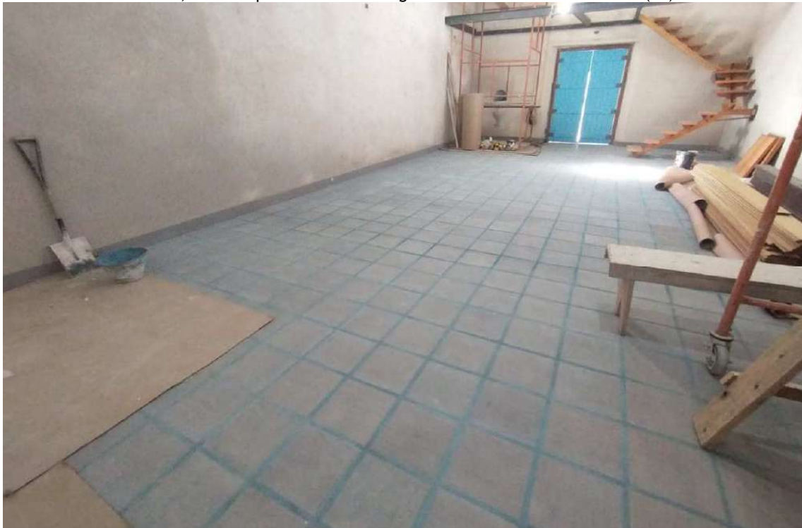
Foto 53 - Execução de rejunte colorido na nave principal.
