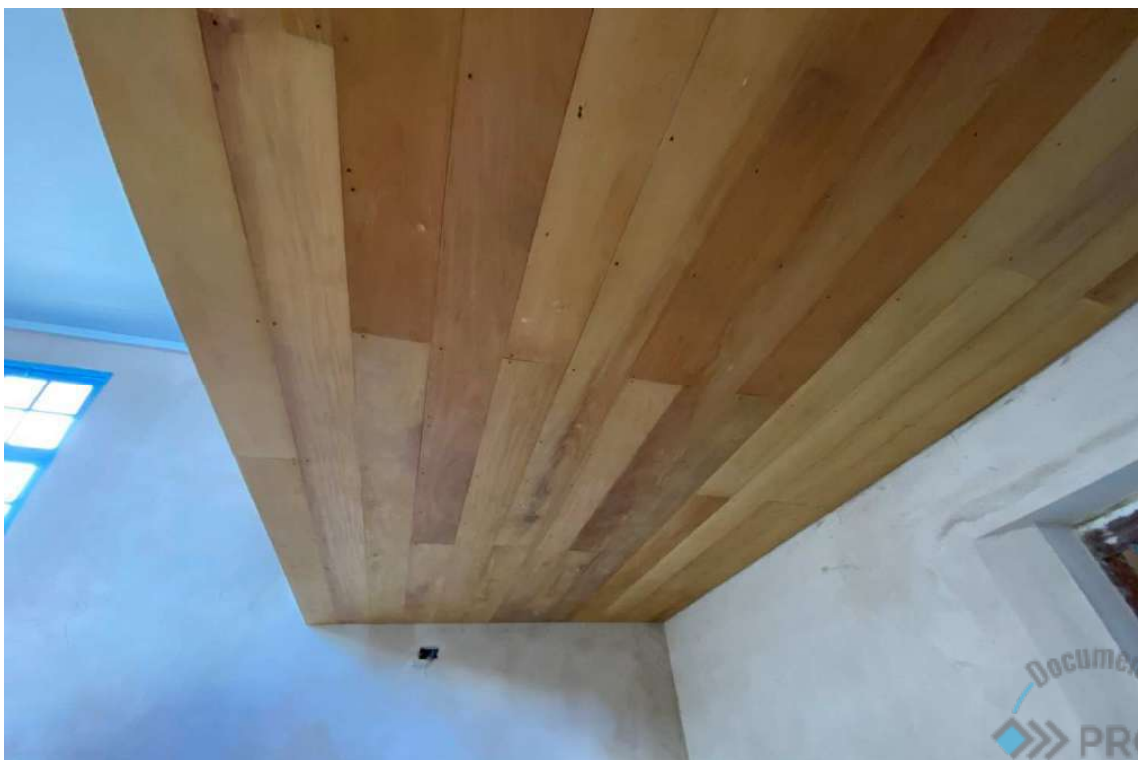
Foto 56 – Vista inferior do forro sob a estrutura do coro.
