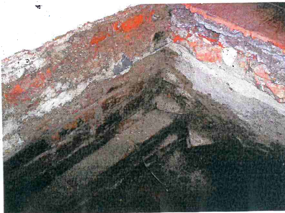
Figura 112 – parte das fundações expostas pela escavação arqueológica realizada no interior da Capela. Foto: SUPETEC
