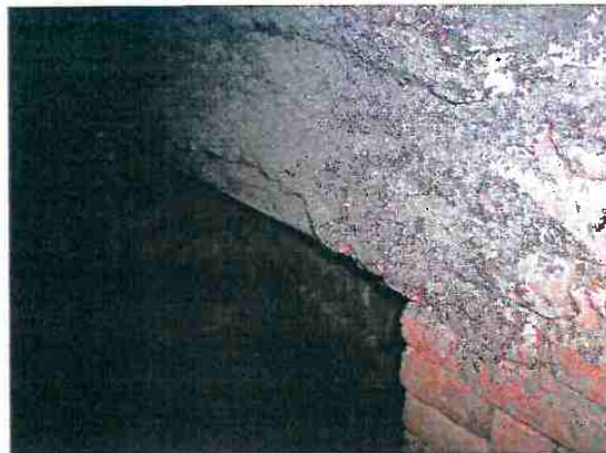
Figura 26 – Detalhe da parte inferior da face posterior do retábulo (lado direito). Pode-se observar rejuntas em argamassa de barro e uma melhor qualidade na execução da parede. Foto: Rita Gnutzmann Veiga. 2005
