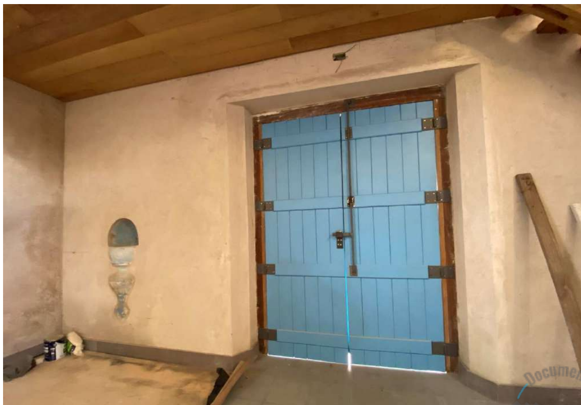
Foto 42 – Porta entrada principal, vista interna.
