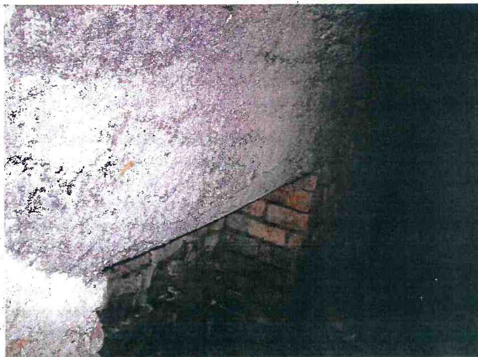
Figura 27 – Detalhe da parte inferior da face posterior do retábulo (lado esquerdo). Pode-se observar rejuntas em argamassa de barro e uma melhor qualidade na execução da parede. Foto: Rita Gnutzmann Veiga. 2005
