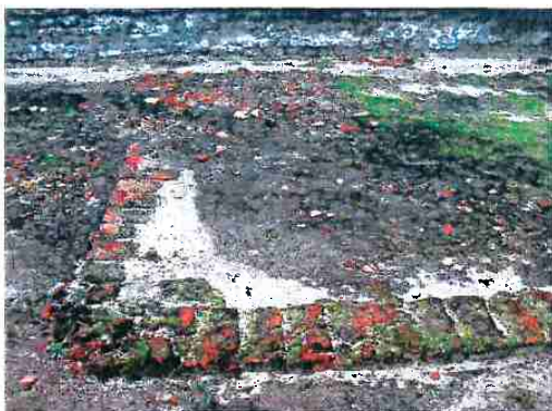
Figura 49 – base de uma estrutura externa, feita de tijolos Foto: LEPAN - 2007
