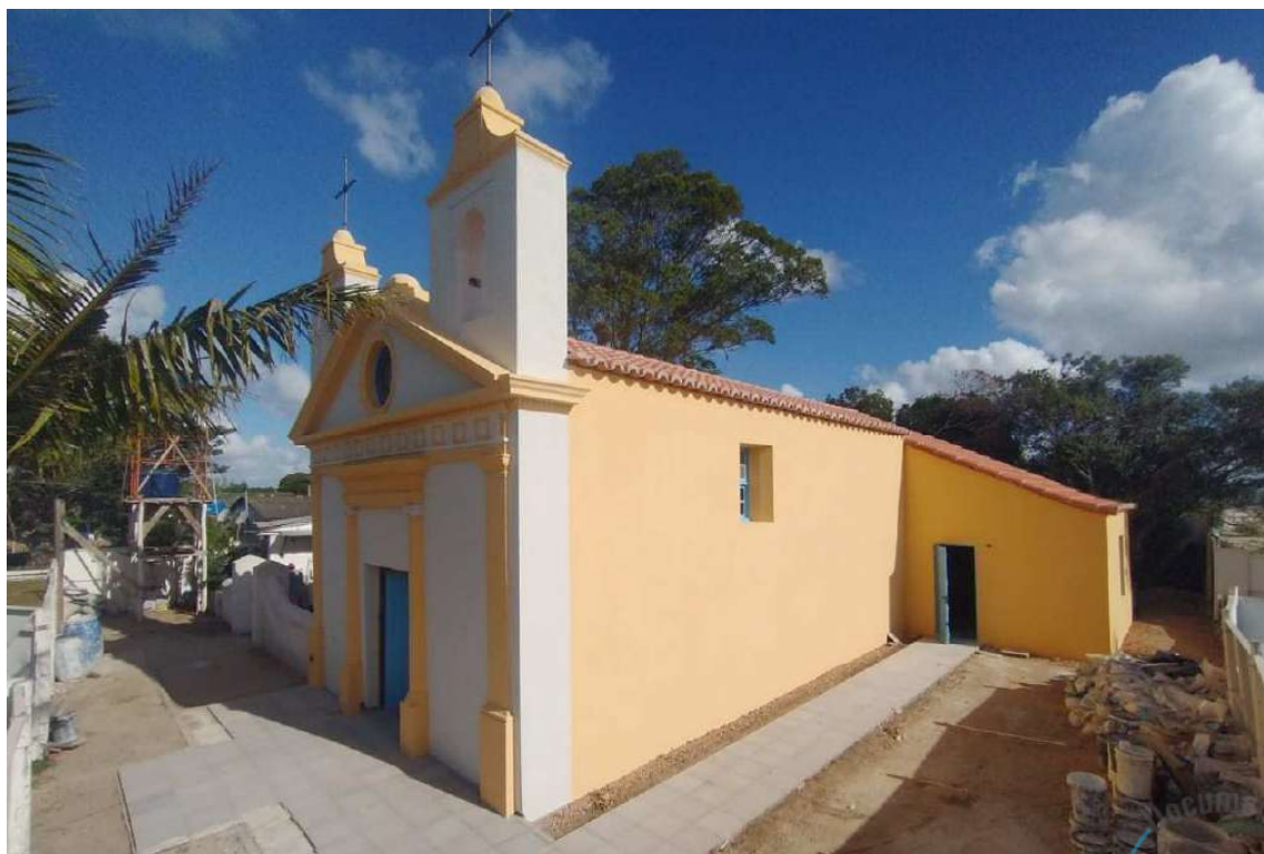
Foto 18 – Pintura das paredes externas com tinta silicato transpirável.
