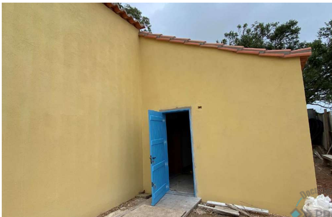
Foto 10 – Pintura das paredes externas com tinta silicato transpirável
