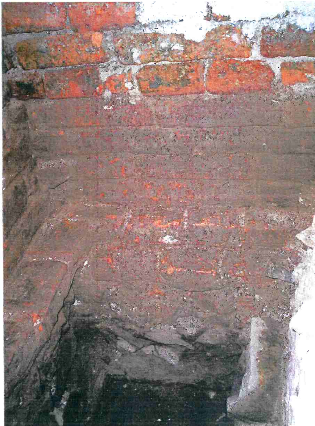
Figura 116 – parte das fundações expostas pela escavação demonstrando a área de intersecção da atual sacristia com a parede da Capela. As fundações antigas e não utilizadas acompanham a profundidade e características das fundações da Nave da Capela. Isto pode indicar que estas estruturas podem ter sido as esperas pelo referido consistório citado nos arquivos da Câmara Municipal no século XIX. Foto: SUPETEC
