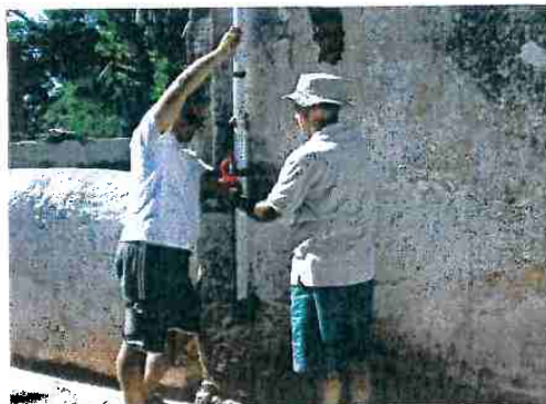
Figura 103 – instalação de aparelho medidor na parede norte. Foto: Escola de Engenharia
