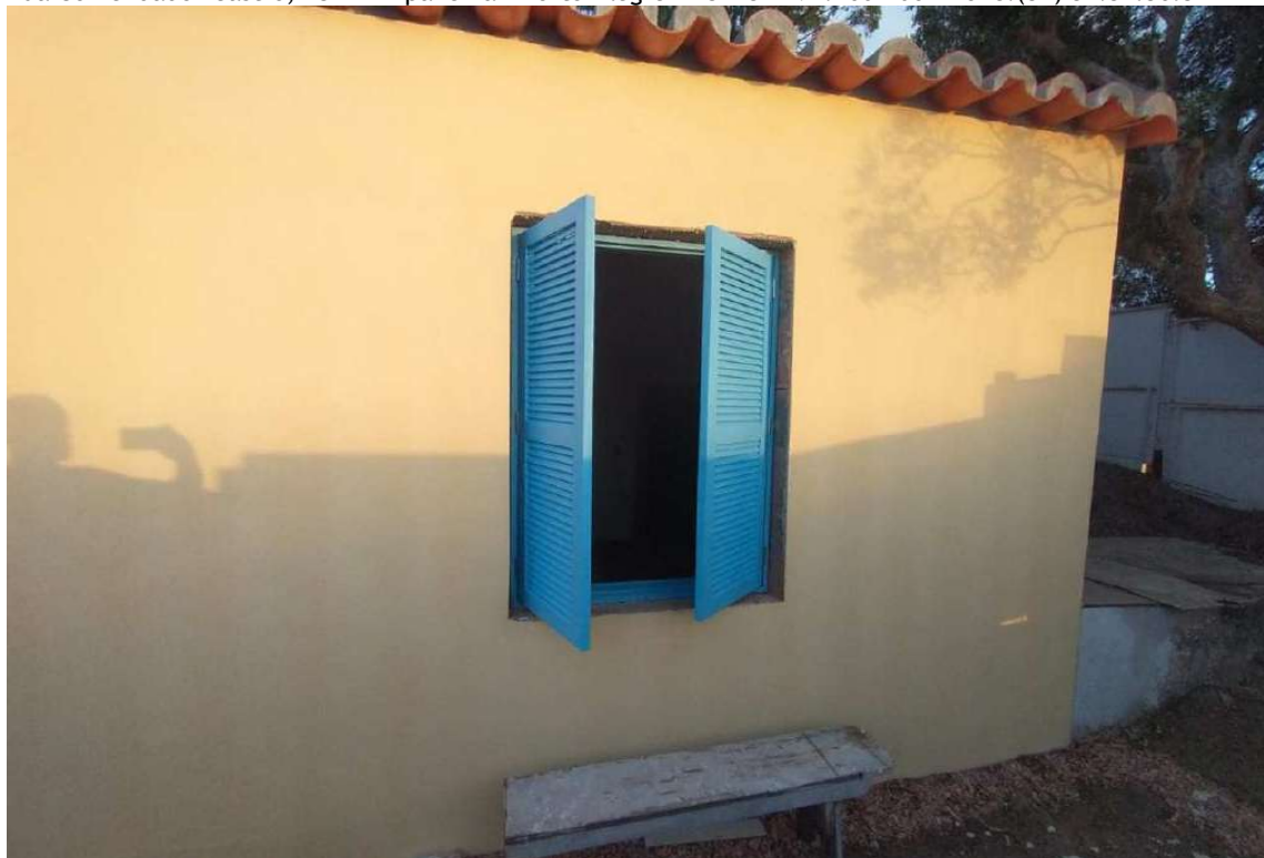
Foto 45 – Janela Sacristia, vista externa.
