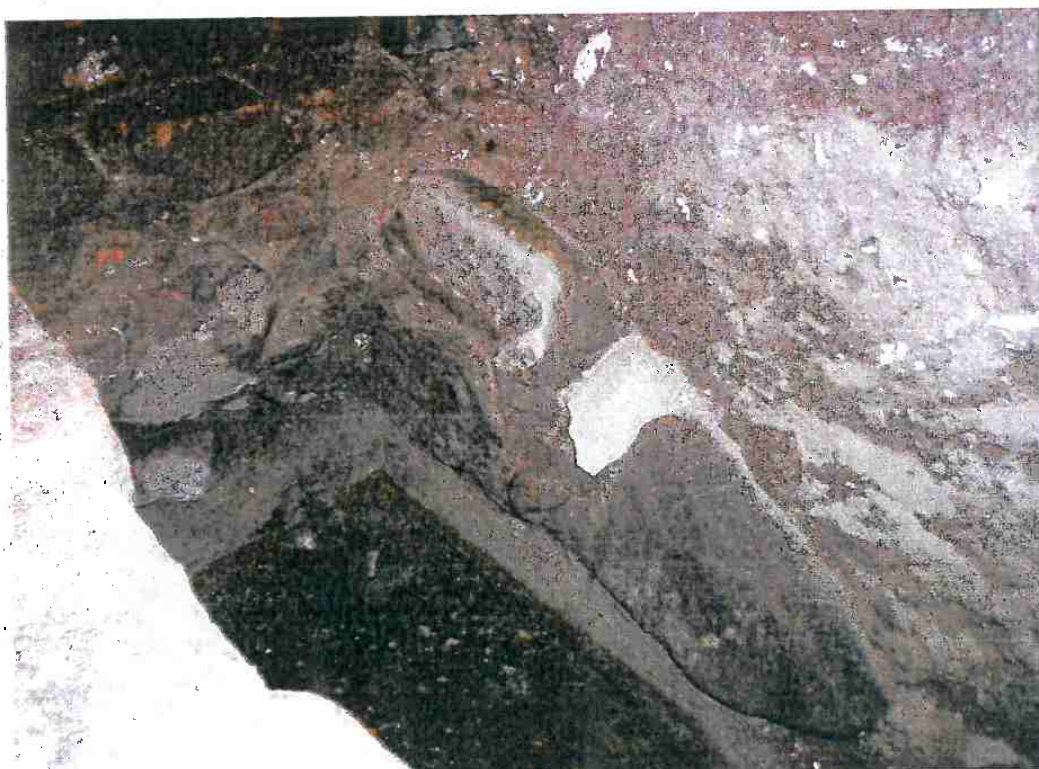
Figura 115 – parte das fundações expostas pela escavação demonstrando a área de interseção da atual sacristia com a parede da Capela. Nota-se uma grande pedra de basalto colocada nesta interseção e a diferença de profundidade entre as fundações da capela e as da parede norte sacristia que são bem mais superficiais. Foto: SUPETEC
