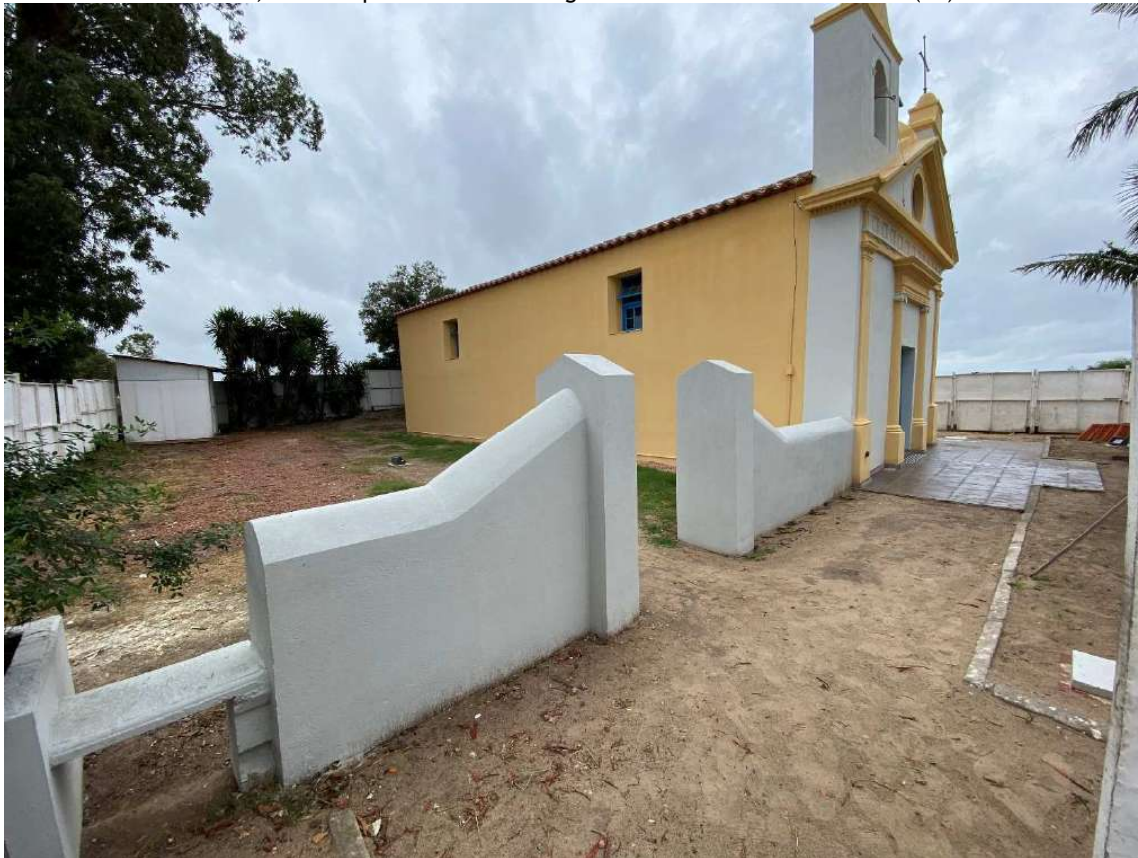
Foto 10 – Pintura das paredes externas e muro finalizada.
