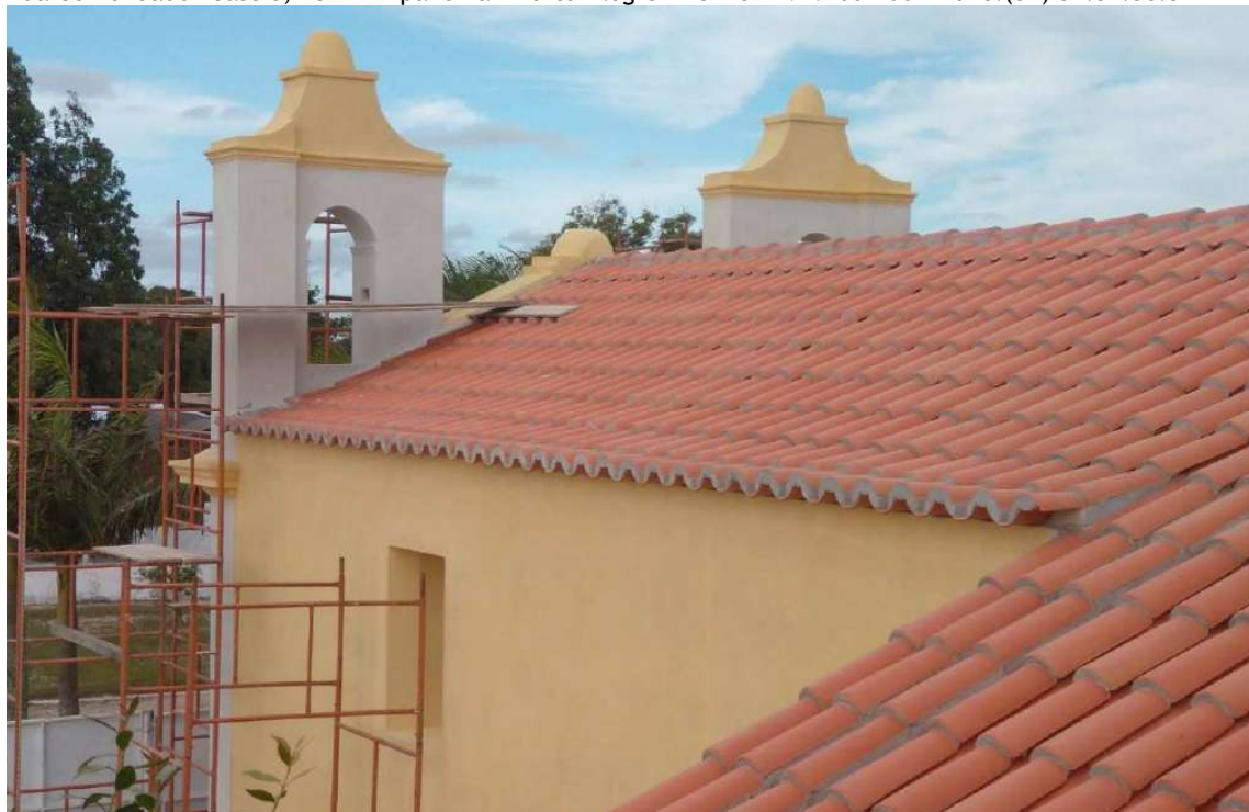
Foto 15 – Pintura das paredes externas com tinta silicato transpirável.
