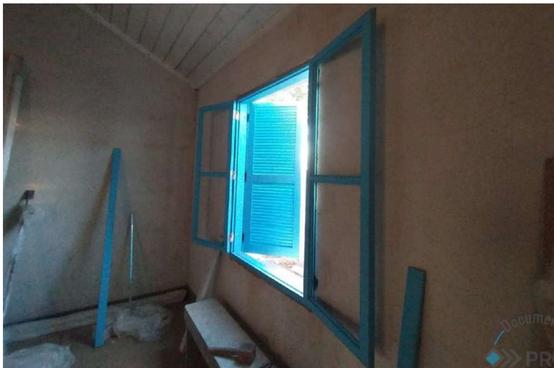
Foto 46 – Janela sacristia, vista interna.
