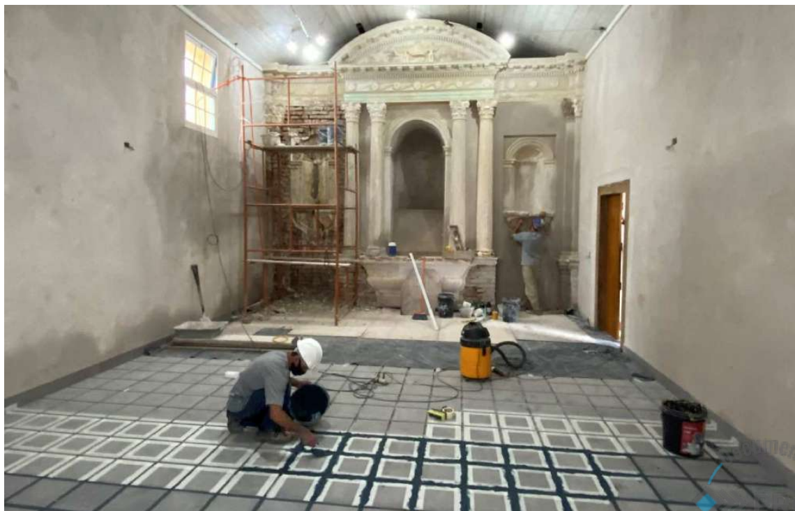
Foto 50 - Execução de rejunte colorido na nave principal.
