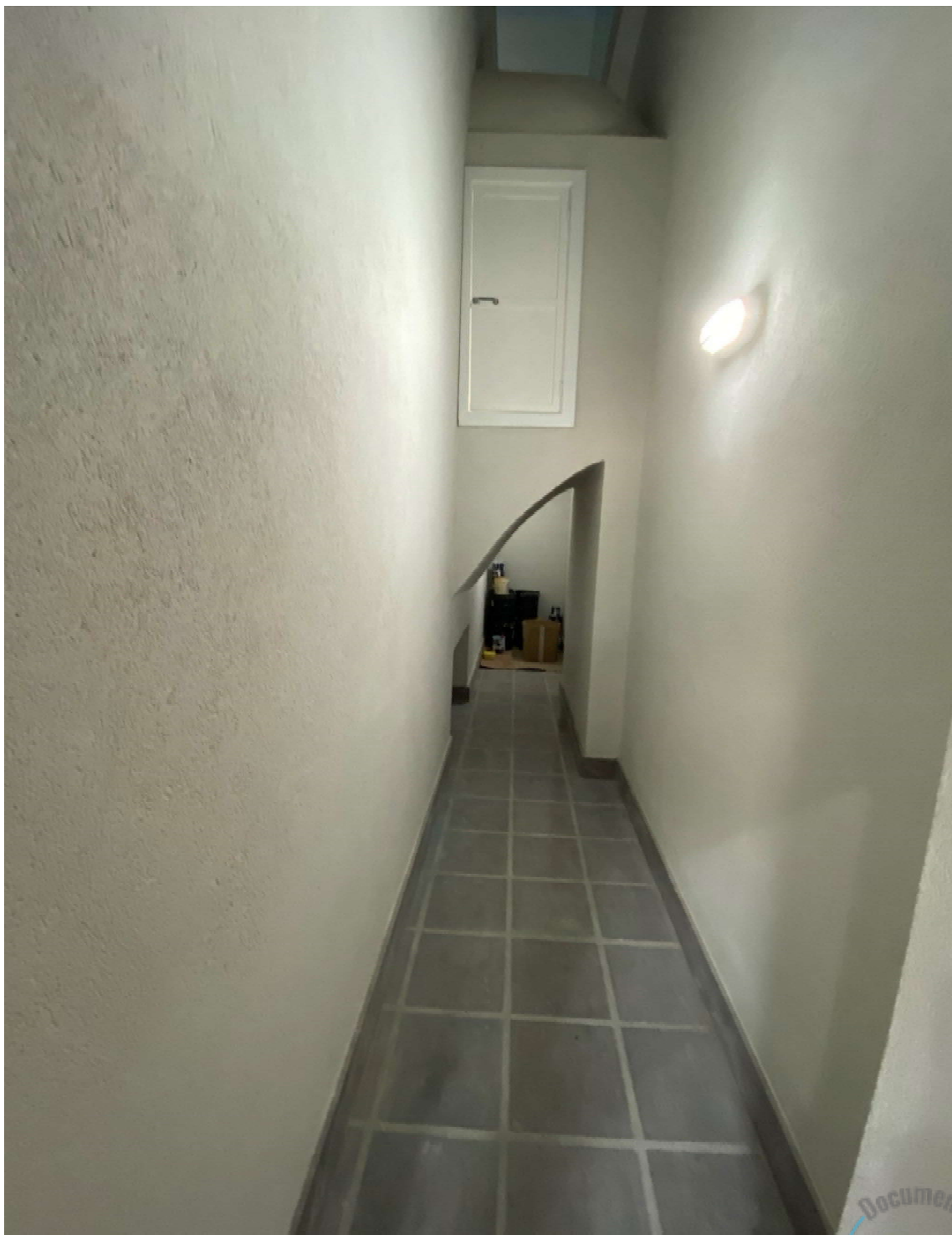
Foto 17 – Compartimento atrás do altar mor, paredes pintadas, iluminação instalada e porta acesso ao altar mor instalada.
