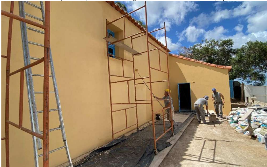
Foto 13 – Pintura das paredes externas com tinta silicato transpirável
