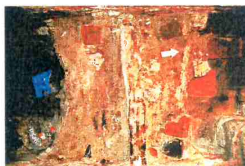
Figura 75 – quadrícula TE1 viga de madeira.
