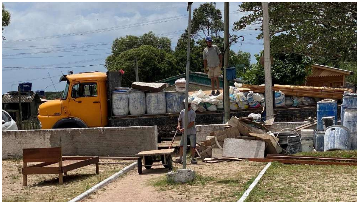
Foto 81 – Descarga de materiais para obra.
