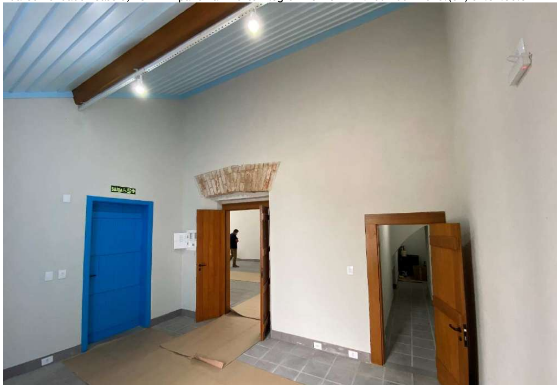
Foto 42 – Pintura das paredes internas e forro da sacristia finalizados.
