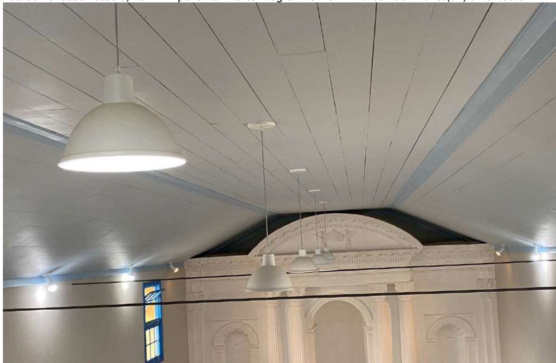
Foto 66 – Luminárias da nave principal.
