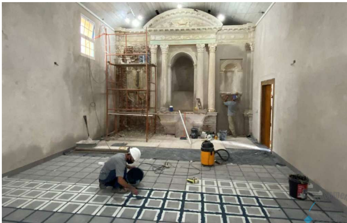
Foto 50 - Execução de rejunte colorido na nave principal.
