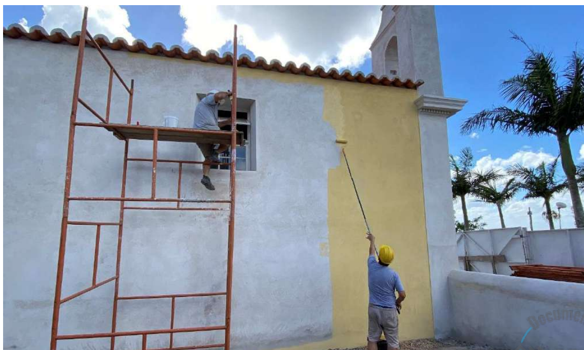
Foto 6 – Pintura das paredes externas com tinta silicato transpirável.
