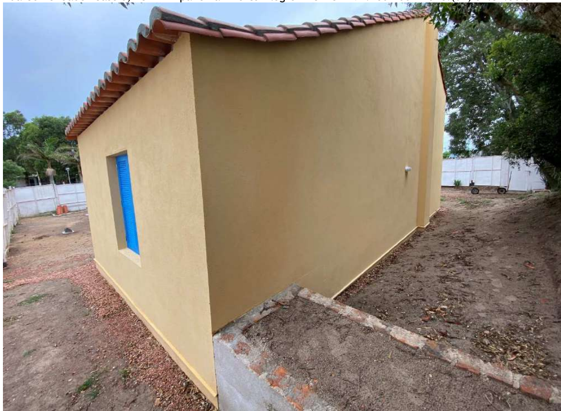
Foto 6 – Pintura das paredes externas finalizada.
