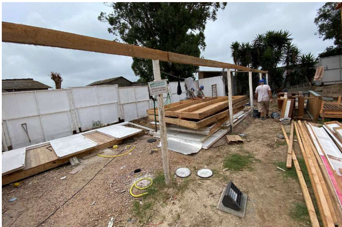
Foto 72 – Desmontagem dos galpões de obra.
