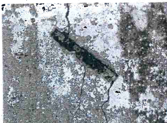
Figura 43 – Grampo de ferro na parede externa oeste. Foto: LEPAN - 2007
