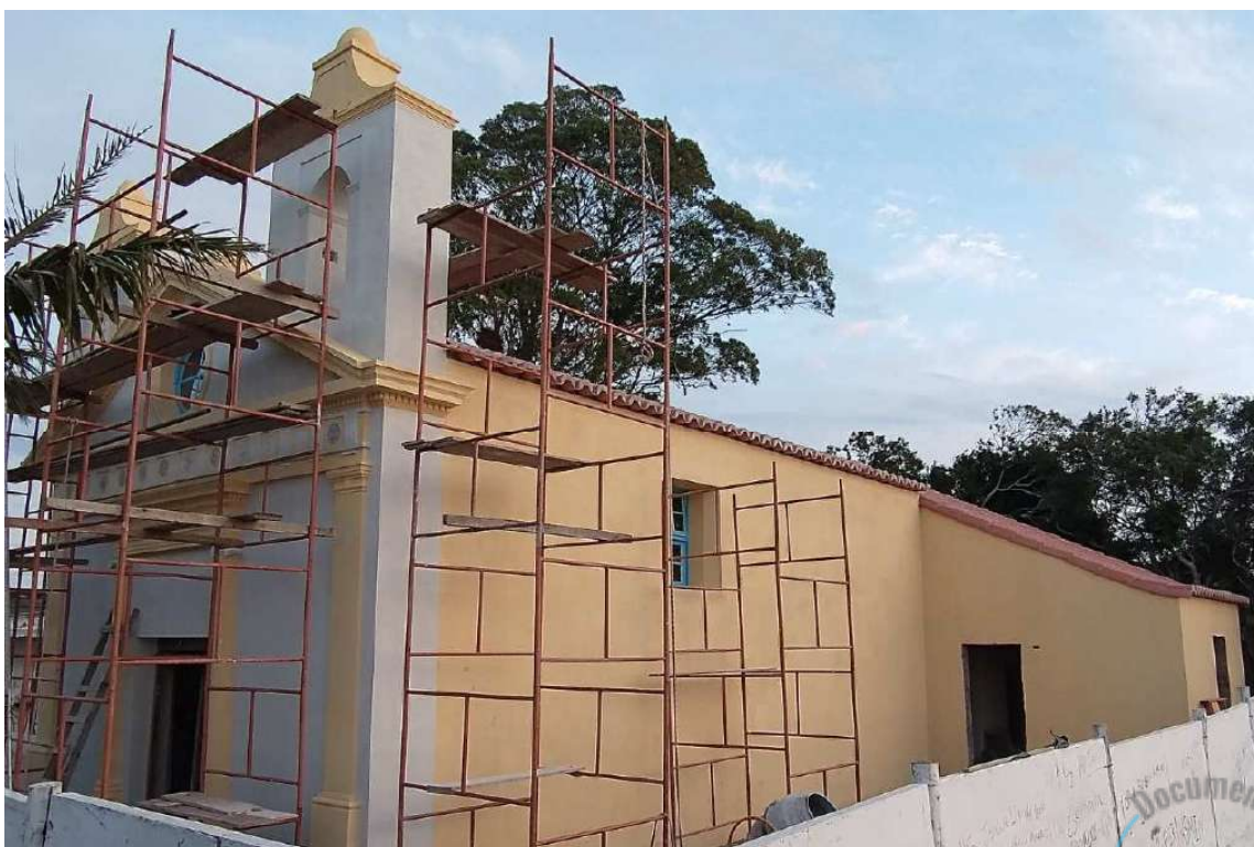
Foto 12 – Pintura das paredes externas com tinta silicato transpirável
