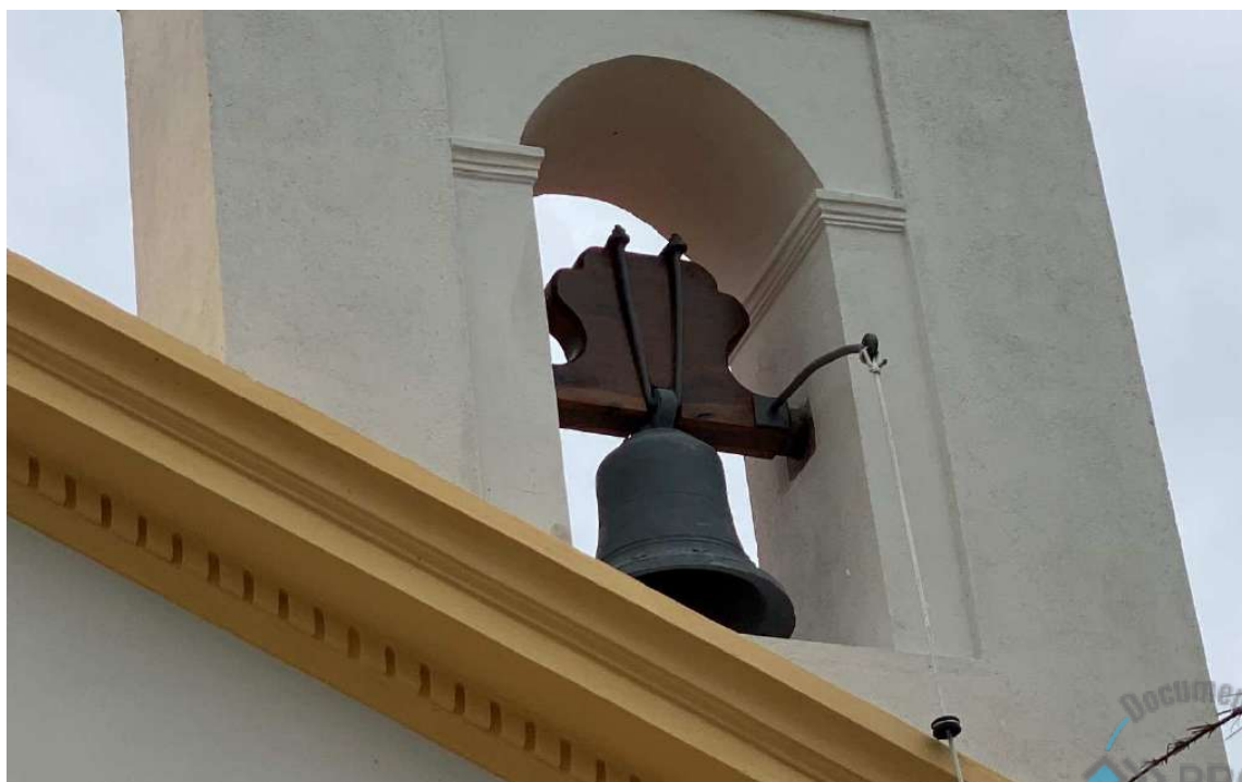
Foto 35 – Sino instalado, e com corda para acionamento.
