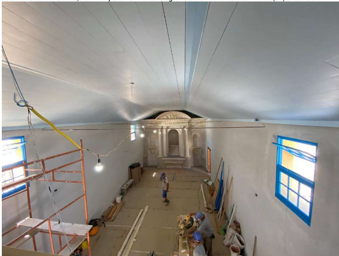
Foto 75 – Forros e paredes pintados.
