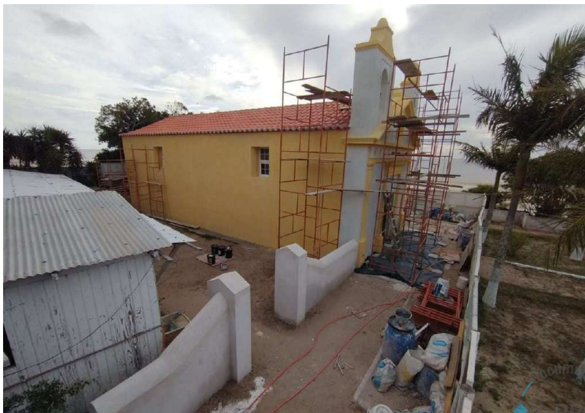
Foto 14 – Pintura das paredes externas com tinta silicato transpirável
