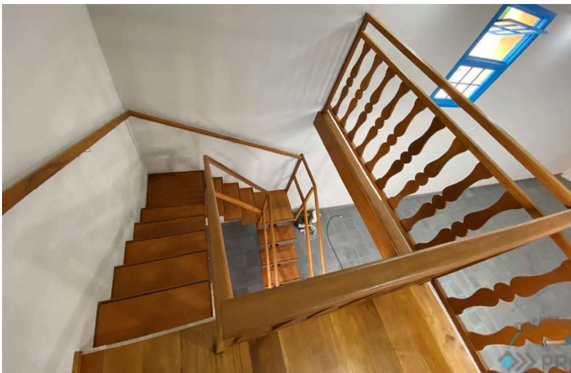
Foto 31 – Guarda corpos e assoalho coro finalizados. Vista superior da escada.
