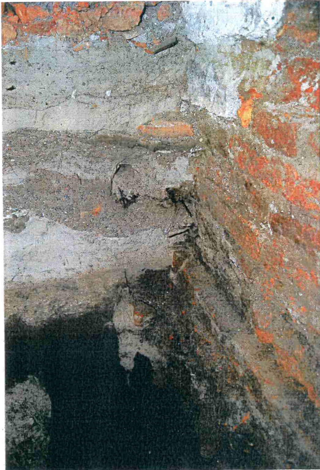
Figura 122 – fundações da parede leste da capela, na região onde foram encontrados enterramentos secundários. Foto: SUPETEC
