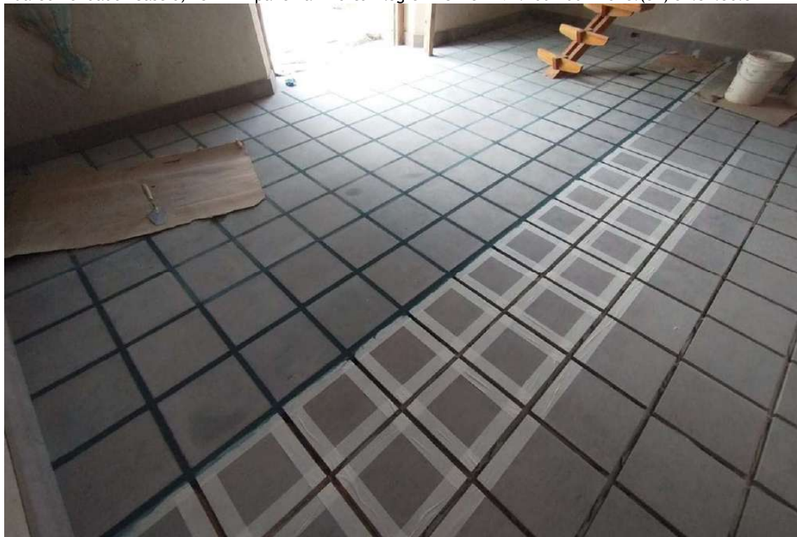
Foto 51 - Execução de rejunte colorido na nave principal.
