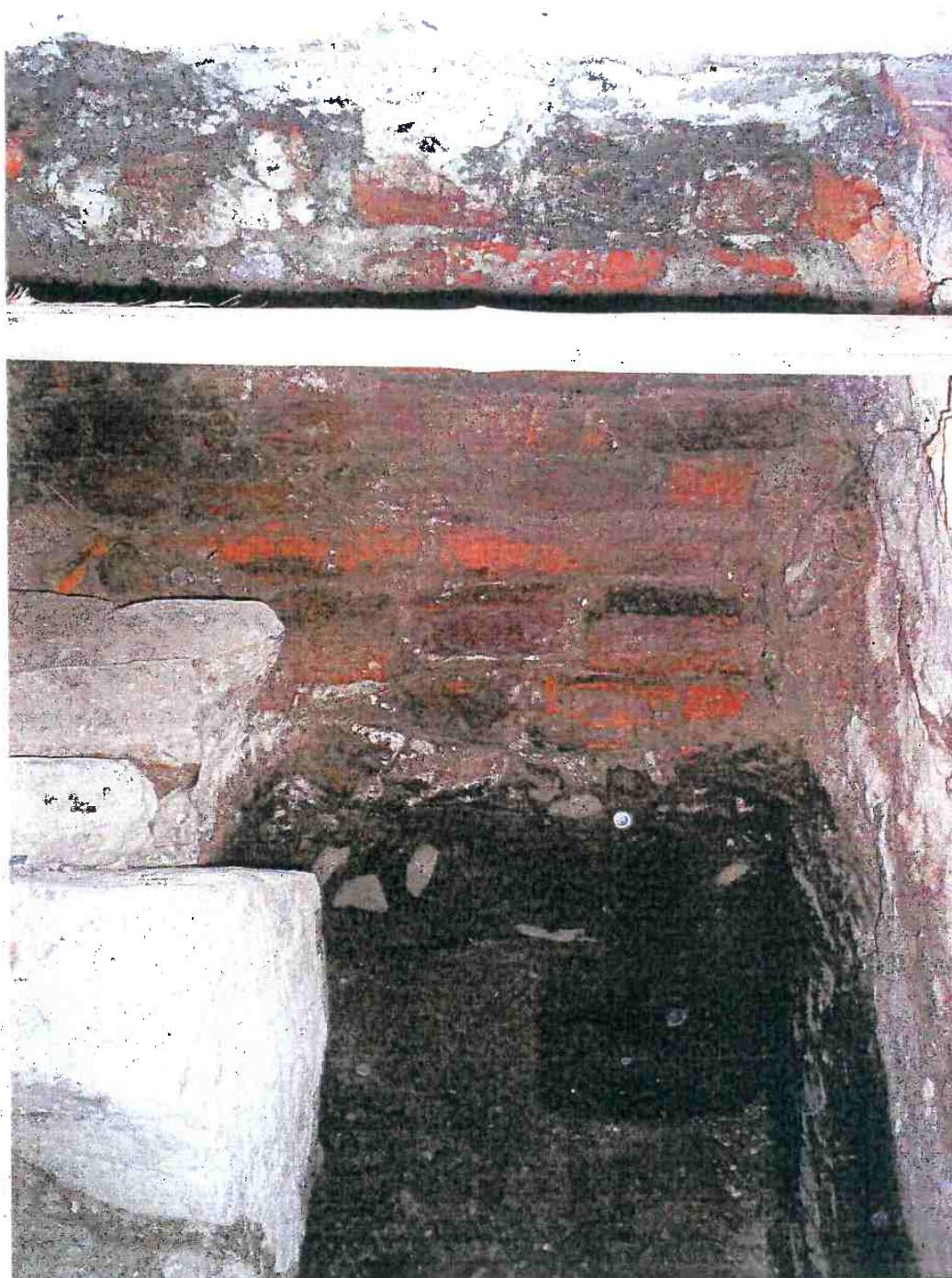
Figura 117 – parte das fundações expostas pela escavação no interior da capela. Observa-se que não existem rachaduras ou tijolos desagregados no trecho de fundações da alvenaria. No lado esquerdo da foto, podem-se observar pedaços de rocha (basalto) que serviam para apoiar os barotes de madeira do piso. As escavações não avançaram muito além da base de basalto das fundações encontradas para não fragilizar a edificação. Foto: SUPETEC
