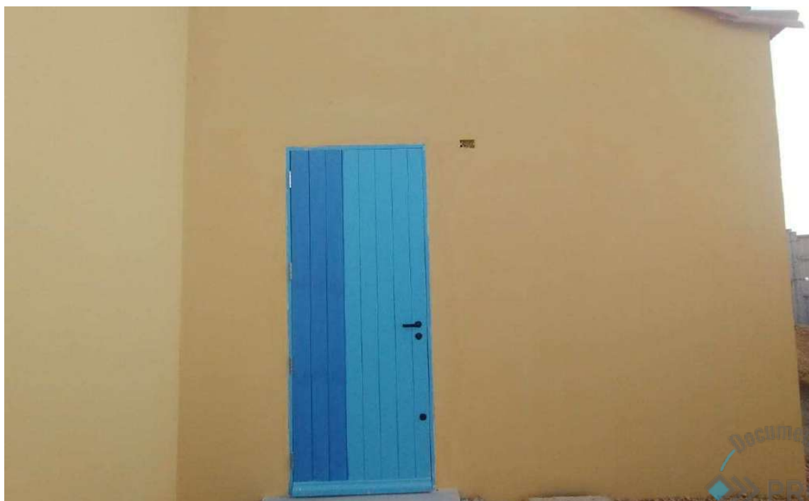
Foto 80 – Teste cor esquadrias.
