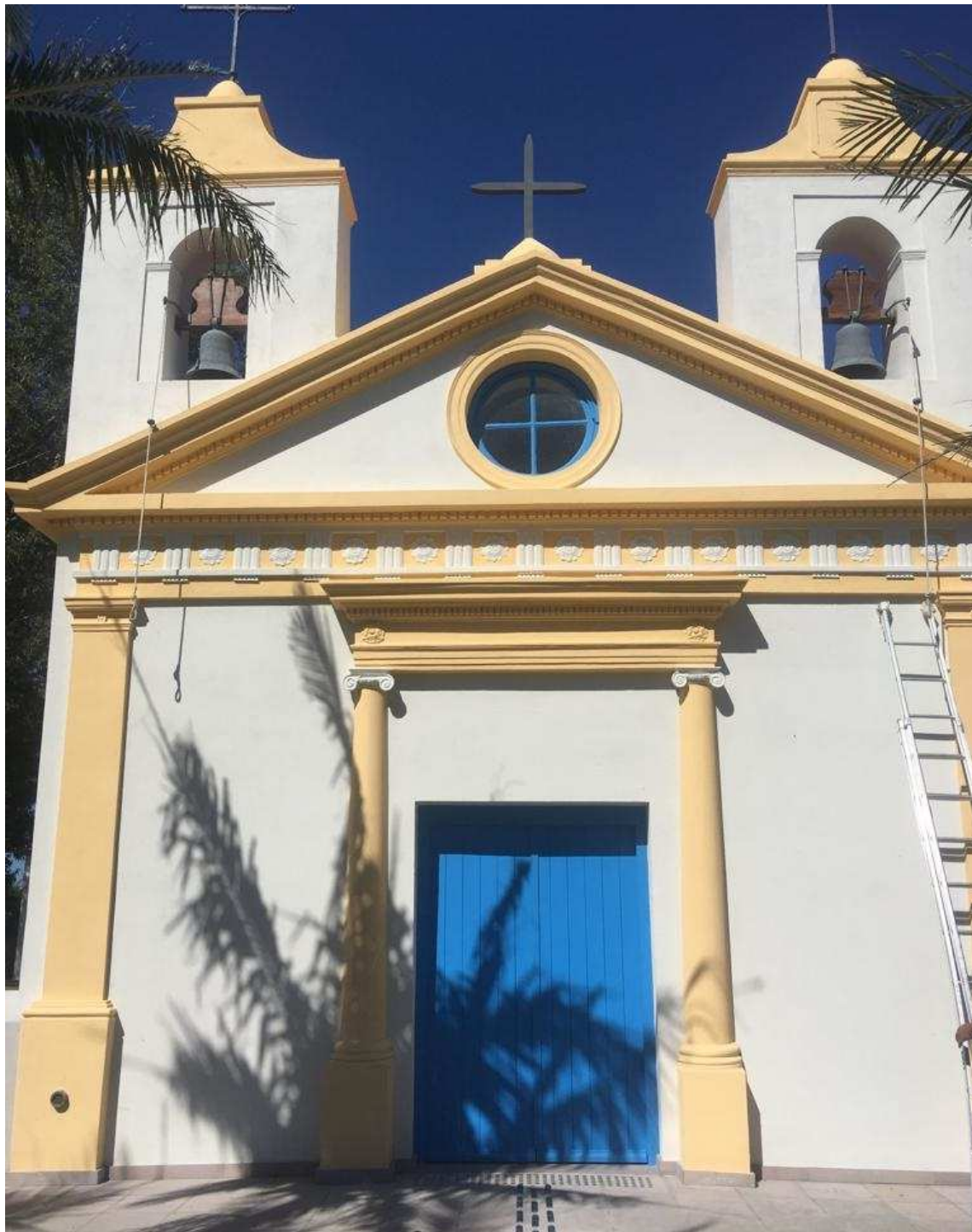
Foto 1 – Pintura finalizada, cordas dos sinos instaladas.
