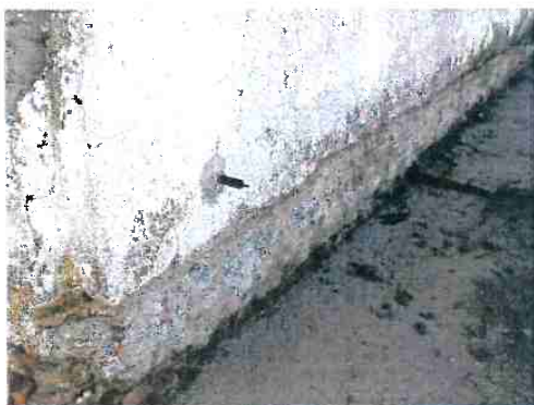
Figura 100 – referencial colocado na parte próxima a face norte da fachada oeste. Foto: Escola de Engenharia
