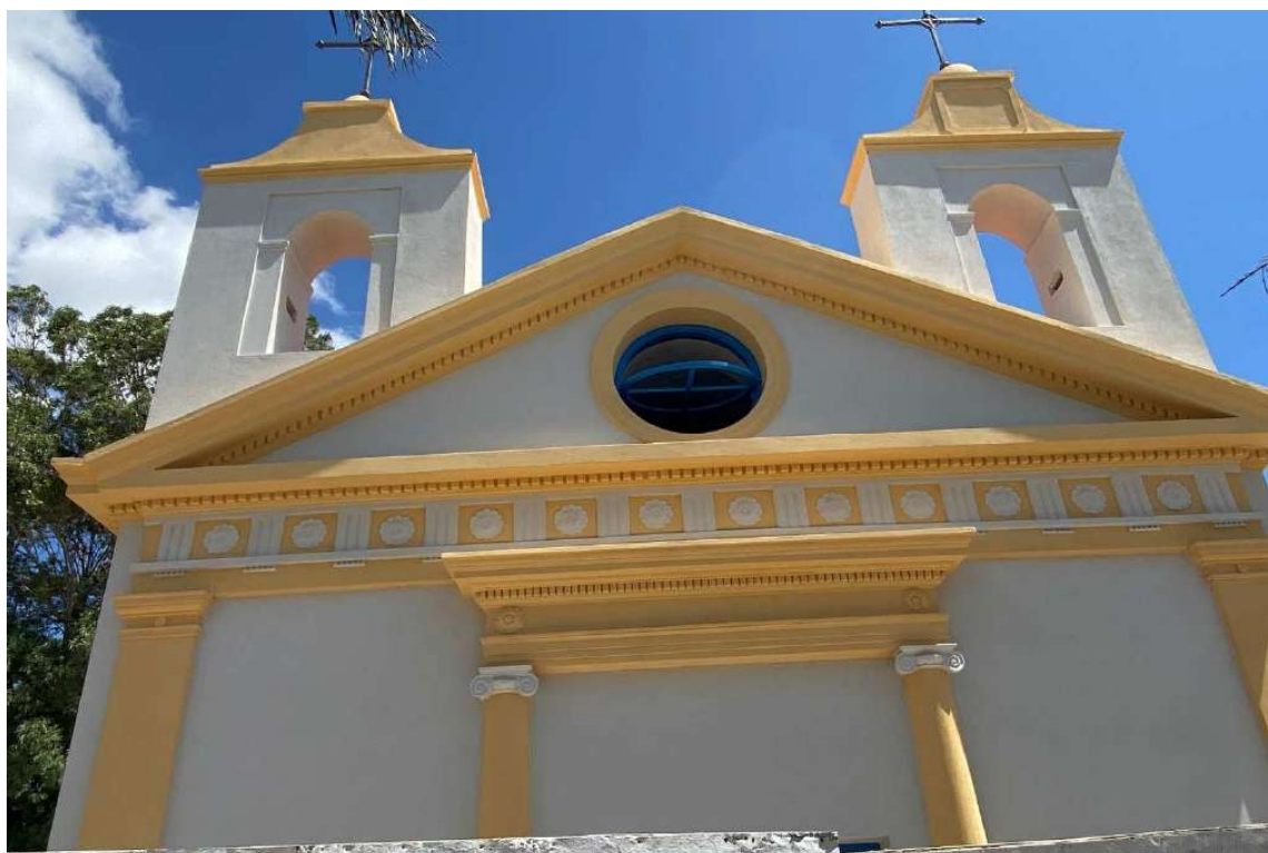
Foto 4 – Pintura fachada principal.
