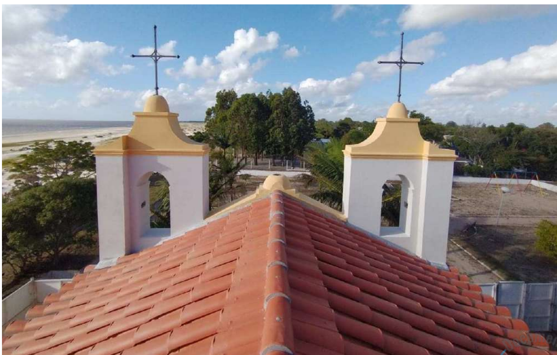
Foto 16 – Pintura das paredes externas com tinta silicato transpirável.
