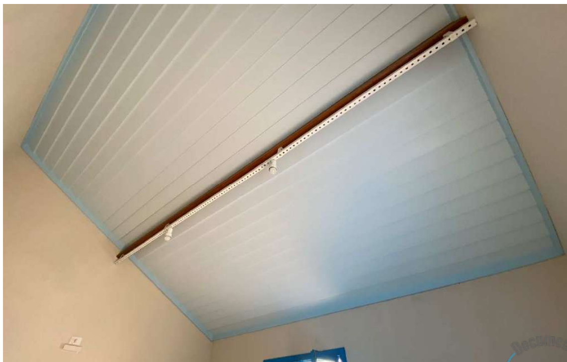
Foto 67 – Luminárias da sacristia.
