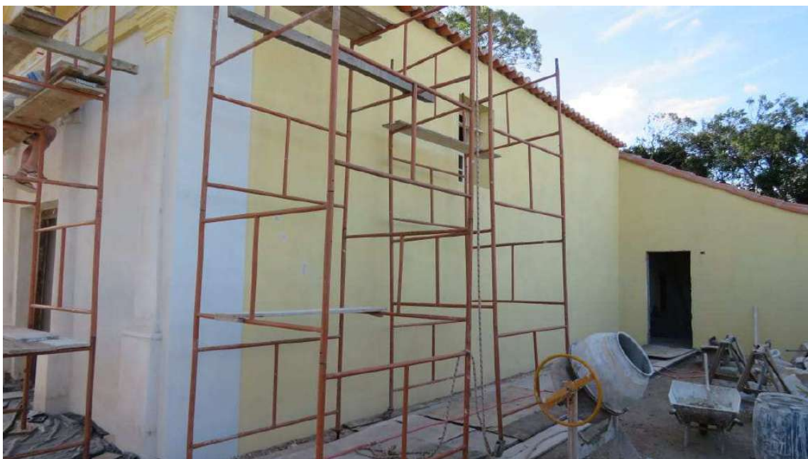
Foto 8 – Pintura das paredes externas com tinta silicato transpirável
