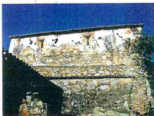
Figura 15 – Lateral direita da capela da Fortaleza São José da Ponta Grossa – Florianópolis, SC. Foto: Rita Gnutzmann Veiga. 2009
