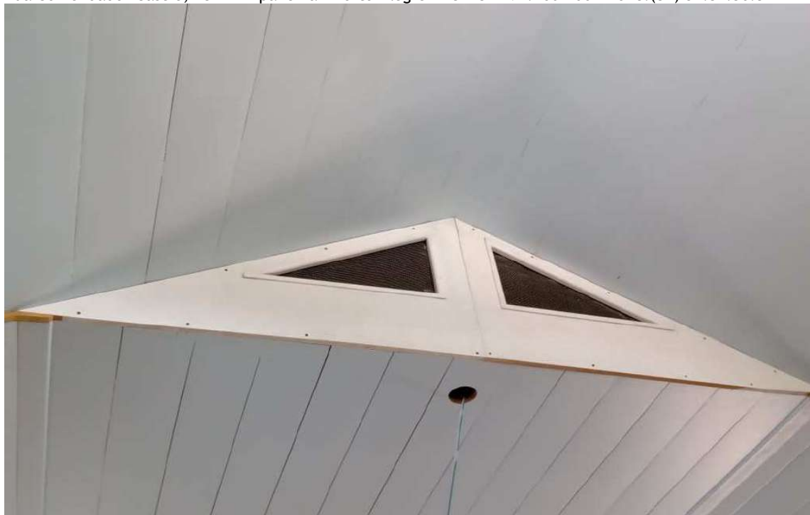
Foto 77 – Forro pintado, detalhe fechamento no forro próximo ao coro.
