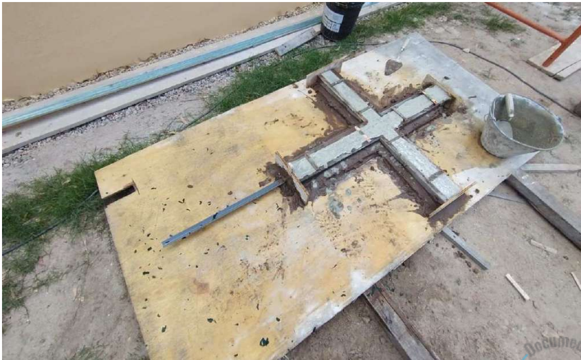
Foto 82 – Forma e concretagem com graute da cruz principal.
