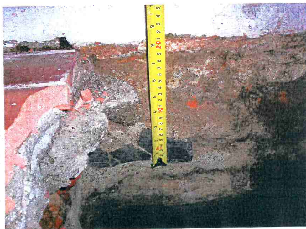
Figura 41 – dois tipos de revestimento diferentes encontrados na parede direita da capela. Abaixo do revestimento escuro (abaixo da trena) pode-se ver a cor creme provavelmente original e mais antiga do prédio. Foto: Rita Gnutzmann Veiga - 2009
