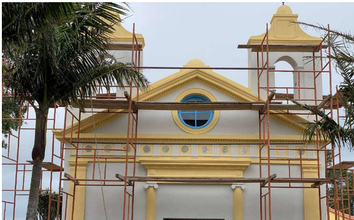
Foto 1 – Pintura da fachada principal.
