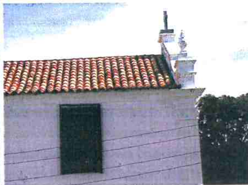
Figura 133 – detalhe da cobertura da Capela Nossa Senhora da Boa Viagem, na 5ª seção da barra em São José do Norte. Foto: Rita Gnutzmann Veiga, 2009.
