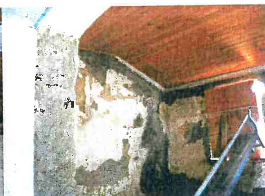
Figura 129 – vista parcial do forro da sacristia. Pode-se observar a implementação de uma cinta de concreto sobre as paredes. Foto: SUPETEC, 2009.
