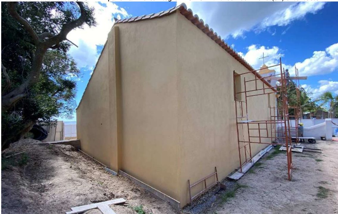
Foto 7 – Pintura das paredes externas com tinta silicato transpirável.
