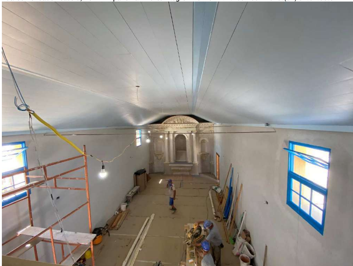
Foto 75 – Forros e paredes pintados.
