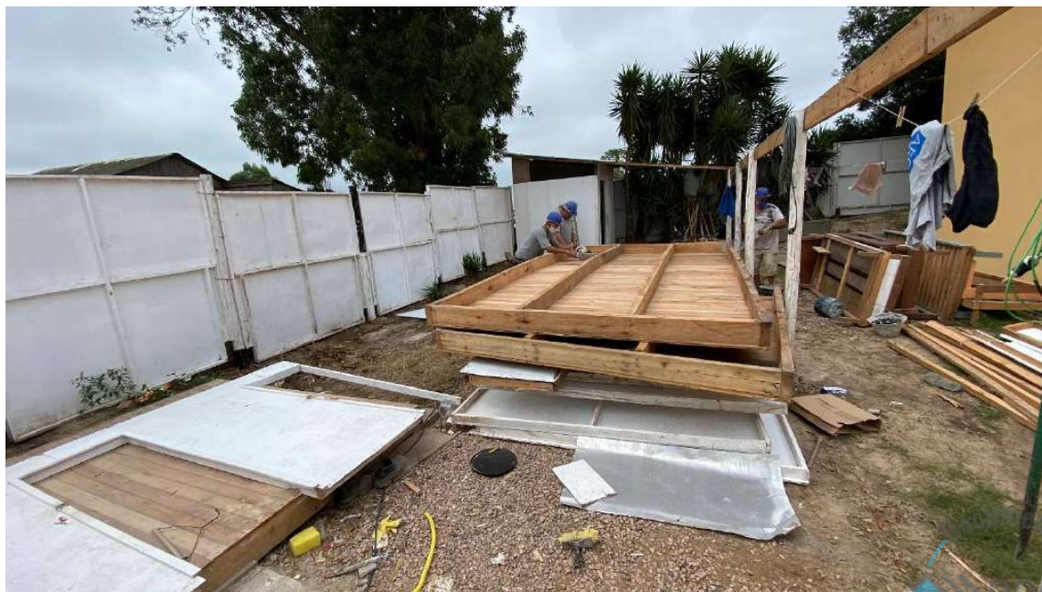
Foto 73 – Desmontagem dos galpões de obra.
