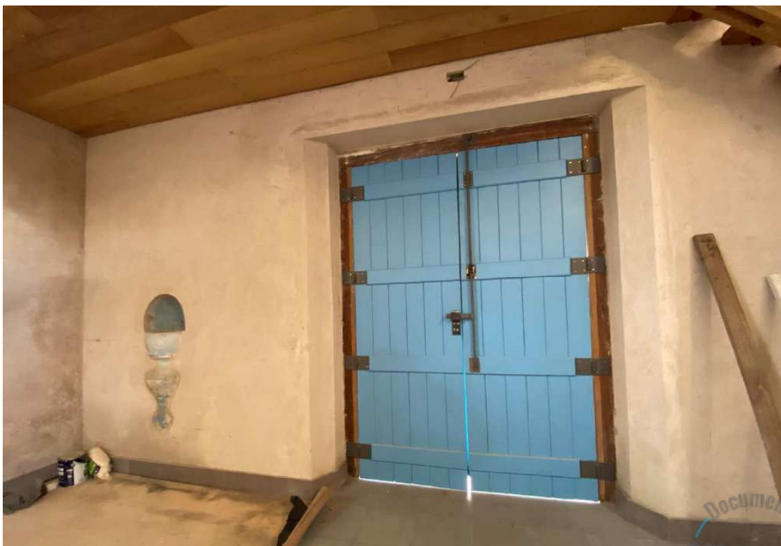
Foto 42 – Porta entrada principal, vista interna.
