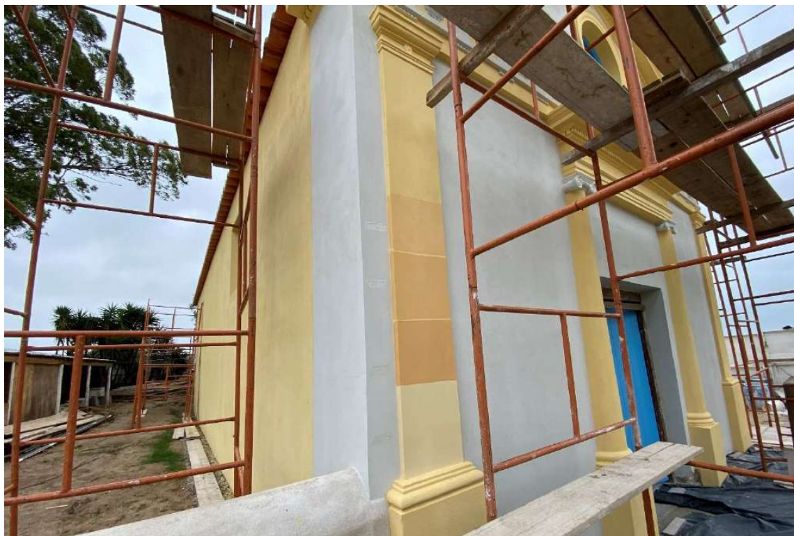
Foto 79 – Testes de cores paredes externas.
