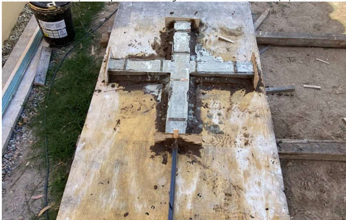
Foto 83 – Forma e concretagem com graute da cruz principal.
