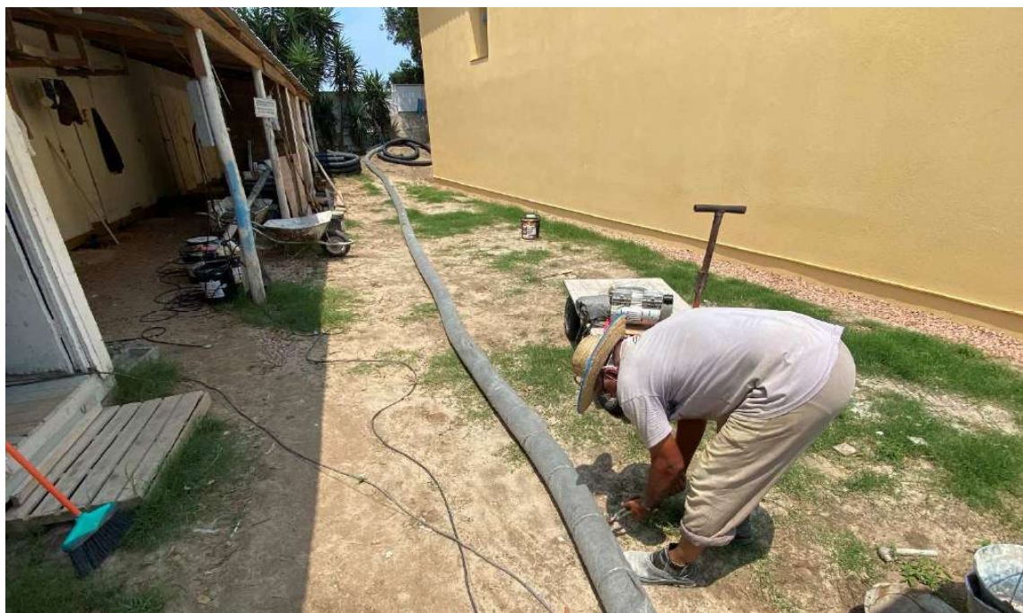
Foto 69 – Preparação tubos dreno para redes externas ao pátio.
