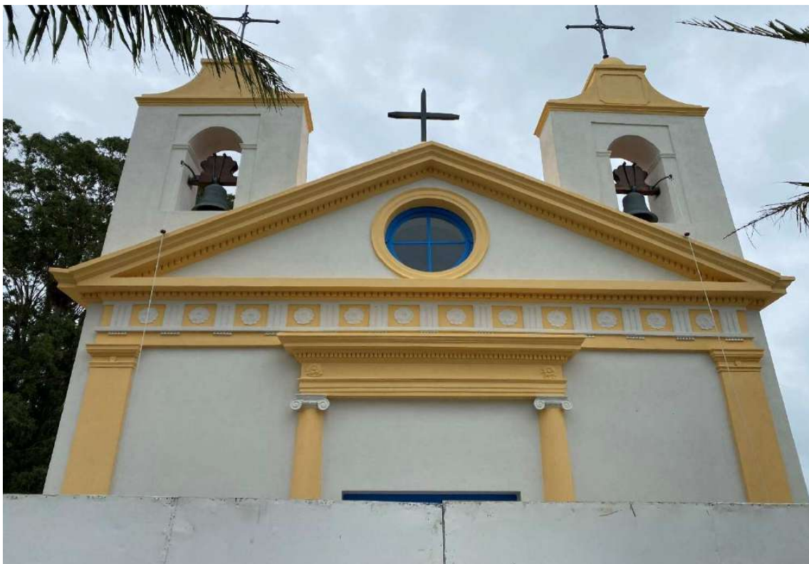
Foto 1 – Pintura finalizada, sinos instalados.
