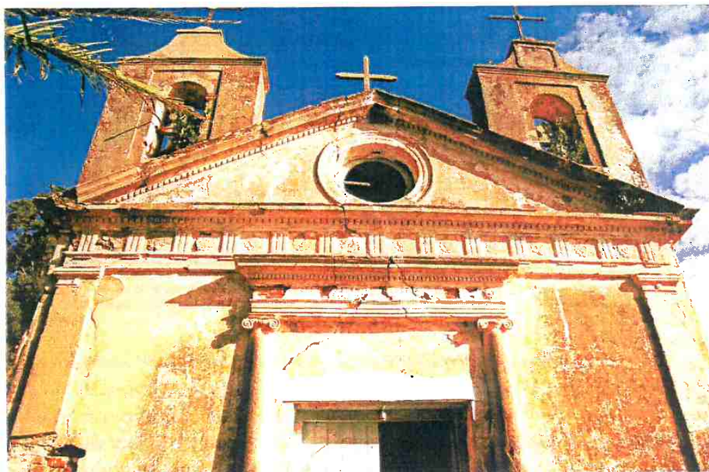
Figura 31 – vista da fachada norte mostrando o estado atual da edificação. Foto: Mariana de Araújo Isquierdo.2010.
