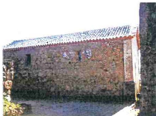
Figura 14 – Lateral esquerda da capela da Fortaleza São José da Ponta Grossa – Florianópolis, SC. Foto: Rita Gnutzmann Veiga. 2009.
