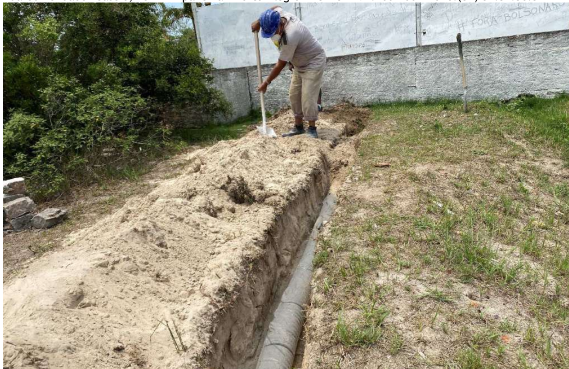
Foto 70 – Redes drenos externos.
