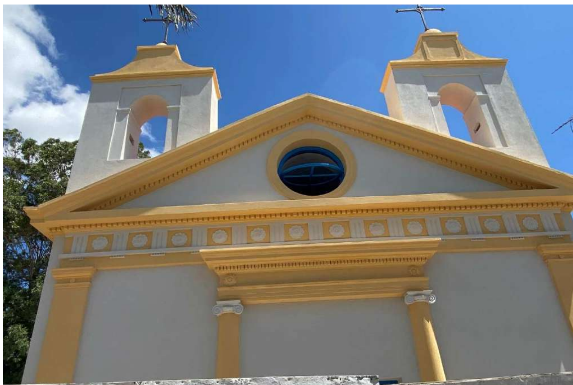
Foto 4 – Pintura fachada principal.
