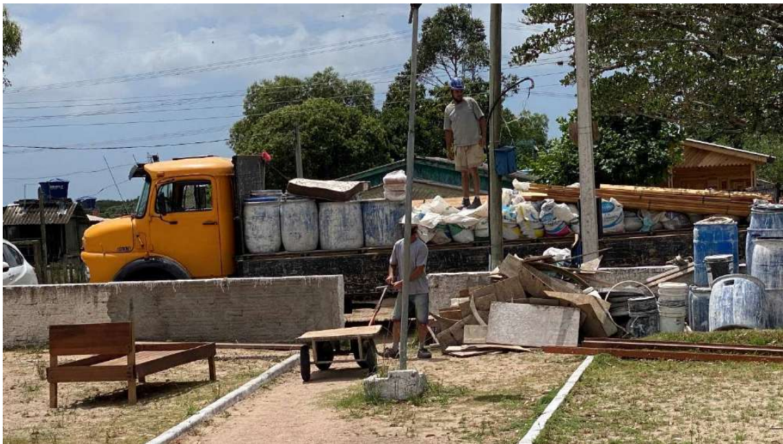
Foto 81 – Descarga de materiais para obra.
