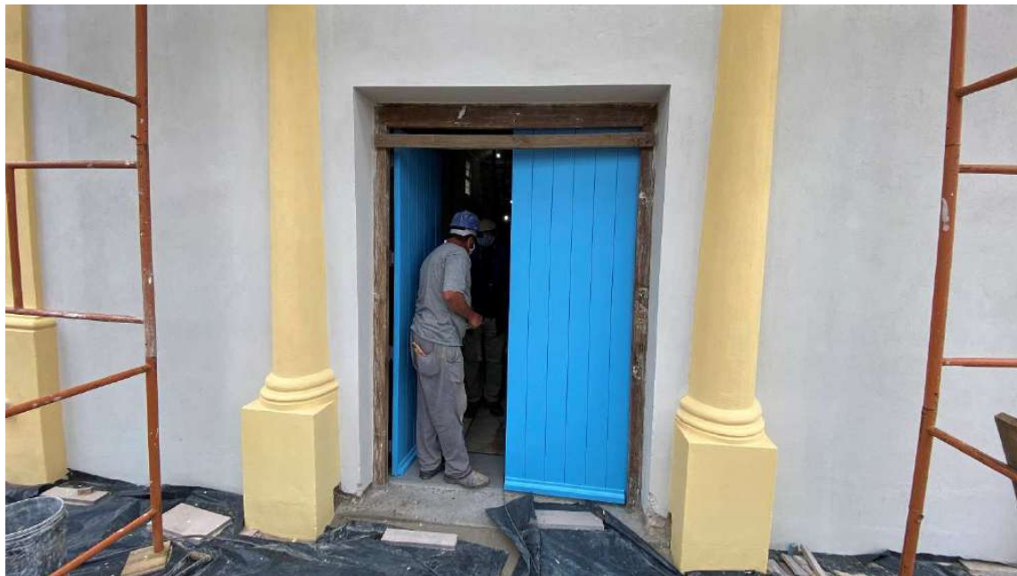
Foto 41 – Porta entrada principal, vista externa.
