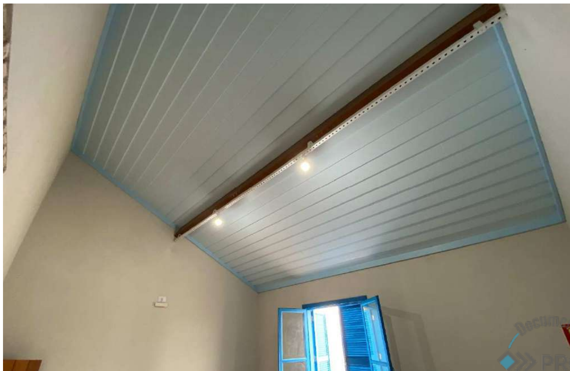
Foto 43 - Pintura das paredes internas e forro da sacristia finalizados.
