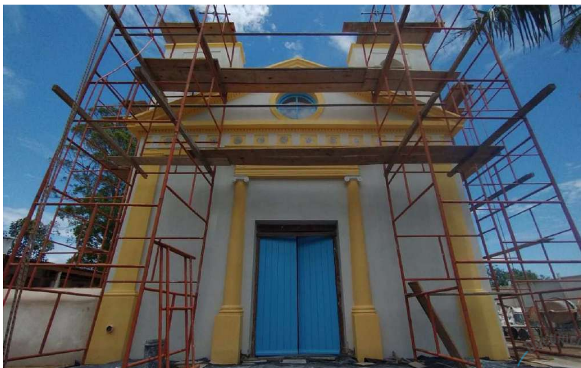
Foto 2 – Pintura da fachada principal.
