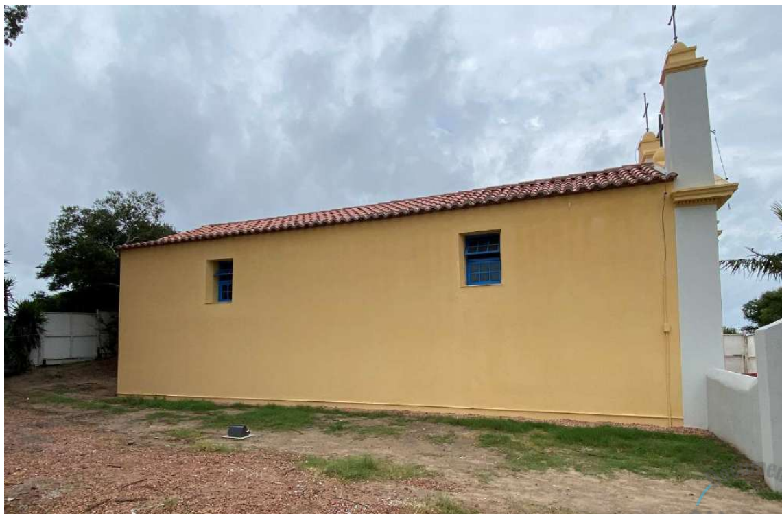
Foto 53 – Cabo NU descendo da torre, eletroduto de 1” e caixa, lado pátio interno.
