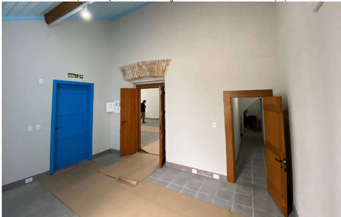
Foto 20 – Porta entrada sacristia, vista interna, porta entre a sacristia e a nave principal, e porta acesso ao compartimento atrás do altar mor.
