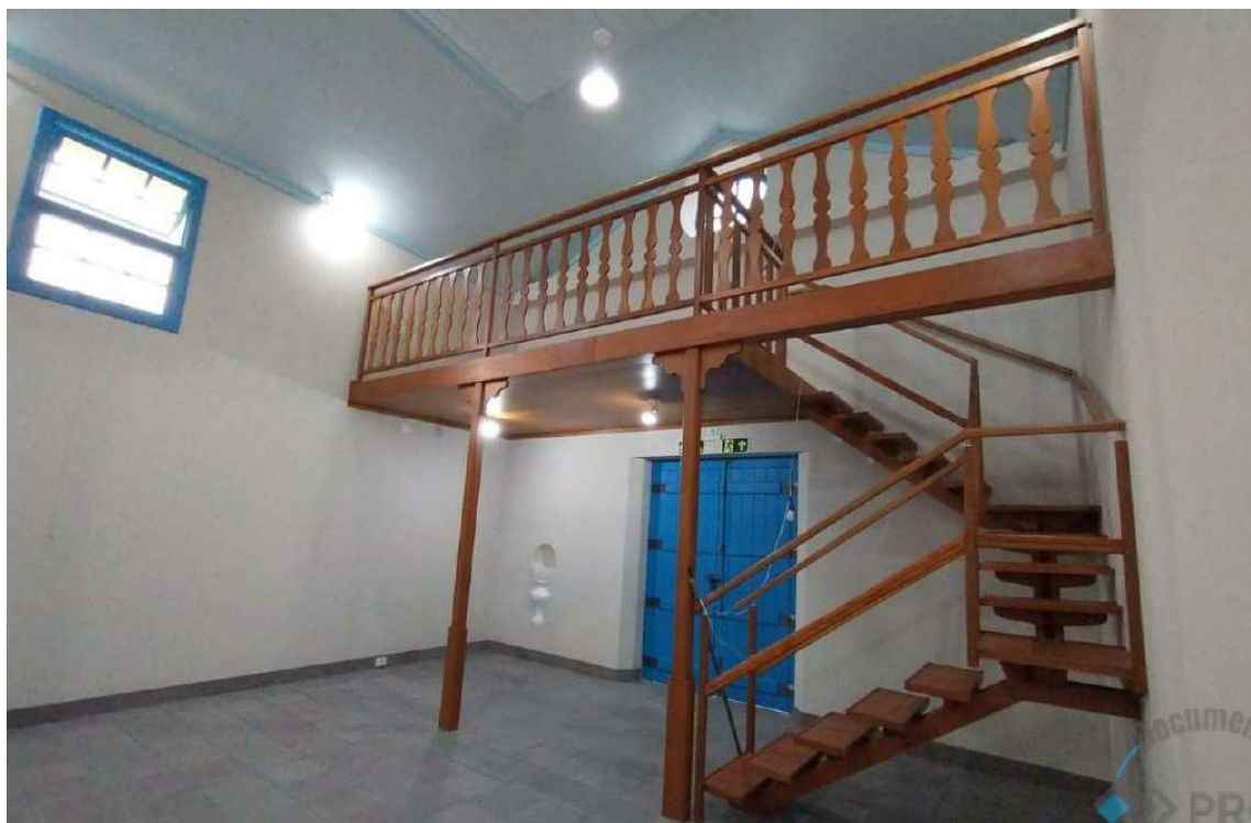
Foto 23 – Coro e escada acesso finalizados.
