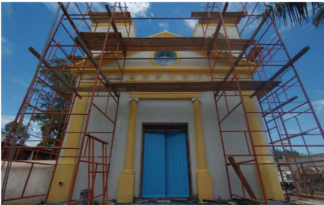
Foto 2 – Pintura da fachada principal.
