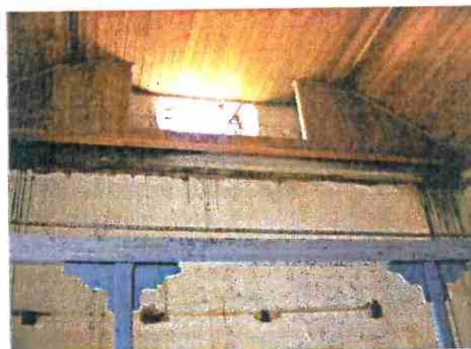
Figura 44 – marcas de uma antiga estrutura interna. Foto: LEPAN - 2007
