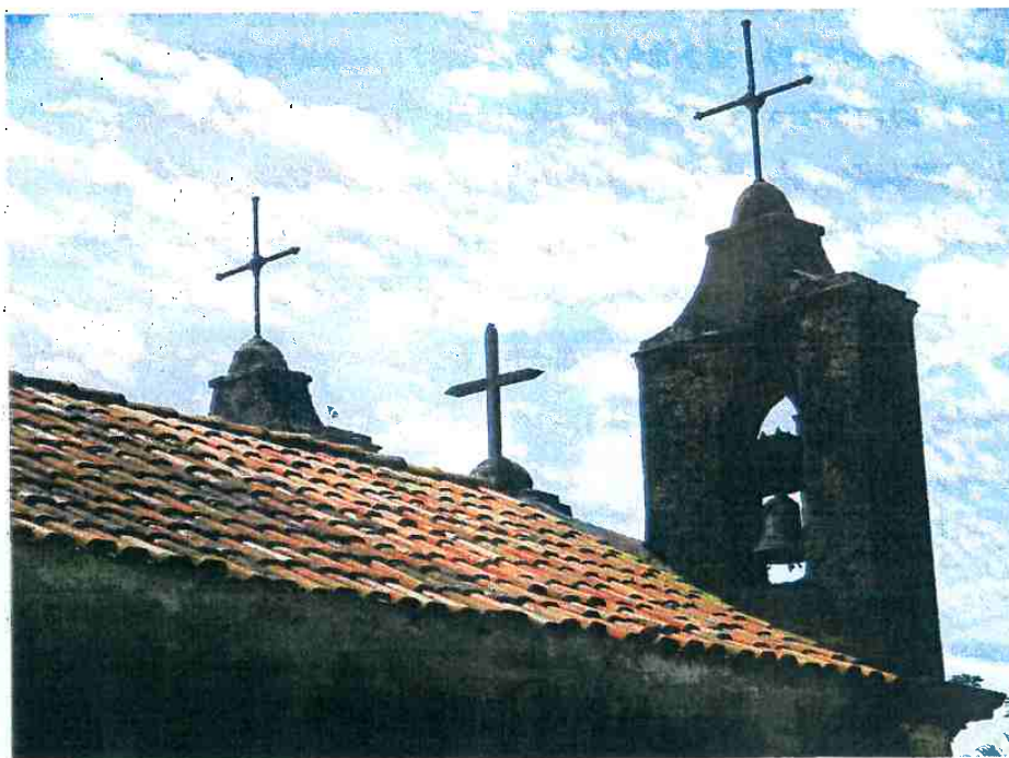
Figura 130 – A cimalha da fachada que avança para a lateral, parece ser coerente com um telhado que possua a suavização da inclinação próxima ao beiral conhecida como galbo. Foto: Rita Gnutzmann Veiga, 2009.
