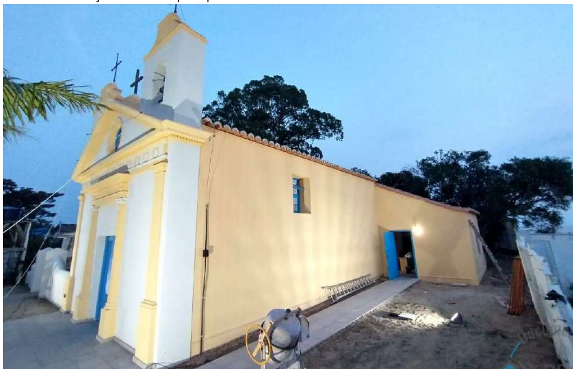
Foto 59 – Iluminação da fachada principal e lado da lagoa.
