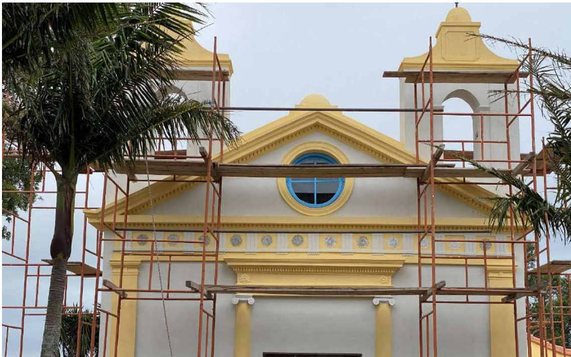
Foto 1 – Pintura da fachada principal.
