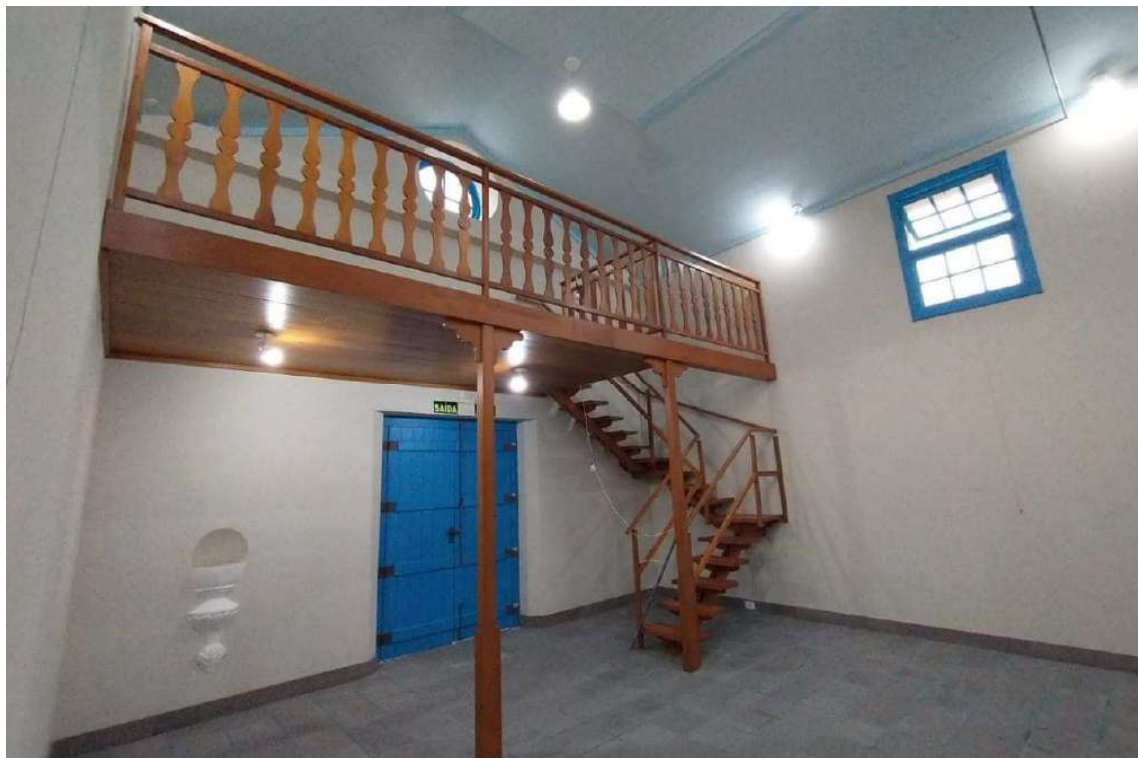
Foto 22 – Coro e escada acesso finalizados.
