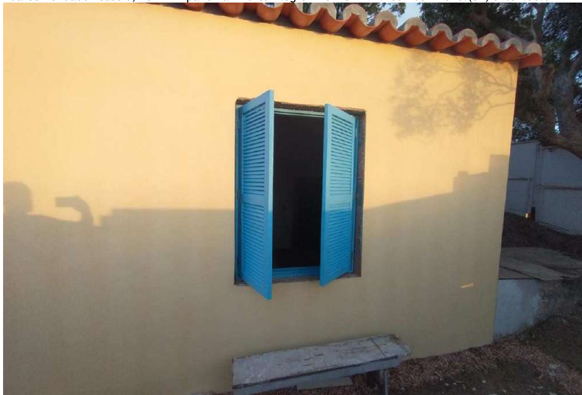
Foto 45 – Janela Sacristia, vista externa.
