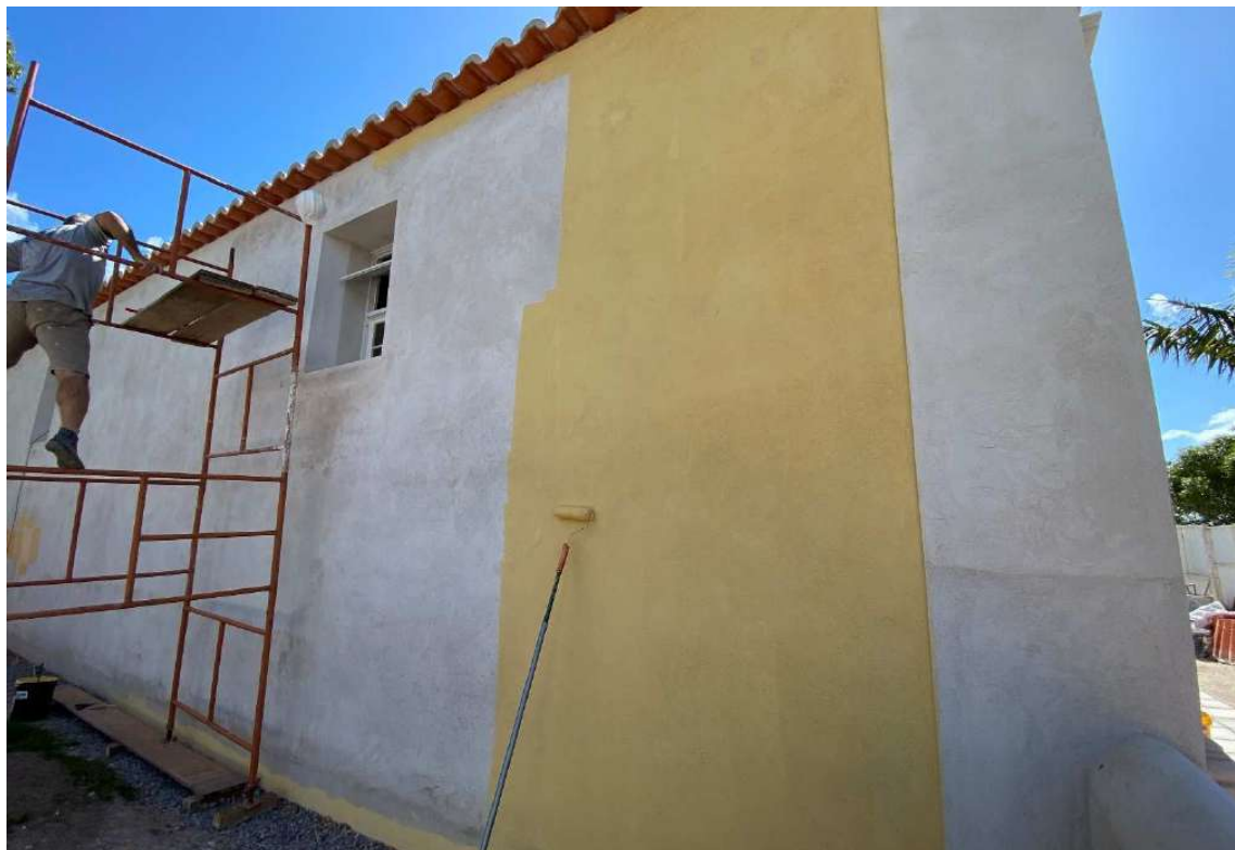
Foto 5 – Pintura das paredes externas com tinta silicato transpirável.
