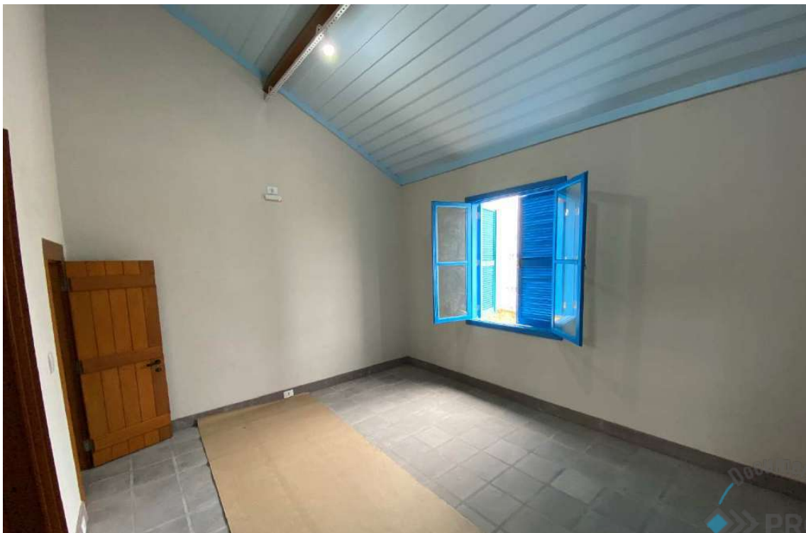
Foto 41 – Pintura das paredes internas e forro da sacristia finalizados.
