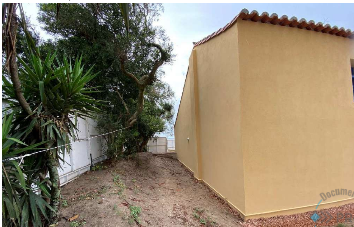
Foto 7 – Pintura das paredes externas finalizada.
