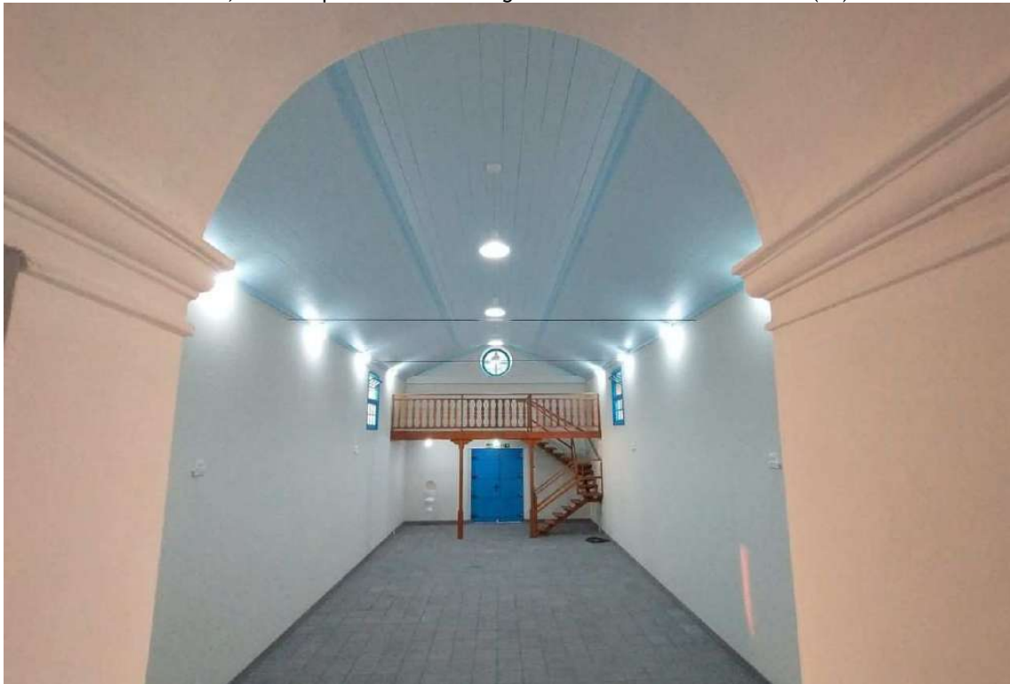
Foto 40 – Pintura do forro e paredes internas nave principal finalizados.
