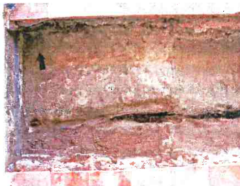
Figura 72 – quadrícula TB1: viga de madeira.
