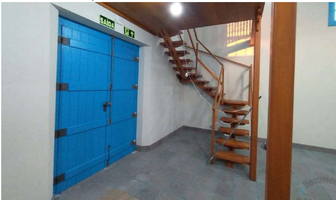
Foto 19 – Porta entrada principal, vista interna.
