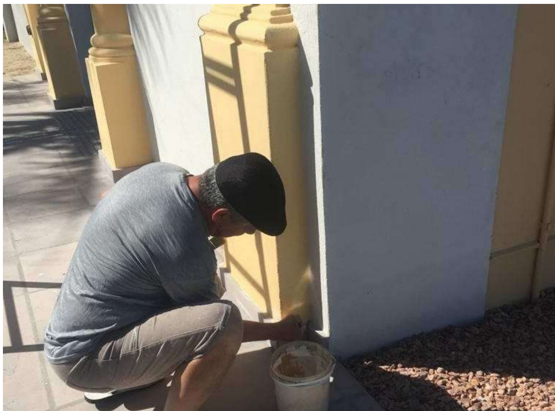
Foto 4 – Pintando trecho reintegrado.
