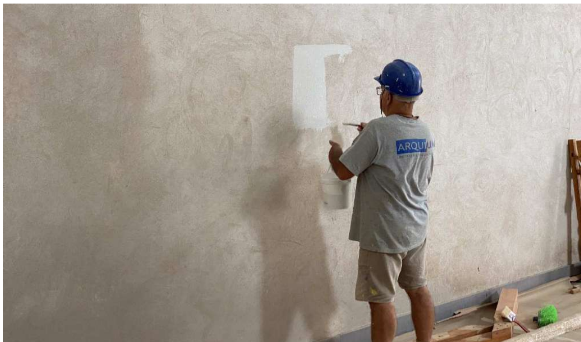
Foto 73 – Teste de cores paredes internas.
