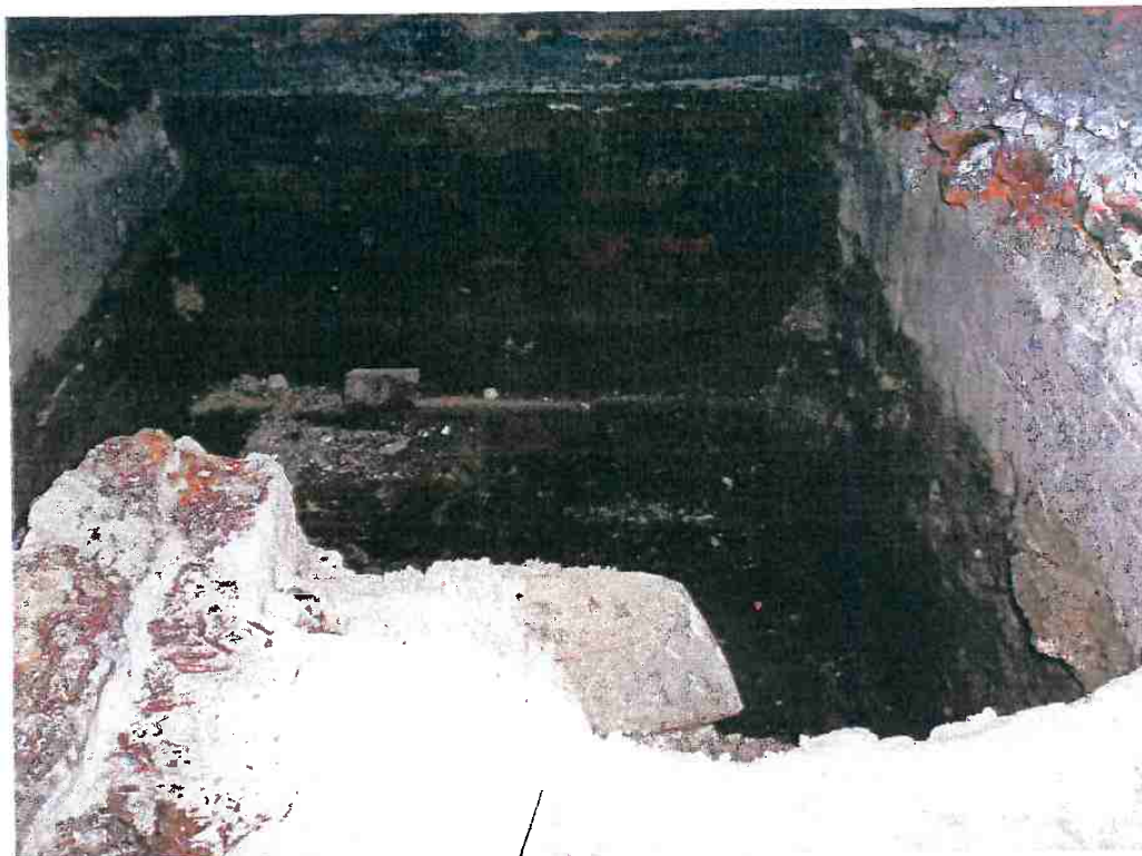
Figura 120 – fundações expostas pela escavação no interior da capela em bom estado de conservação. Foto: SUPETEC
