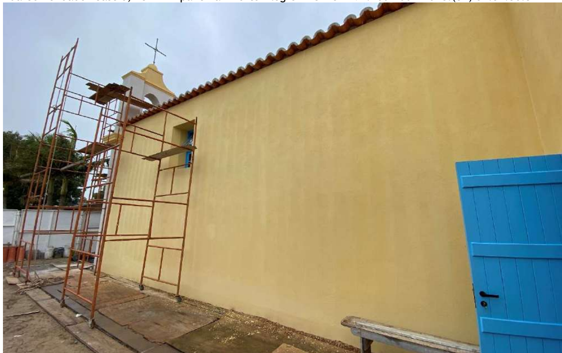
Foto 11 – Pintura das paredes externas com tinta silicato transpirável
