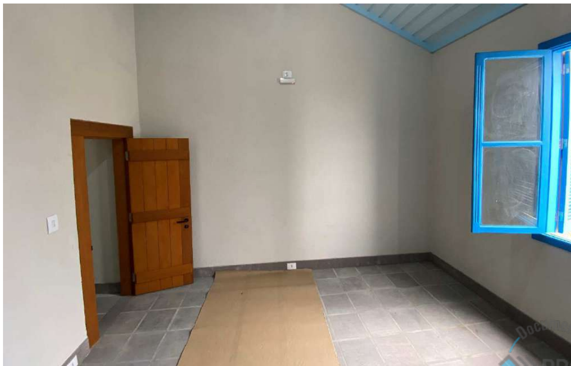
Foto 49 – Iluminação de emergência na sacristia.
