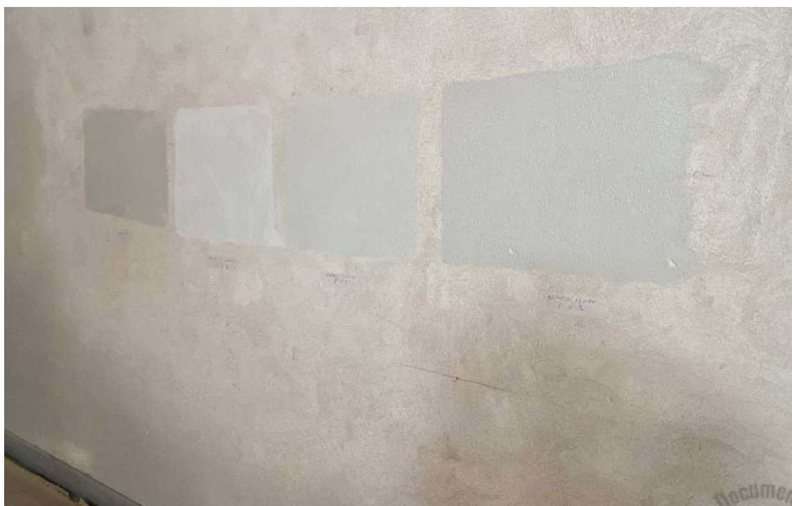
Foto 74– Teste de cores paredes internas.
