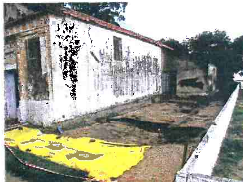
Figura 83 – janela da parede leste vista por fora.
