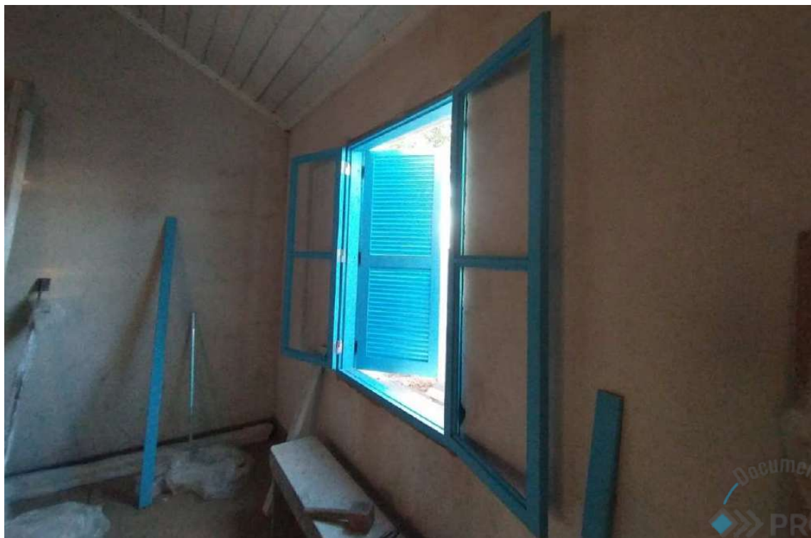
Foto 46 – Janela sacristia, vista interna.
