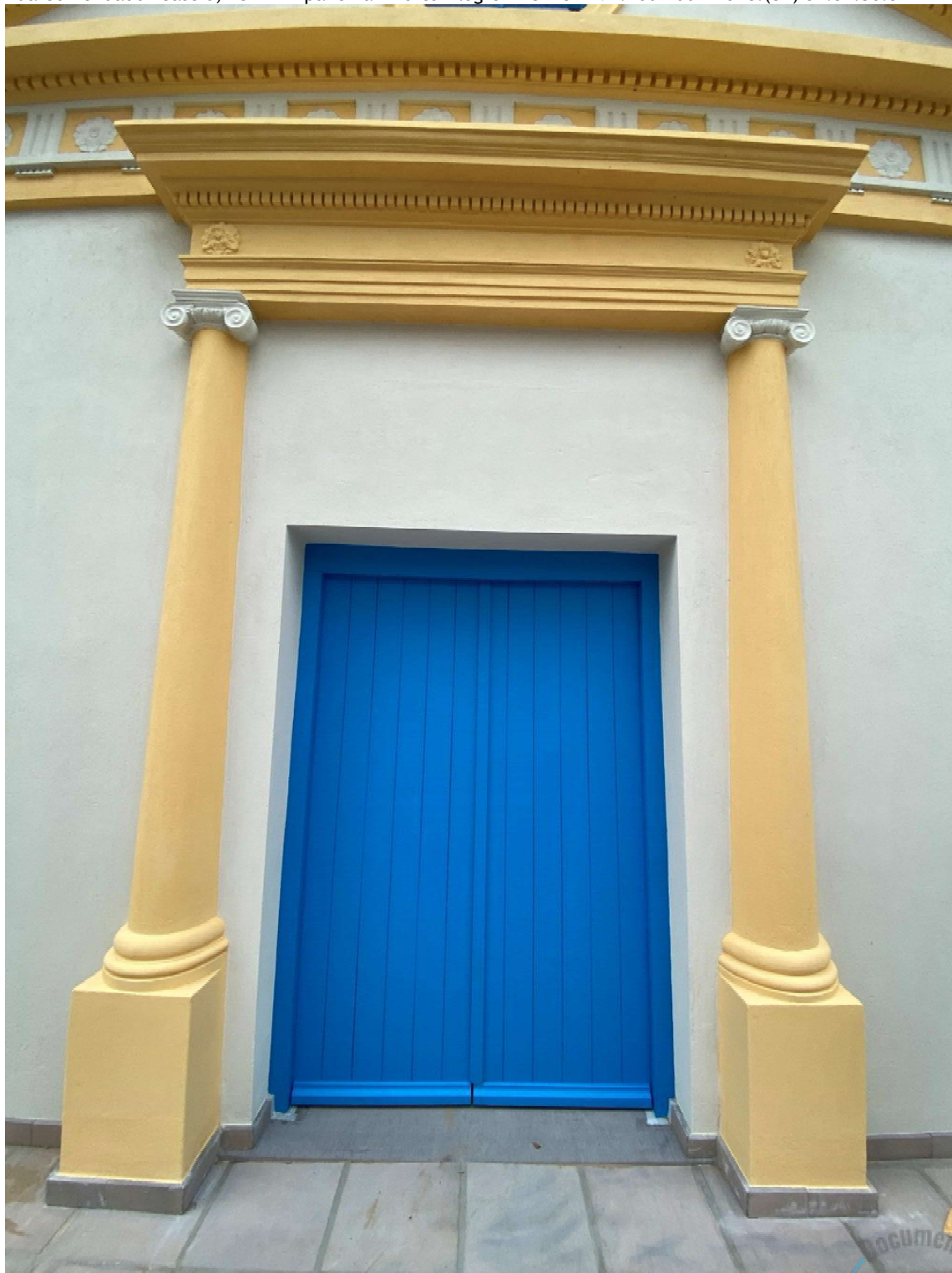
Foto 3 – Pintura finalizada, detalhe porta entrada nave principal.
