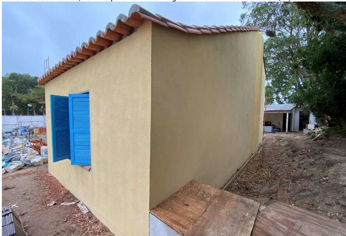
Foto 9 – Pintura das paredes externas com tinta silicato transpirável
