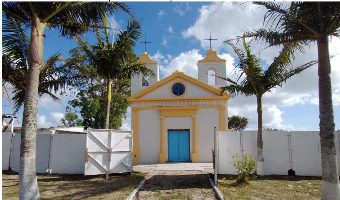
Foto 3 – Pintura fachada principal
