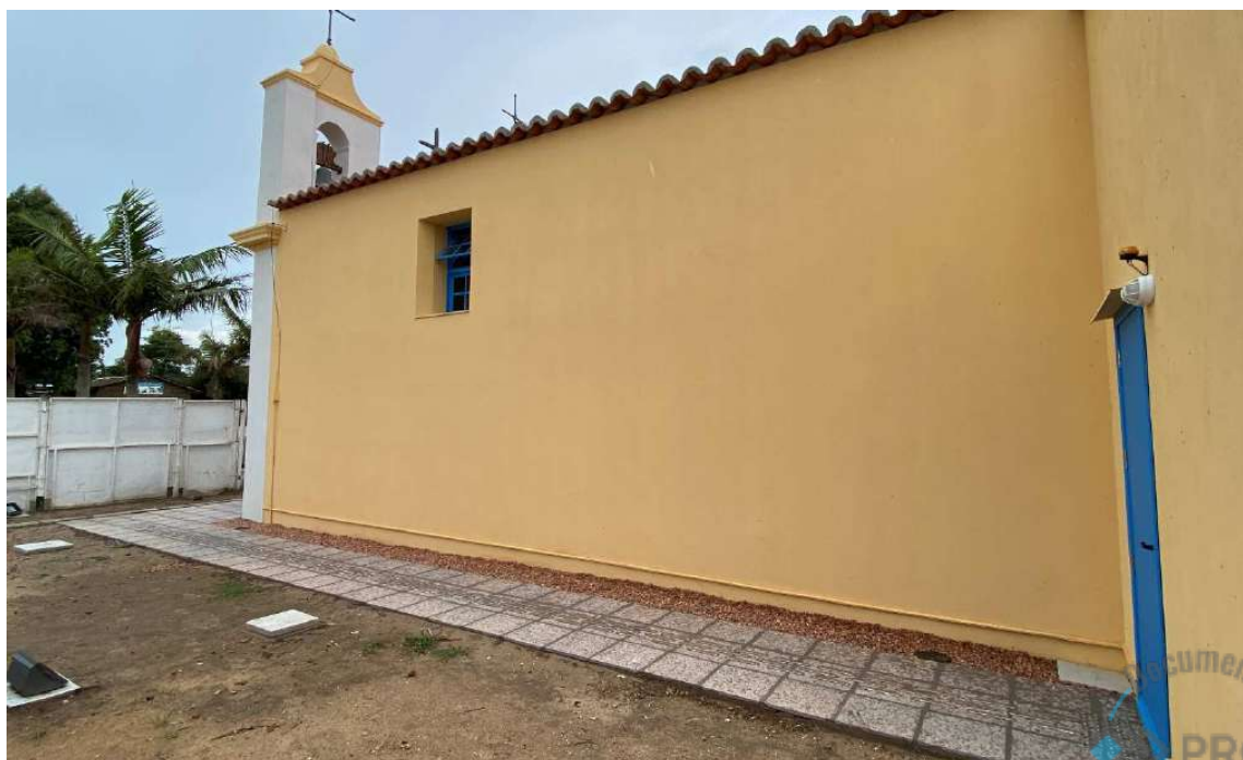
Foto 5 – Pintura das paredes externas finalizada.
