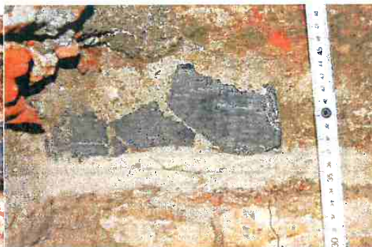
Figura 79 – vestígios de rebocos antigos na quadrícula TB6 (parede leste da capela).
