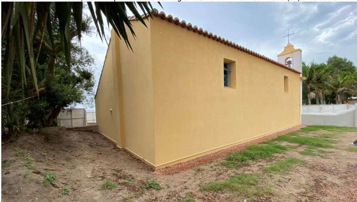
Foto 8 – Pintura das paredes externas finalizada.
