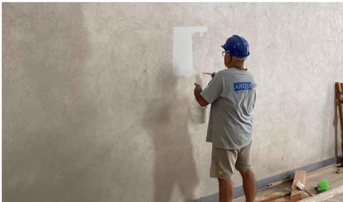
Foto 73 – Teste de cores paredes internas.
