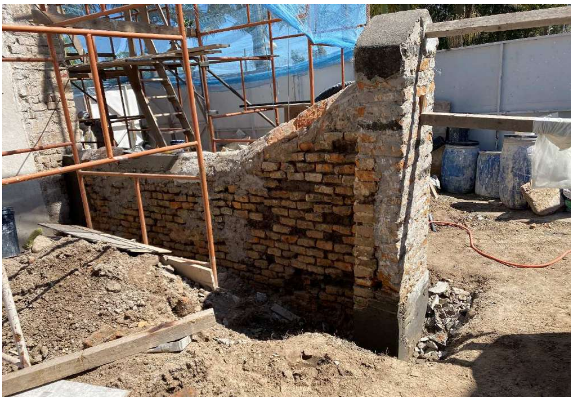
Foto 102 – Sapata de reforço concretada.
