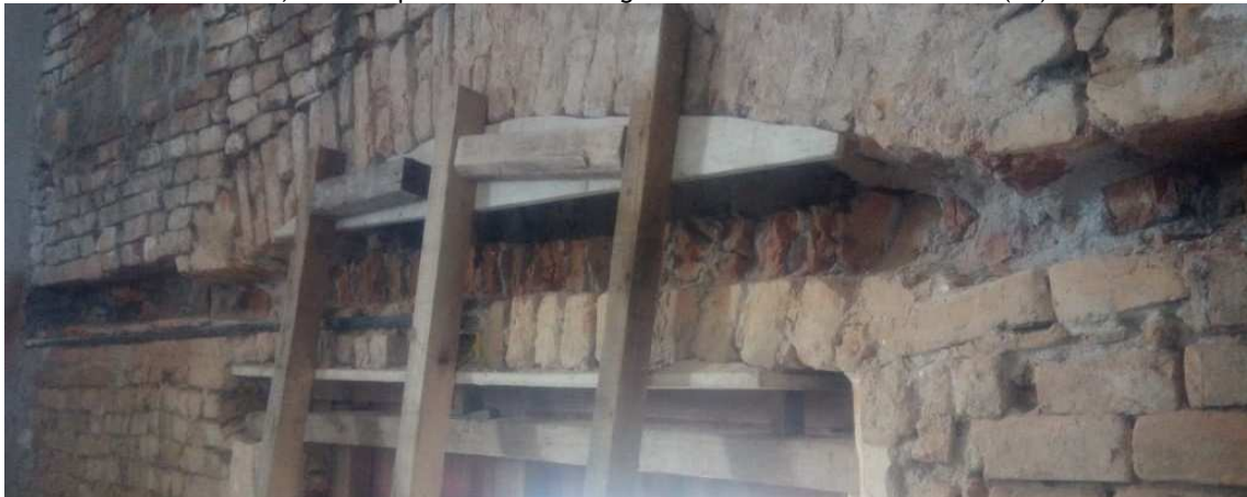
Foto 24 – Reforço do arco da verga com peças metálicas e grauteamento.
