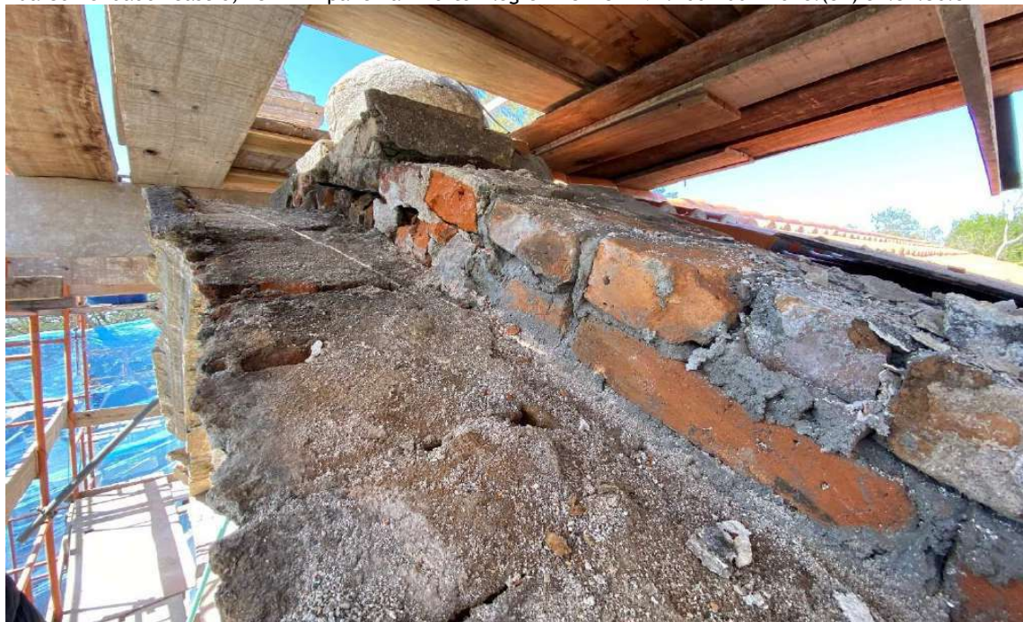
Foto 67 – Reconstituições de alvenarias junto a cimalha superior.
