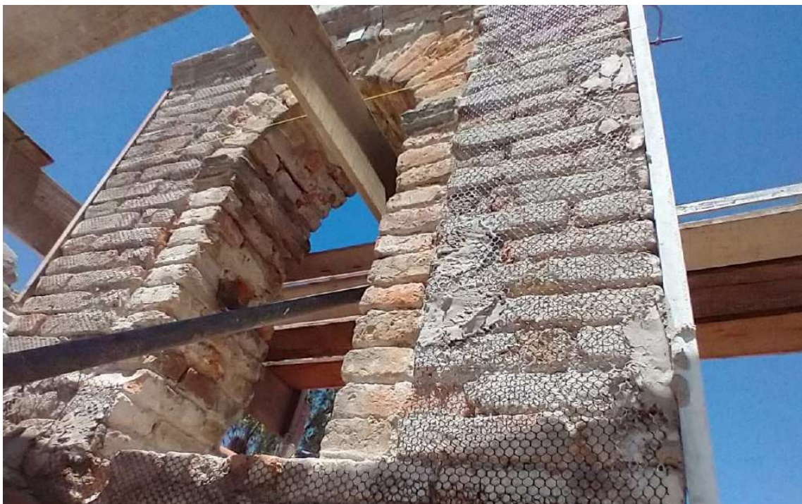
Foto 2 – Revestimentos antigos removidos, juntas rebaixadas, tela estuque plástica.
