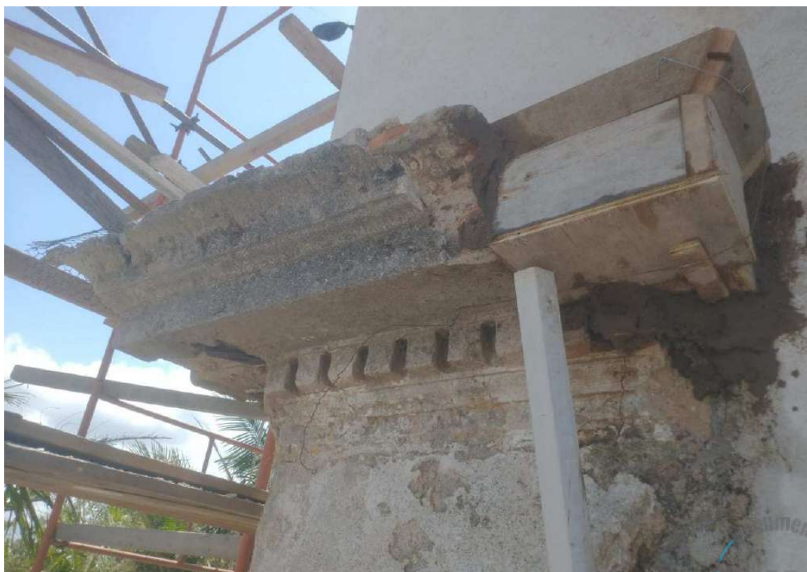
Foto 8 – Reconstrução das molduras nos cantos superiores das pilastras laterais.
