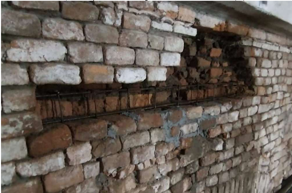
Foto 14 – Demolição parcial da alvenaria e colocação de armadura de aço..
