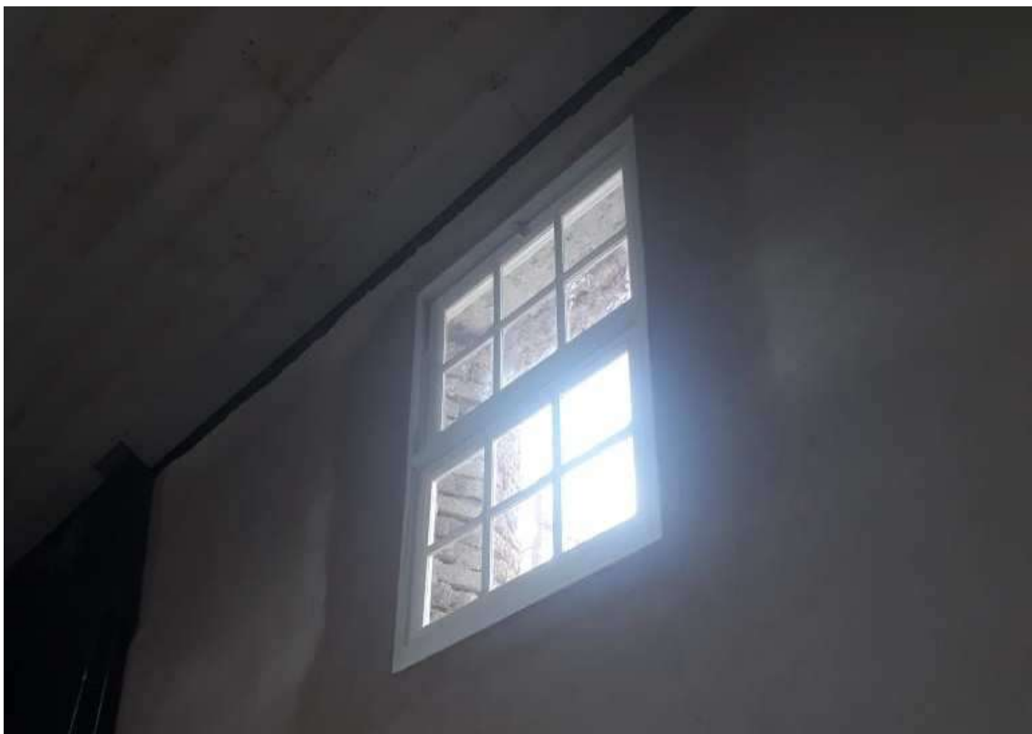
Foto 64 – Janela nave principal instalada.
