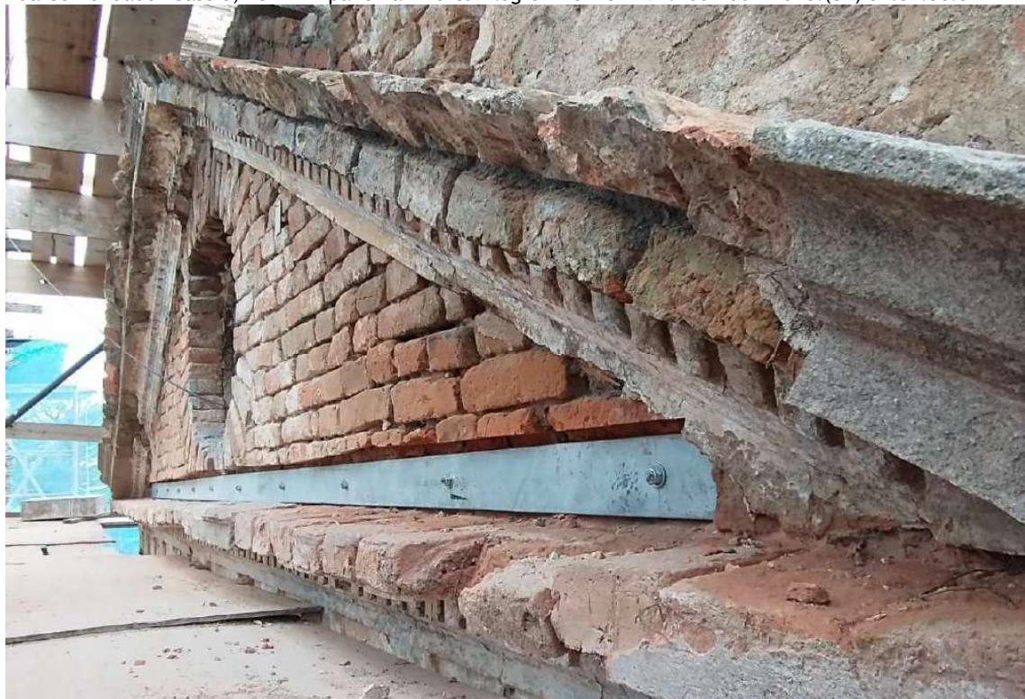
Foto 18 – Chapa metálica de reforço instalada e fixada na cinta interna com barras roscadas.
