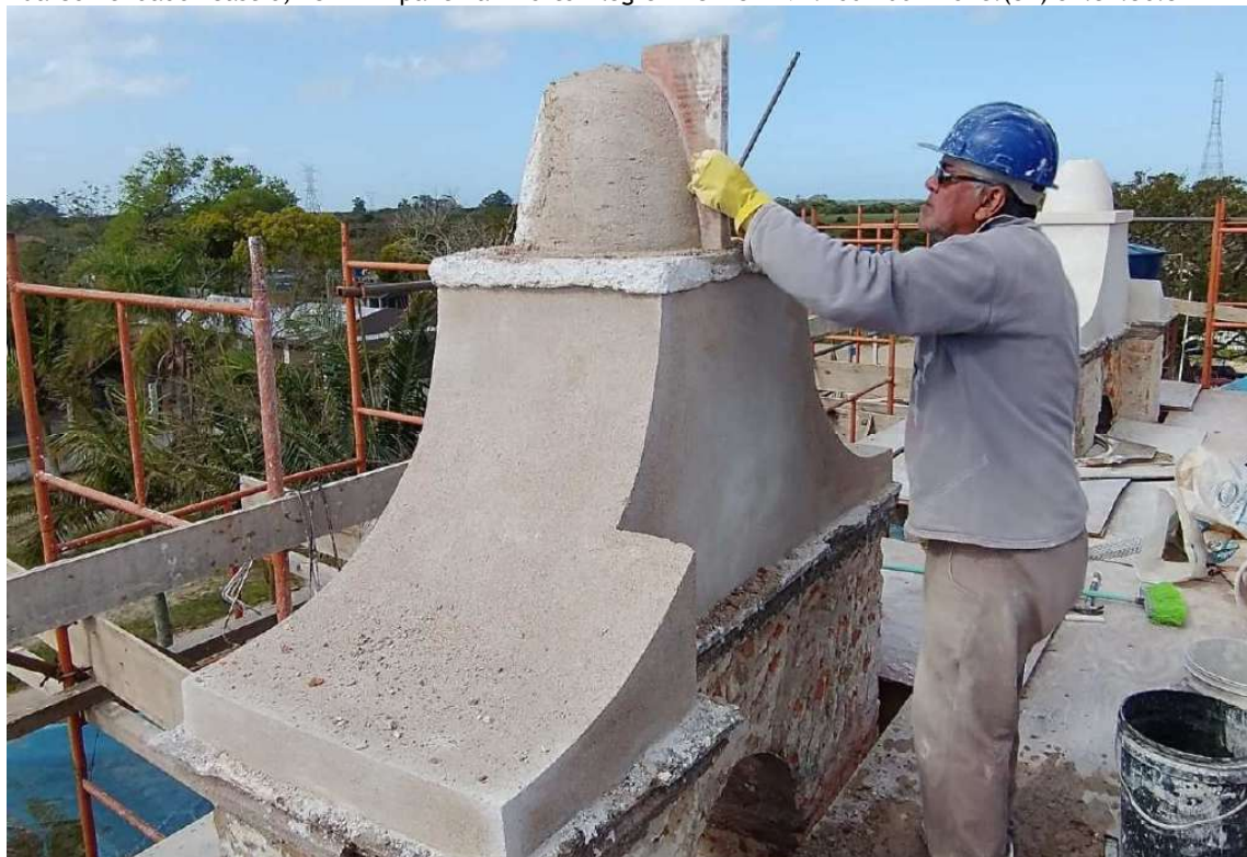
Foto 75 – Execução revestimentos em argamassa de cal e areia 1:3.
