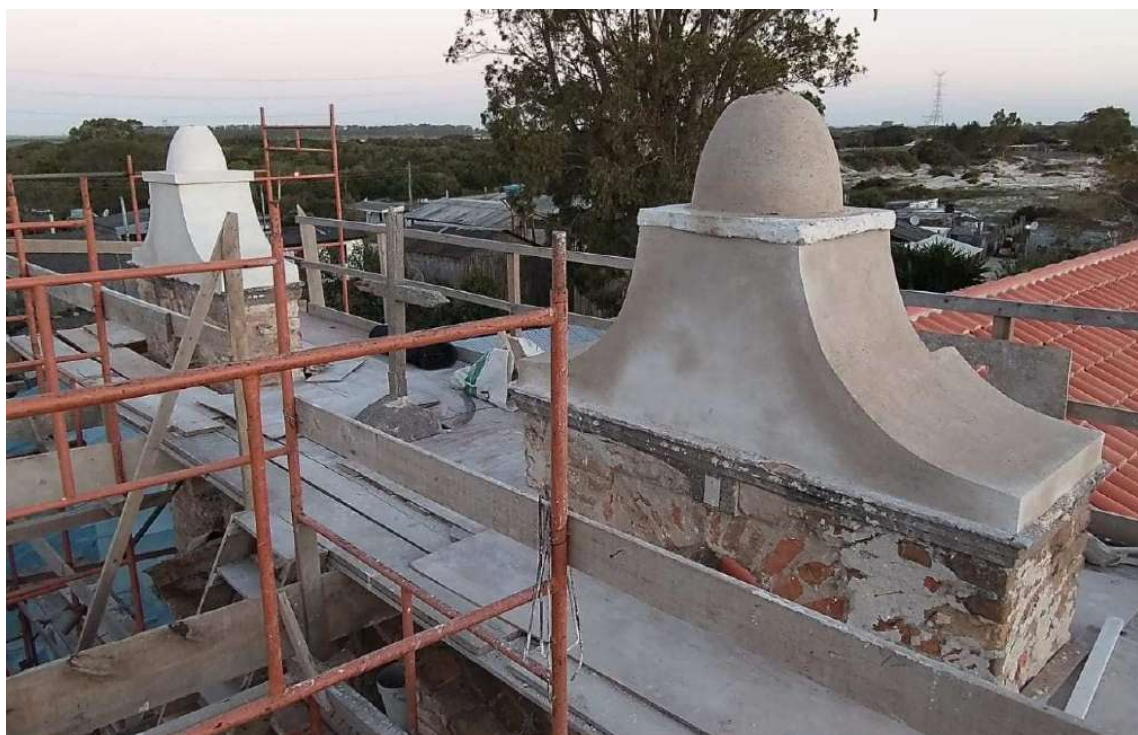
Foto 76 – Execução revestimentos em argamassa d cal e areia 1:3
