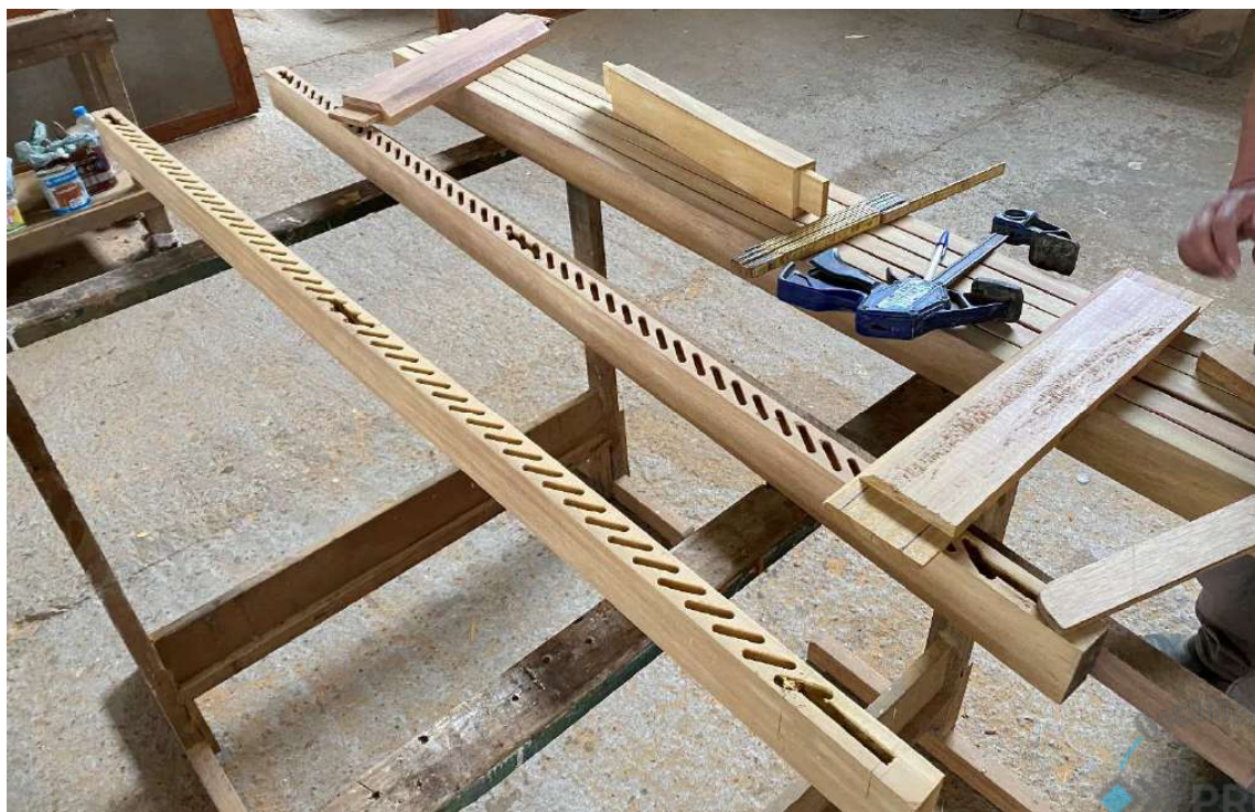
Foto 64 – Executando as venezianas da janela da sacristia.
