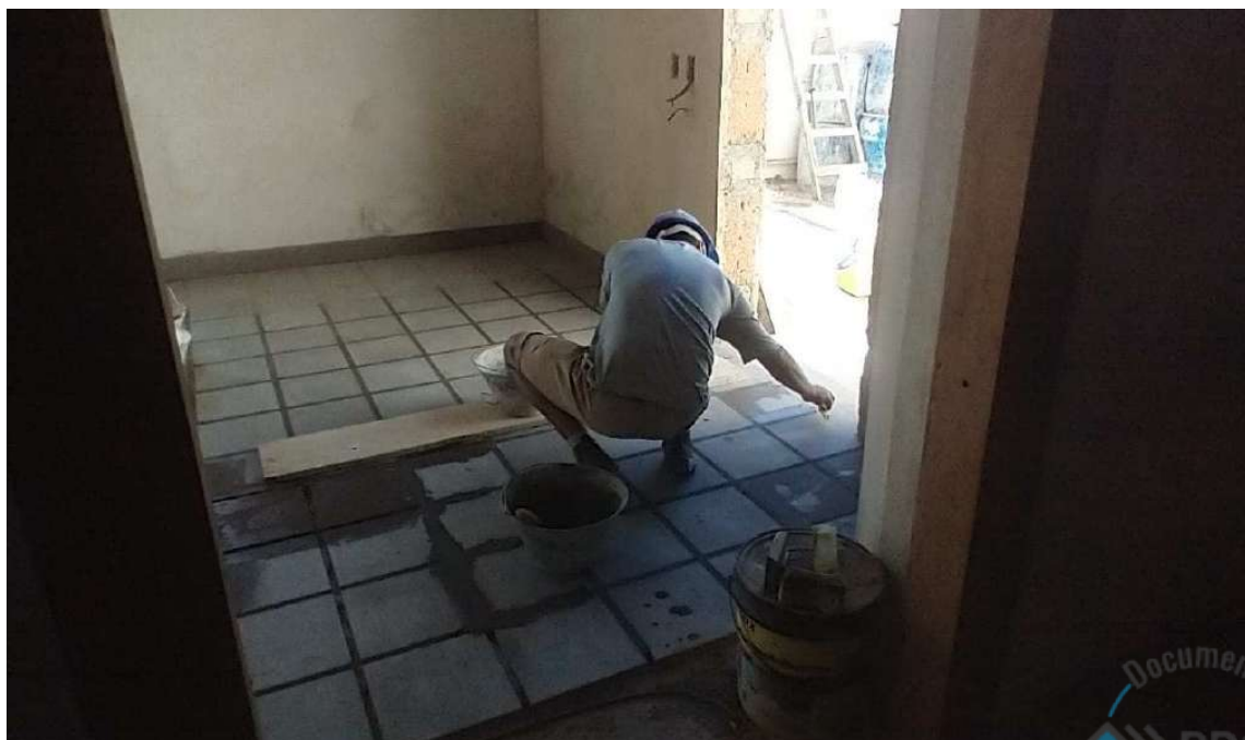
Foto 56 – Colocação de piso definitivo e rodapés - basalto fosco tear. Rejunte com cimento e areia - Sacristia.
