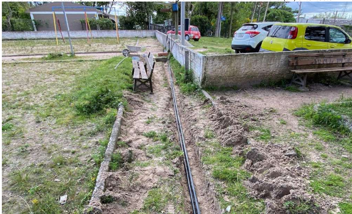
Foto 43 – Caixas de passagem e eletrodutos rede alimentação.
