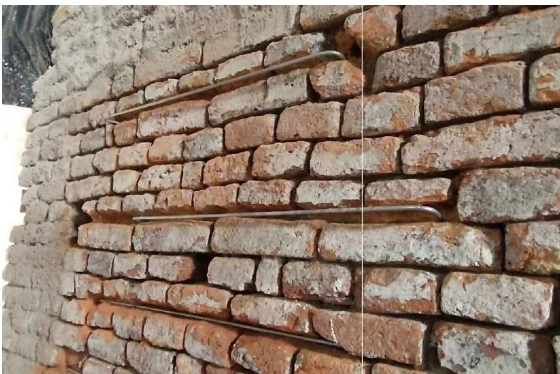
Foto 4 – Grampeamento trechos rachados com barras aço inox.
