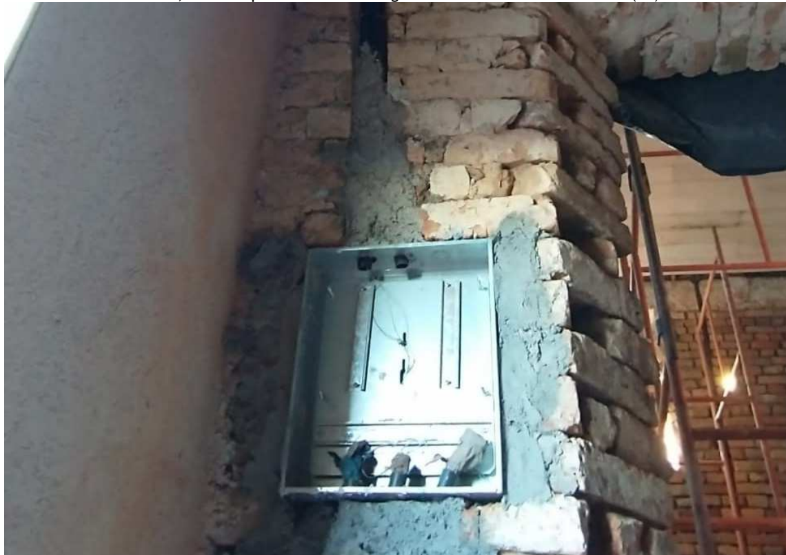
Foto 45 – Instalação do Centro de distribuição.
