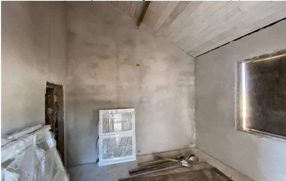
Foto 61 – Execução reboco paredes internas sacristia.
