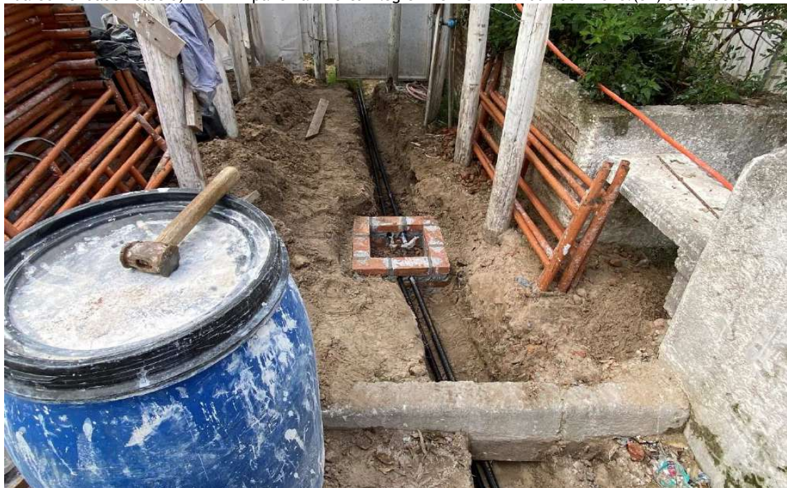
Foto 45 – Caixas de passagem e eletrodutos rede alimentação.
