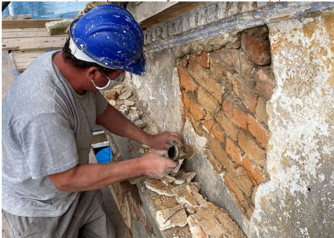
Foto 90 – Remoção revestimentos soltos da fachada principal.
