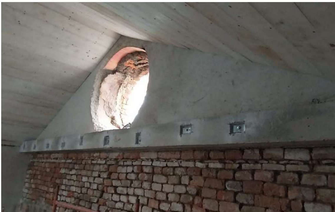
Foto 20 – Fixação da chapa metálica externa de reforço na cinta interna com barras roscadas.
