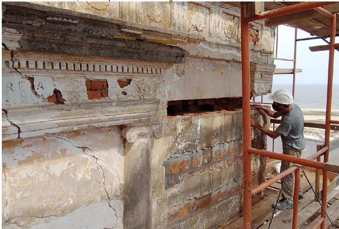
Foto 4 – Reforços no canto entre a parede fachada principal e parede oeste, amarração.
