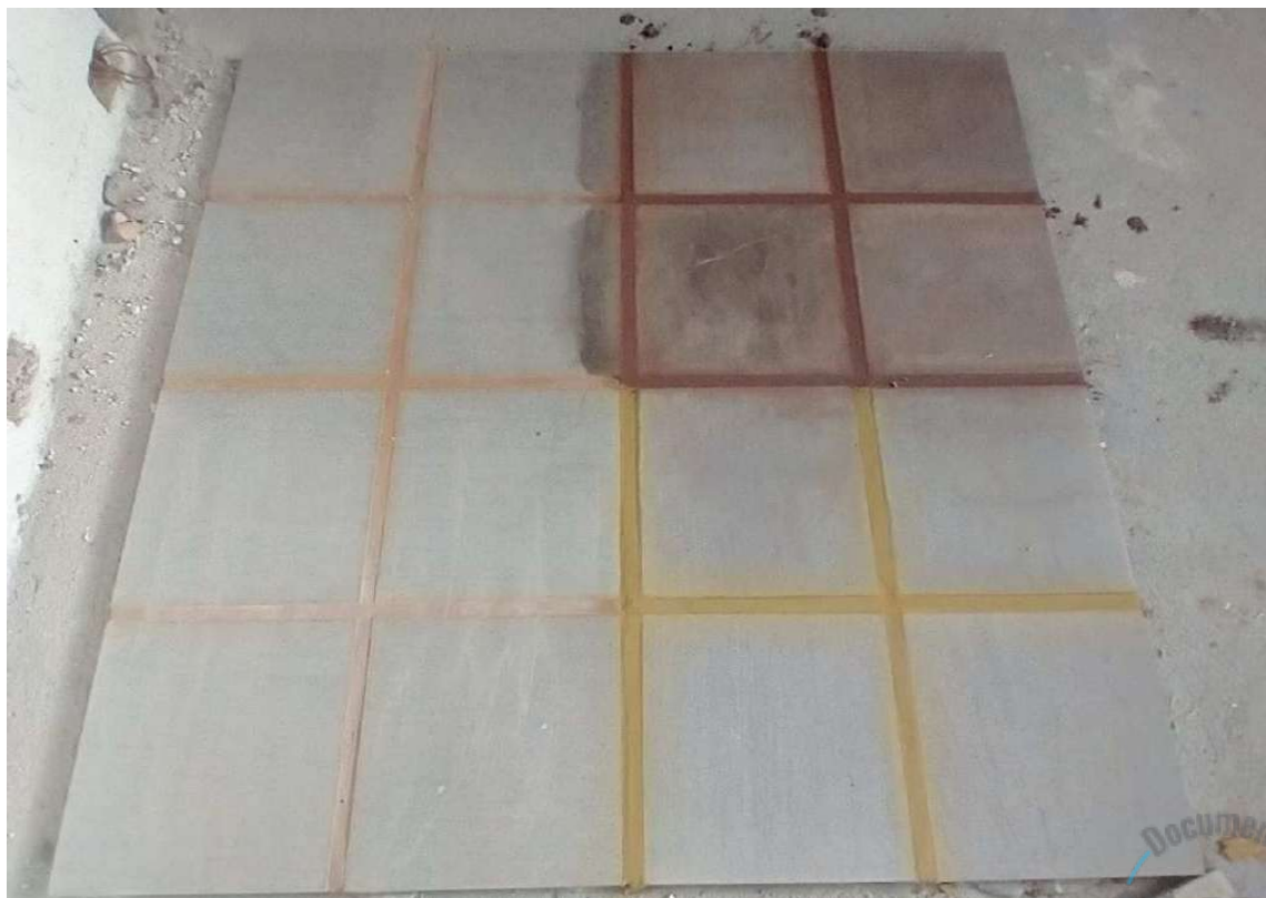
Foto 60 – Teste de cores rejunte piso basalto fosco tear.
