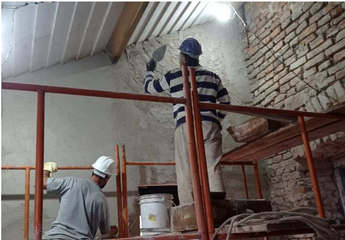
Foto 44 – Revestimento interno parede norte sacristia, argamassa de cal e areia 1:3.
