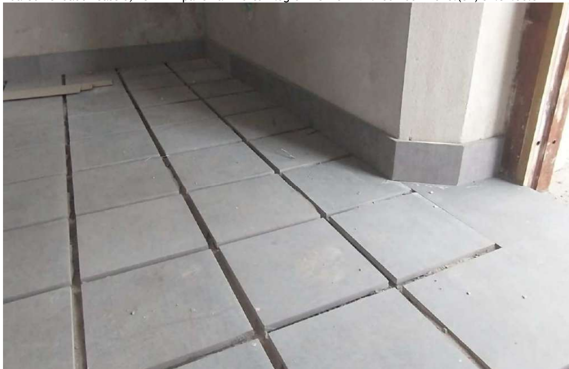
Foto 51 – Colocação de piso definitivo e rodapés - basalto fosco tear. Nave principal.
