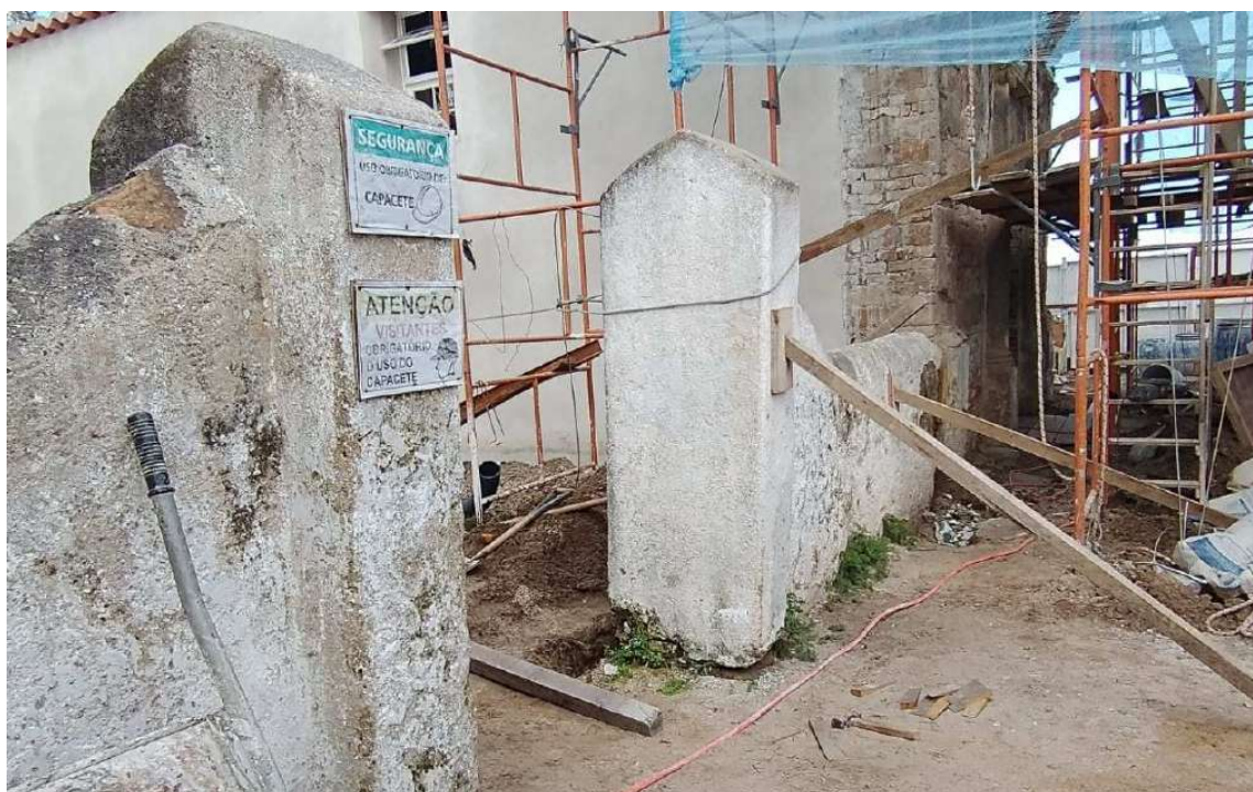
Foto 98 –Execução escoramento para o aprumo do muro.
