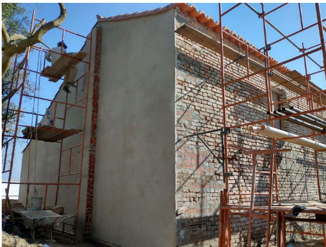
Foto 25 – Vista parede sul, sendo feito revestimento sobre o pilar de alvenaria.
