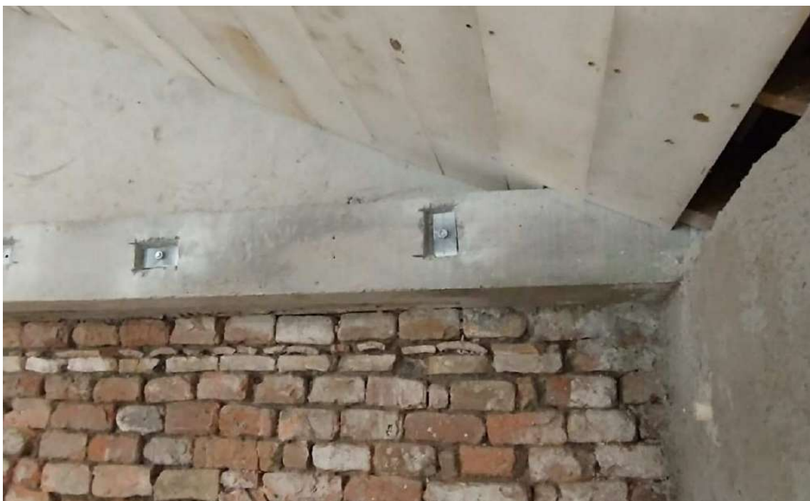
Foto 23 – Detalhe fixação da chapa metálica externa de reforço na cinta interna com barras roscadas.
