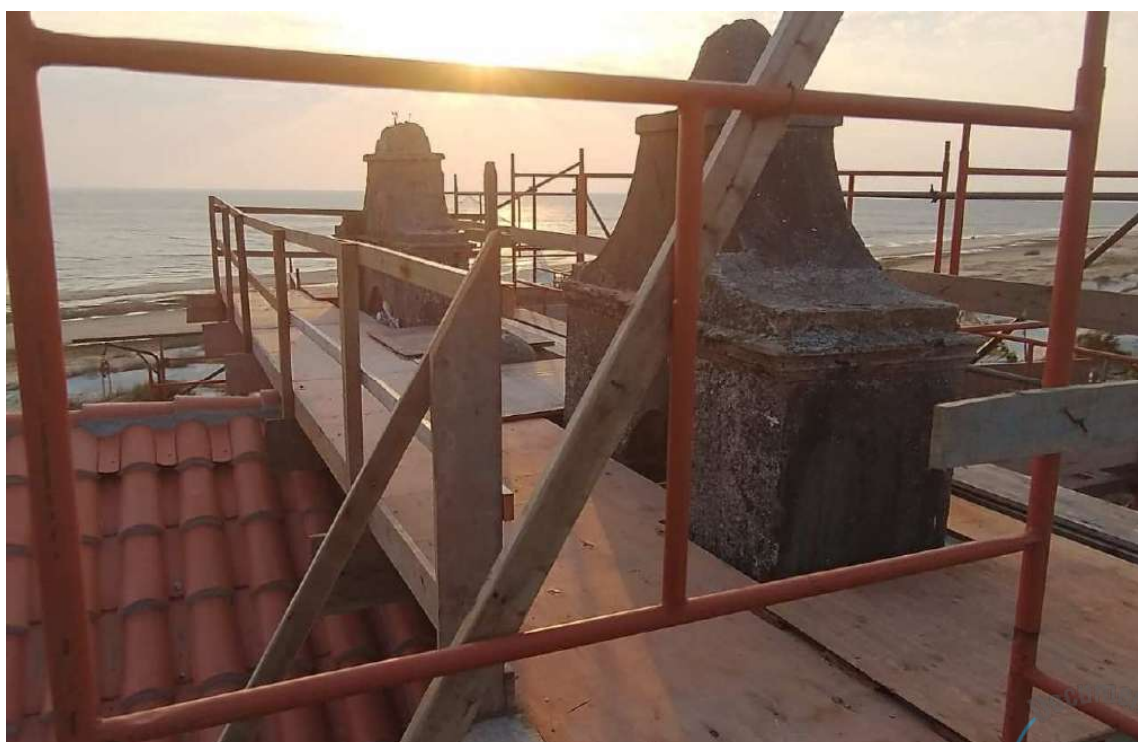
Foto 73 – Estrutura acesso as torres.
