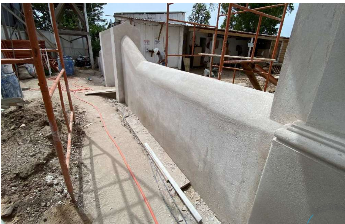
Foto 46 – Revestimento em cal e areia 1:3.
