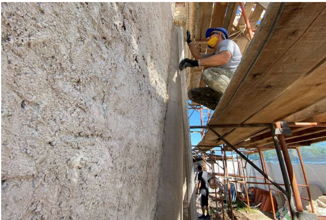
Foto 40 – Revestindo as colunas com argamassa de cal e areia 1:3.
