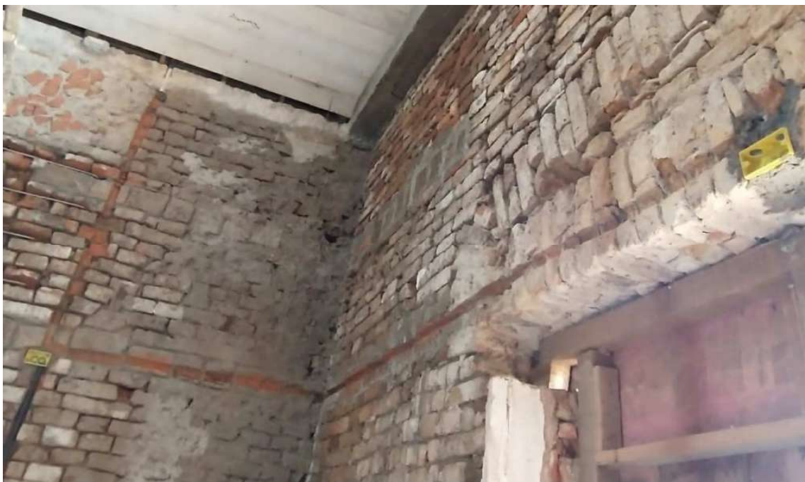
Foto 43 – Rasgos, tubulações e caixas.
