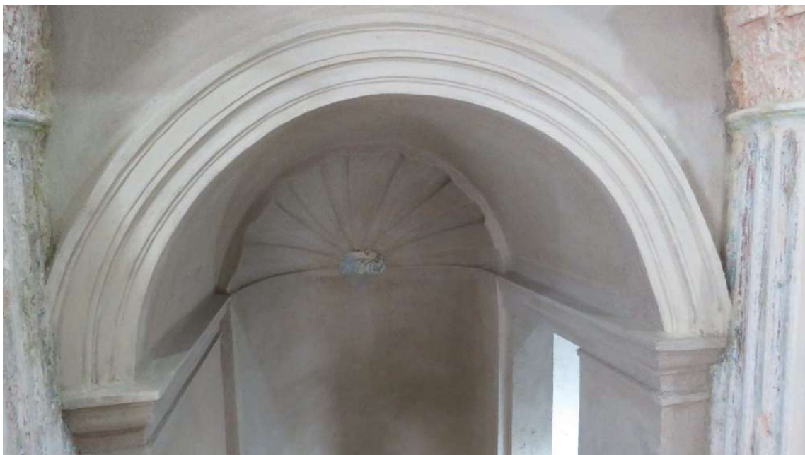
Foto 83 – Restauro de frisos, molduras e ornamentos altar mor.
