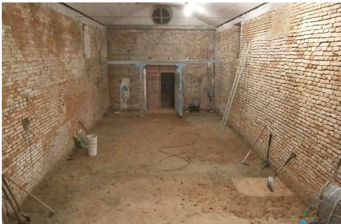
Foto 58 – Nivelando base para executar contrapiso na nave principal.
