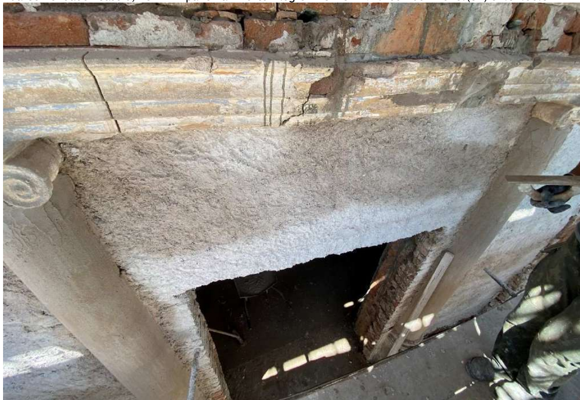
Foto 35 – Revestindo as colunas com argamassa de cal e areia 1:3.
