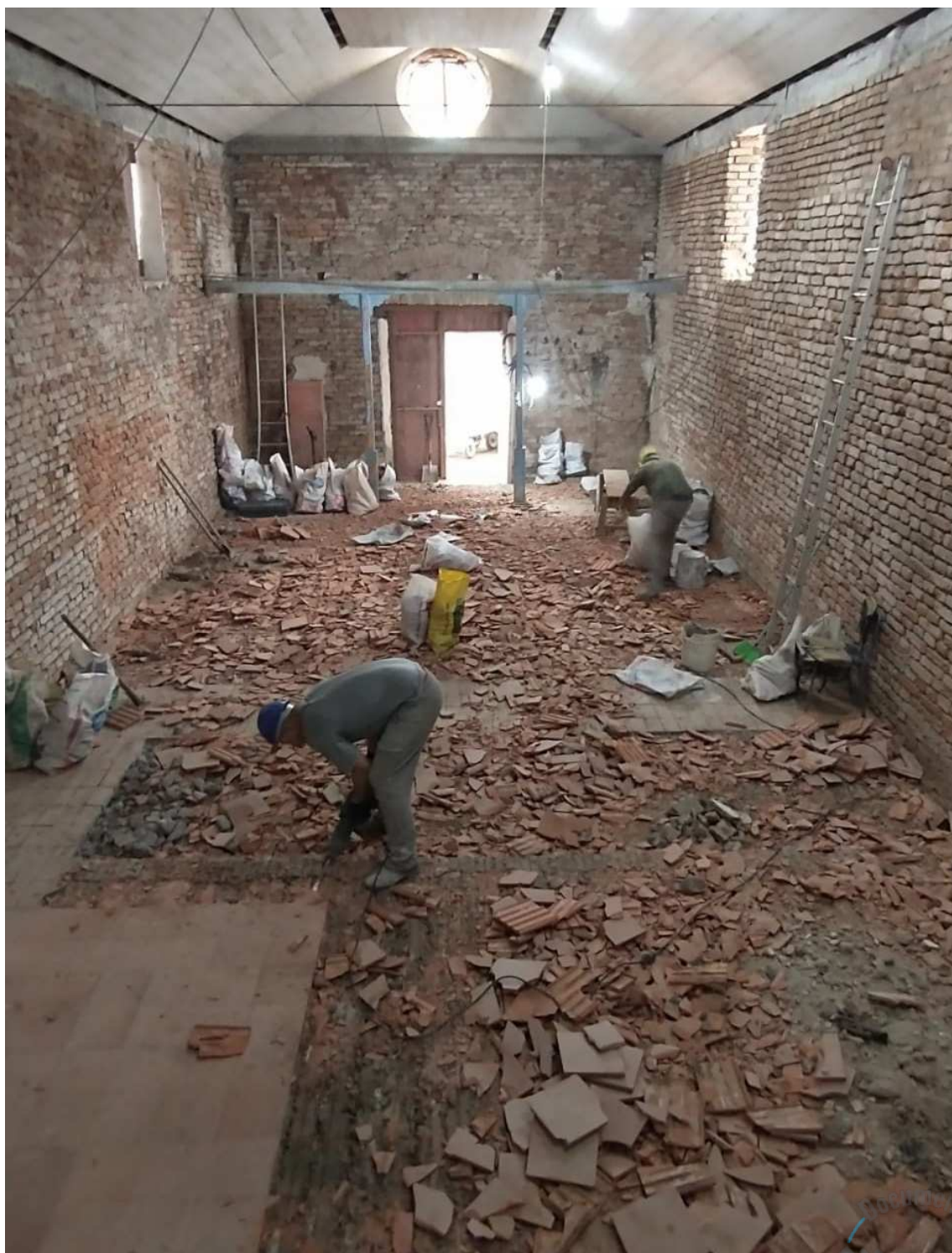
Foto 51 – Demolição piso e contrapiso existente para executar contrapiso na nave principal.
