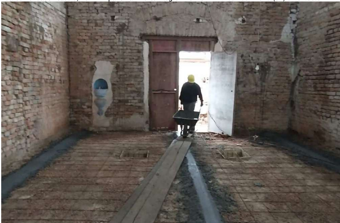
Foto 61 – Execução do contrapiso na nave principal.
