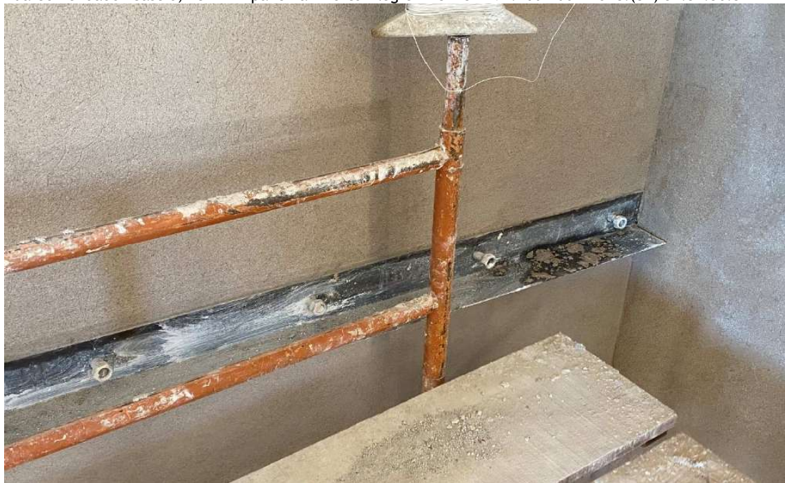
Foto 12 – Vista da cantoneira fixada na cinta e reboco concluído.
