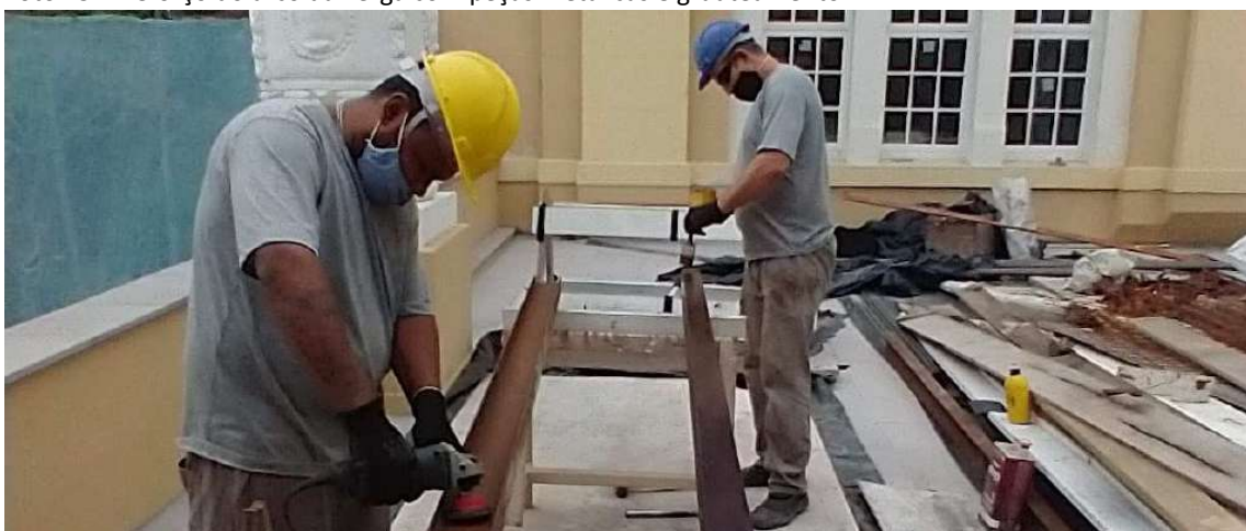
Foto 26 – Lixação e preparação de vigas metálicas 4'' para colocar na verga reta da porta principal.
