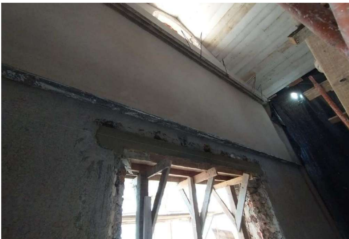
Foto 28 – Instalação de 3 perfis metálicos 4” na verga da porta principal e grauteamento.
