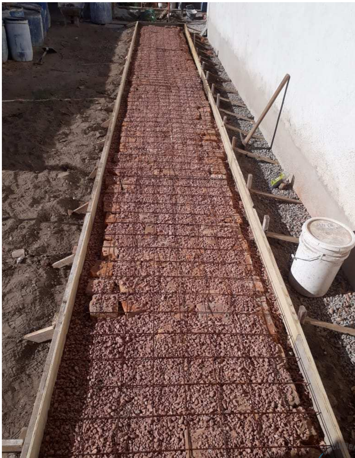
Foto 71 – Execução da rampa lateral acesso da sacristia.
