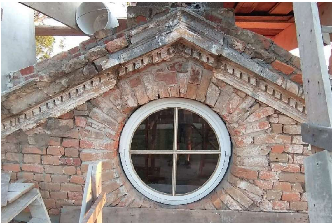
Foto 61 – Oculo fachada principal instalado.
