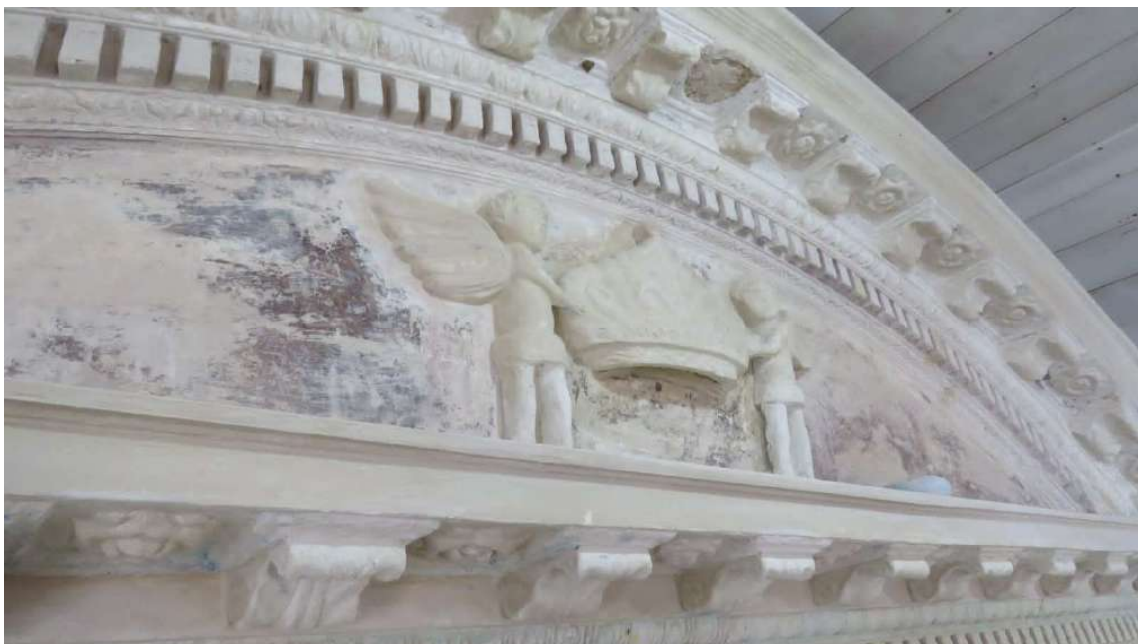
Foto 85 – Restauro dos ornamentos do altar mor.
