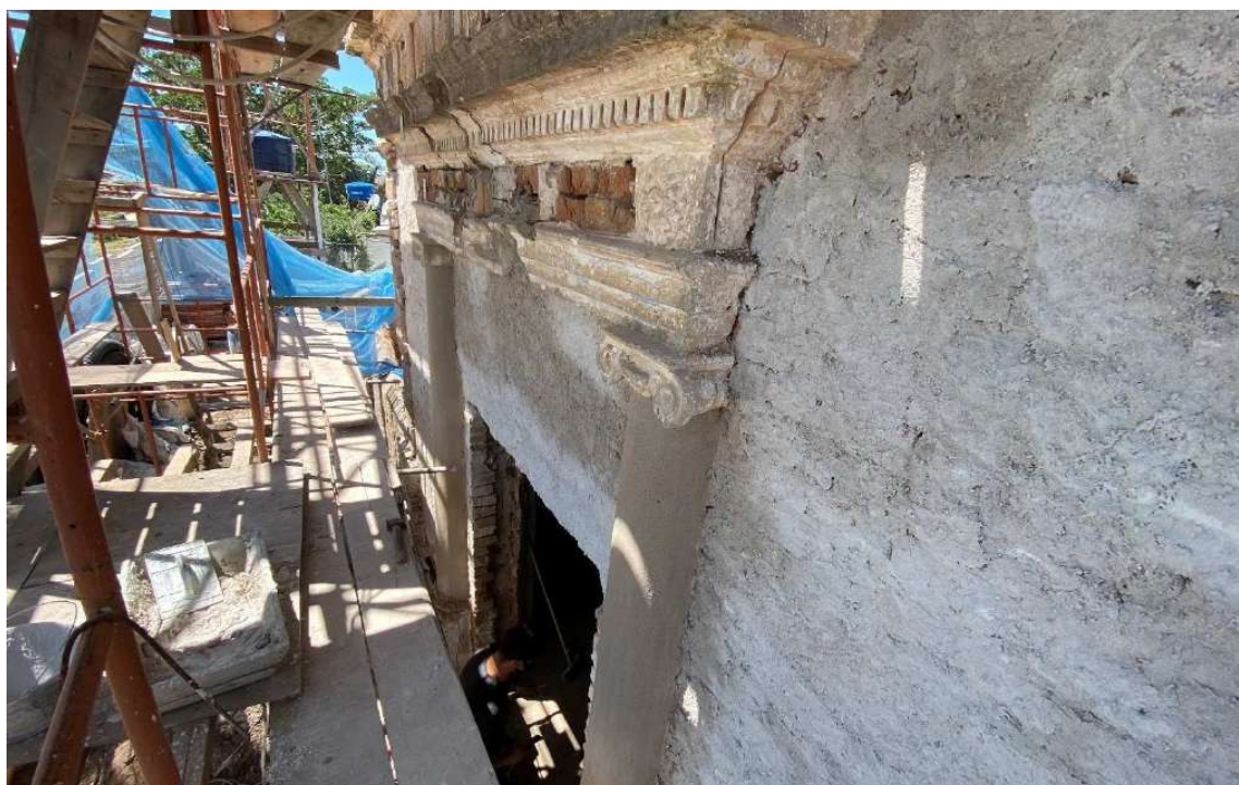
Foto 36 – Revestindo as colunas com argamassa de cal e areia 1:3.
