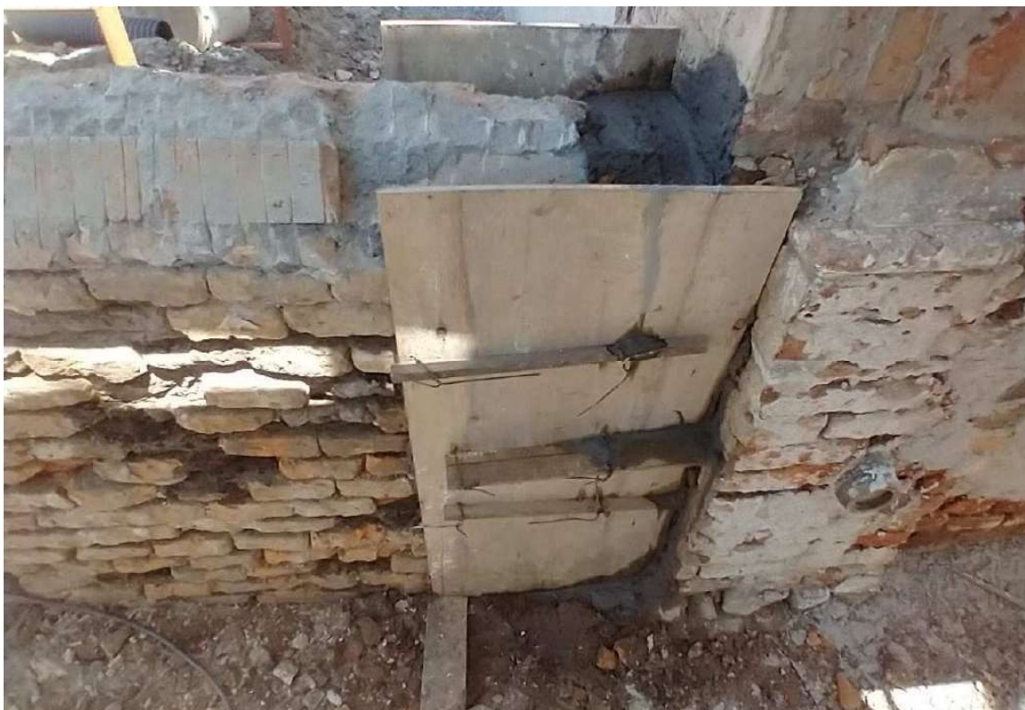
Foto 104 – Concretagem trecho demolido após o muro ser reaprumado.
