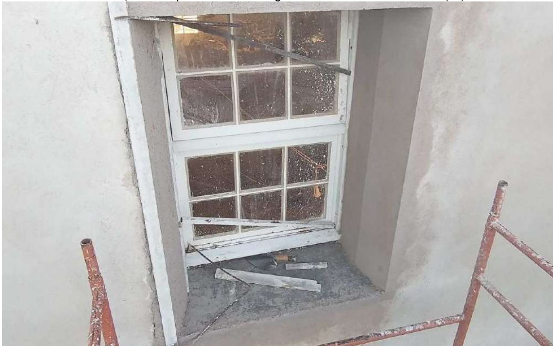
Foto 63 – Arremate janela lateral instalada.
