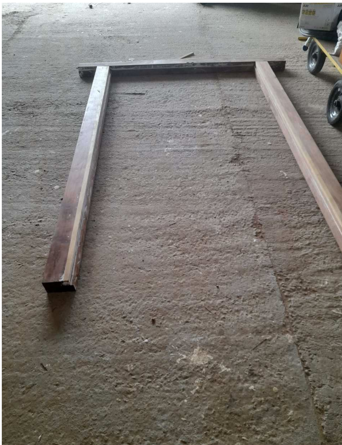
Foto 66 – Marco porta antes da instalação. Marco porta principal.
