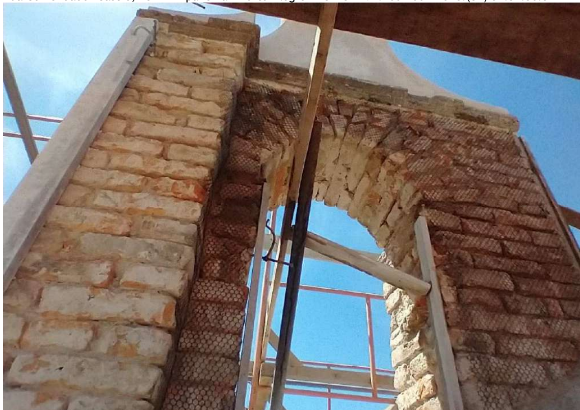
Foto 3 – Revestimentos antigos removidos, juntas rebaixadas, tela estuque plástica.
