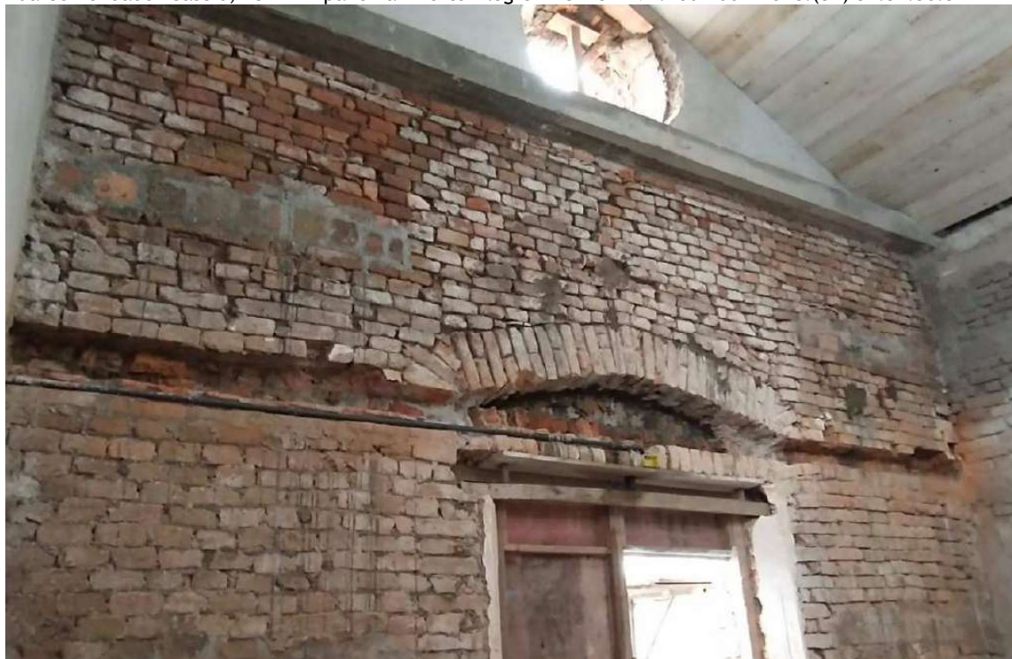
Foto 6 – Remoção tijolos para cinta concreto reforço parede e base para cantoneira metálica mezanino.
