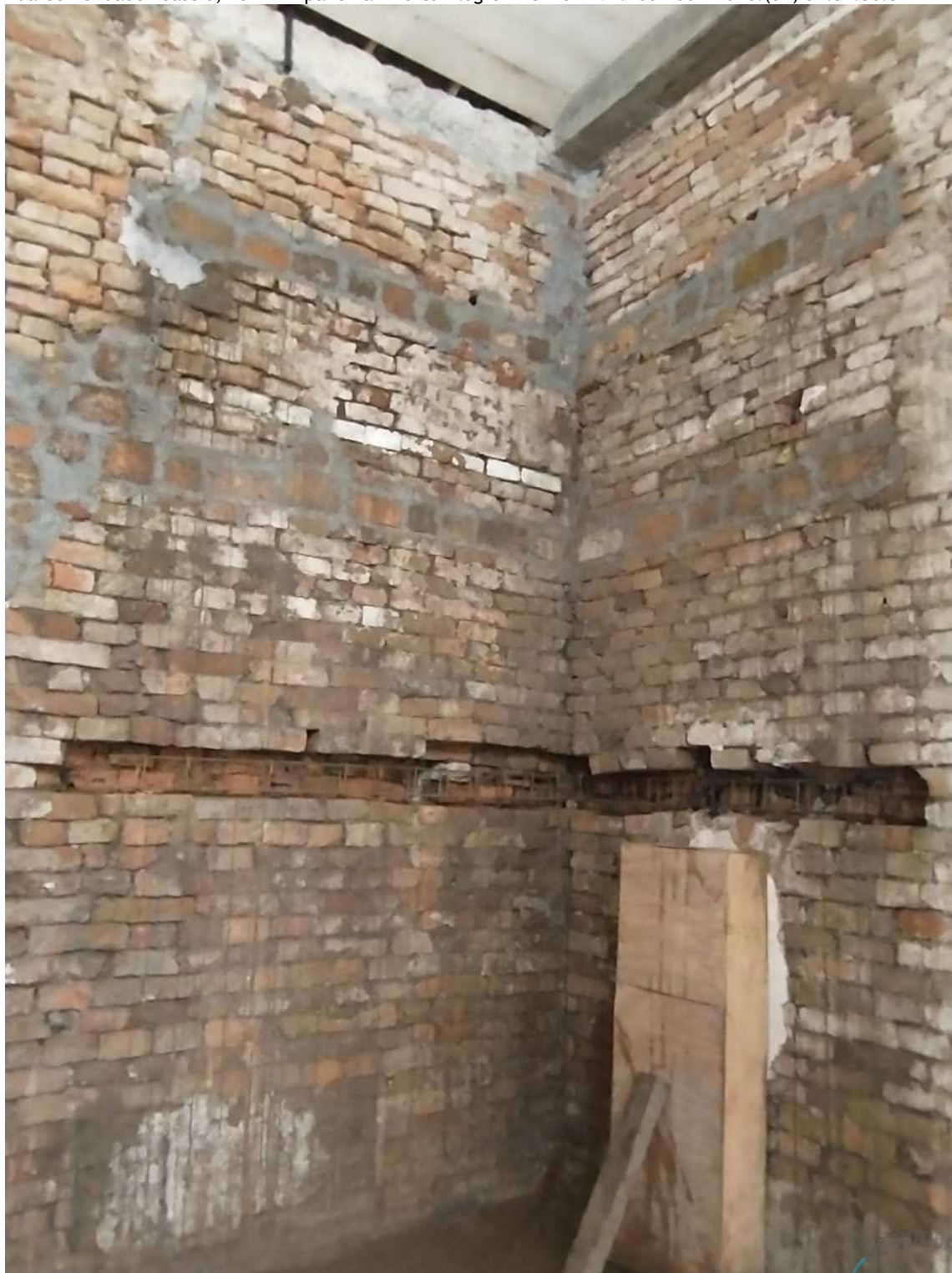
Foto 12 – Reforços estruturais internos, parede fachada principal x parede lado oeste nave principal.
