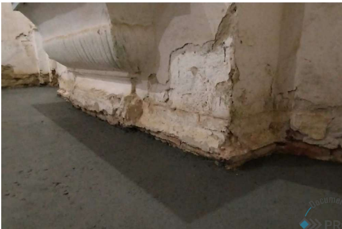
Foto 66 – Contrapiso nave principal, junto ao altar.
