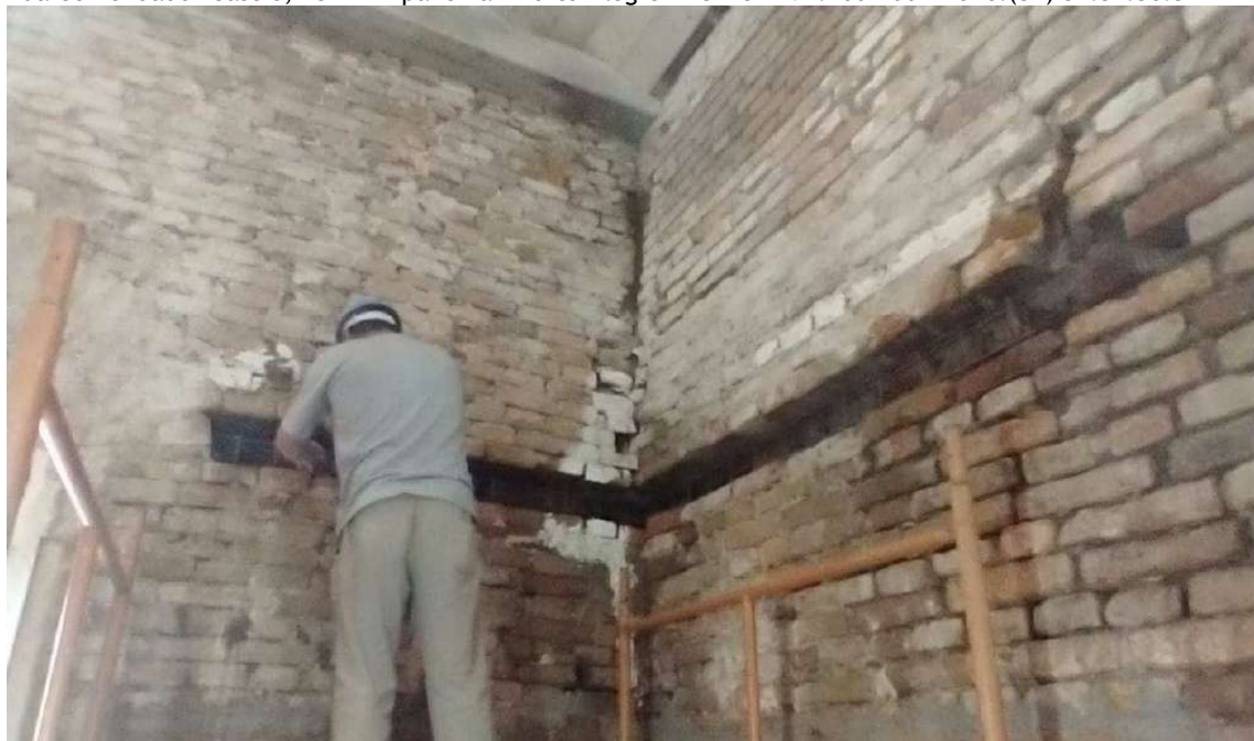
Foto 15 - Reforços estruturais internos, parede fachada principal x parede lado leste nave principal.
