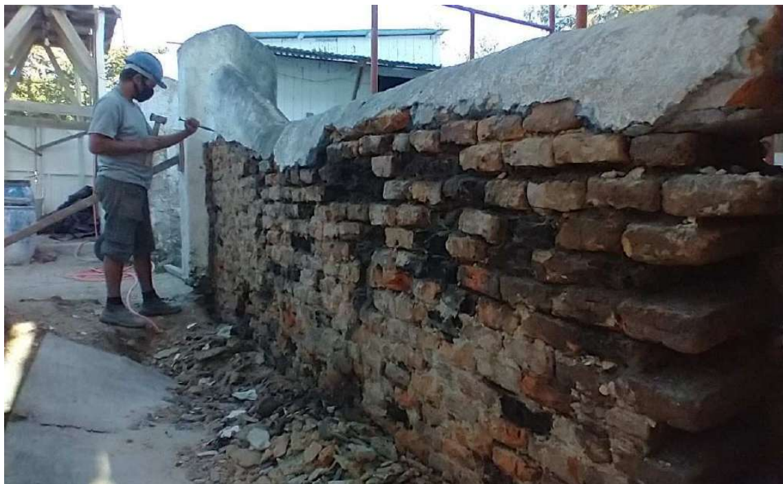
Foto 95 – Remoção revestimentos degradados muro pátio.
