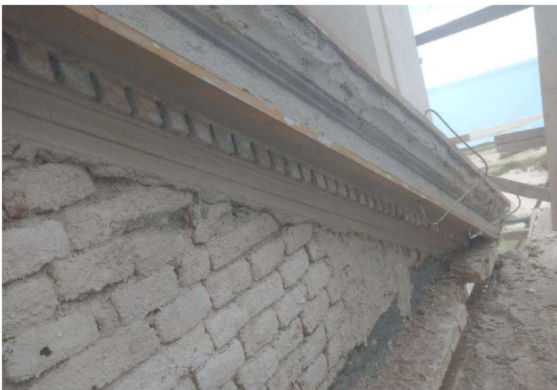
Foto 28- Execução frisos junto ao tímpano.
