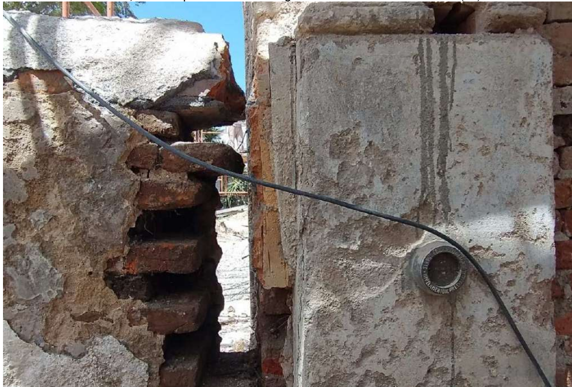
Foto 97 – Demolição de parte da alvenaria de ligação do muro com a parede da Capela, forma a possibilitar o aprumo do muro.
