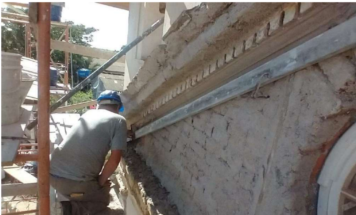
Foto 27 – Execução frisos junto ao tímpano.
