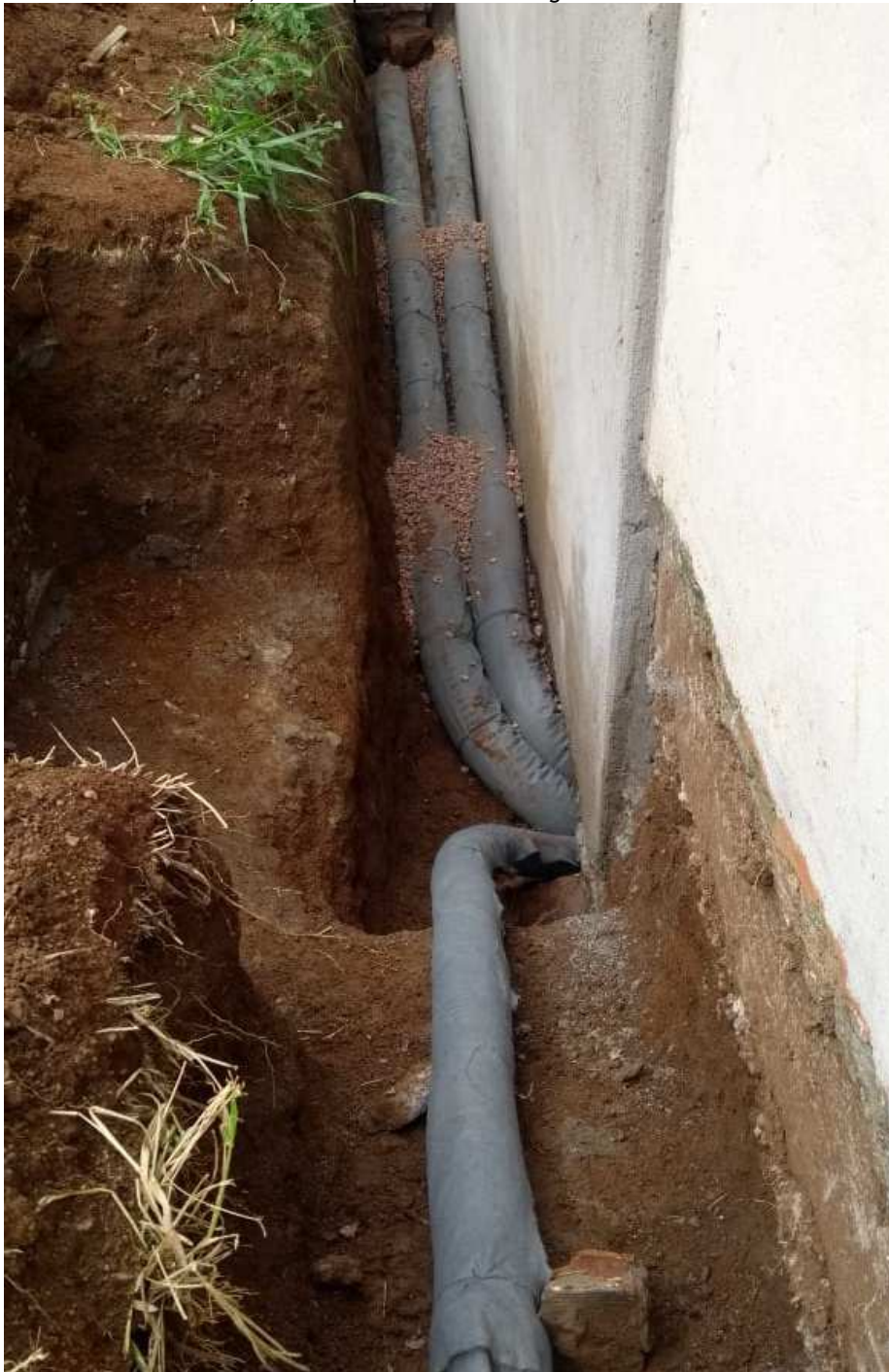
Foto 89 – Execução rede drenagem perímetro da Capela.
