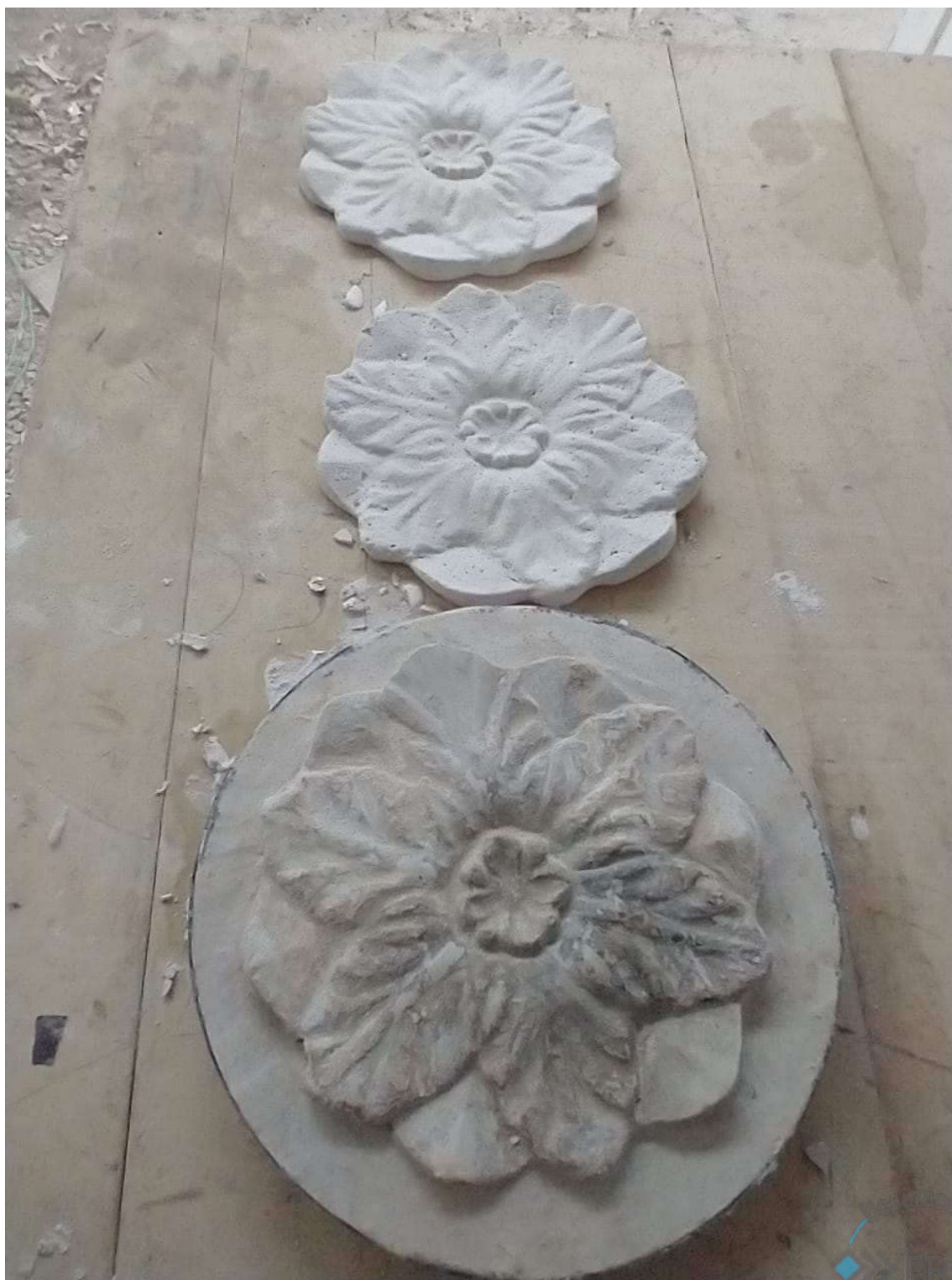
Foto 19 – Moldes de gesso ornamentos e peça em argamassa para ser aplicada na fachada.
