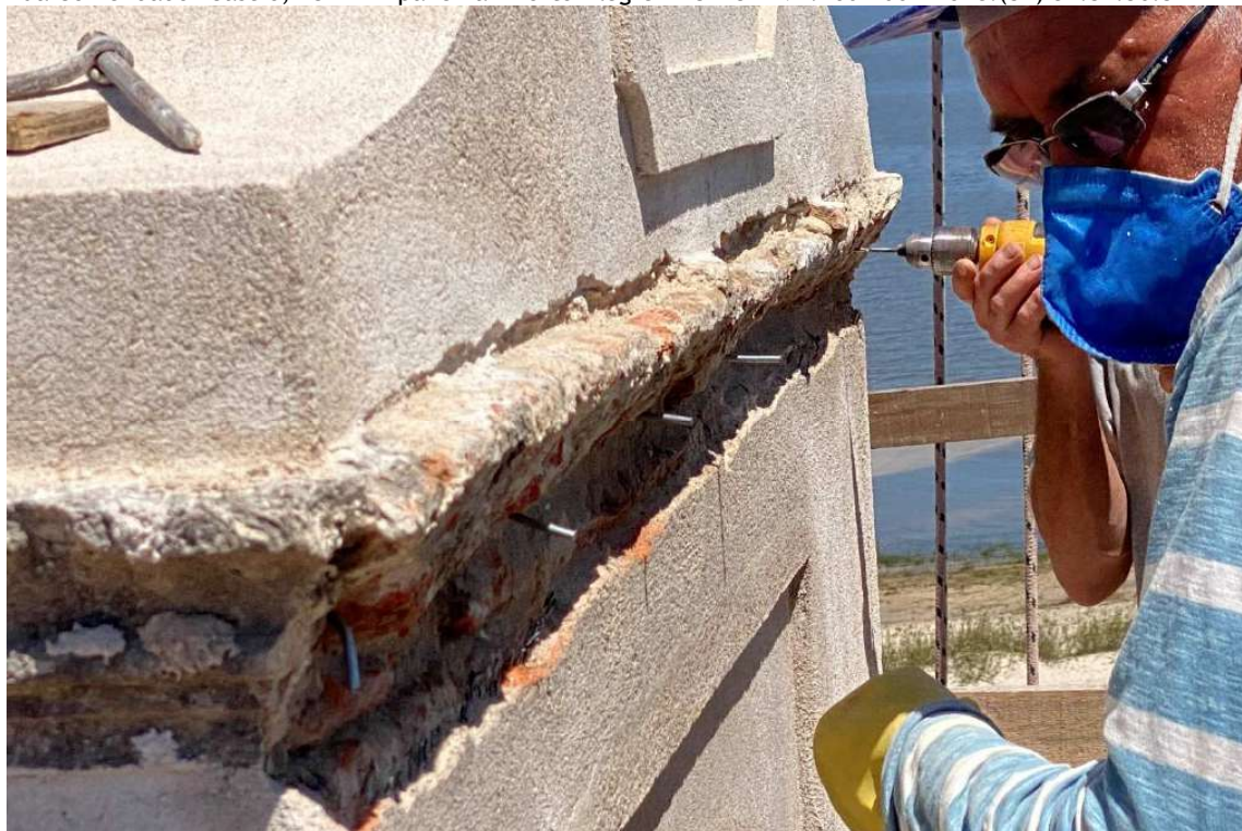
Foto 9 – Colocando pinos em inox para reforço dos frisos.
