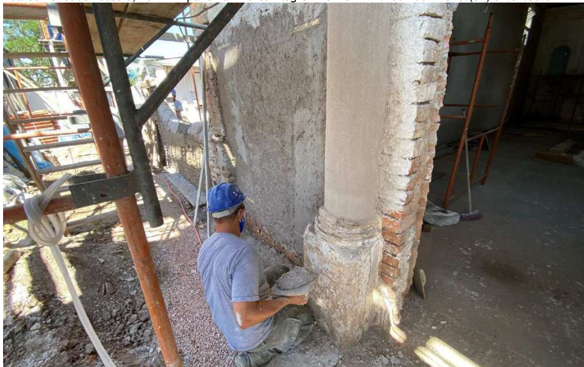
Foto 37 – Revestindo as colunas com argamassa de cal e areia 1:3.
