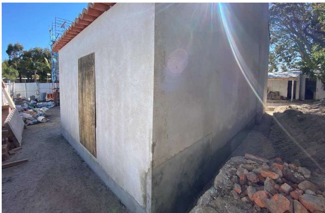
Foto 42 – Argamassa transpirável aplicada na base.
