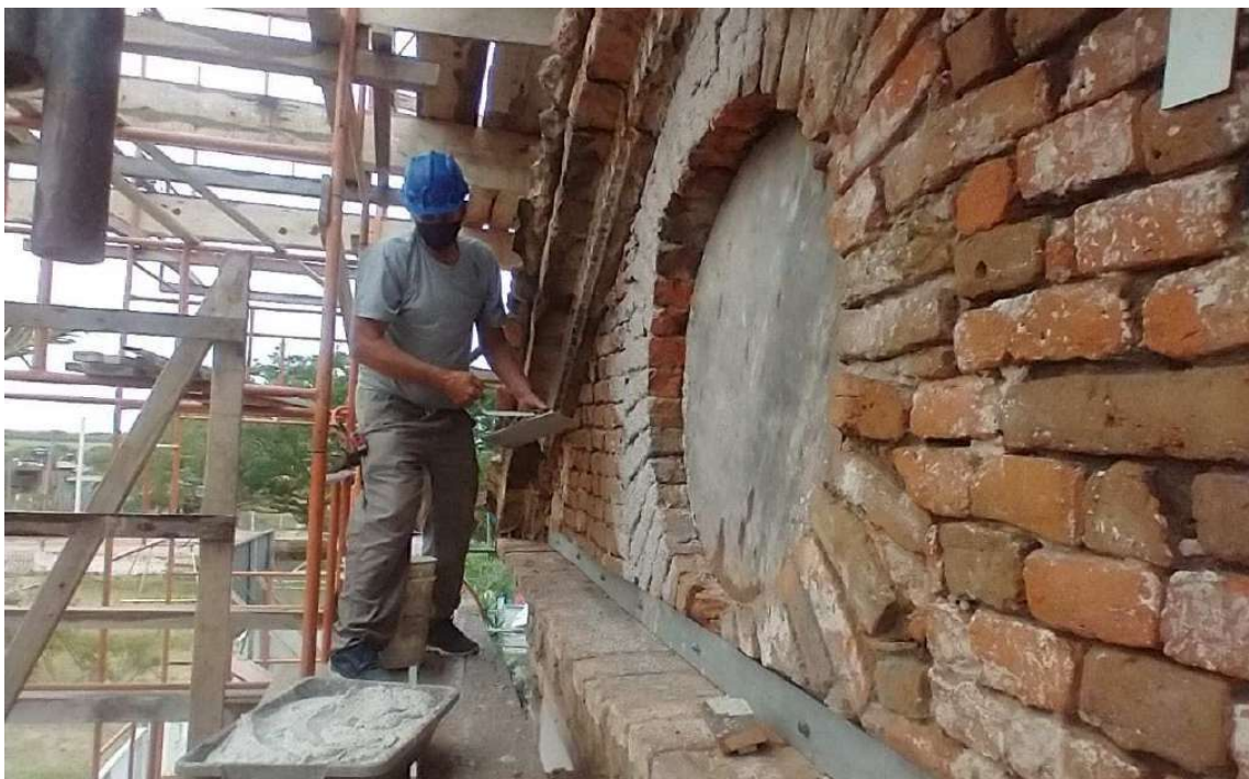
Foto 26 – Chapisco em cal e areia 1:3 para base revestimento.
