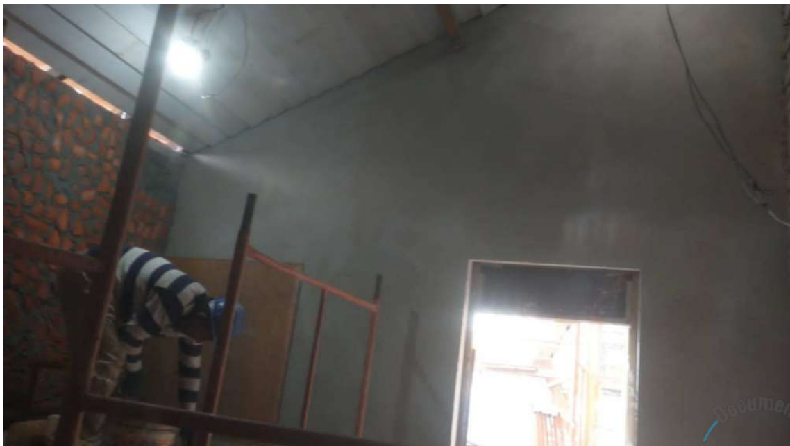
Foto 45 – Revestimento interno parede norte sacristia, argamassa de cal e areia 1:3, e encascotamento parede oeste da sacristia.
