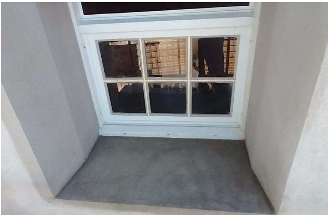
Foto 64 – Arremate janela lateral instalada, peitoril arrematado com argamassa transpirável e impermeabilizante.
