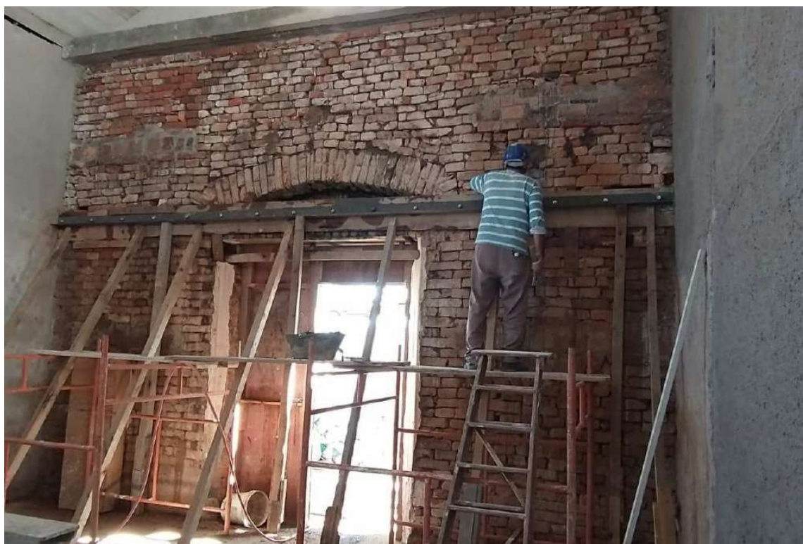
Foto 7 – Escoramento da forma da cinta e cantoneira. Cantoneira fixada com peças de barra roscada.
