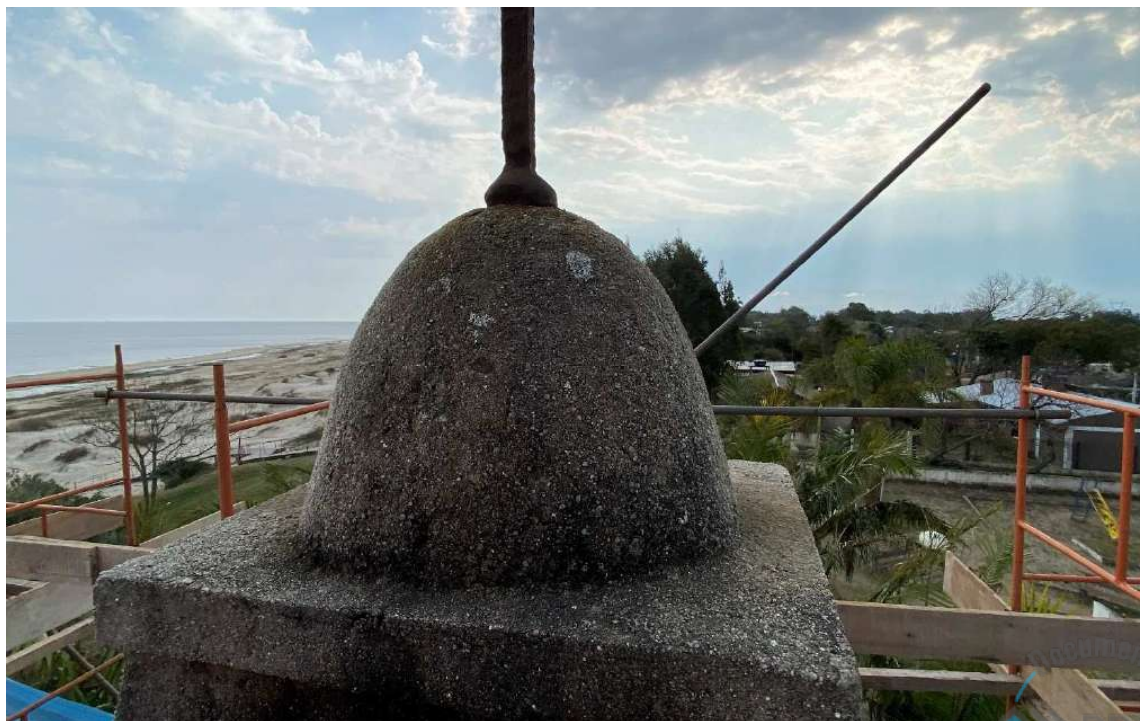
Foto 79 – Registro da base da cruz lado leste.
