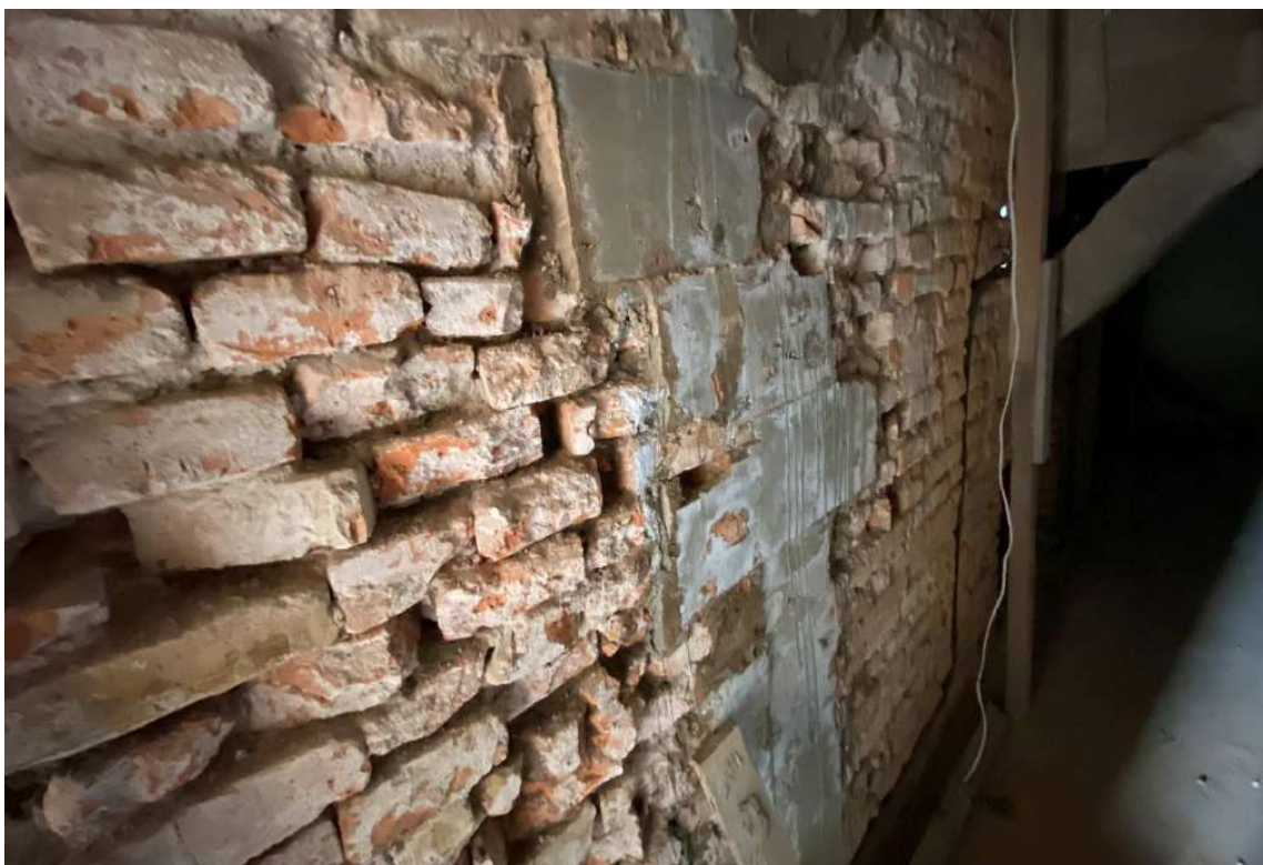
Foto 81 – Execução de reforços e grauteamento parede altar mor, parte de trás.
