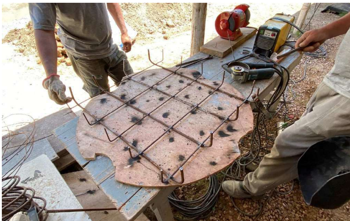
Foto 100 – execução armaduras sapatas de reforço fundações do muro.
