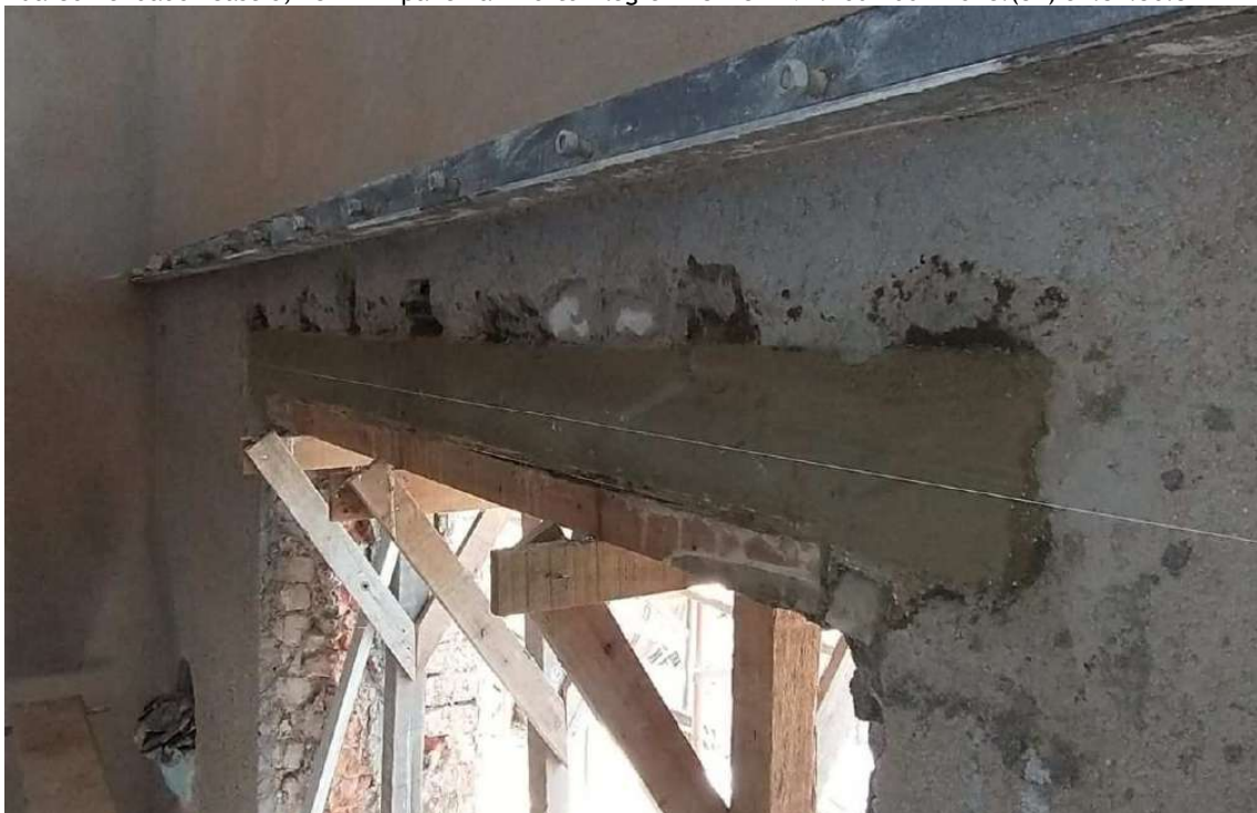
Foto 27 – Instalação de 3 perfis metálicos 4” na verga da porta principal e grauteamento.
