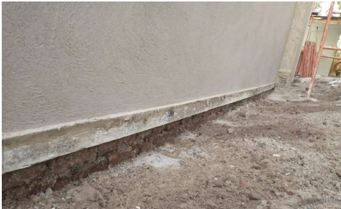
Foto 29 – Vista parede sul, trecho próxima ao solo, onde será revestido com argamassa transpirável.
