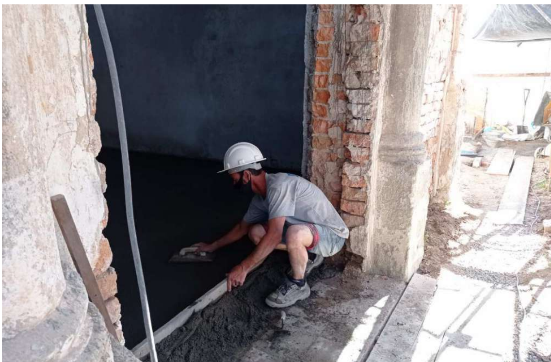
Foto 54 – Base em cimento e areia.
