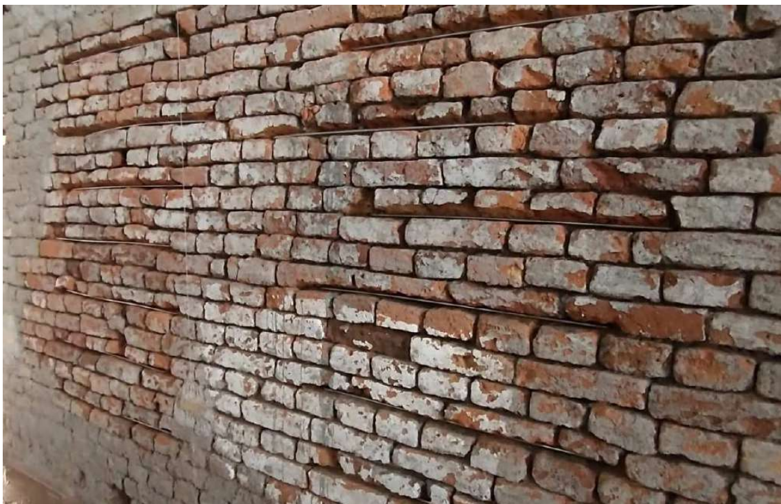
Foto 1 – Grampeamento trechos rachados com barras aço inox.
