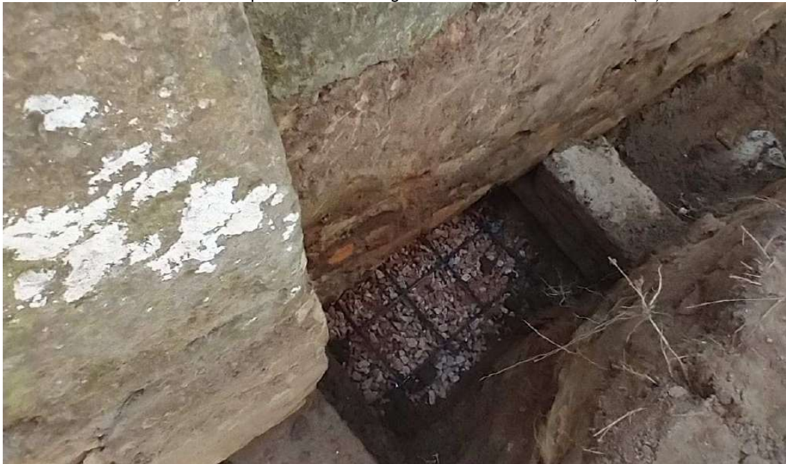
Foto 103 – Armadura sapata base muro.
