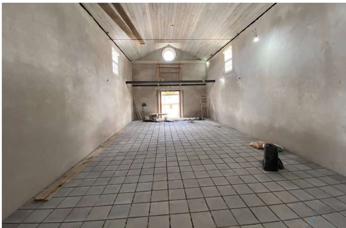
Foto 50 – Colocação de piso definitivo - basalto fosco tear. Nave principal.
