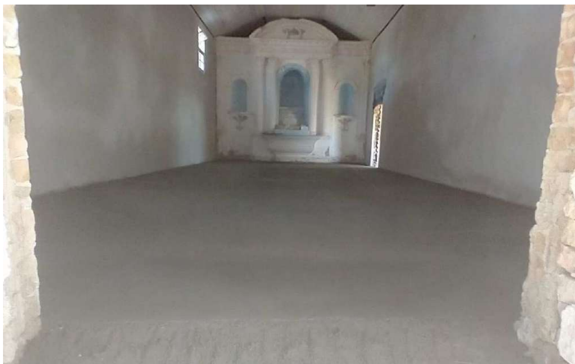
Foto 56 – Base em cimento e areia finalizado na nave principal.
