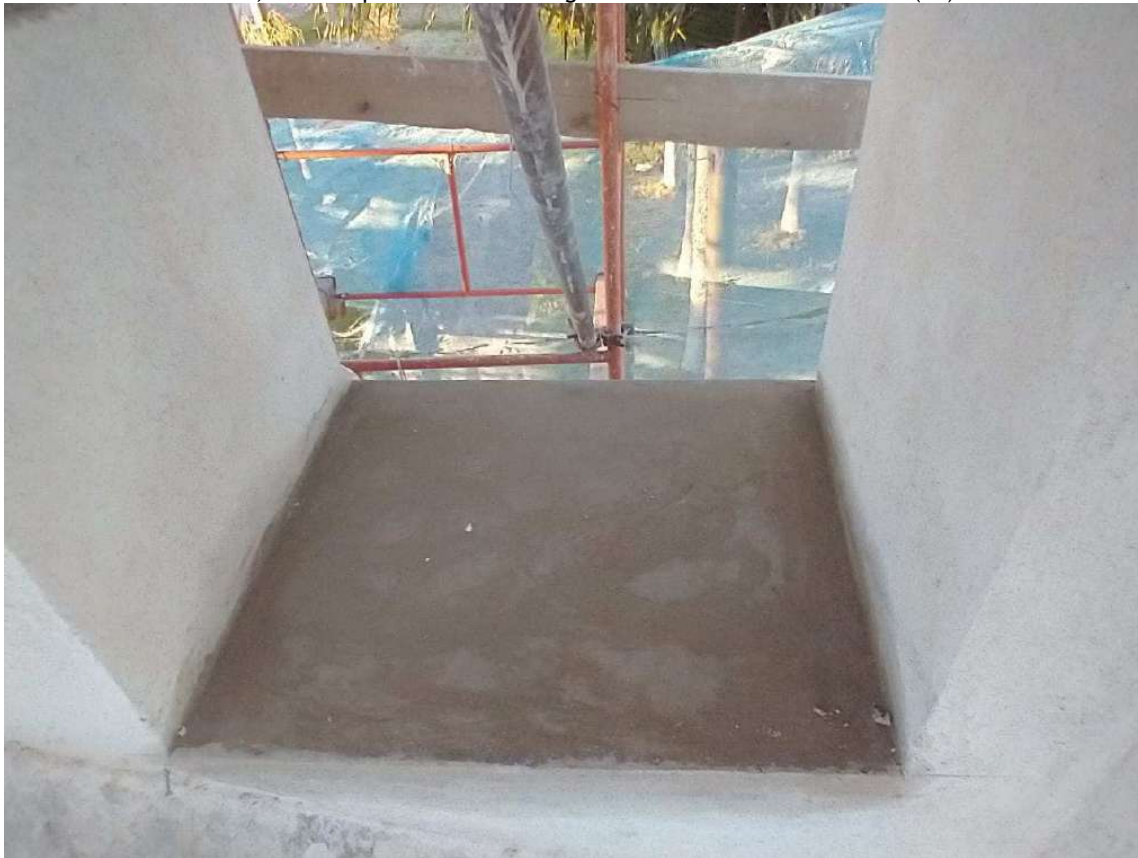
Foto 13 – Base interna da torre sineira com argamassa impermeabilizante e transpirável.
