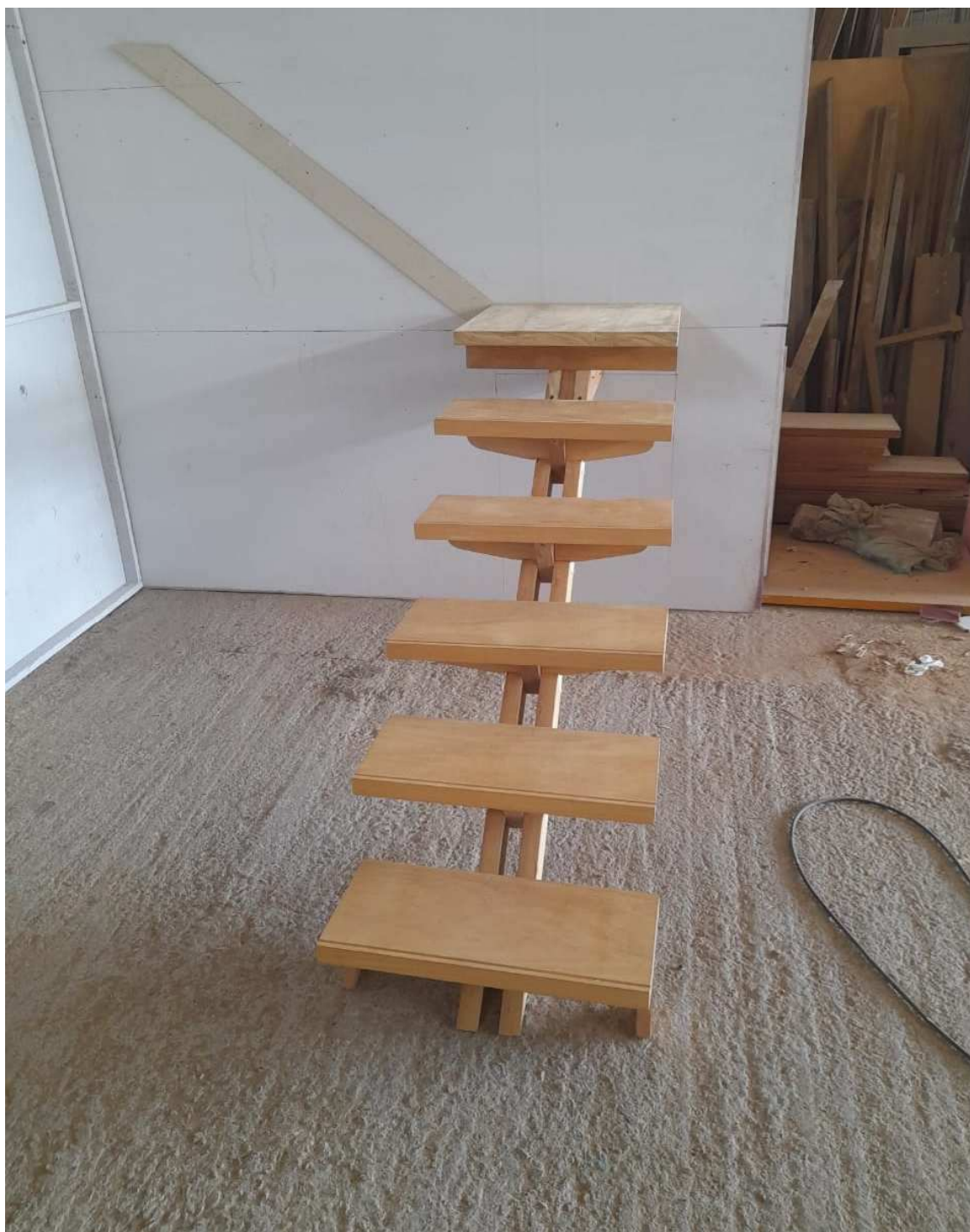
Foto 93 – Execução escada coro na marcenaria.
