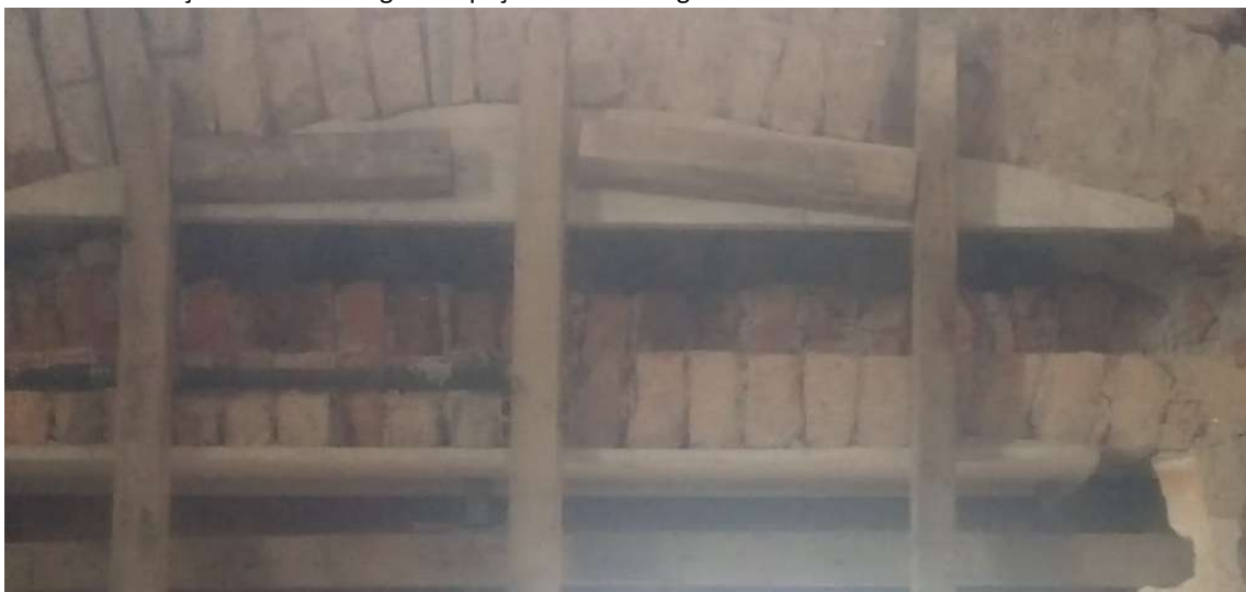
Foto 25 – Reforço do arco da verga com peças metálicas e grauteamento.
