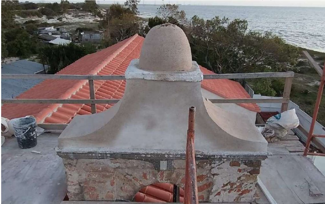
Foto 77 – Execução revestimentos em argamassa de cal e areia 1:3
