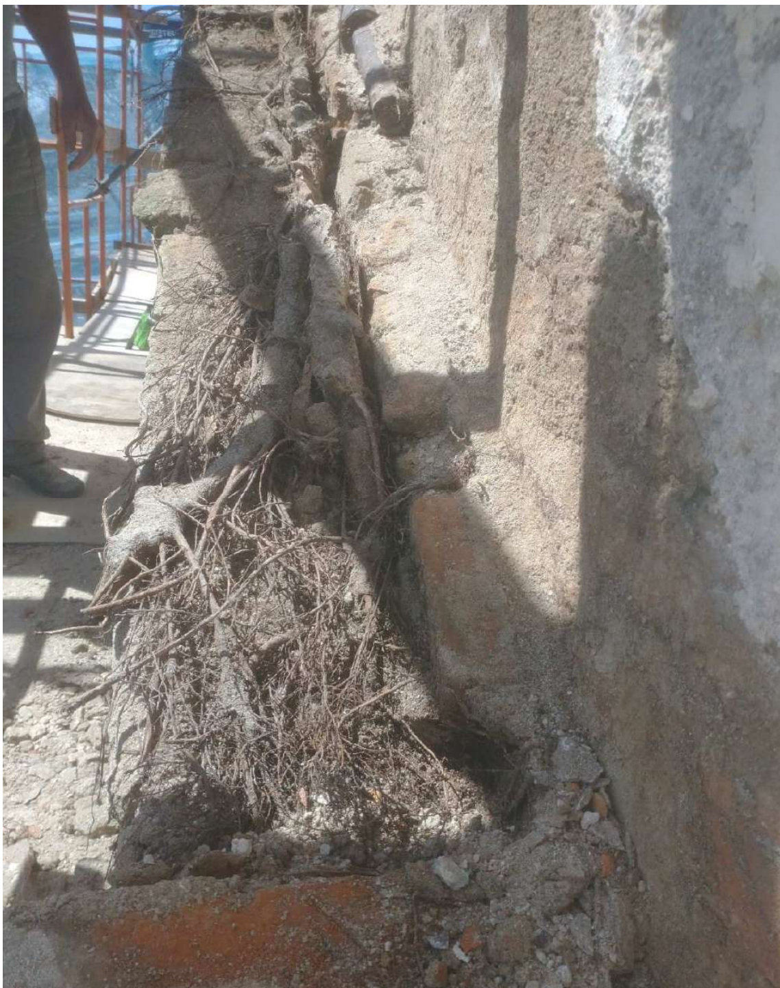
Foto 65 – Remoção arbustos sobre as cimalthas.
