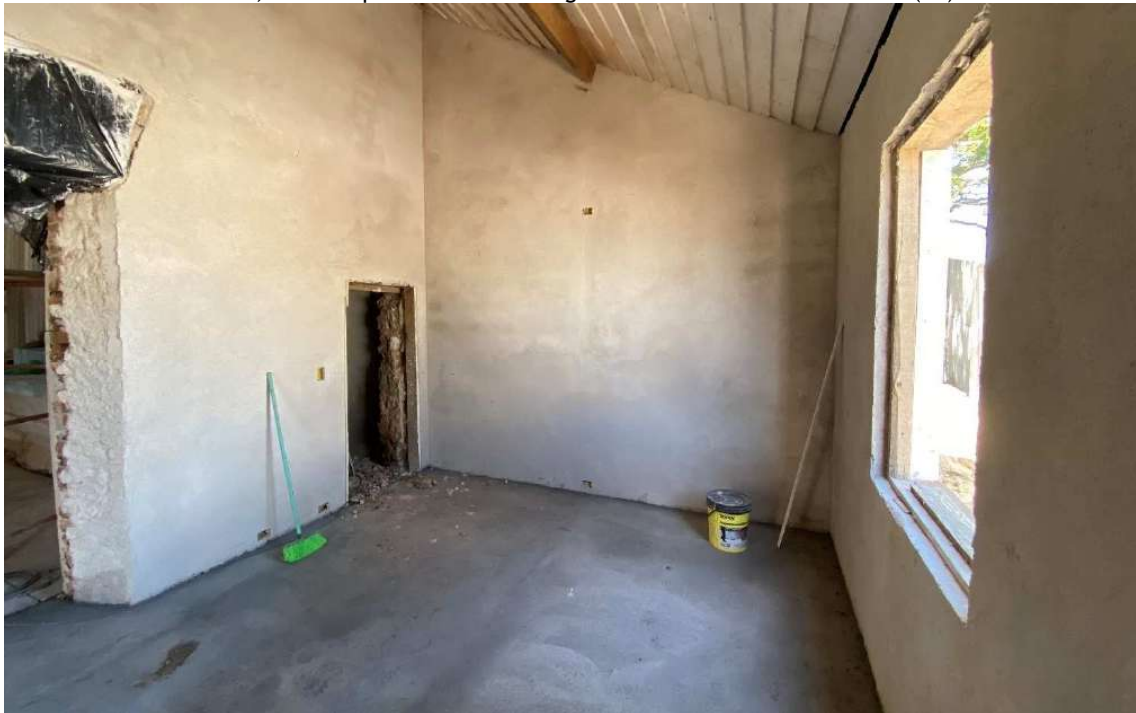
Foto 57 – Base em cimento e areia finalizado na nave principal.
