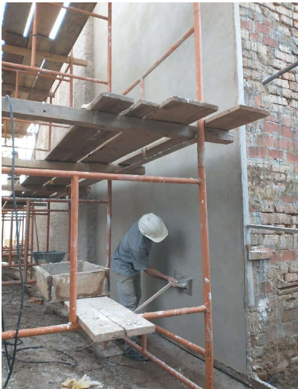
Foto 27 – Vista parede sul, executando o revestimento em cal e areia 1:3.
