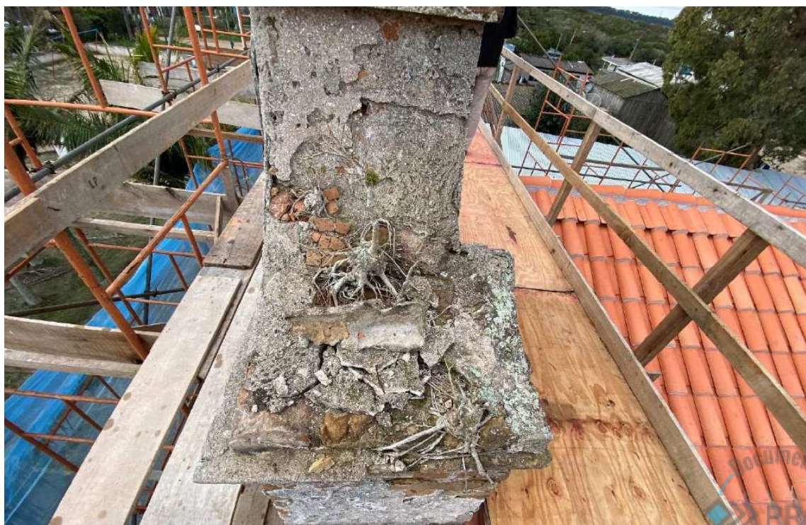
Foto 81 – Registro estado da torre sino lado oeste.
