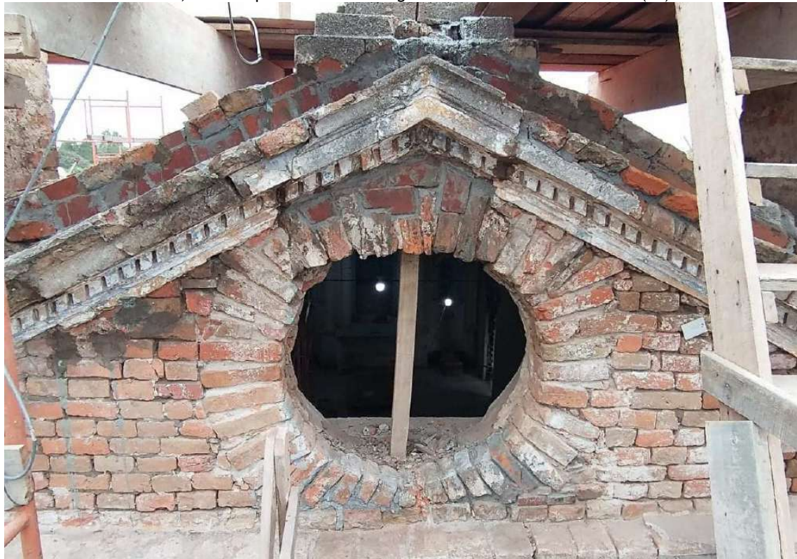
Foto 69 – Preenchimento de vazios com graute e reconstituição de elementos.
