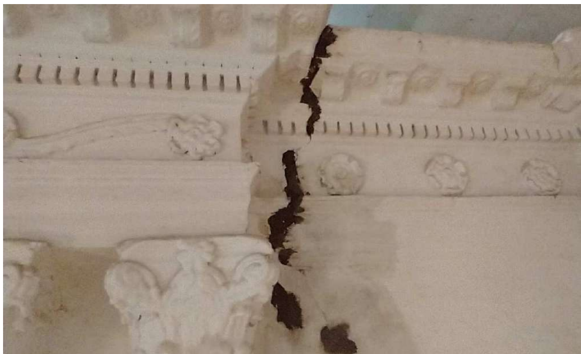
Foto 83 – Execução de grauteamento em rachadura do altar mor, pela parte de trás e tamponamento provisório com barro, para evitar escorrimentos.
