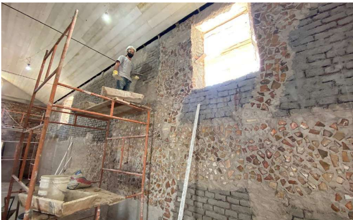
Foto 50 – Encascotamento e chapisco parede interna.
