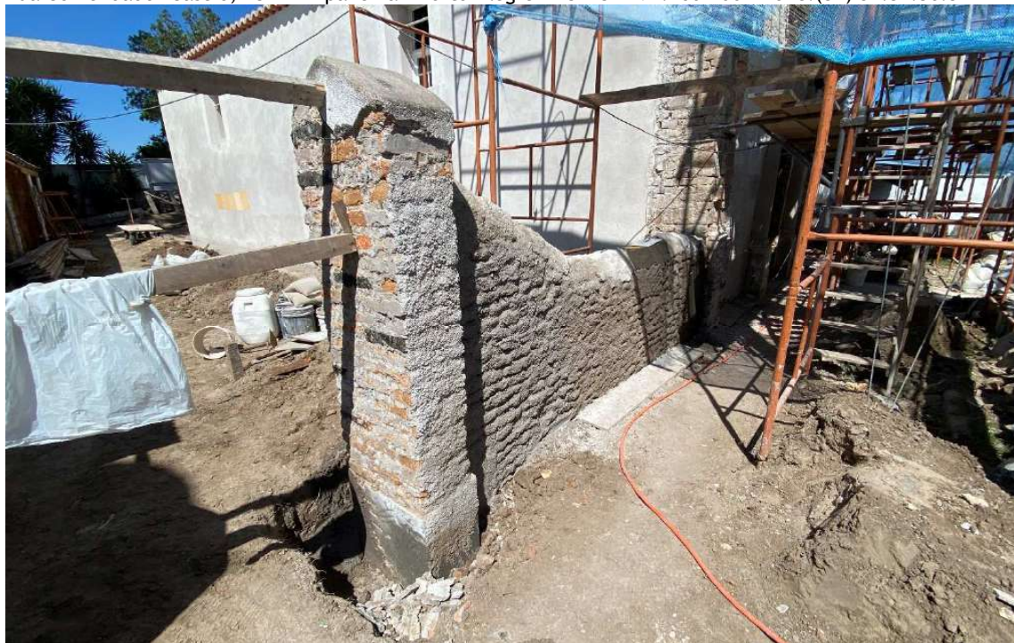
Foto 105 – Execução de enchimentos base para futuro revestimento em cal e areia 1:3.
