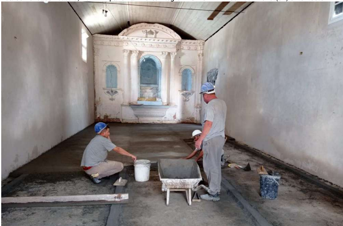
Foto 53 – Base em cimento e areia.
