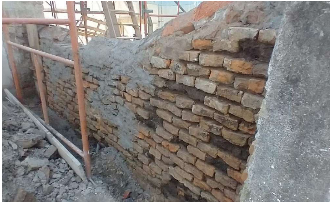
Foto 96 – Remoção revestimentos degradados muro pátio.
