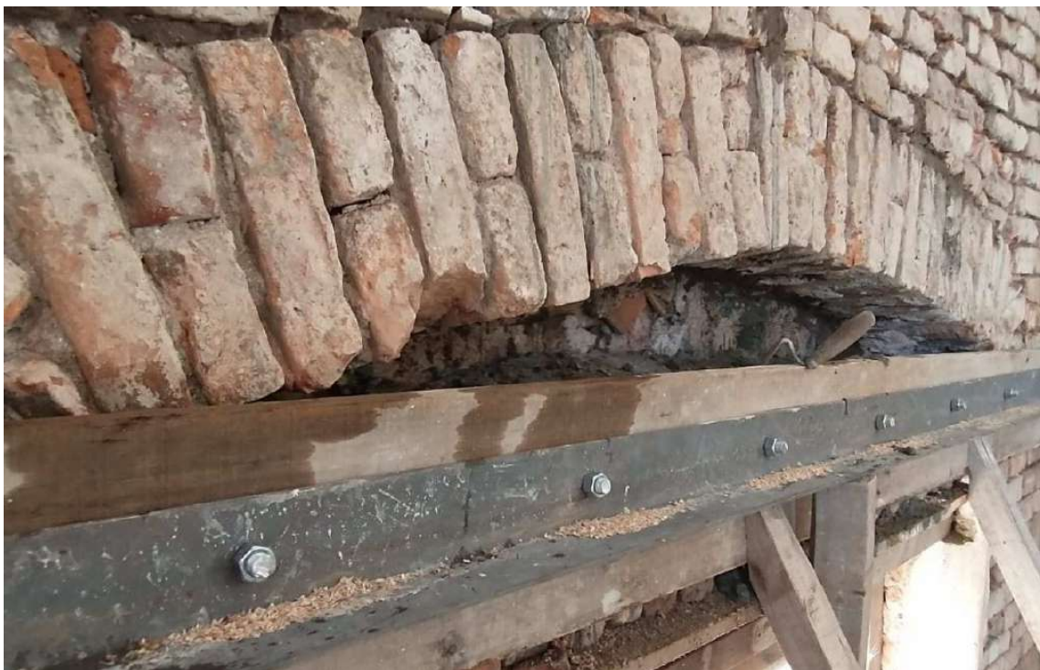
Foto 11 – Detalhe da forma da cinta e cantoneira. Cantoneira fixada com peças de barra roscada.
