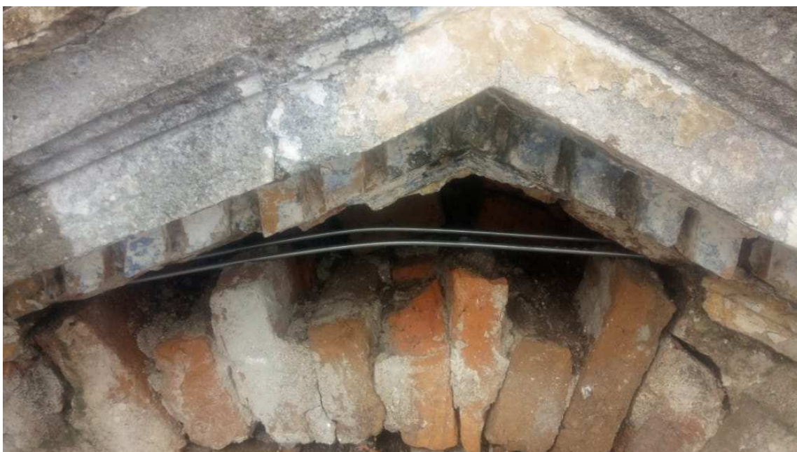
Foto 30 – Reforço do arco da verga com peças metálicas e grauteamento.
