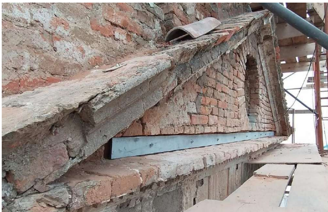
Foto 19 – Chapa metálica de reforço instalada e fixada na cinta interna com barras roscadas.
