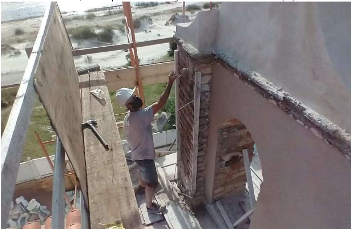
Foto 5 – Revestimento em argamassa de cal e areia 1:3.
