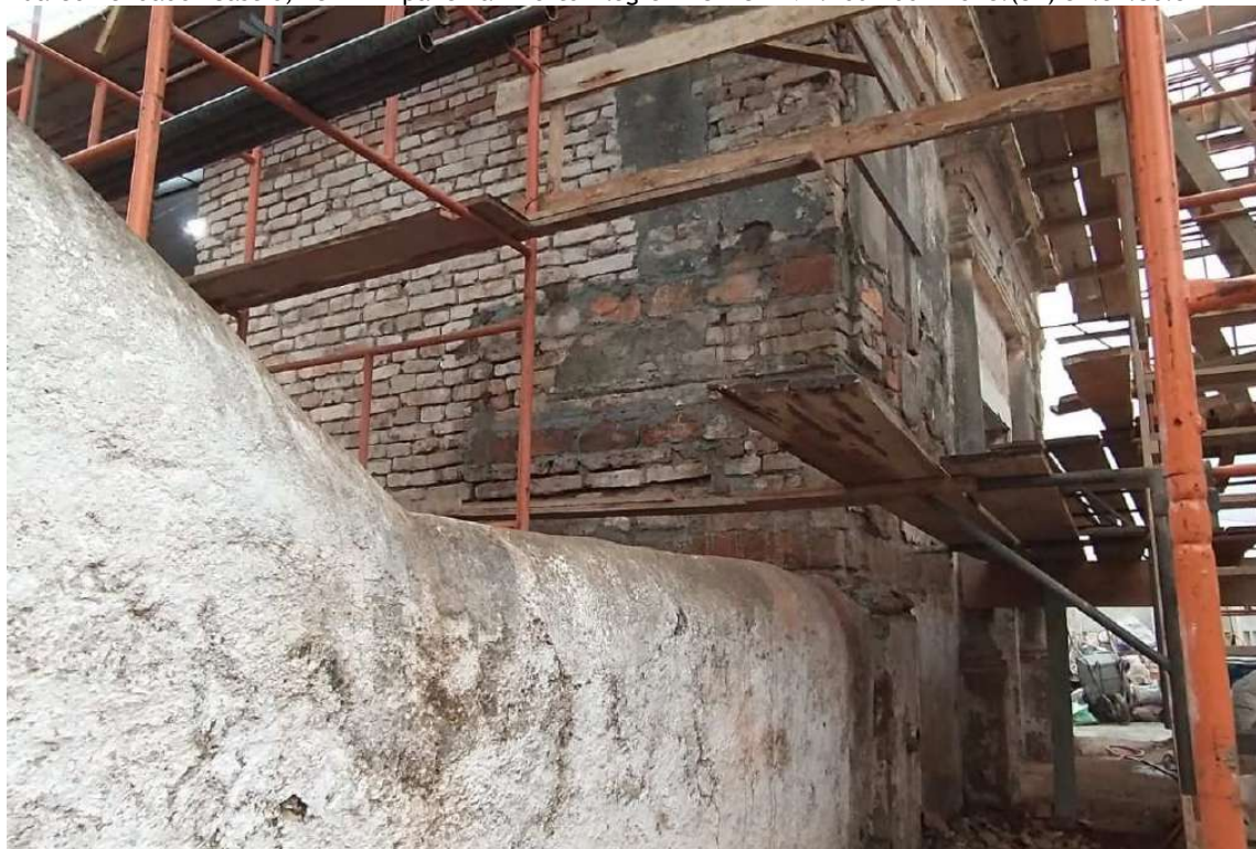
Foto 10 – Reforços no canto entre a parede fachada principal e parede Leste, amarração.
