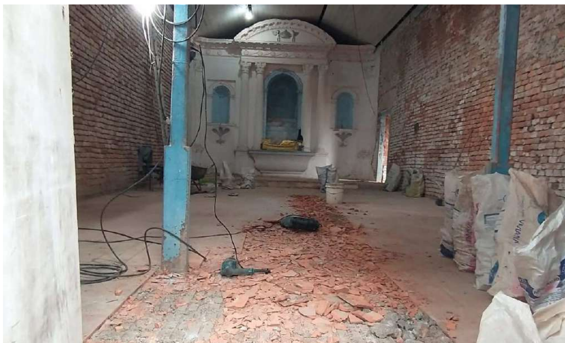
Foto 53 – Demolição piso e contrapiso existente para executar contrapiso na nave principal.
