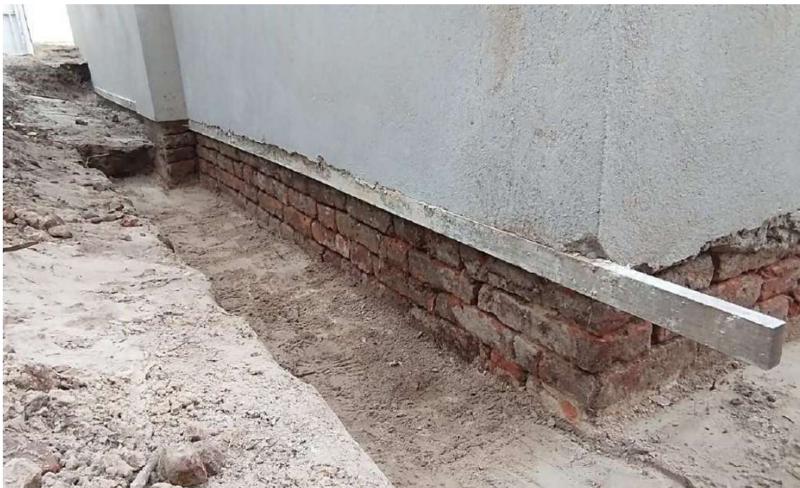
Foto 33 – Preparação da base para aplicação de argamassa transpirável.
