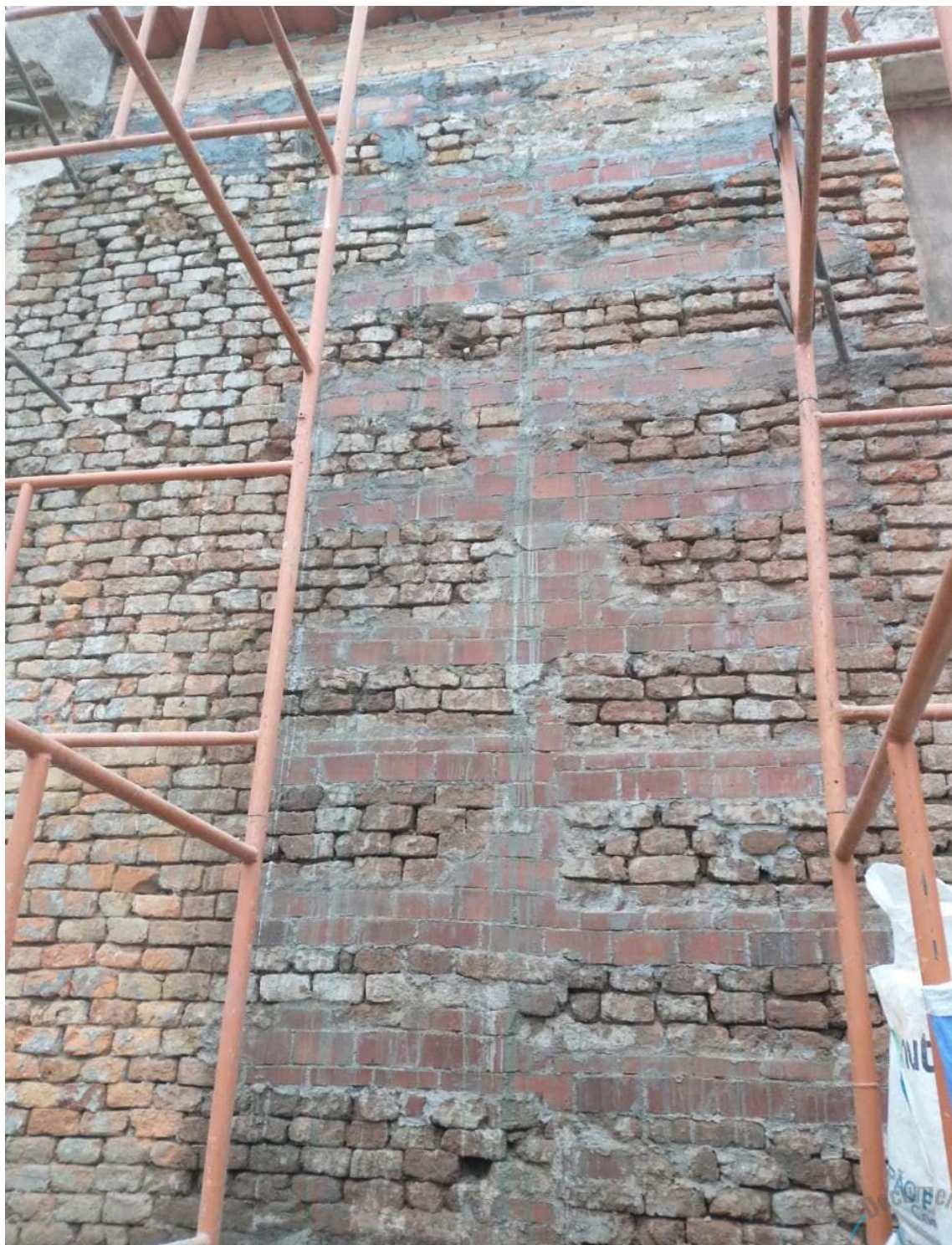
Foto 1 – Parede Oeste, lado lagoa.
