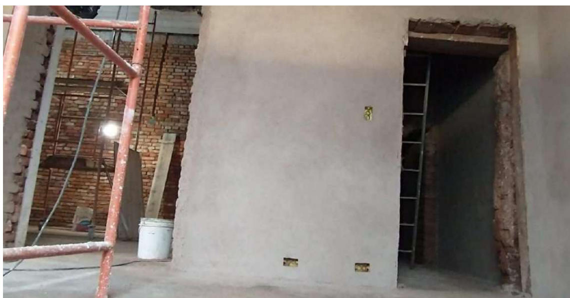
Foto 48 – Instalações elétricas – tubulações e caixas - sacristia.
