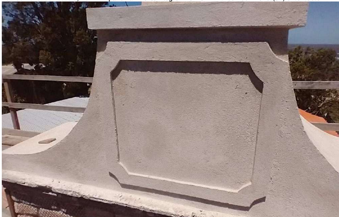
Foto 11 – Detalhe da moldura da parte frontal da torre sineira.
