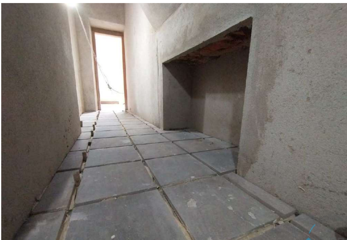
Foto 58 – Colocação de piso definitivo e rodapés - basalto fosco tear – Compartimento atrás Altar Mor.
