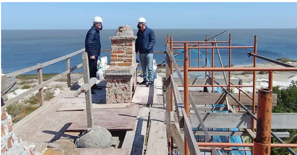
Foto 81 – Arquiteto Renato Savoldi do IPHAE verificando trabalhos nas torres com Eng Paulo Walter.
