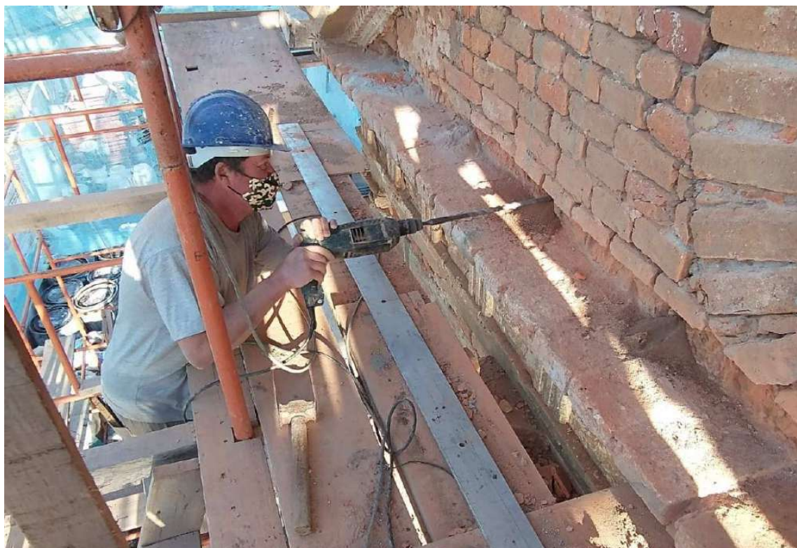
Foto 17 – Execução de furos na alvenaria e na cinta interna para inserção de chapa metálica de reforço.
