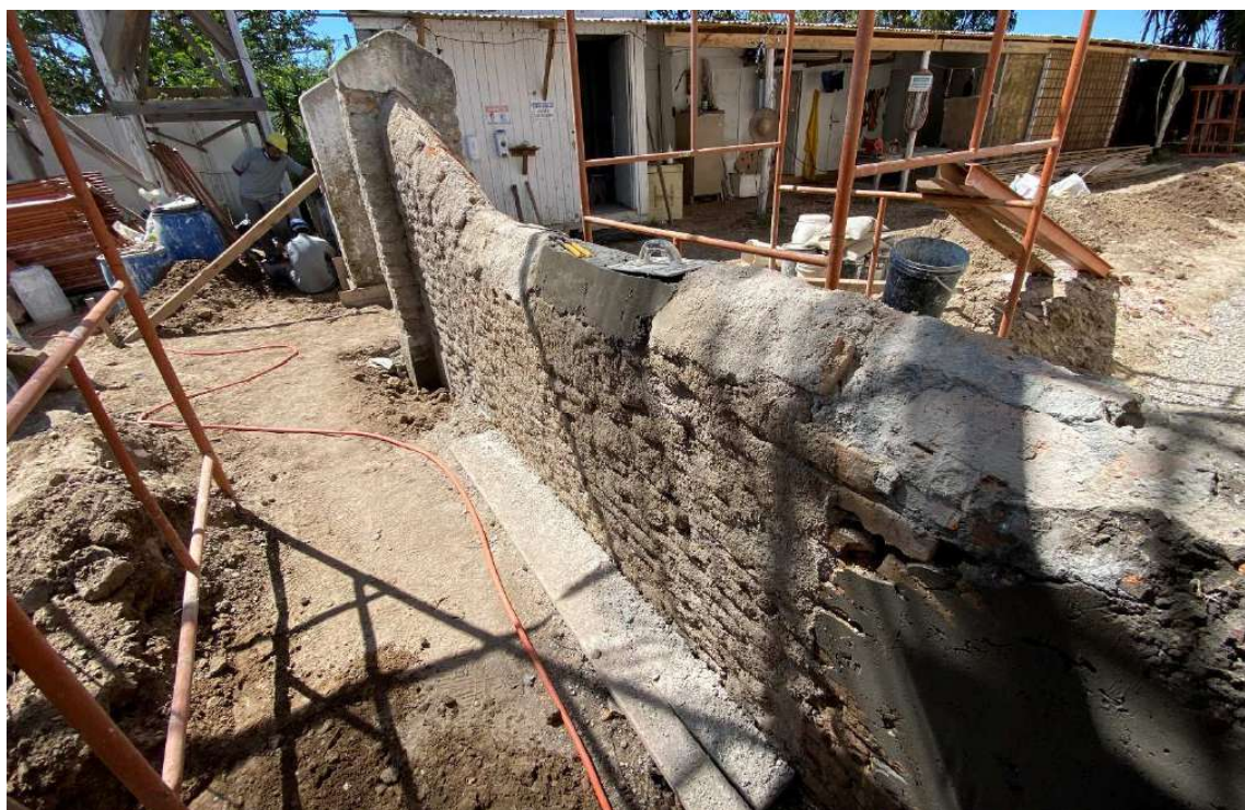
Foto 106 – Execução de enchimentos base para futuro revestimento em cal e areia 1:3.
