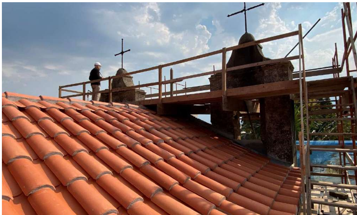
Foto 72 – Estrutura acesso as torres.
