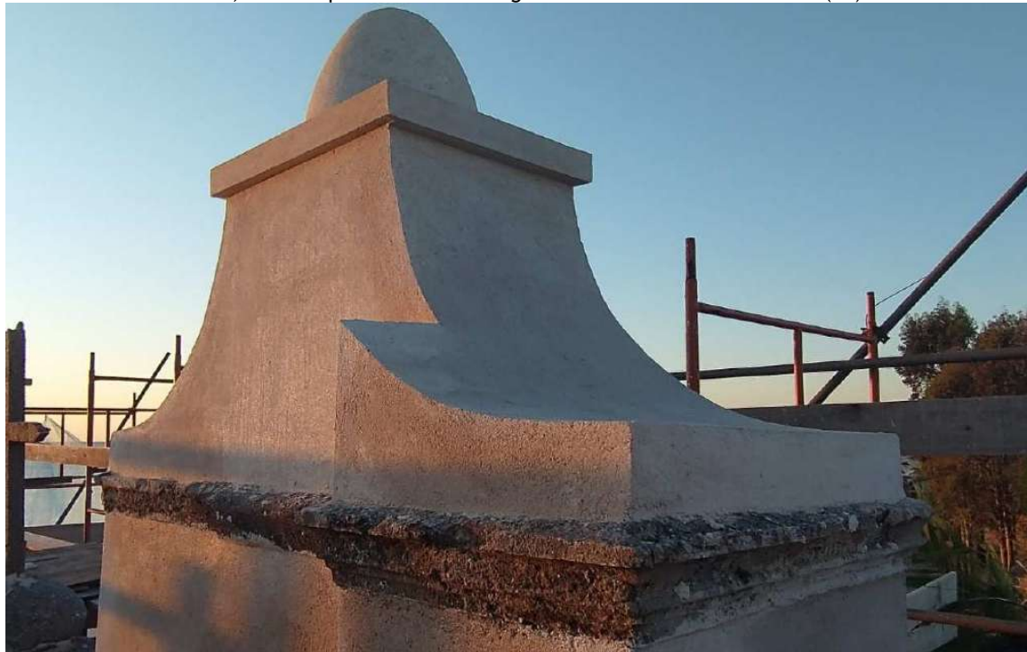
Foto 15 – Revestimento em argamssa de cal e areia 1:3.
