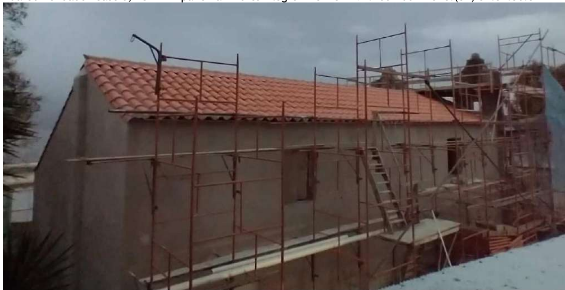
Foto 42 – Vista parede leste da nave principal revestida com argamassa cal e areia 1:3.
