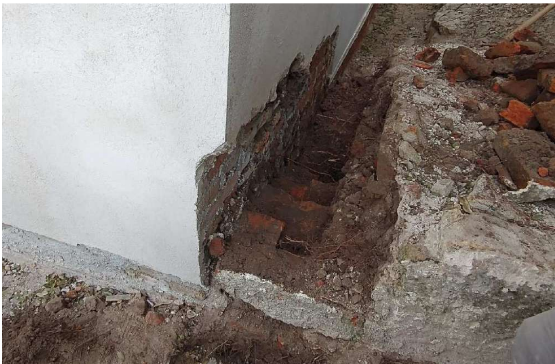
Foto 37 – Preparação da base para aplicação de argamassa transpirável..
