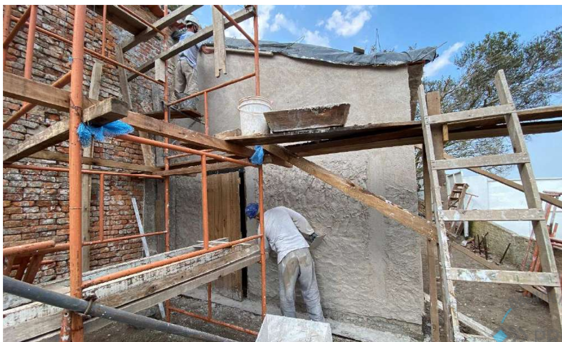
Foto 33 – Vista parede norte da sacristia sendo revestida com argamassa cal e areia 1:3.
