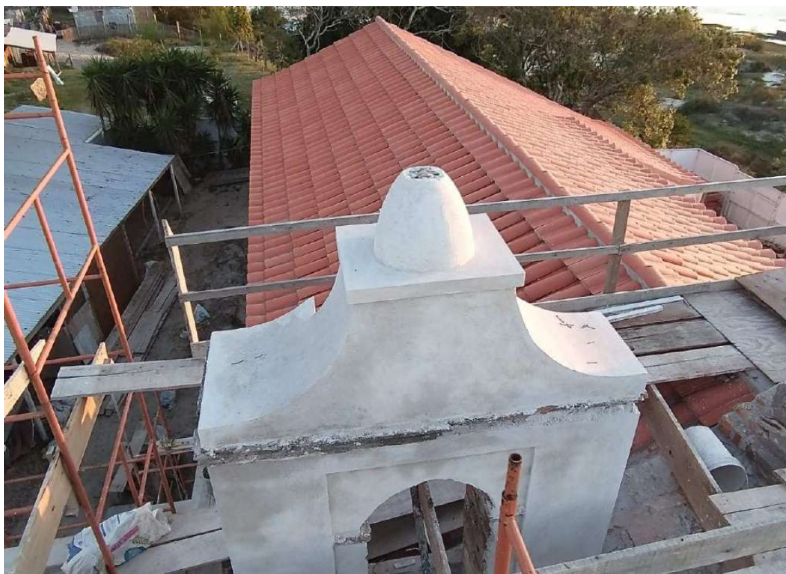
Foto 24 – Revestimento em argamassa de cal e areia 1:3.
