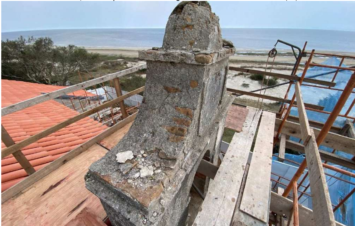
Foto 82 – Registro estado torre sino lado leste.
