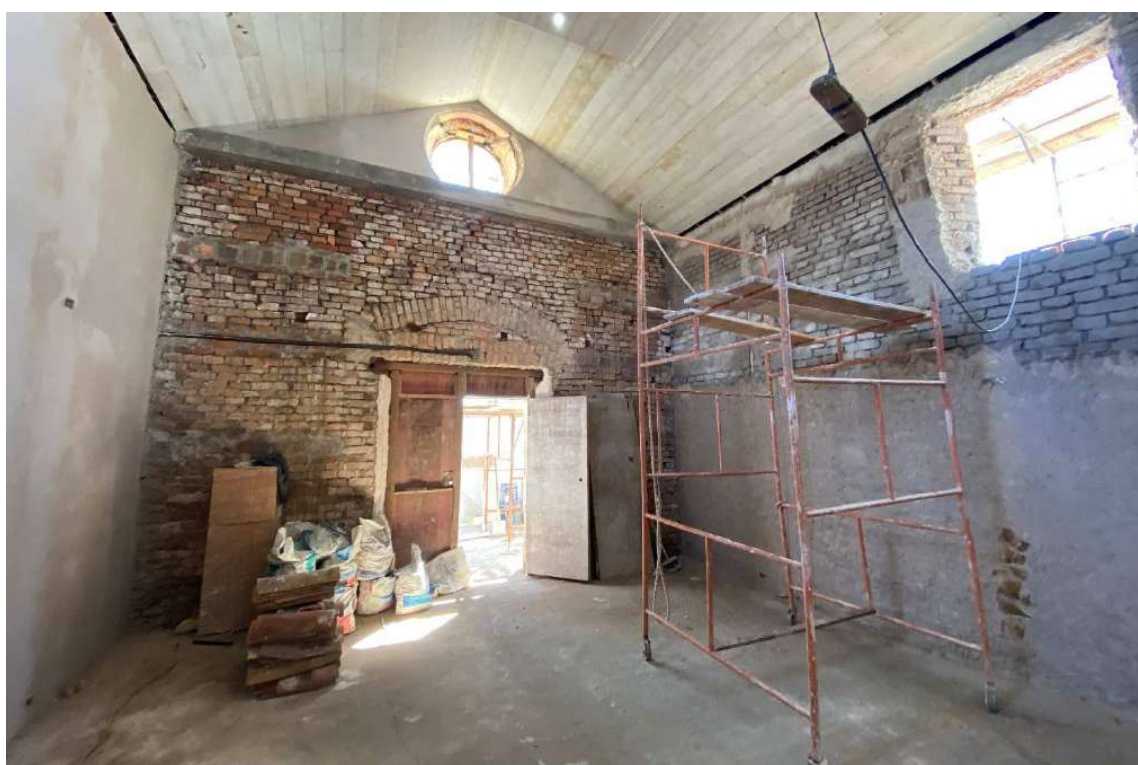
Foto 52 – Encascotamento e chapisco parede interna.
