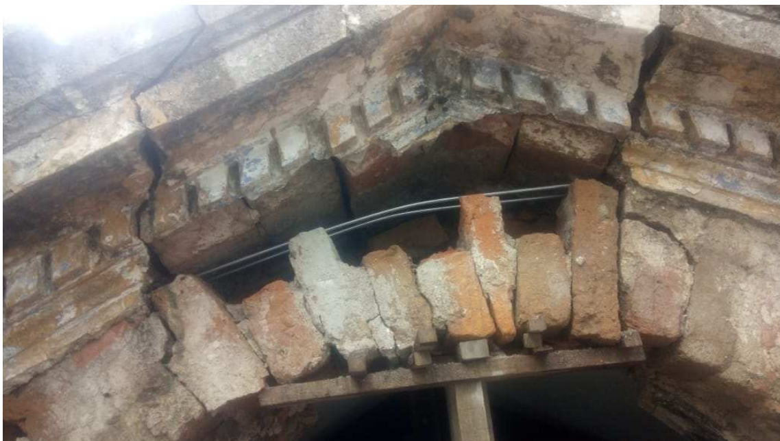
Foto 29 – Reforço do arco da verga com peças metálicas e grauteamento.
