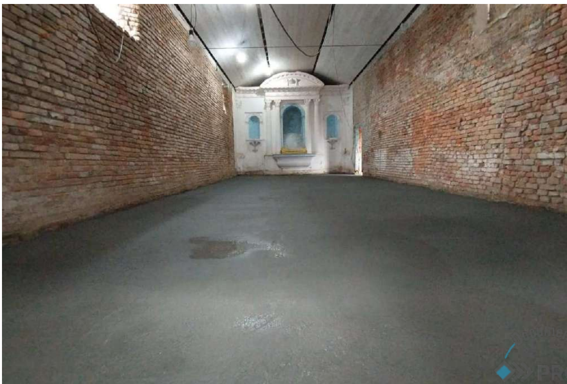
Foto 64 – Contrapiso da nave principal.
