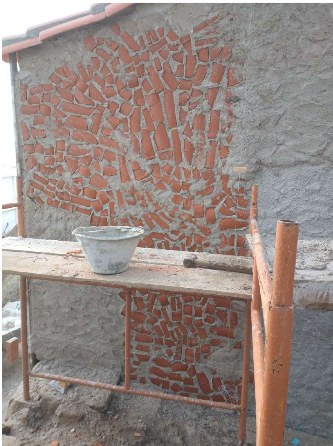
Foto 23 – Parede parcialmente encascotada, parede sul.
