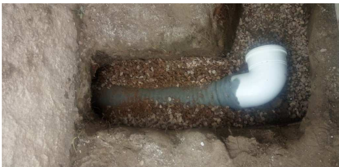
Foto 85 – Execução rede drenagem perímetro da Capela.
