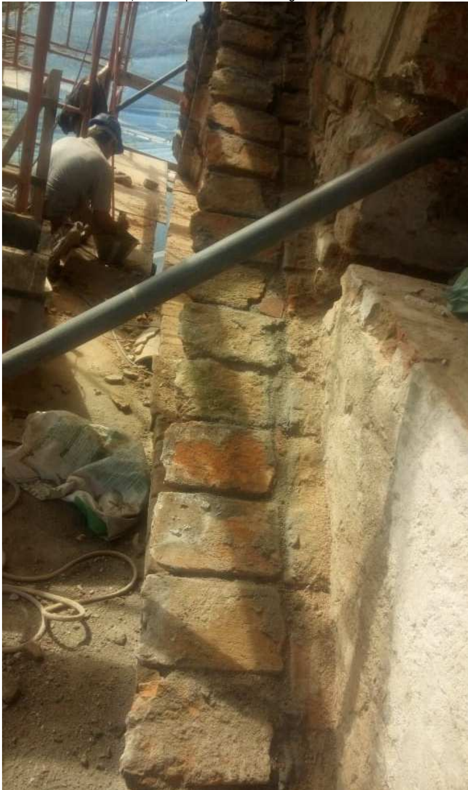
Foto 66 – Cimalha após a remoção dos arbustos.
