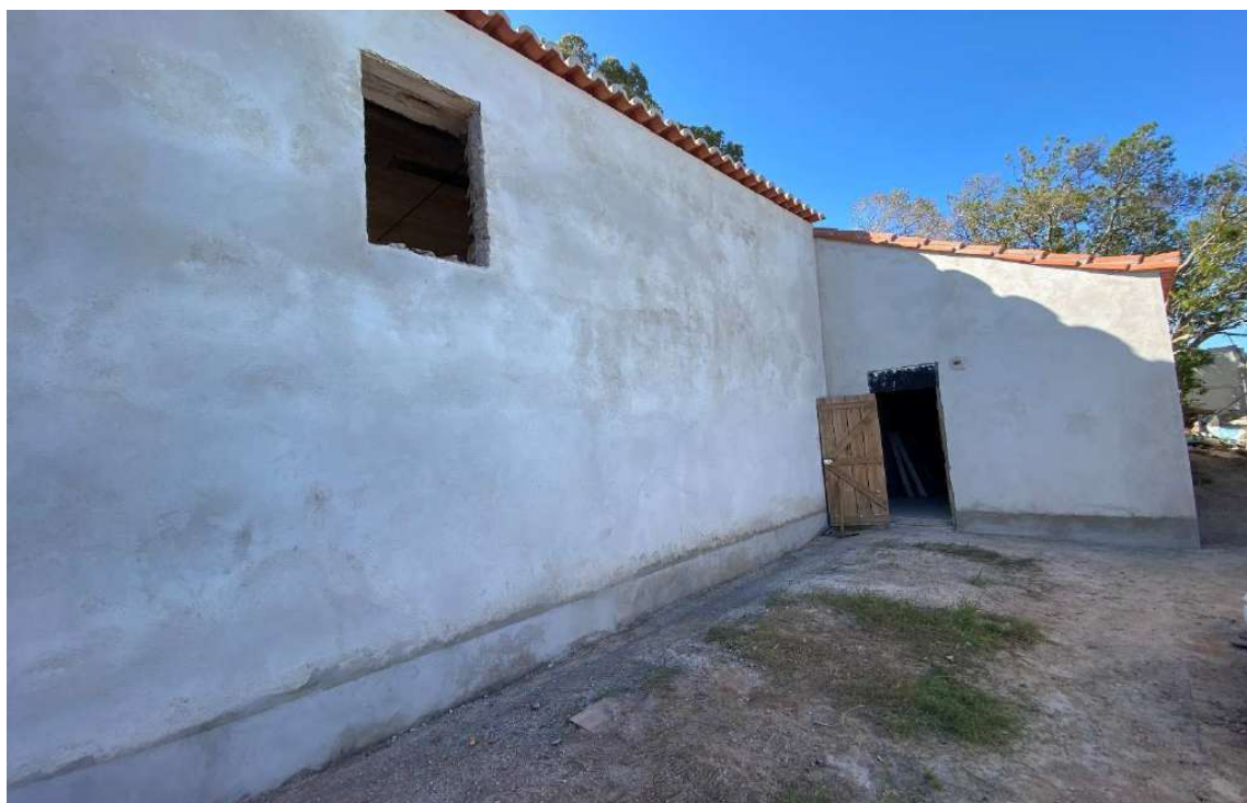
Foto 41 – Argamassa transpirável aplicada na base.
