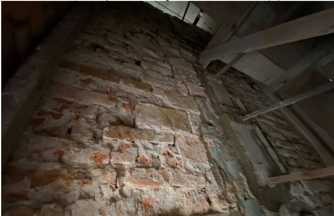
Foto 80 – Execução de reforços e grauteamento parede altar mor, parte de trás.
