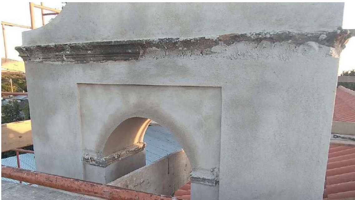
Foto 14 – Revestimentos e frisos em argamassa de cal 1:3.
