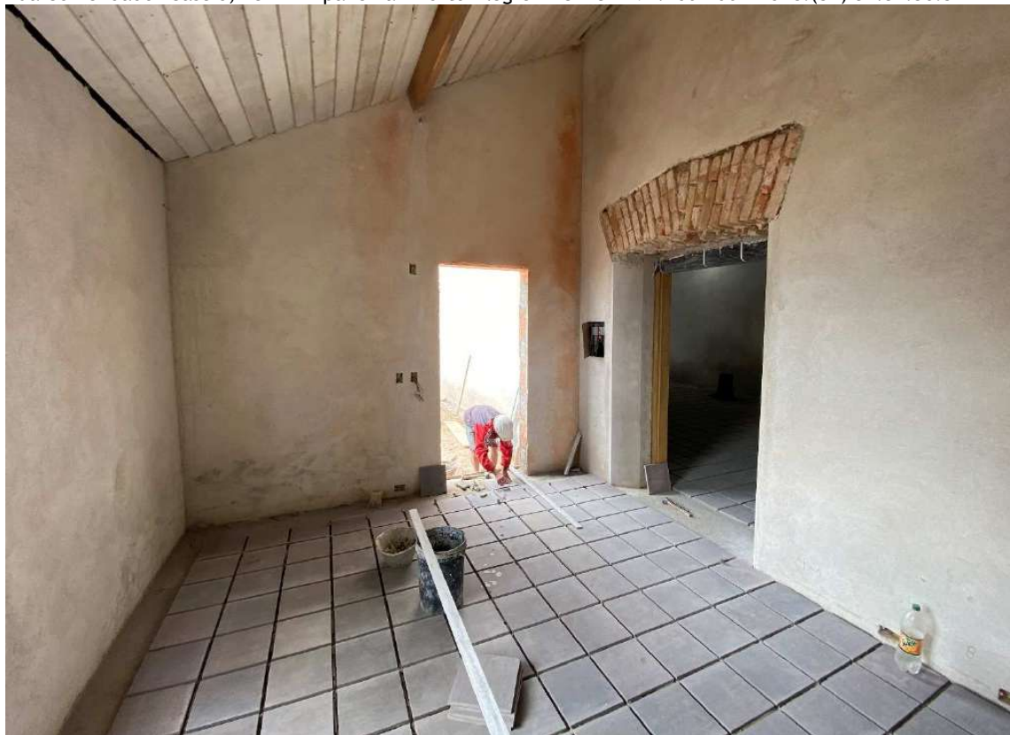
Foto 55 – Colocação de piso definitivo - basalto fosco tear. Sacristia.
