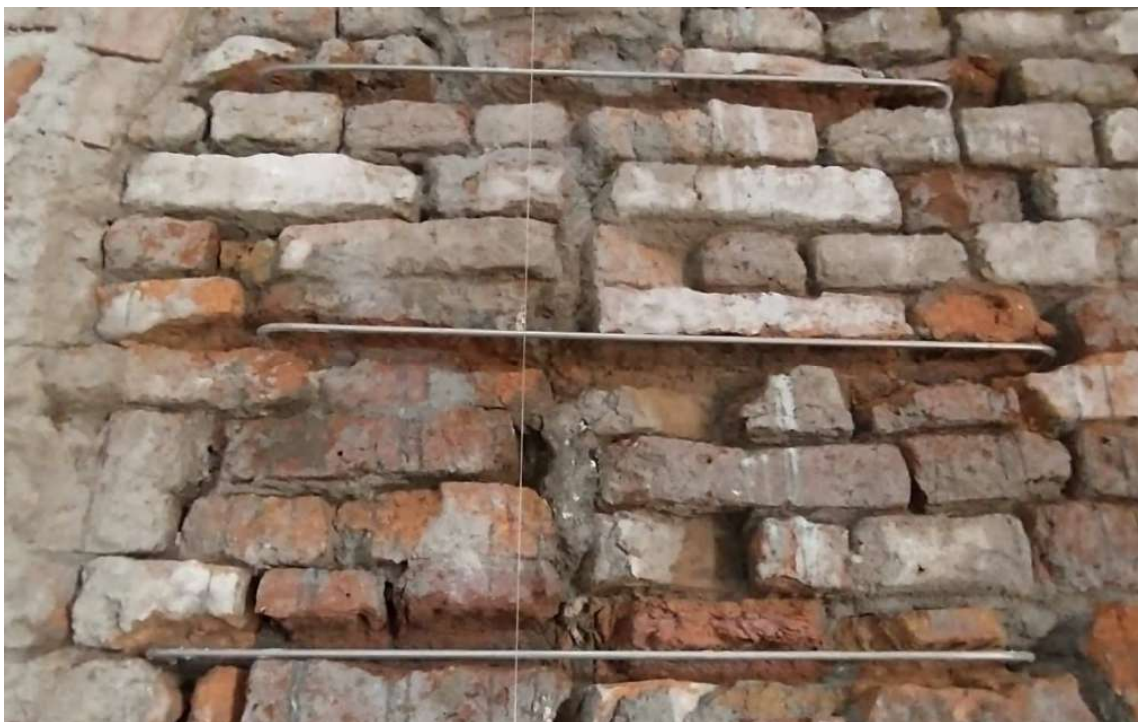
Foto 2 – Grampeamento trechos rachados com barras aço inox.
