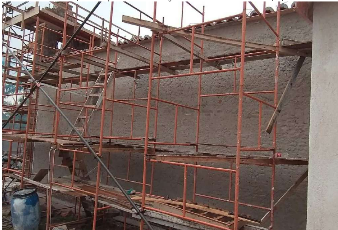
Foto 36 – Vista parede oeste da nave principal sendo revestida com argamassa cal e areia 1:3.
