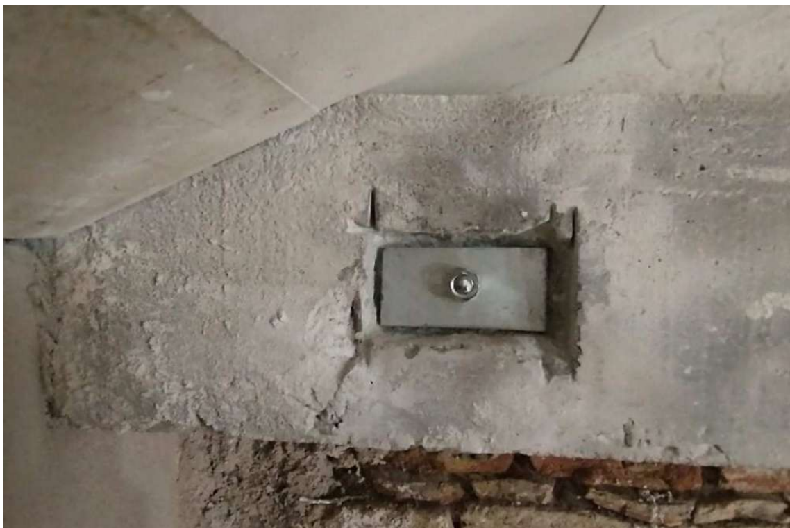
Foto 22 – Detalhe fixação da chapa metálica externa de reforço na cinta interna com barras roscadas.
