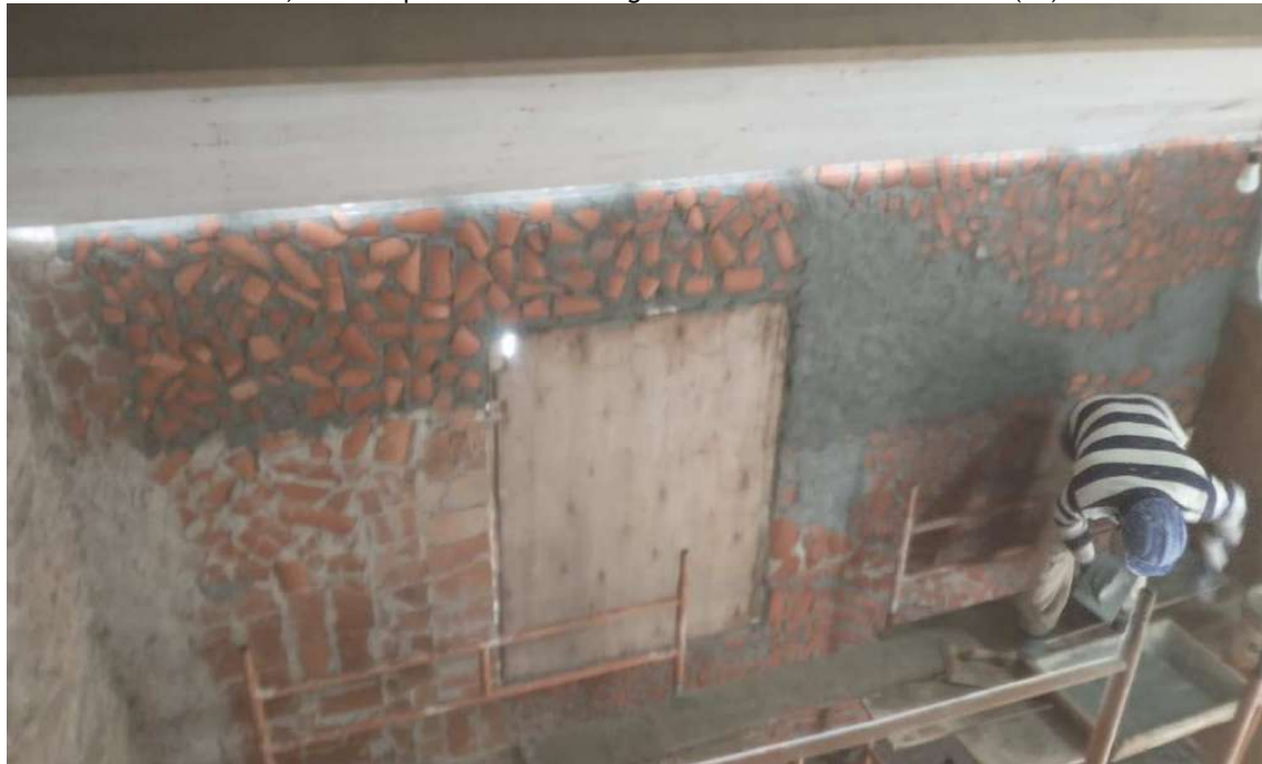
Foto 46 – Execução encasotamento da parede oeste da sacristia.
