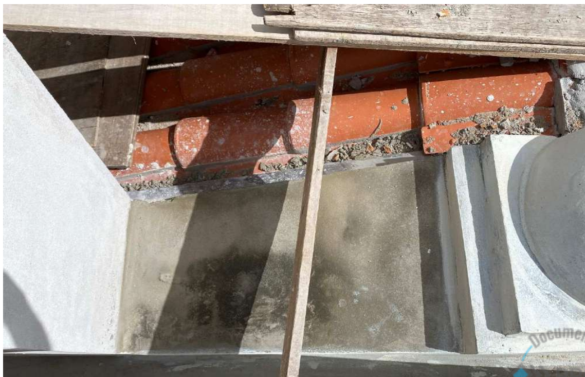
Foto 6 – Reintegração dos capeamentos com argamassa impermeabilizante e transpirável.
