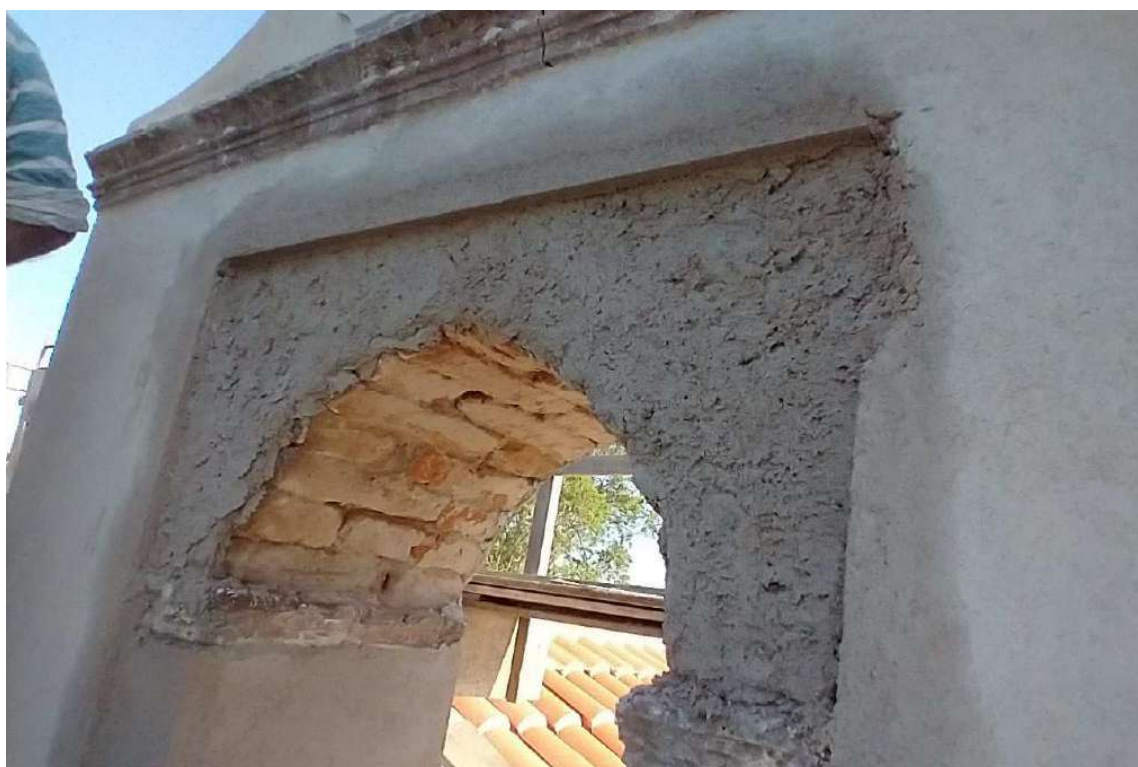
Foto 12 – Executando revestimento junto ao arco interno.
