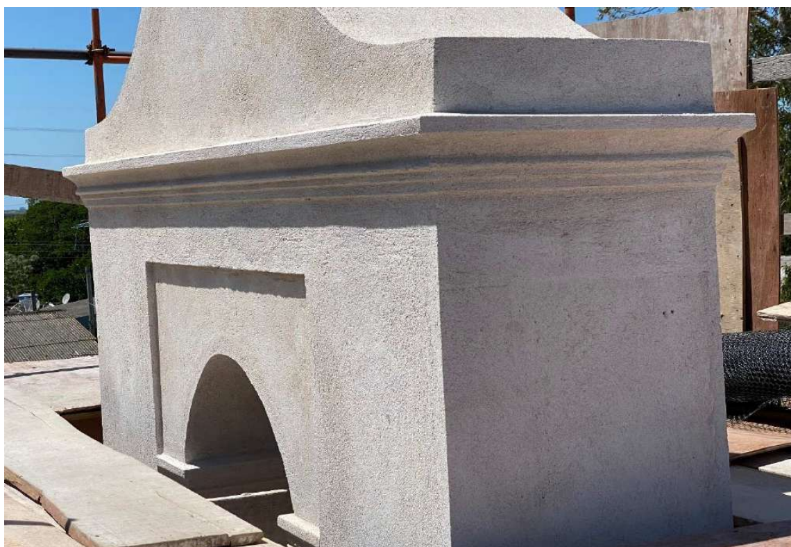
Foto 20 – Revestimento em argamassa de cal e areia 1:3.
