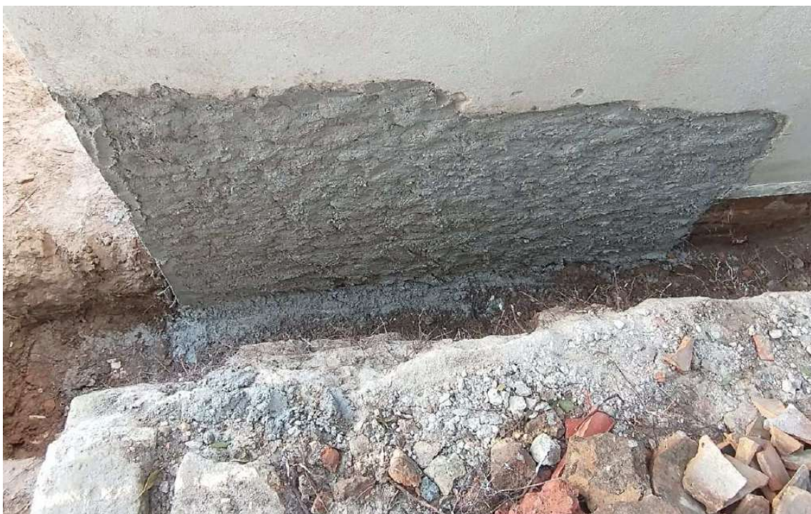
Foto 38 – Preparação da base para aplicação de argamassa transpirável.
