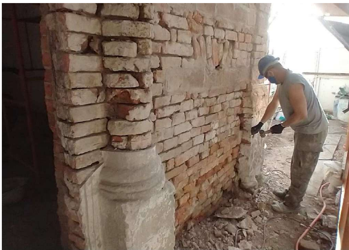
Foto 32 – Rebaixo juntas e mestras para execução panos lisos fachada.
