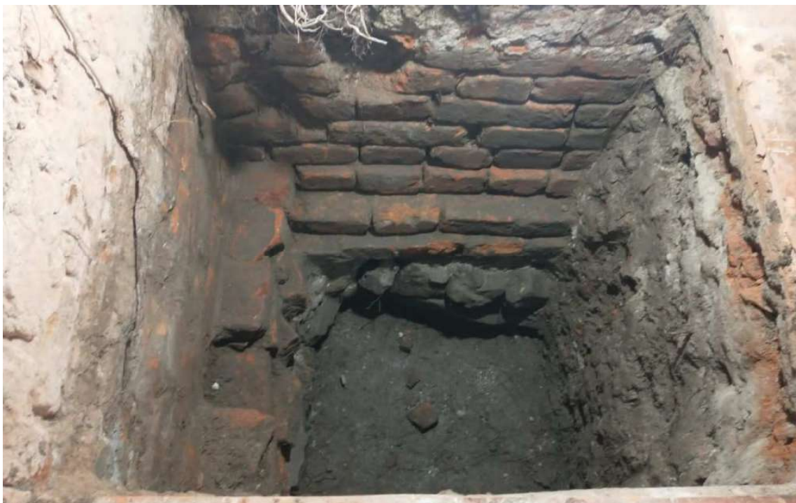
Foto 94 – Prospecção fundações da fachada principal x parede lado leste nave principal.
