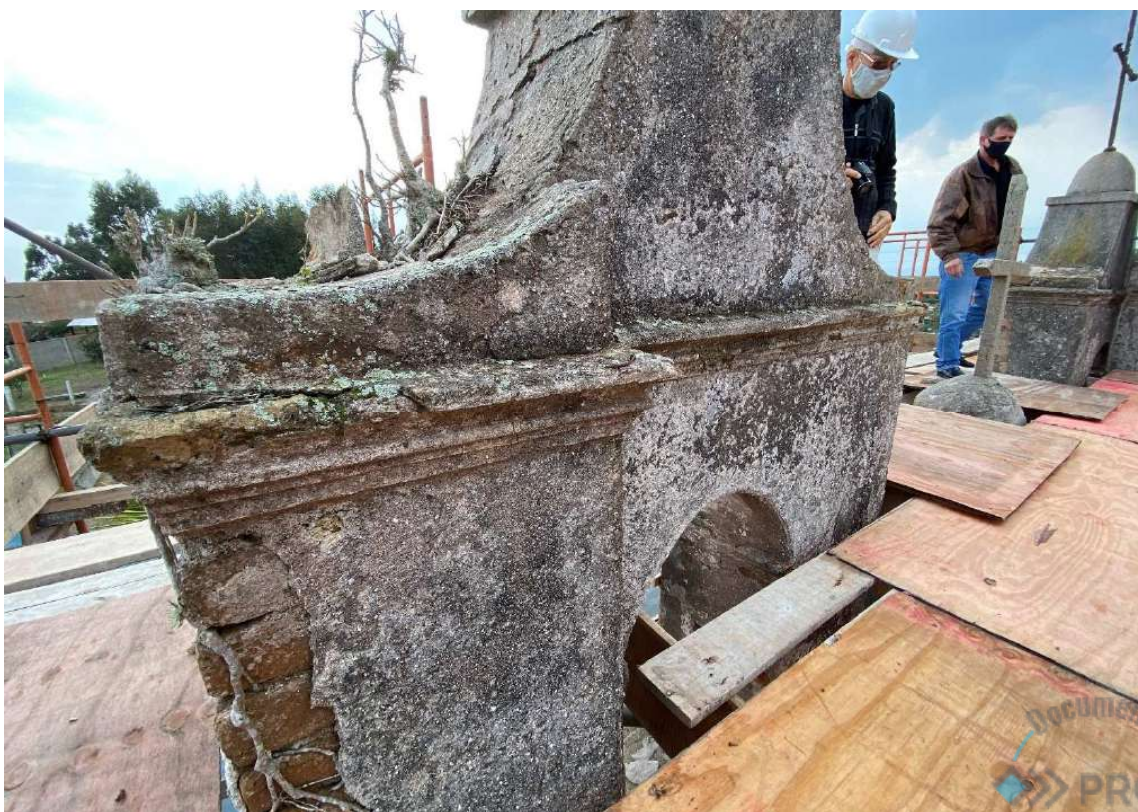
Foto 83 – Registro torre sino lado leste.
