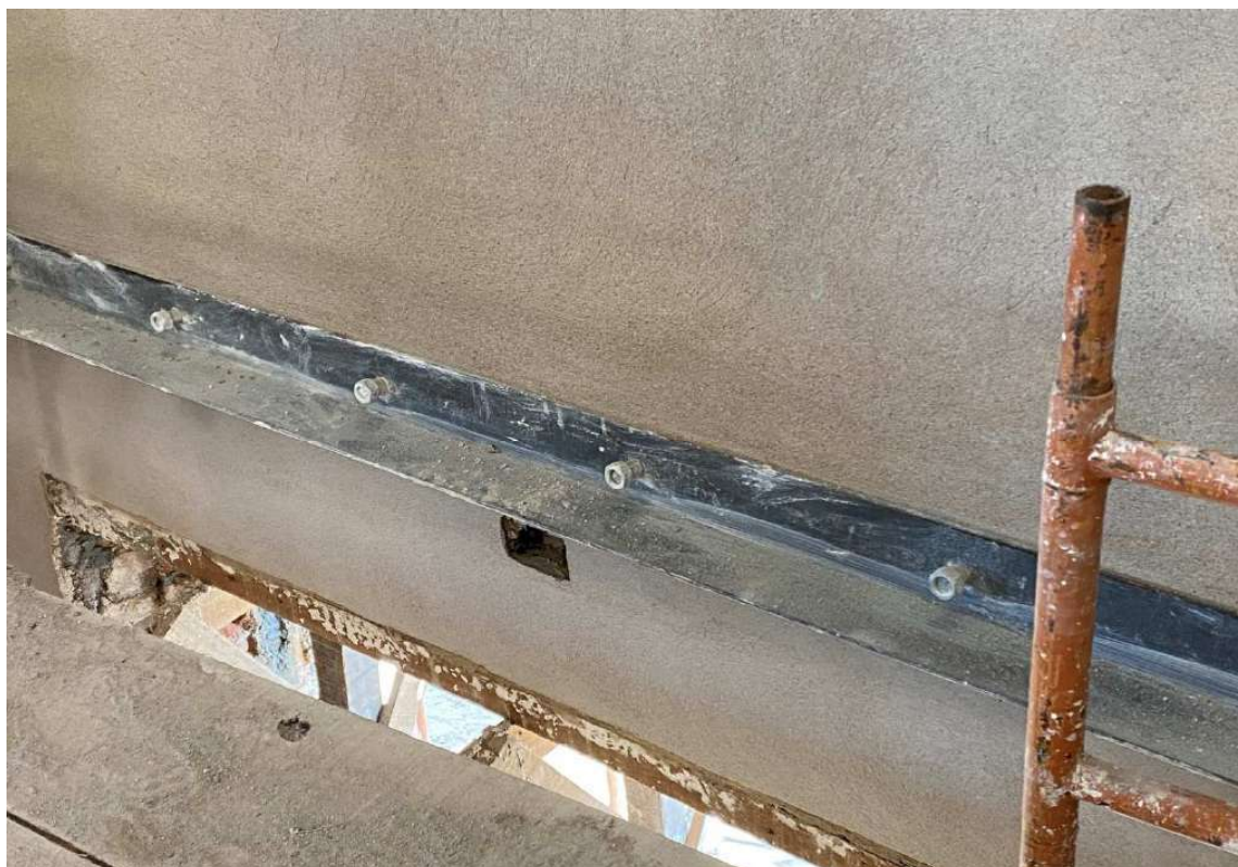
Foto 13 – Vista da cantoneira fixada na cinta e reboco concluído.
