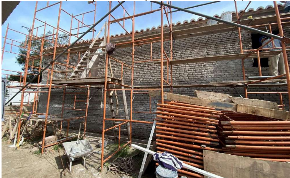
Foto 40 – Vista parede leste da nave principal sendo revestida com argamassa cal e areia 1:3.
