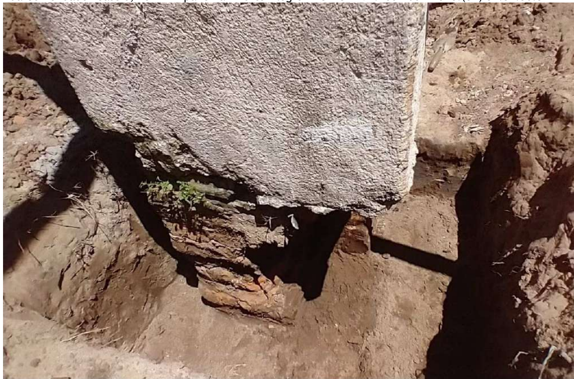
Foto 99 – Escavação para inserção de sapatas de concreto na base do muro.
