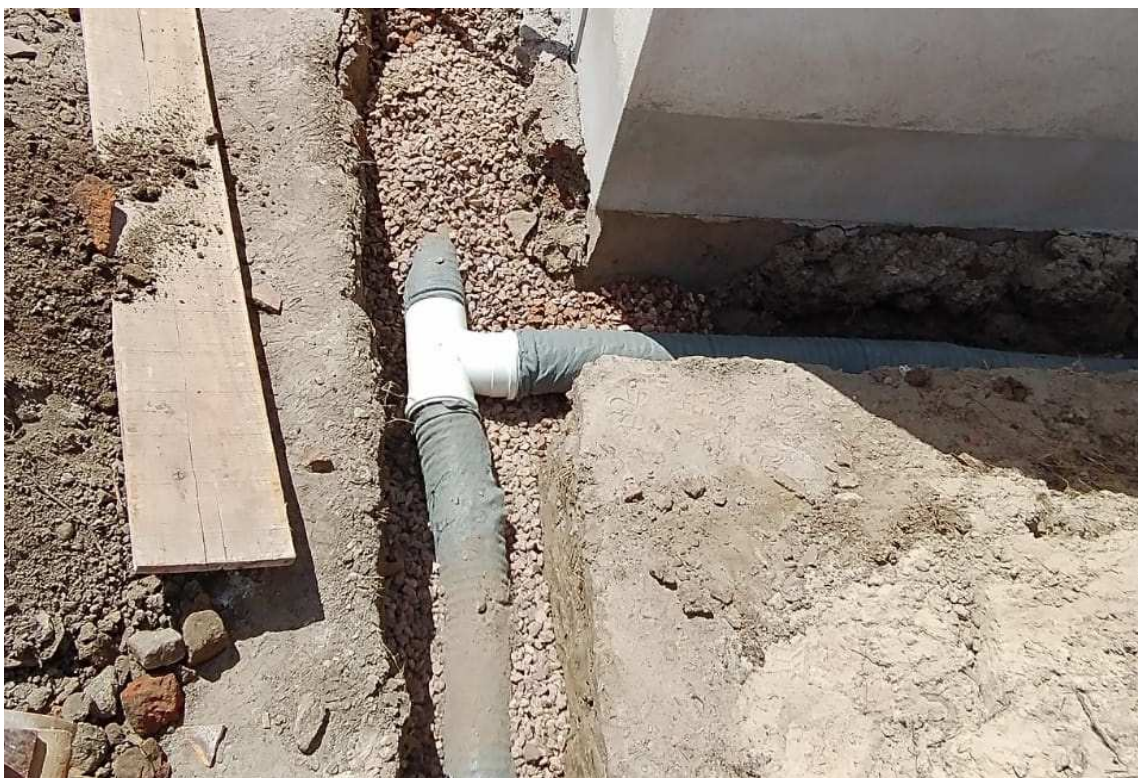
Foto 87 – Execução rede drenagem perímetro da Capela.
