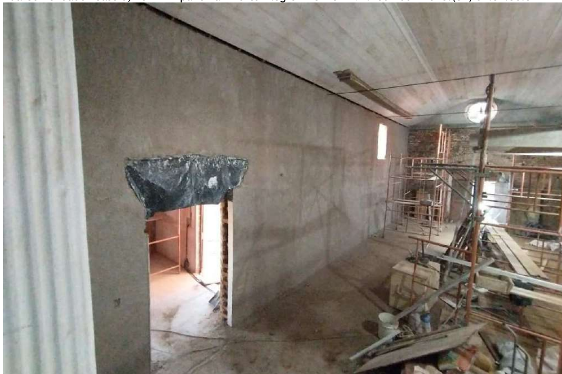
Foto 53 – Execução reboco paredes internas.
