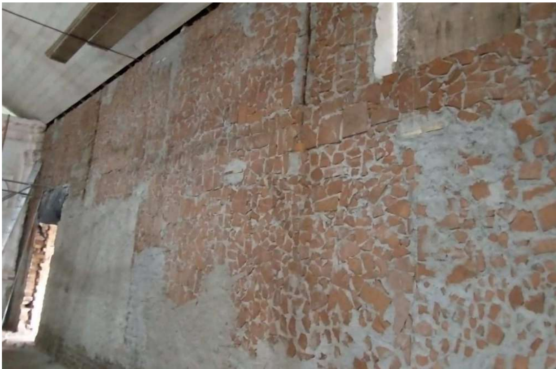
Foto 49 – Encascotamento parede interna.
