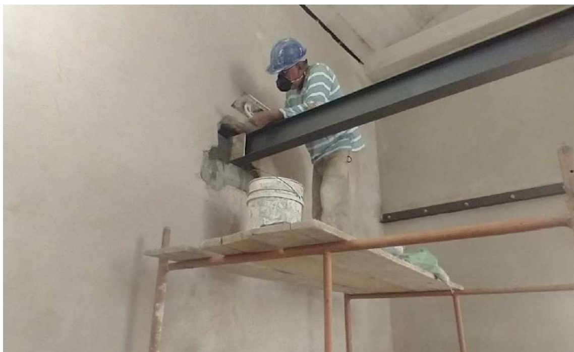
Foto 92 – Execução arremates apoio da estrutura metálica coro
