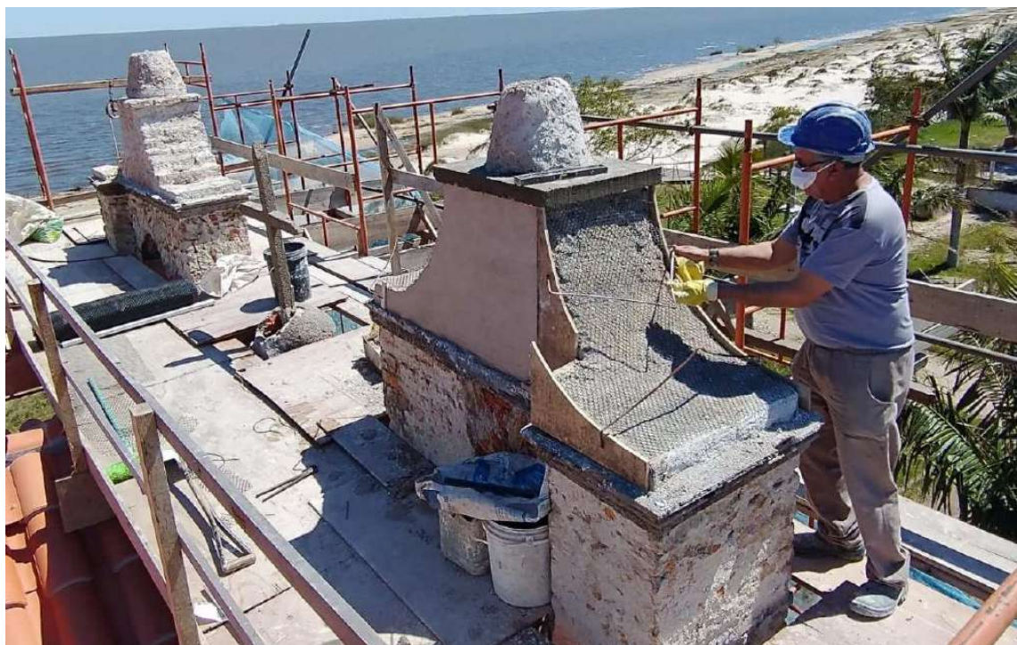
Foto 74 – Revestimentos em argamassa de cal e areia 1:3.
