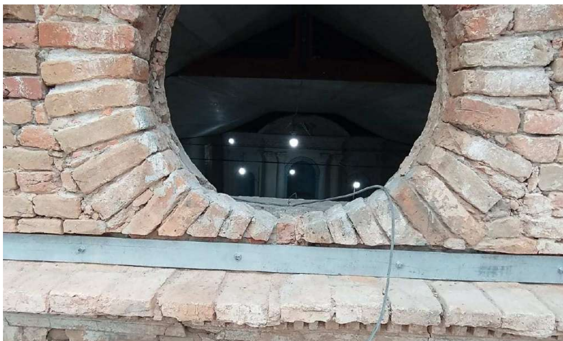
Foto 32- Detalhe da chapa metálica 4" instalada na base do óculo.
