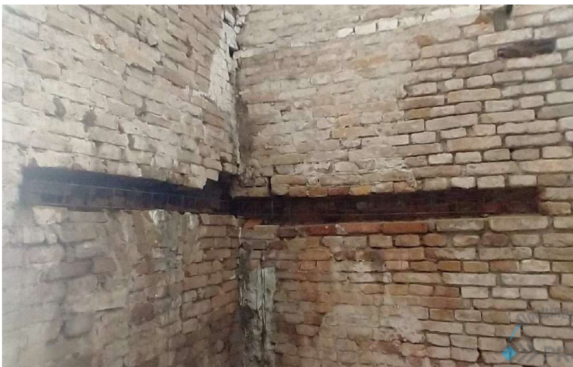
Foto 14 - Reforços estruturais internos, parede fachada principal x parede lado leste nave principal.
