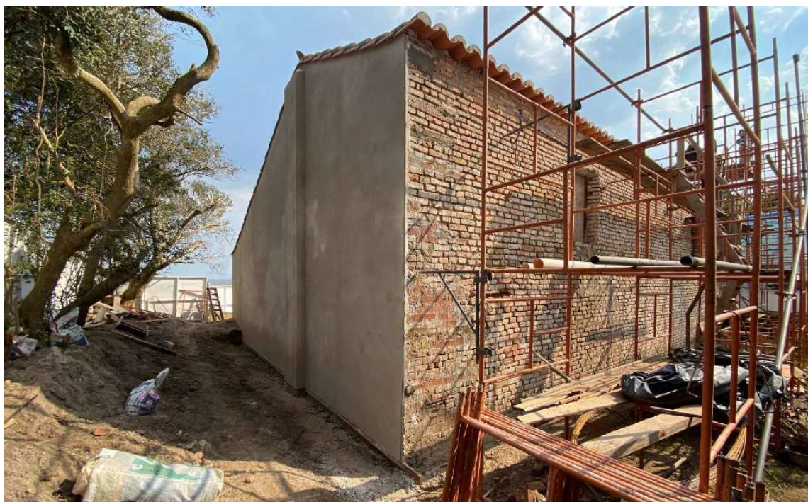
Foto 28 – Vista parede sul, concluído o revestimento em cal e areia 1:3.
