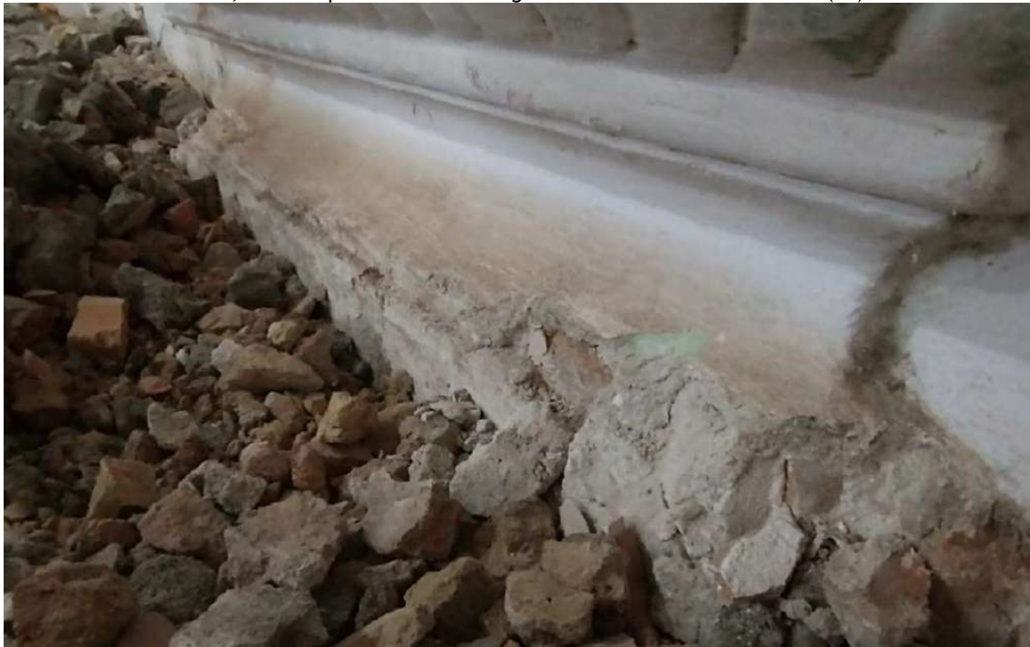
Foto 55 – Demolição piso e contrapiso existente para executar contrapiso na nave principal, note-se que o nível do piso demolido estava tapando o rodapé do altar mor.
