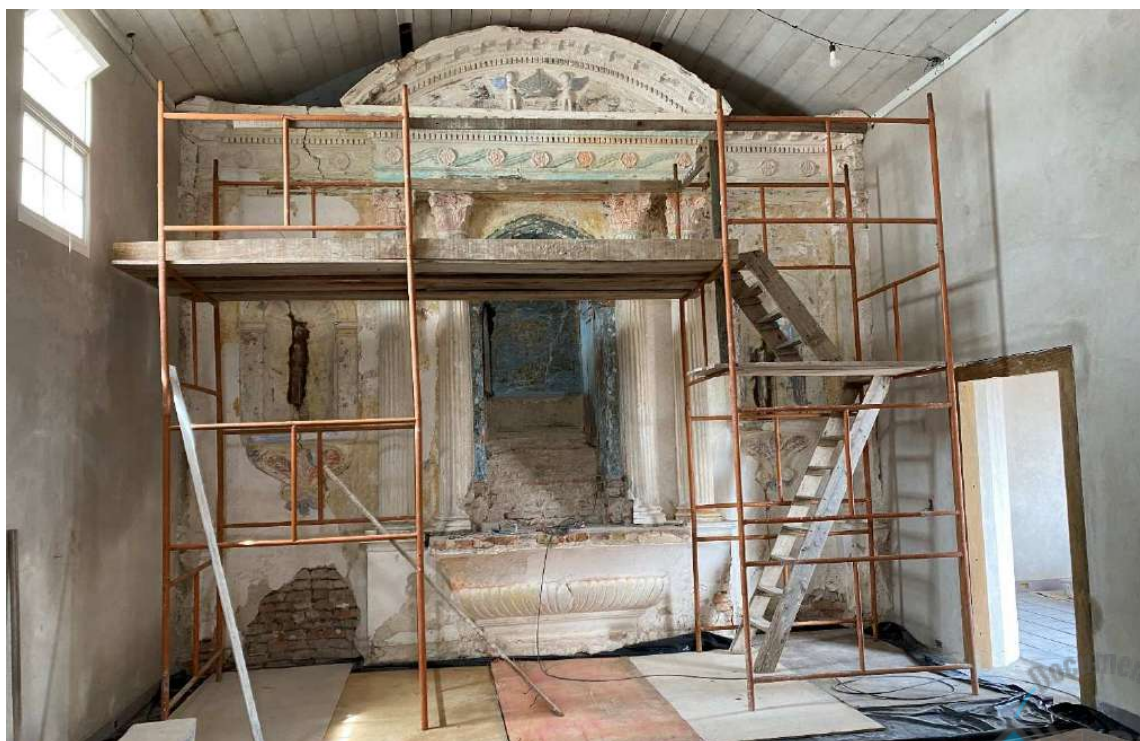
Foto 80 –Estrutura andaimes e plataformas para serviços restauro do altar mor.
