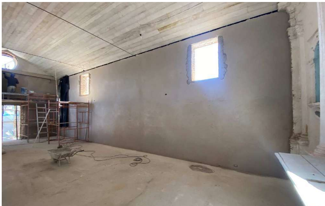
Foto 56 – Execução reboco paredes internas.
