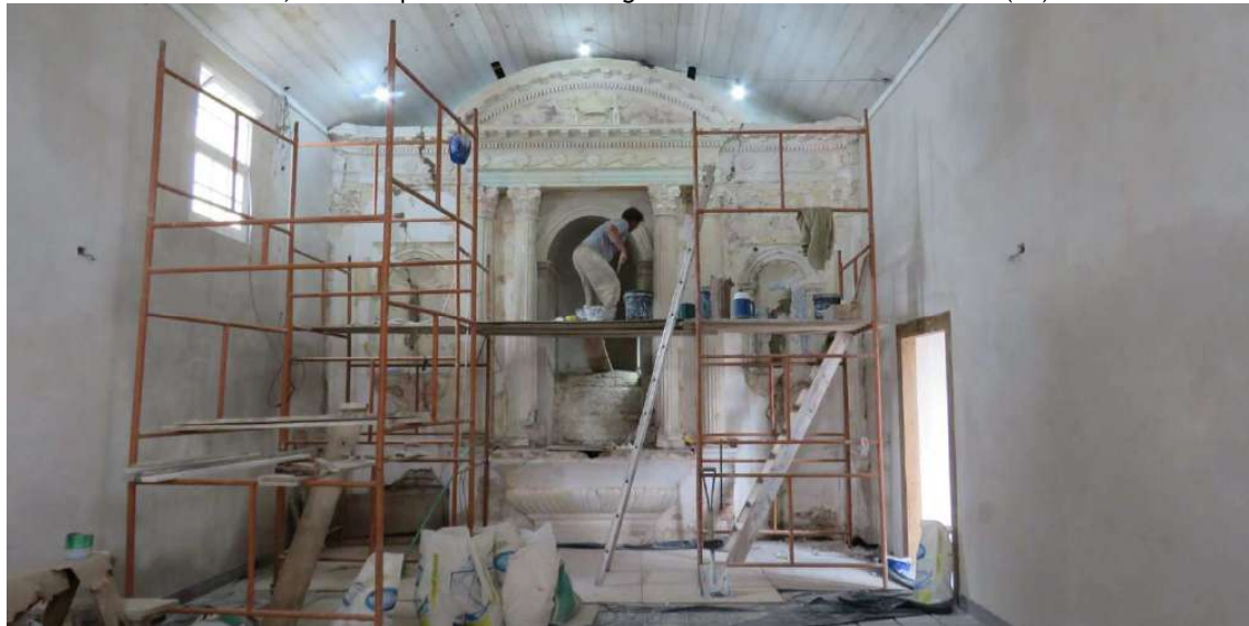
Foto 81 – Execução restauro ornamentos do altar mor.
