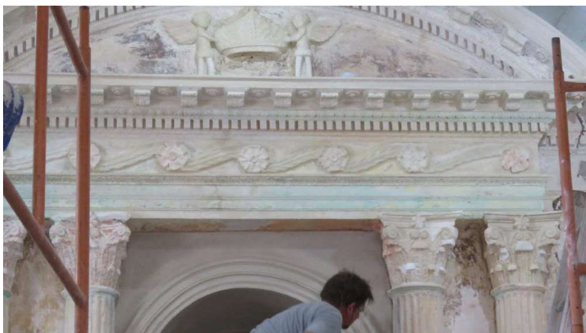
Foto 88 – Restauro dos ormanetos, frisos, molduras, e capitéis do altar mor.
