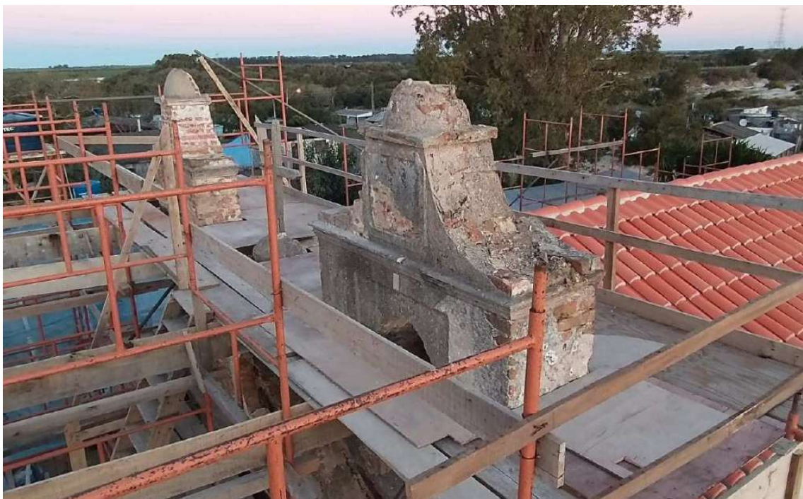
Foto 71 – Remoção dos revestimentos das torres.
