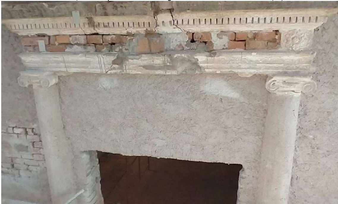
Foto 39 – Revestindo as colunas com argamassa de cal e areia 1:3.
