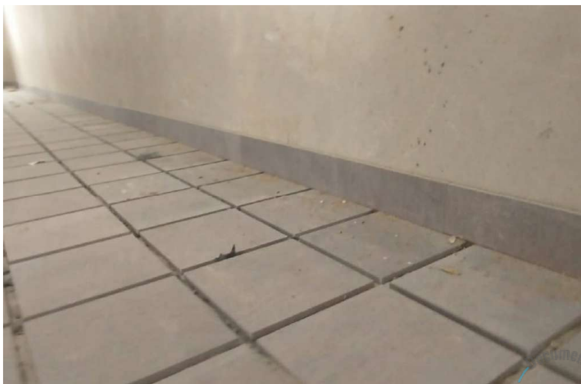
Foto 52 – Colocação de piso definitivo e rodapés - basalto fosco tear. Nave principal.
