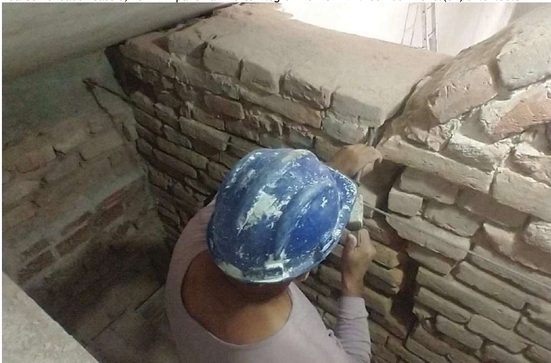
Foto 78 – Execução de reforços e grauteamento parede altar mor, parte de trás.
