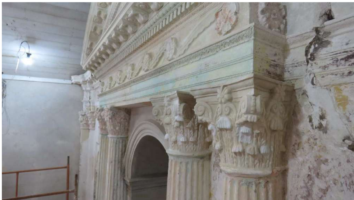
Foto 87 – Restauro dos ormanetos, capitéis do altar mor.
