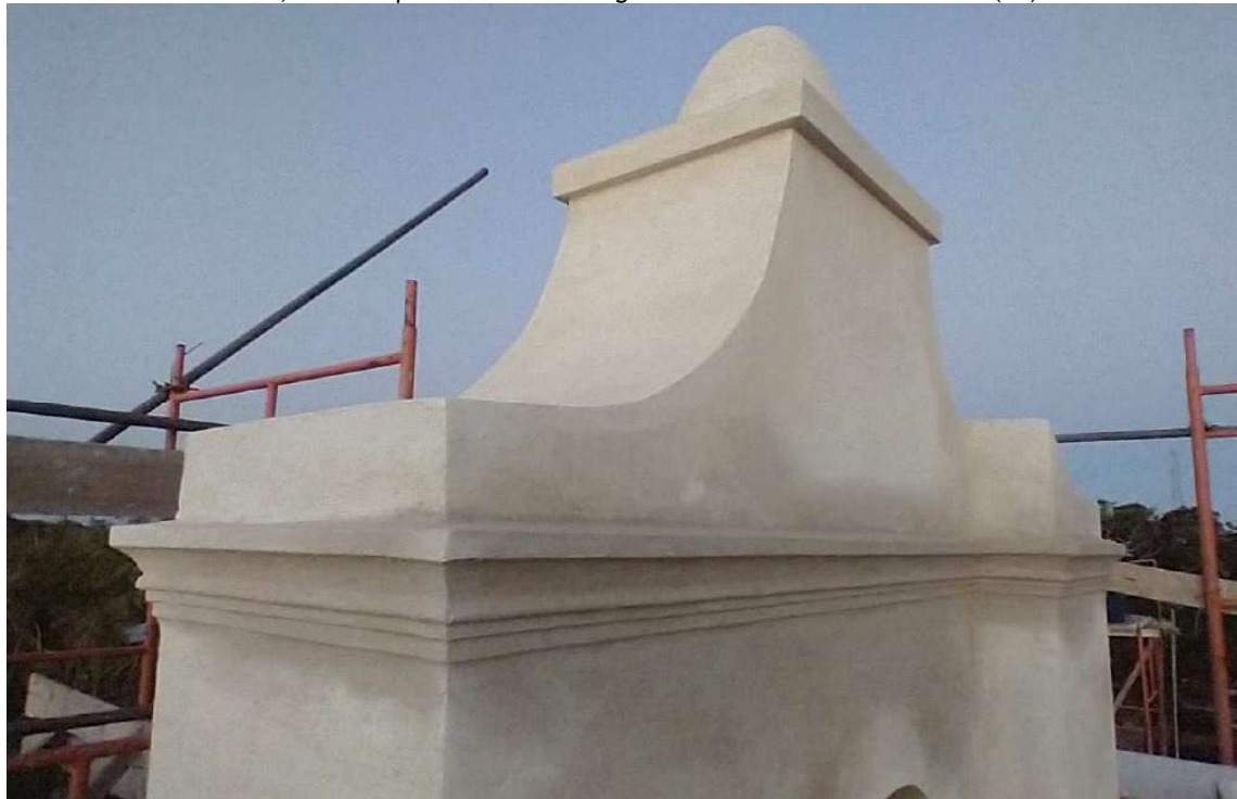
Foto 19 – Revestimento em argamassa de cal e areia 1:3.
