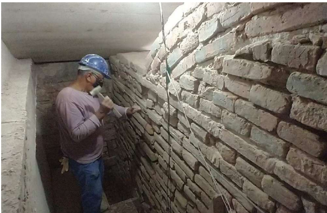
Foto 79 – Execução de reforços e grauteamento parede altar mor, parte de trás.
