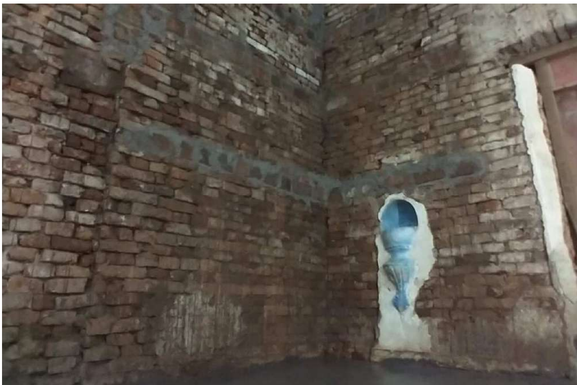
Foto 13 - Reforços estruturais internos, parede fachada principal x parede lado oeste nave principal.
