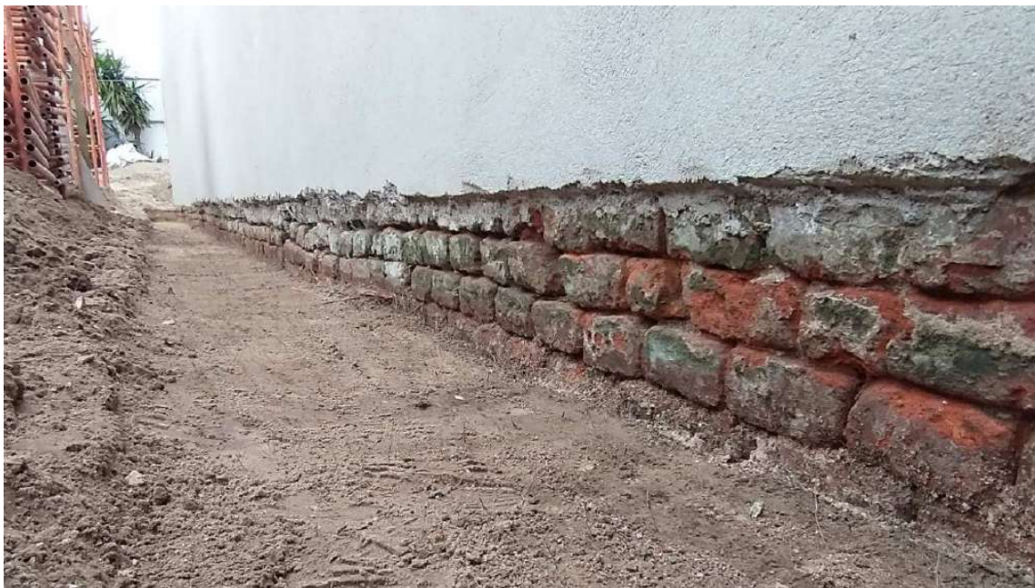
Foto 34 – Preparação da base para aplicação de argamassa transpirável.
