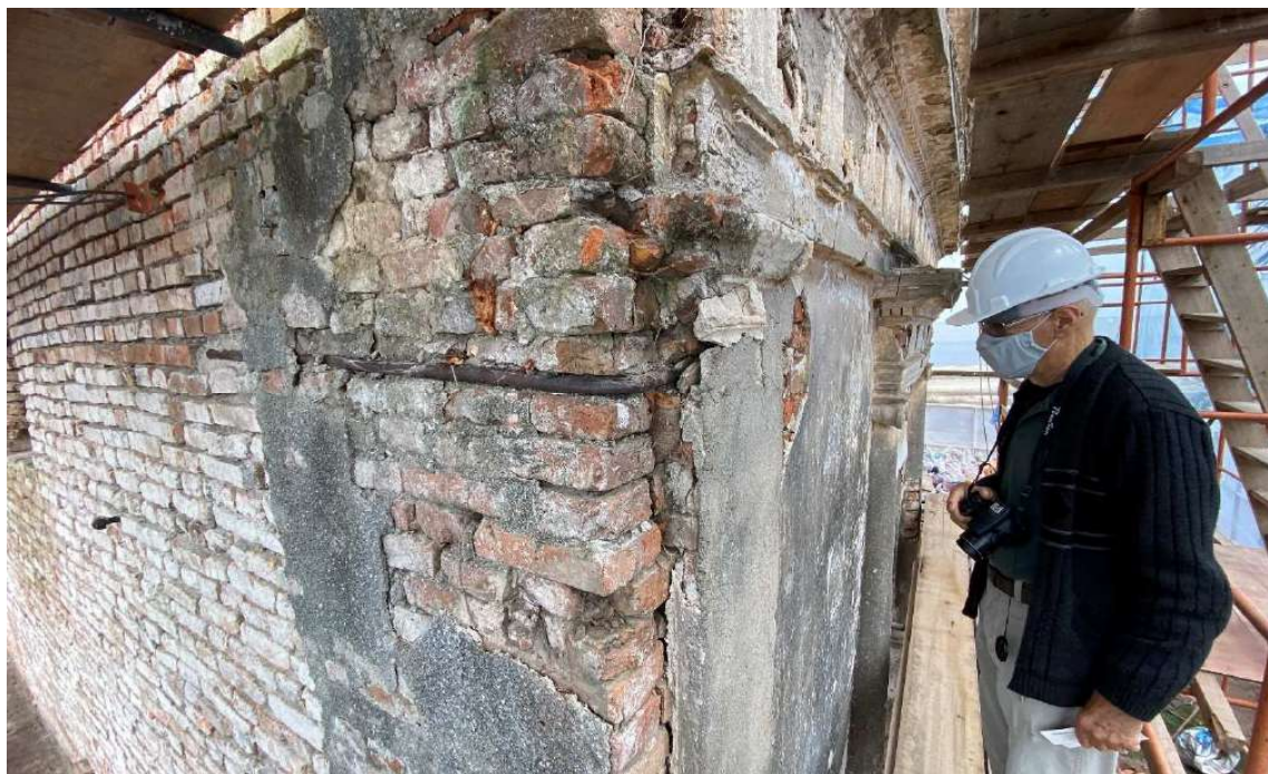
Foto 88 – Arq Edegar verificando estado do antigo ferro de amarração.
