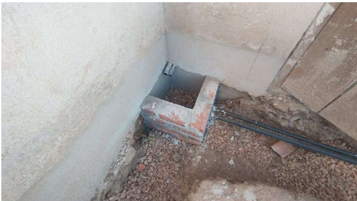
Foto 41 – Caixas de passagem e eletrodutos rede alimentação.
