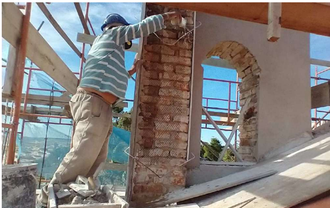
Foto 4 – Revestimento em argamassa de cal e areia 1:3.
