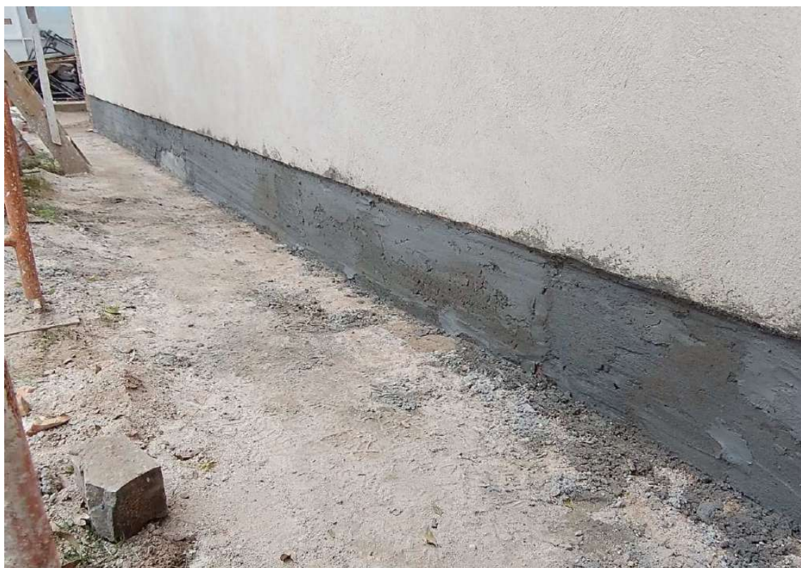
Foto 36 - Preparação da base para aplicação de argamassa transpirável.
