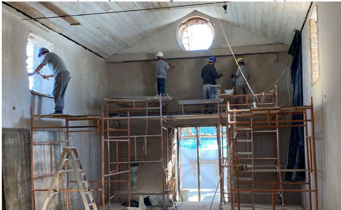
Foto 57 – Execução reboco paredes internas e ajuste vão janelas.
