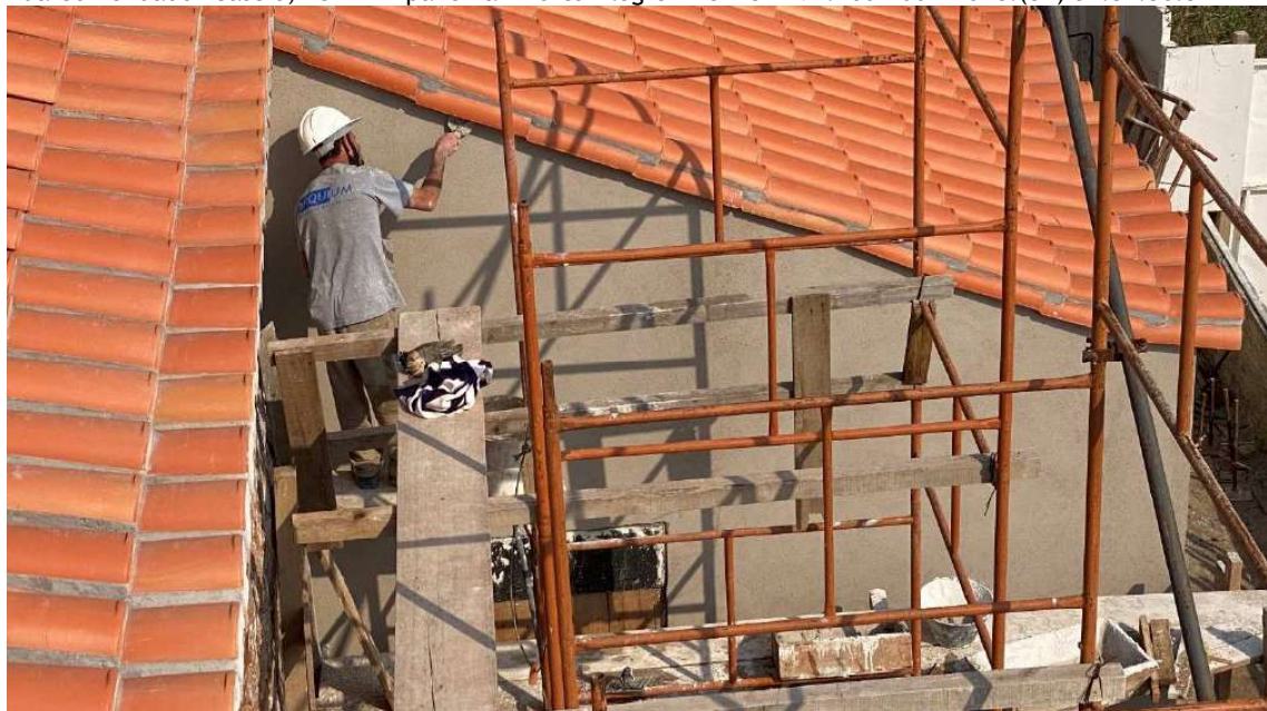
Foto 34 – Vista parede norte da sacristia sendo revestida com argamassa cal e areia 1:3.
