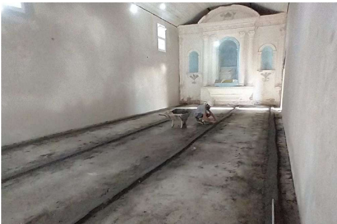
Foto 52 – Mestras para base em cimento e areia.
