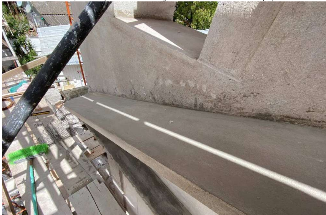
Foto 3 – Reintegração dos capeamentos com argamassa impermeabilizante e transpirável.
