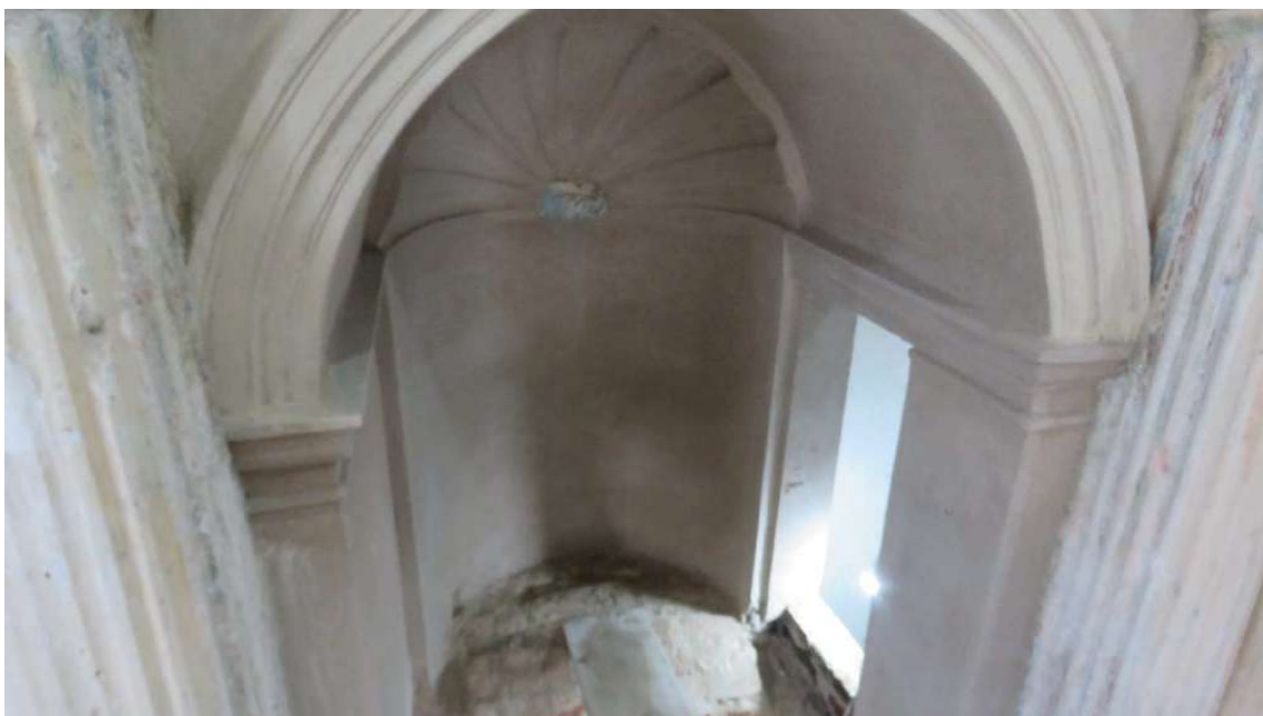
Foto 84 – Restauro de frisos, molduras e ornamentos altar mor.
