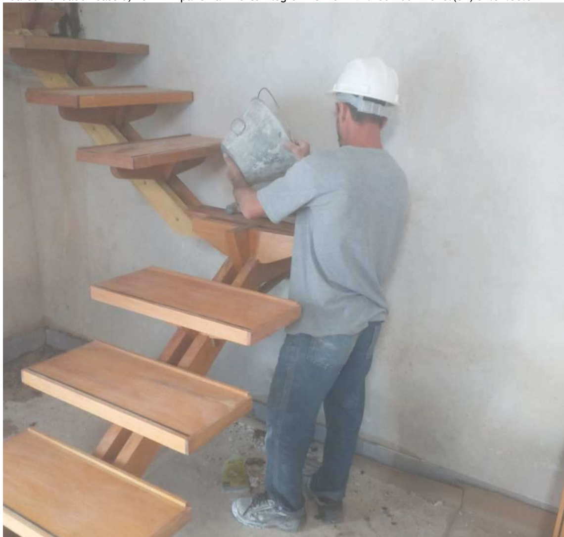
Foto 93 – Instalação da escada acesso ao coro.
