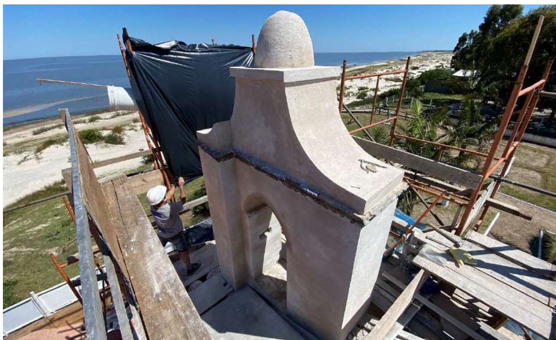
Foto 8 – Revestimento em argamassa de cal e areia 1:3.
