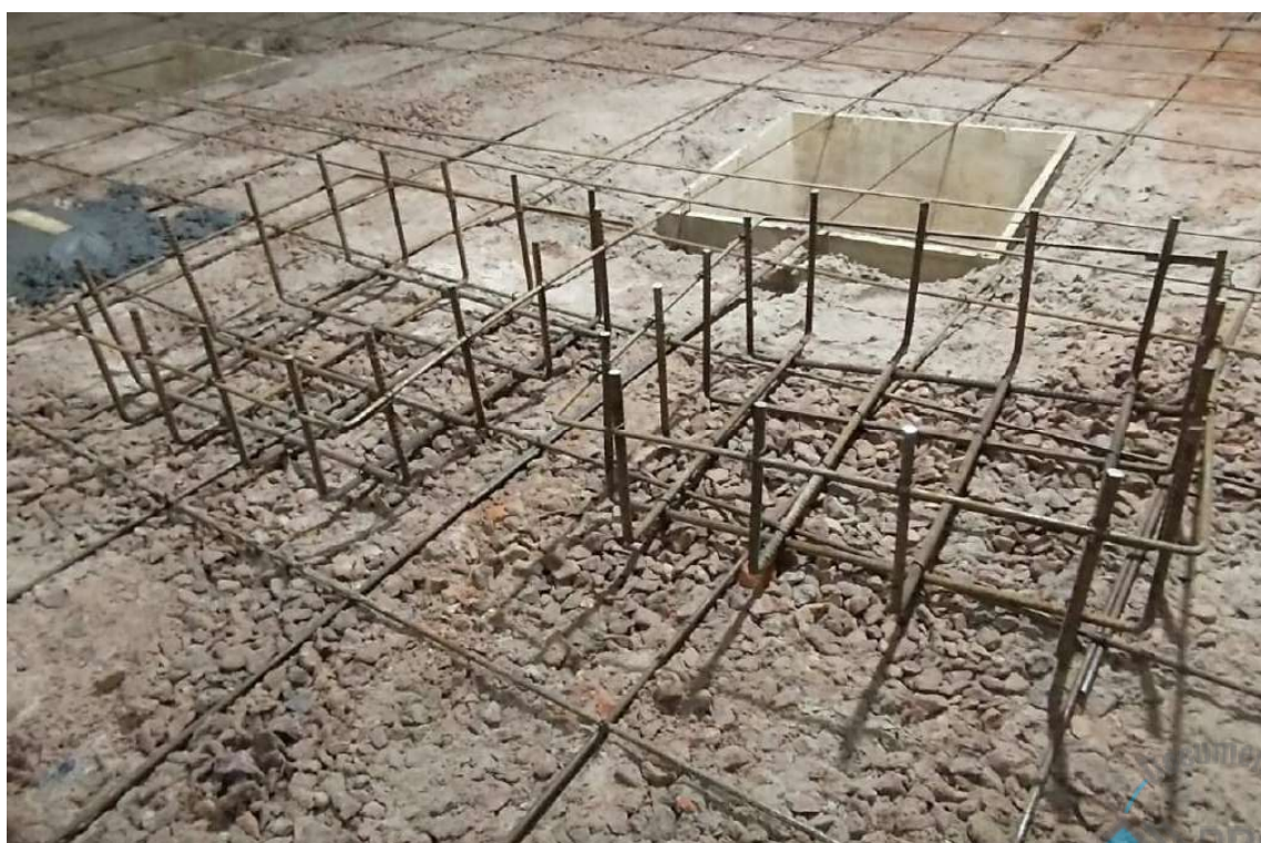
Foto 60 – Armaduras sapatas base dos pilares do mezanino.
