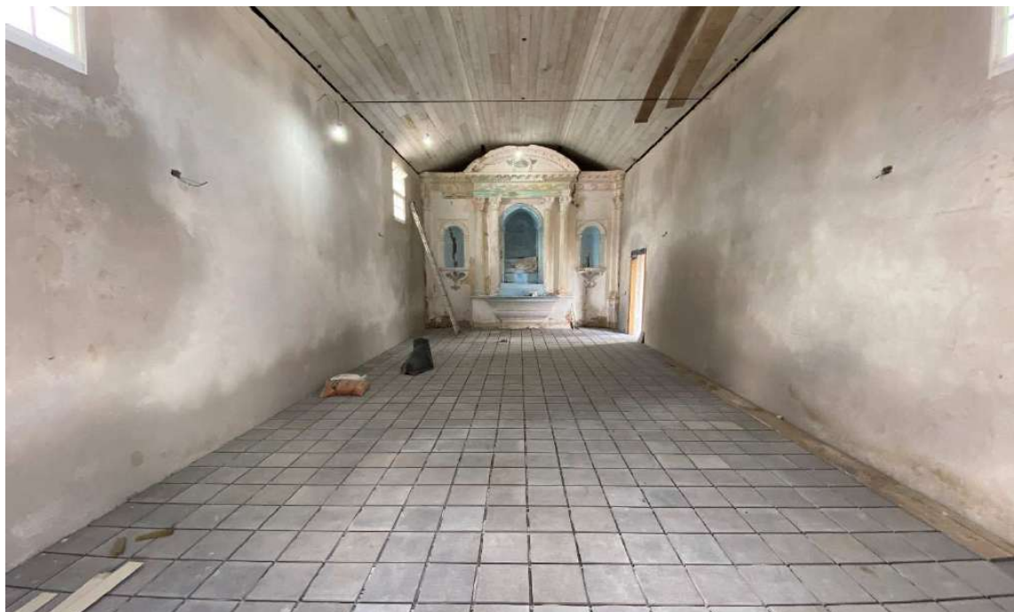
Foto 49 - Colocação piso definitivo – basalto fosco tear. Nave principal.
