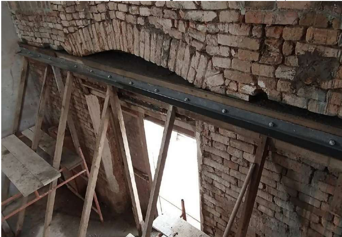
Foto 8 – Escoramento da forma da cinta e cantoneira. Cantoneira fixada com peças de barra rosca.
