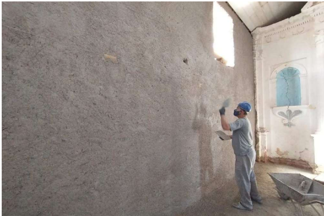
Foto 54 – Execução reboco paredes internas.
