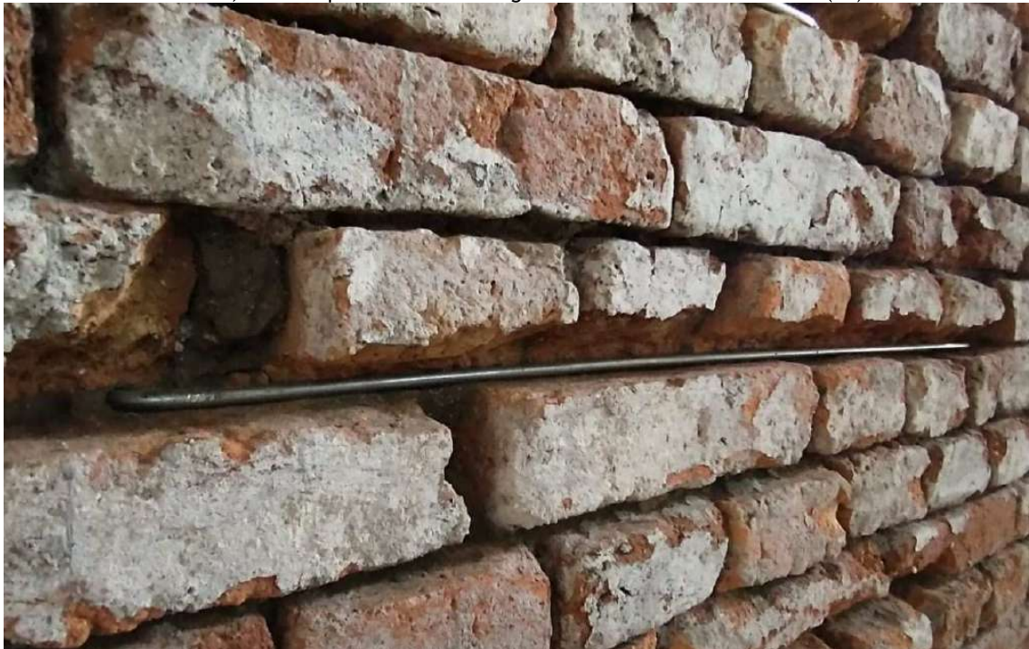
Foto 3 – Grampeamento trechos rachados com barras aço inox.
