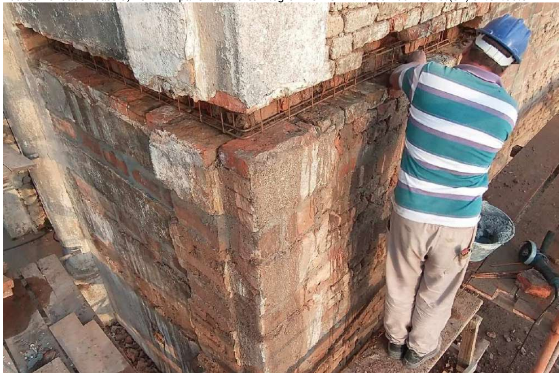
Foto 2 –Reforços no canto entre a parede fachada principal e parede oeste, amarração.
