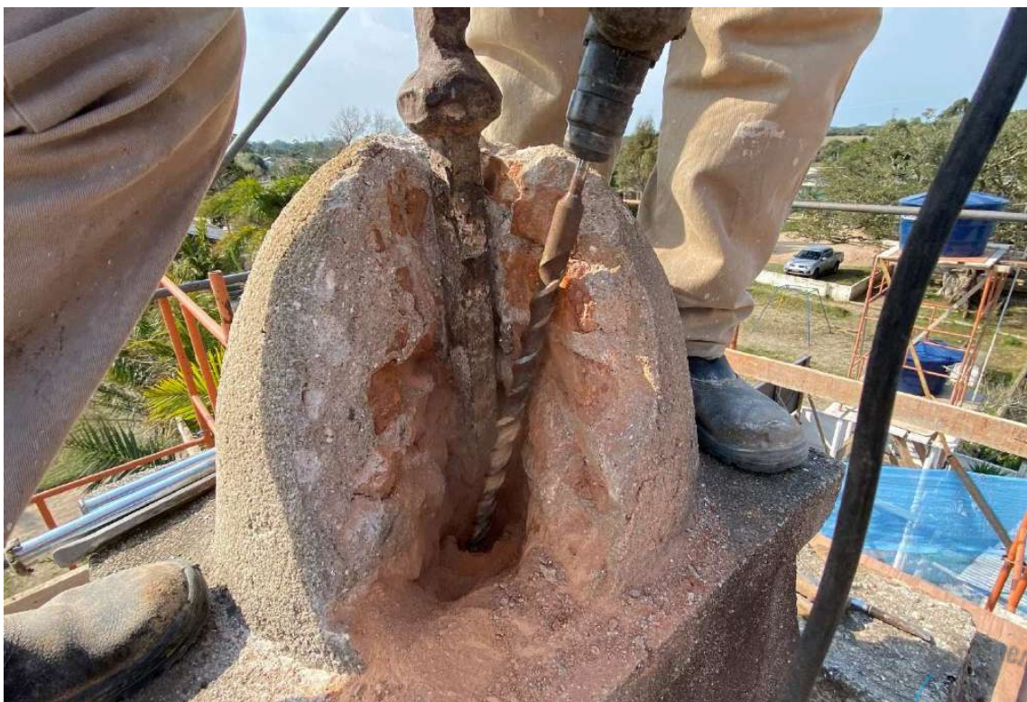
Foto 85 – Remoção da cruz ala leste, detalhe do ancoramento.
