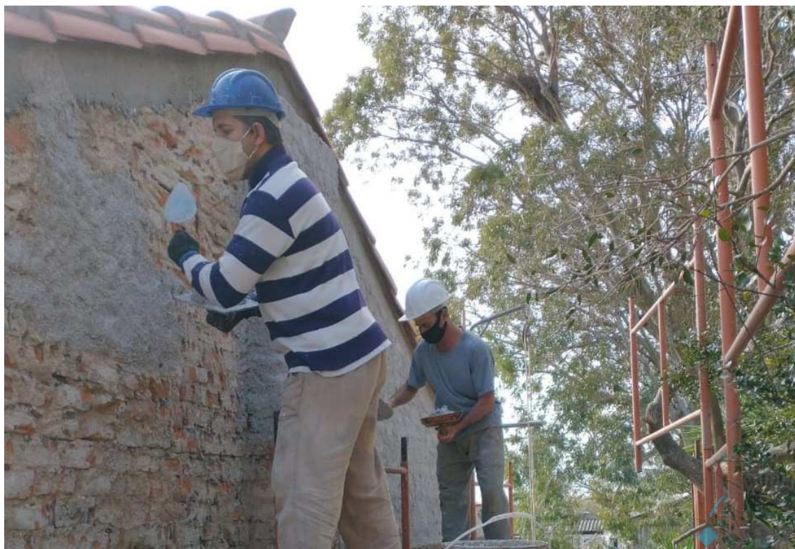
Foto 22 – Executando base para o encascotamento.
