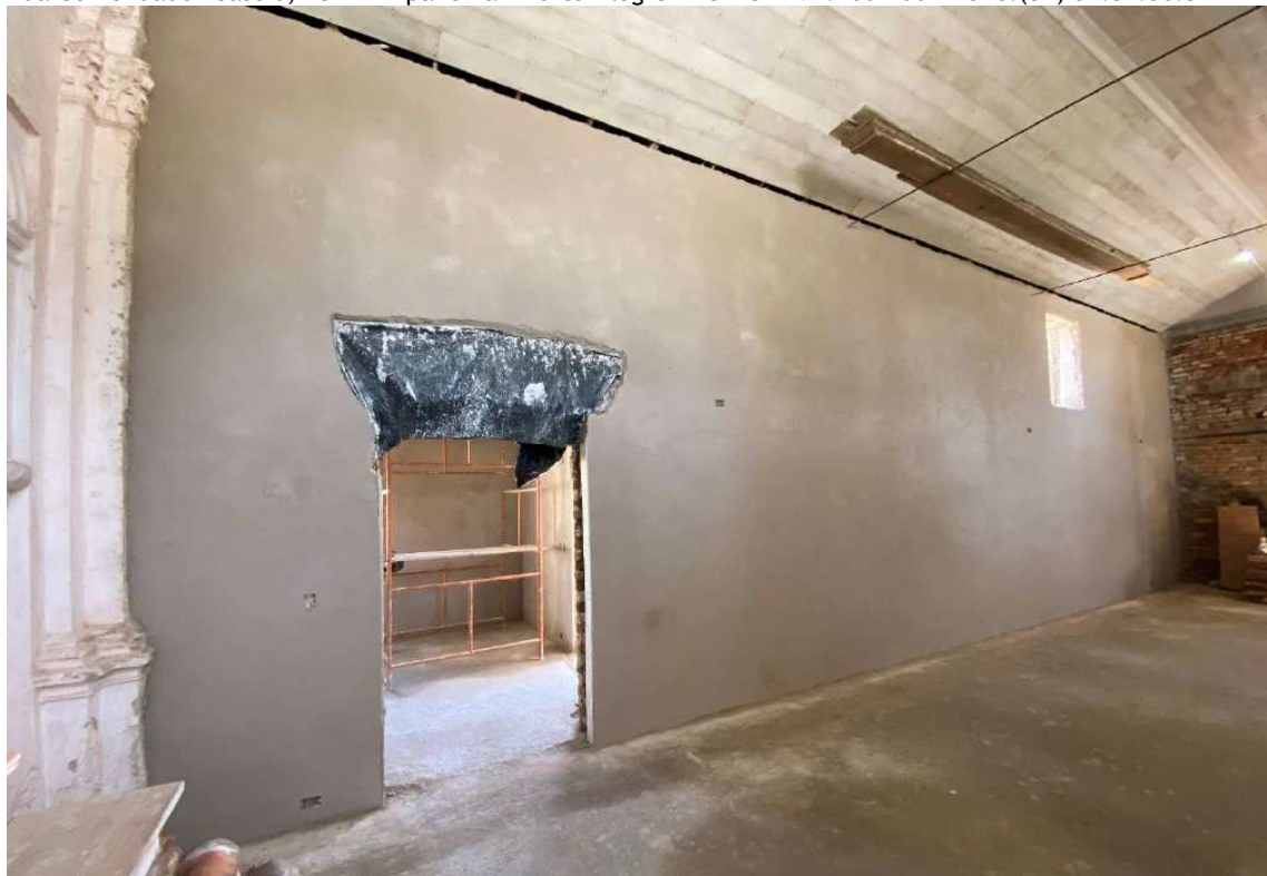
Foto 55 – Execução reboco paredes internas.
