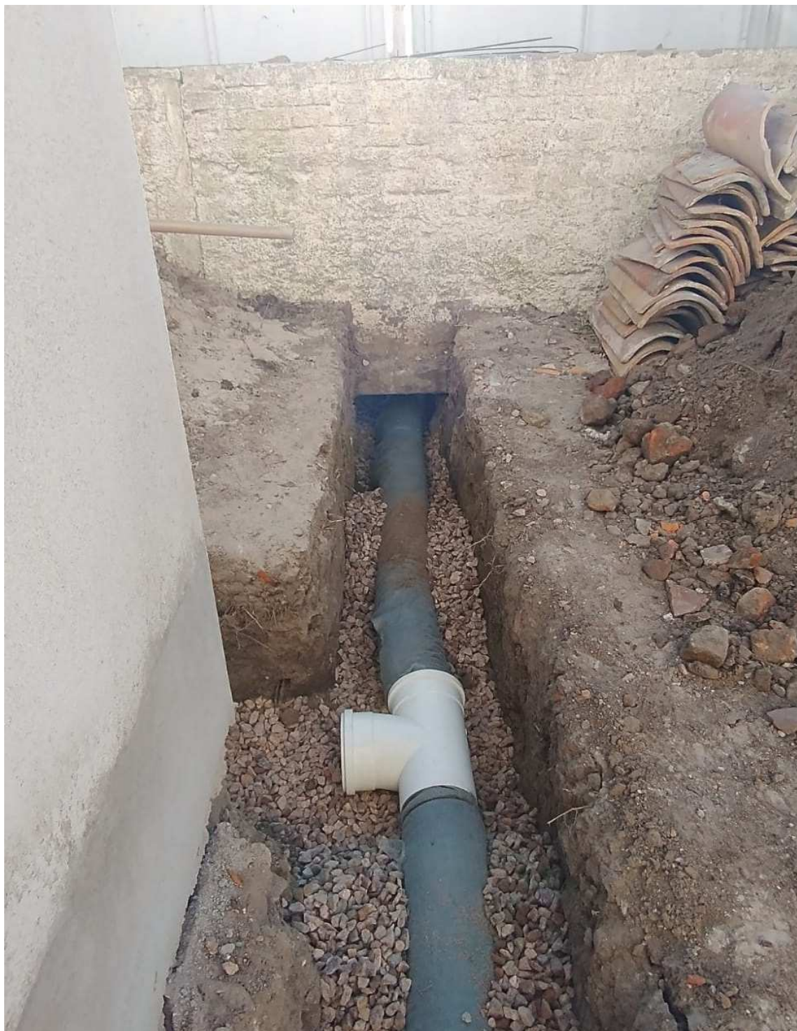
Foto 88 – Execução rede drenagem perímetro da Capela.
