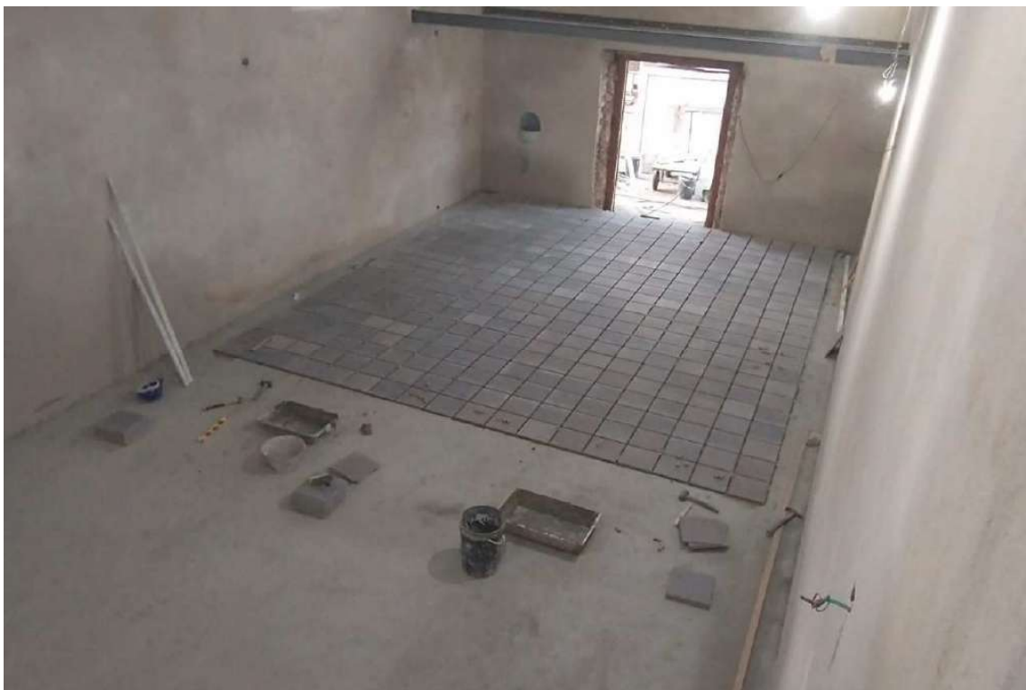
Foto 60 – Colocação de piso definitivo.
