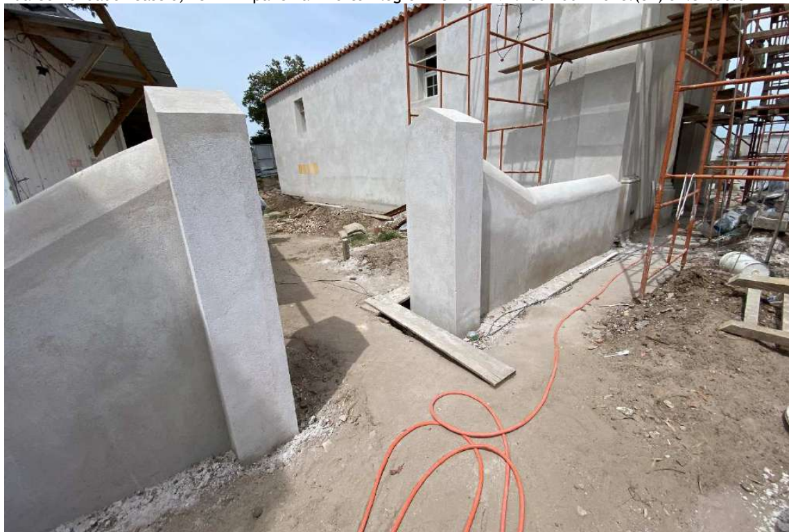
Foto 47 – Revestimento em cal e areia 1:3.
