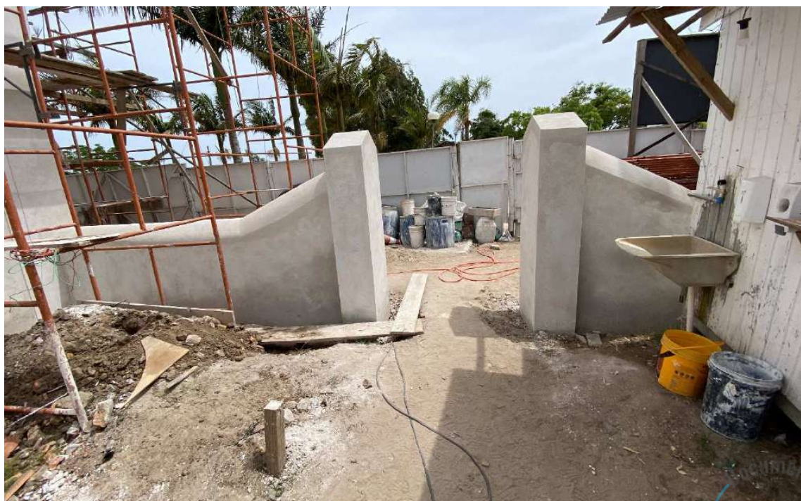
Foto 48 – Revestimento em cal e areia 1:3.
