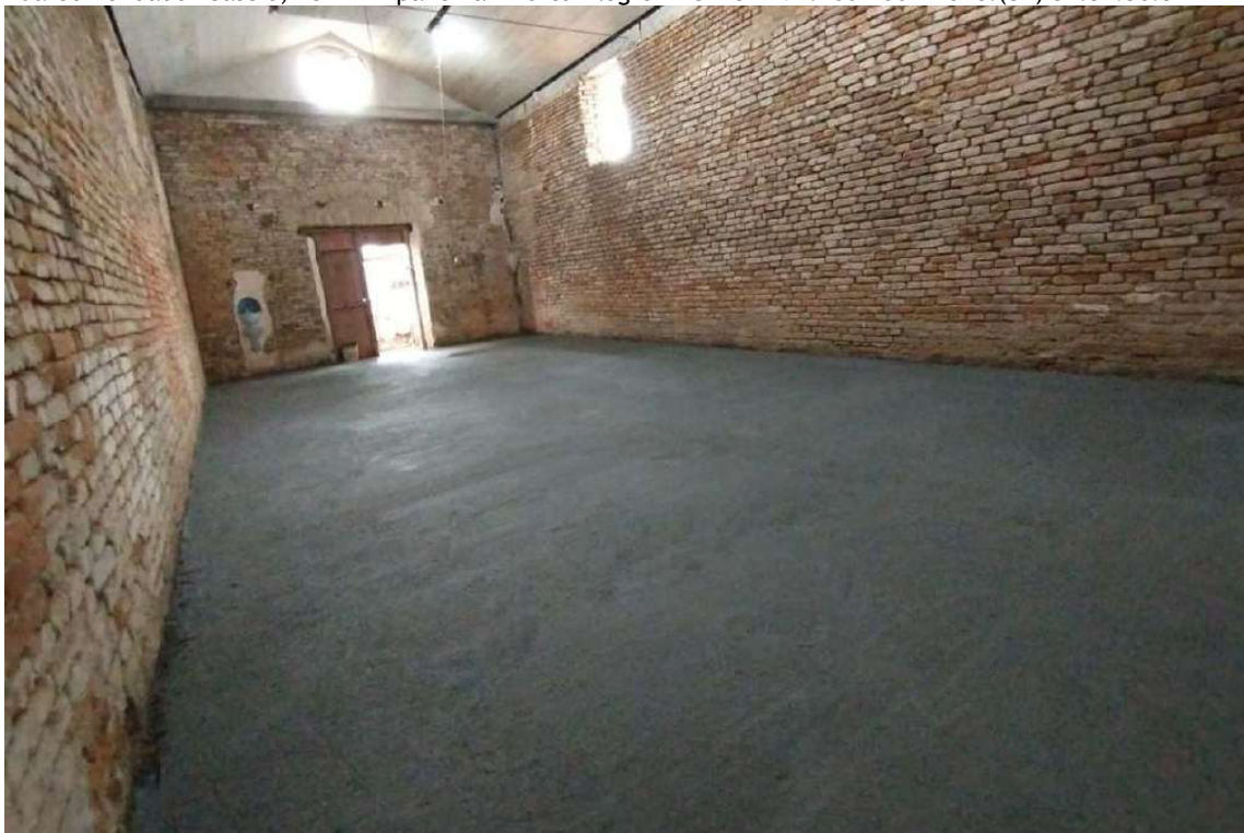
Foto 63 – Contrapiso da nave principal.
