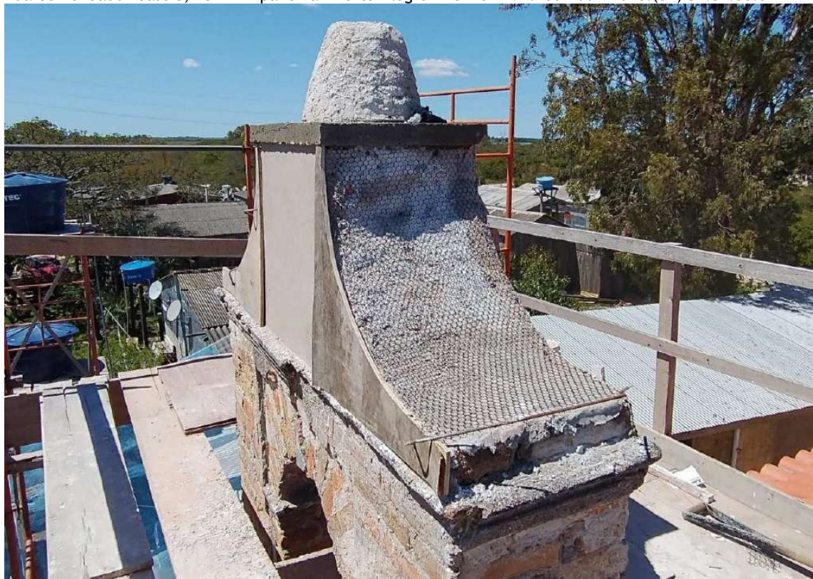
Foto 73 – Revestimentos em argamassa de cal e areia 1:3.
