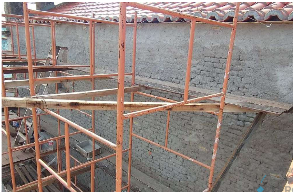
Foto 37 – Vista parede oeste da nave principal sendo revestida com argamassa cal e areia 1:3.
