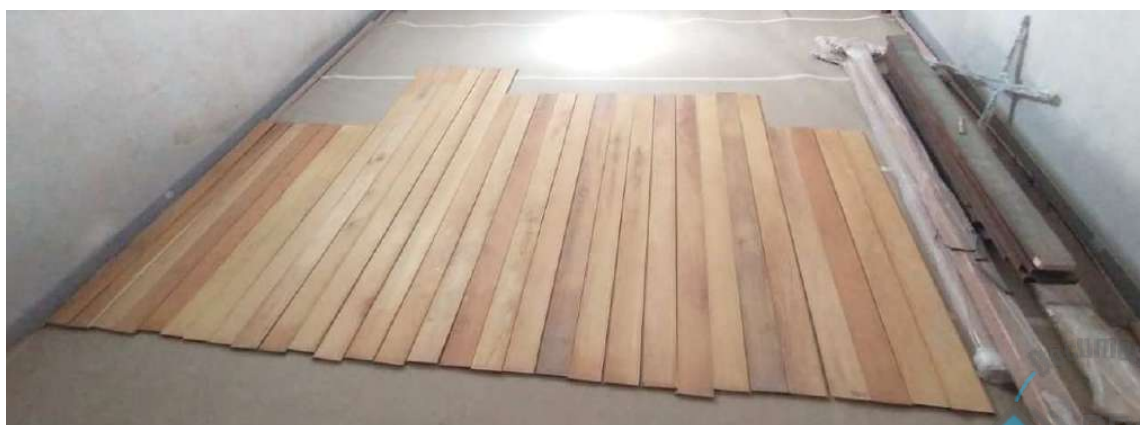
Foto 94 – Barroteamento entre piso, forro e assoalho do coro.
