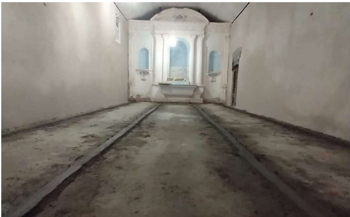
Foto 51 - Mestras para base em cimento e areia.
