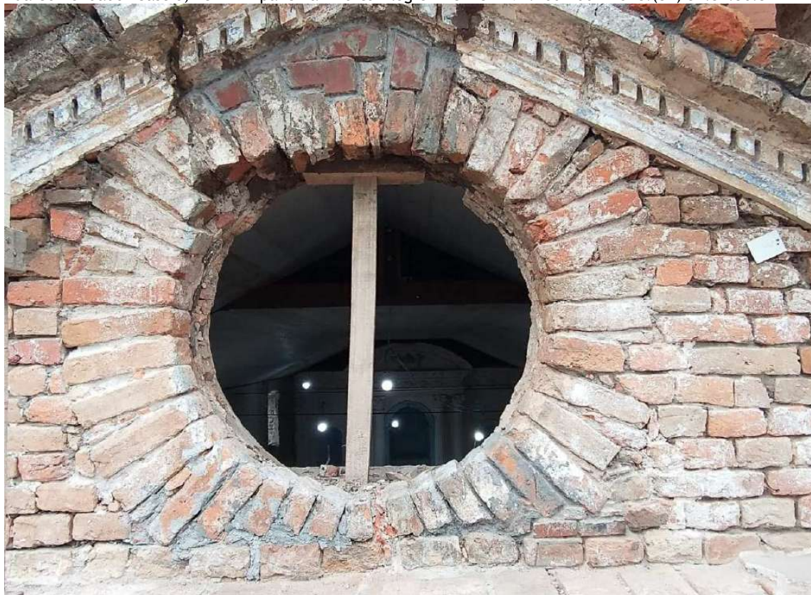
Foto 31 – Reconstituição alvenaria após inserção de reforços metálicos.
