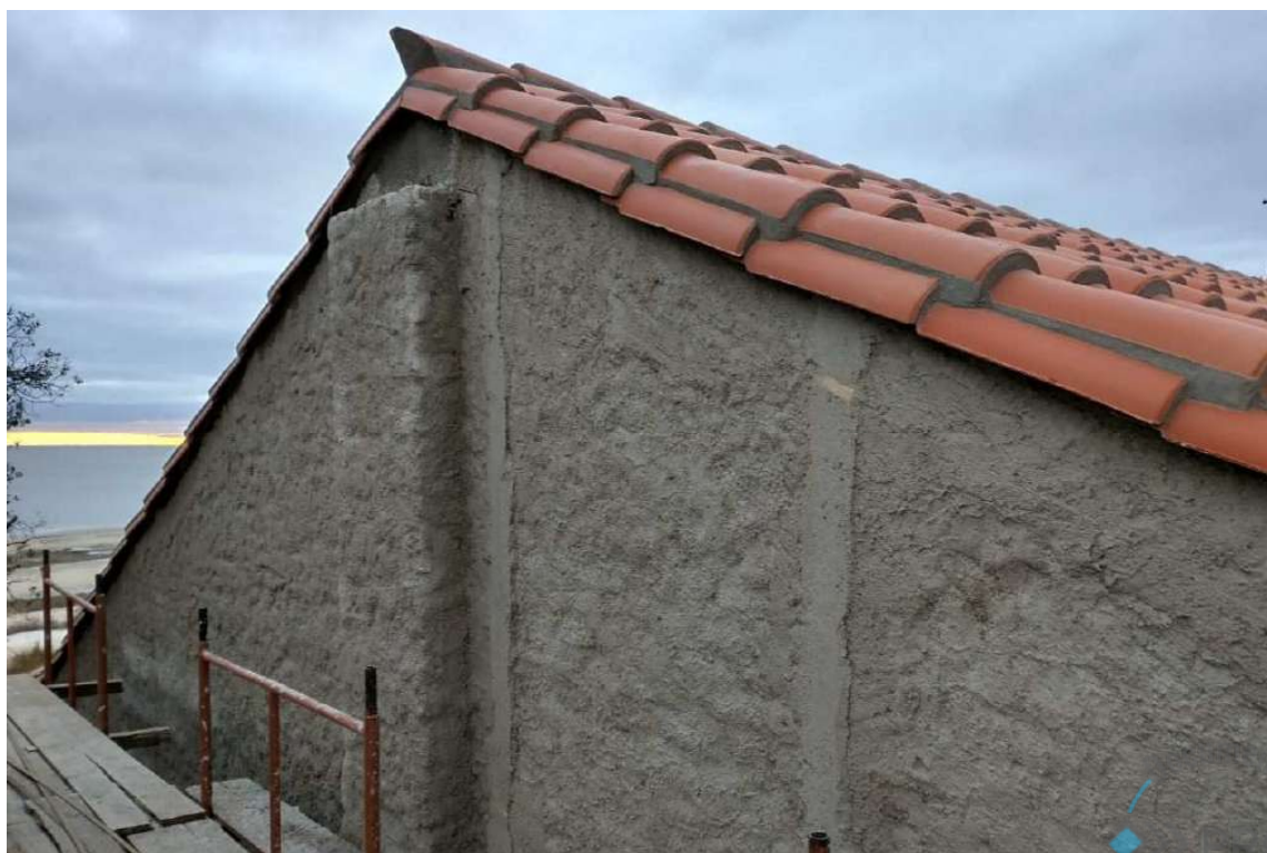
Foto 19 – Execução de revestimentos em cal e areia 1:3.
