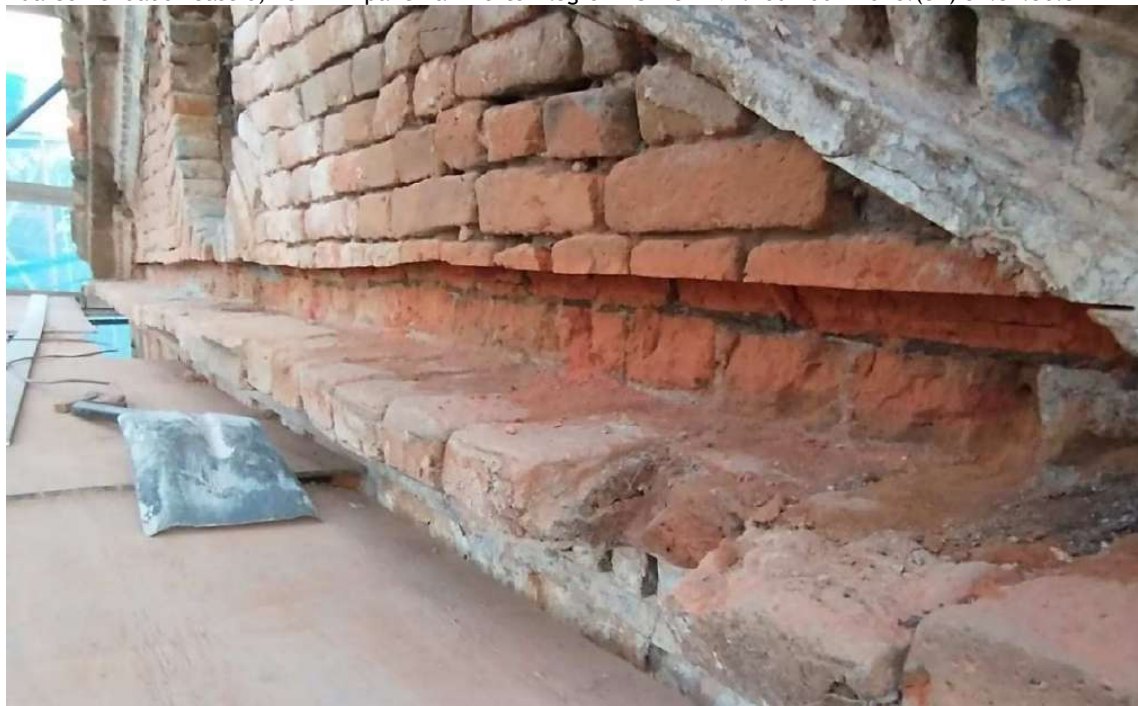
Foto 16 – Corte alvenaria para inserção de chapa metálica de reforço.
