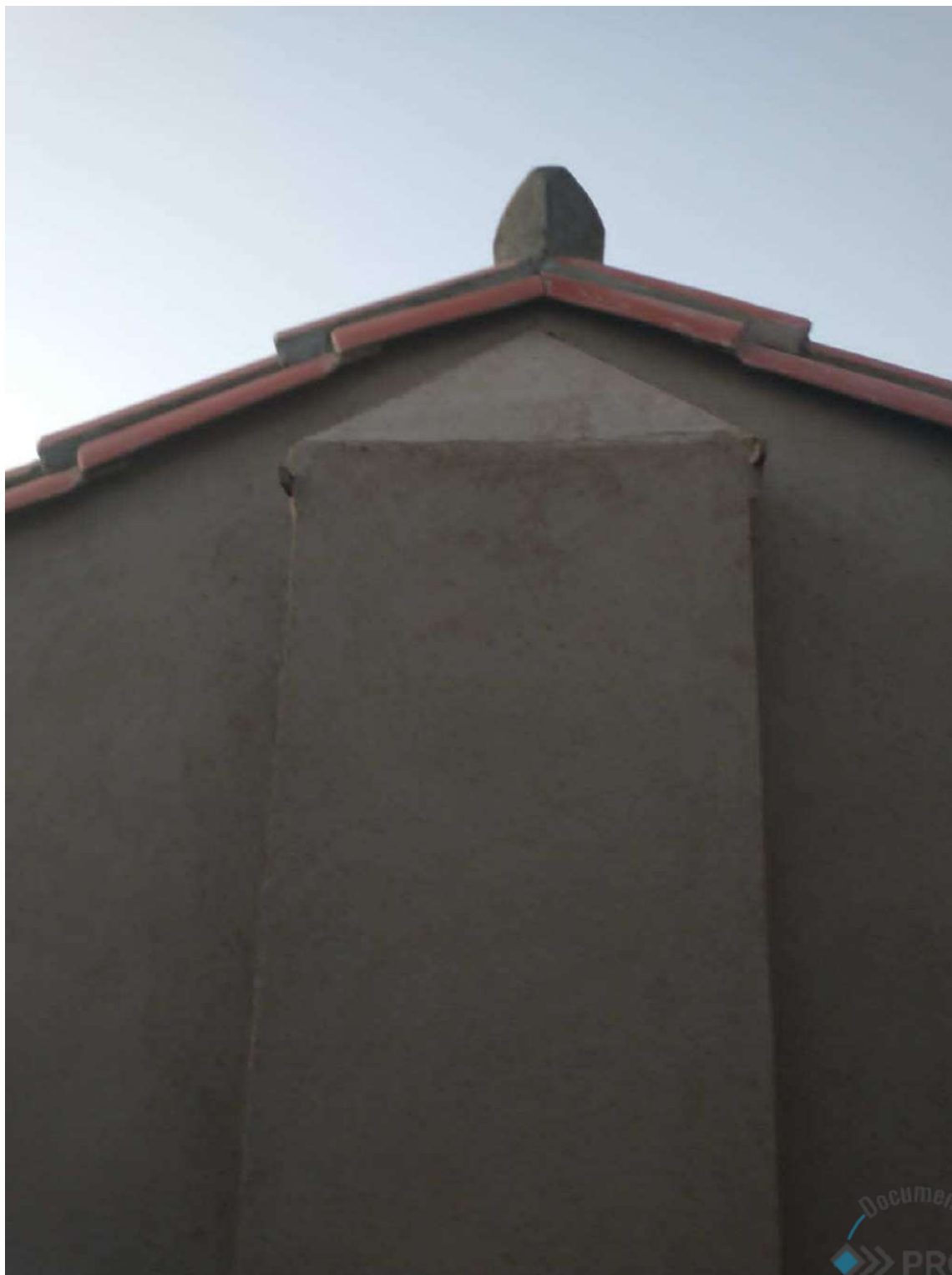
Foto 26 – Detalhe do acabamento de topo do pilar na parede sul.
