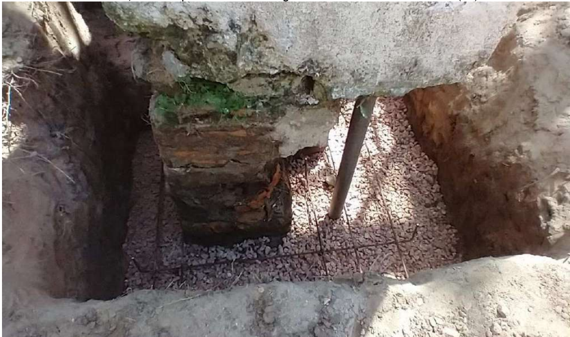
Foto 101 – Armadura sapata base muro.
