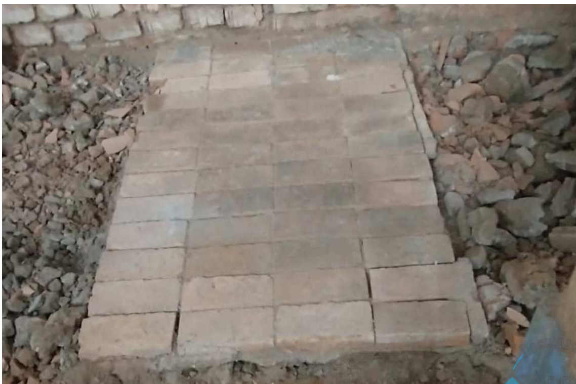
Foto 56 – Remoção dos tijolos antigos de piso, foi feito registro destas marcações.
