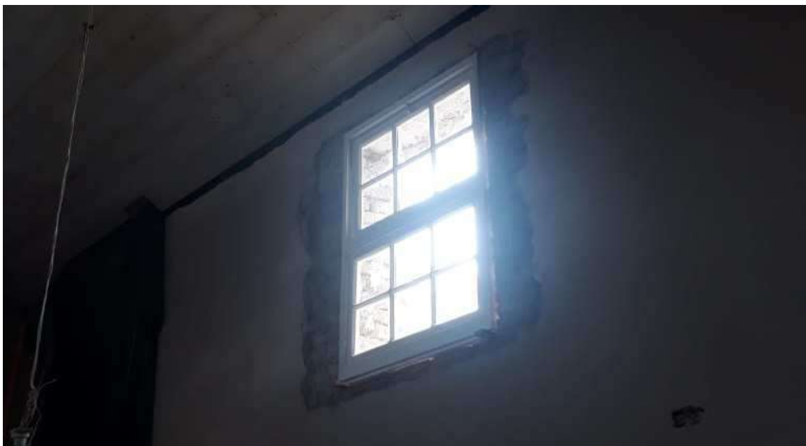
Foto 63 – Janela nave principal instalada.
