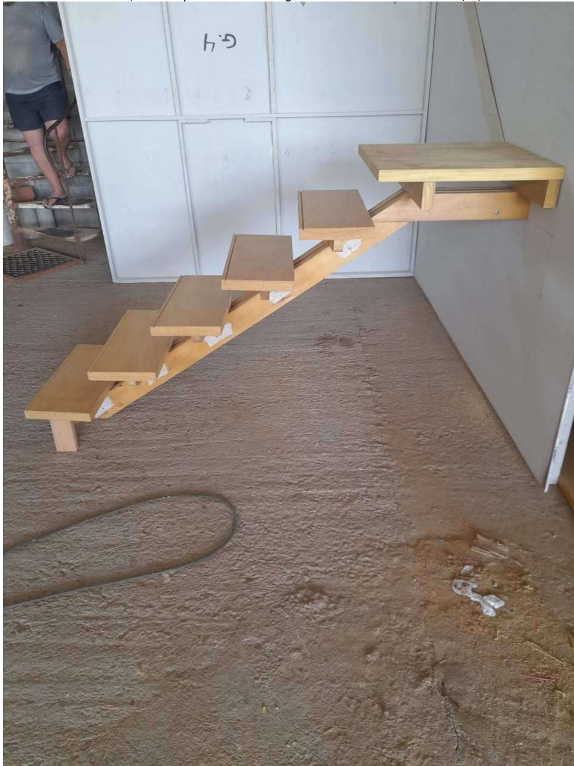
Foto 94 – Execução escada coro na marcenaria.
