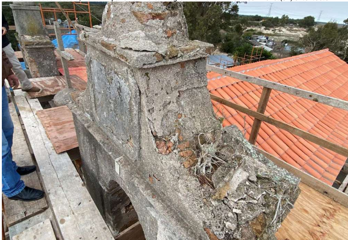
Foto 80 – Registro estado da torre sino lado oeste.
