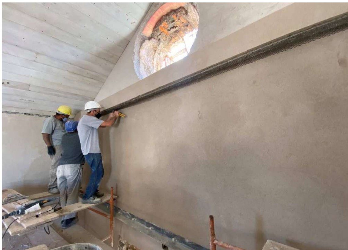
Foto 58 – Execução reboco paredes internas, colocando tela sob a cinta interna para rebocar.
