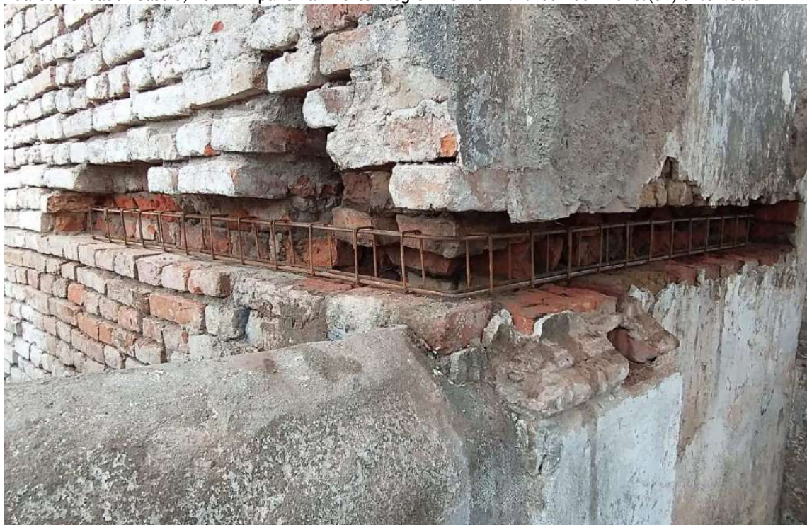
Foto 6 – Reforços no canto entre a parede fachada principal e parede Leste, amarração.
