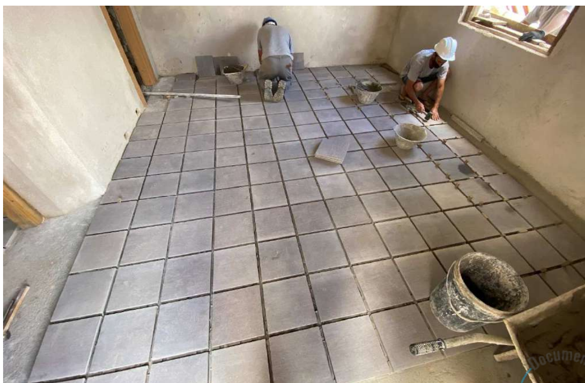
Foto 54 – Colocação de piso definitivo -basalto fosco tear. Sacristia.
