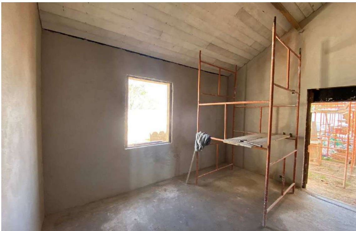
Foto 62 – Execução reboco paredes internas sacristia.
