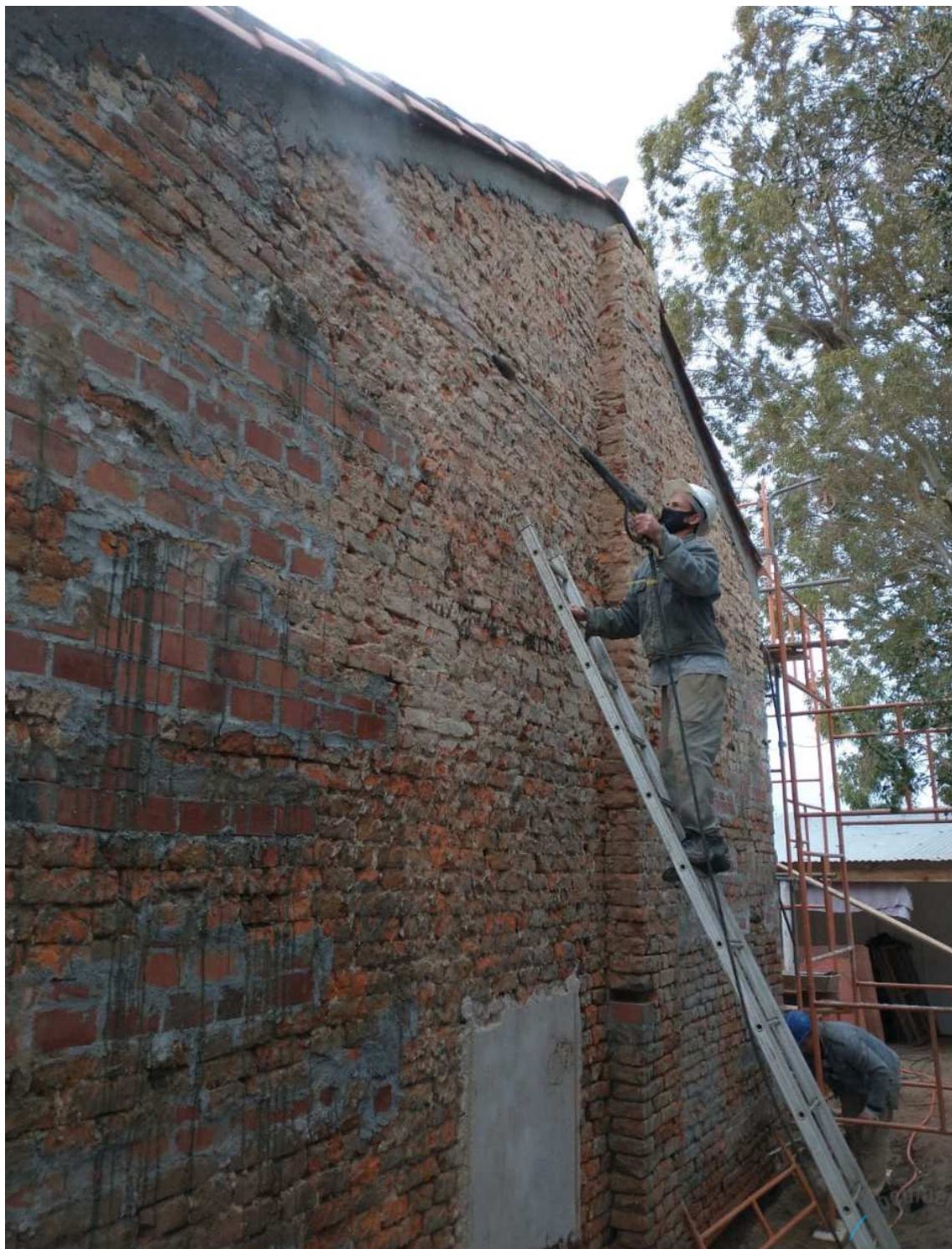
Foto 17 – Limpeza da fachada sul com hidrojato.
