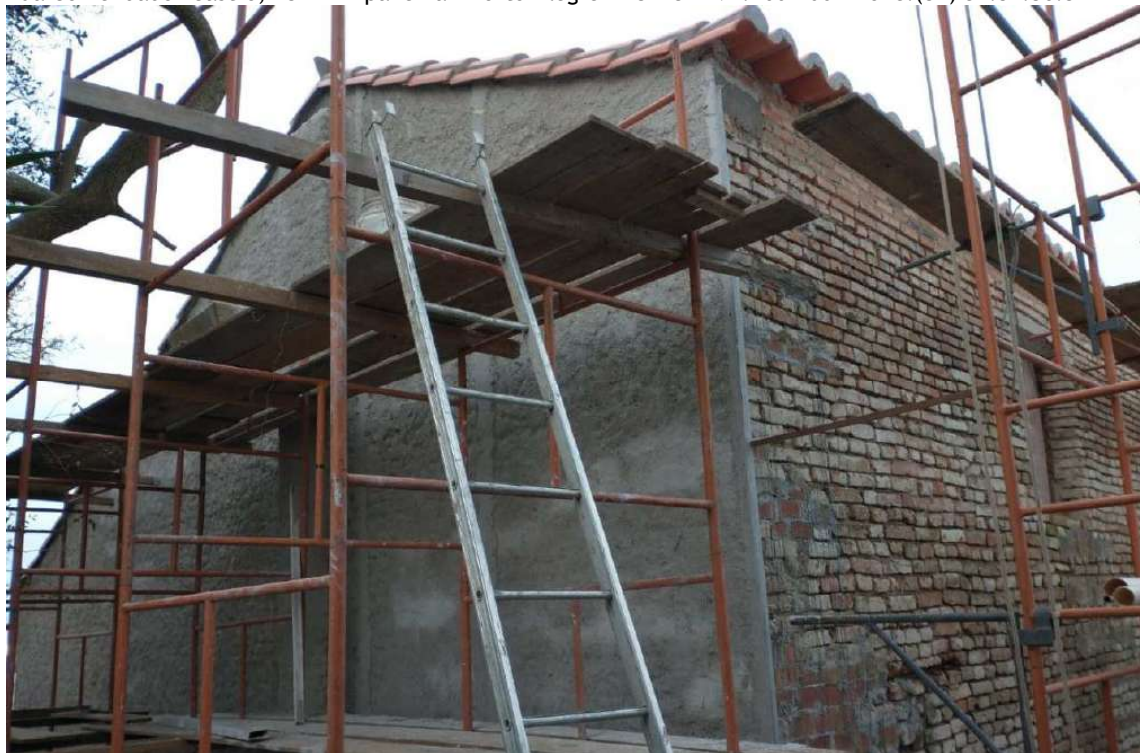
Foto 18 – Execução de revestimentos em cal e areia 1:3.
