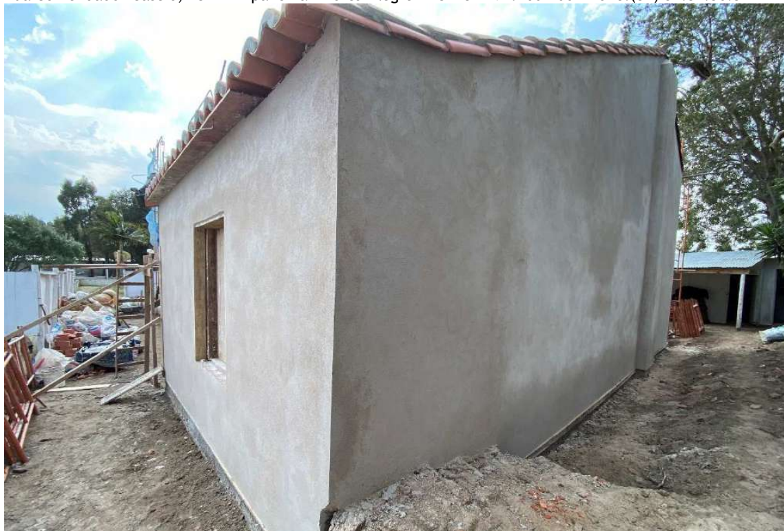
Foto 30 – Vista parede sul e parede oeste da sacristia com revestimento em cal e areia 1:3 concluído.
