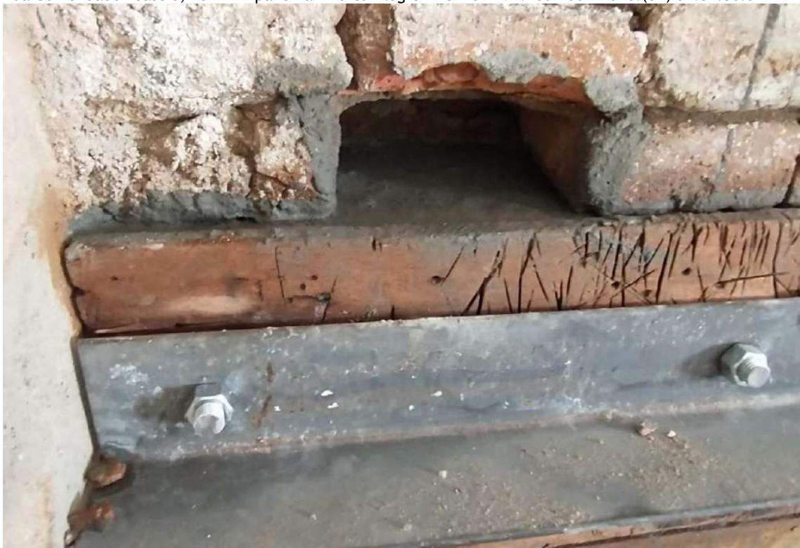
Foto 10 – Detalhe da forma da cinta e cantoneira. Cantoneira fixada com peças de barra roscada.
