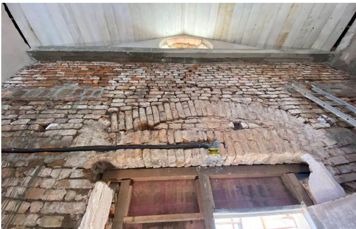
Foto 44 – Rasgos, tubulações e caixas.
