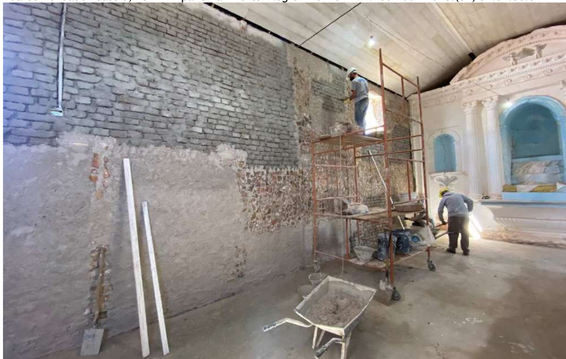
Foto 51 – Encascotamento e chapisco parede interna.
