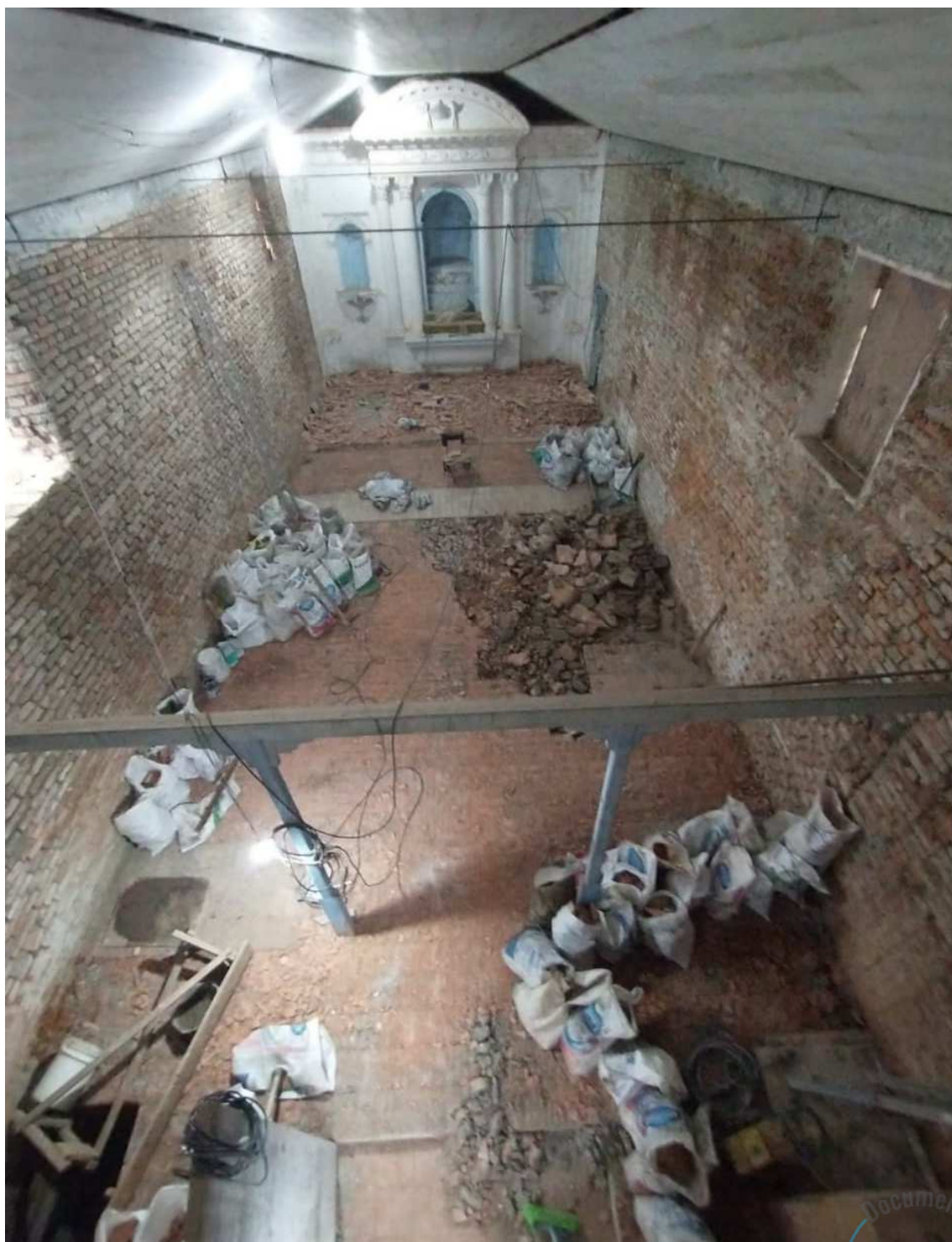
Foto 52 – Demolição piso e contrapiso existente para executar contrapiso na nave principal, ensacamento dos entulhos.
