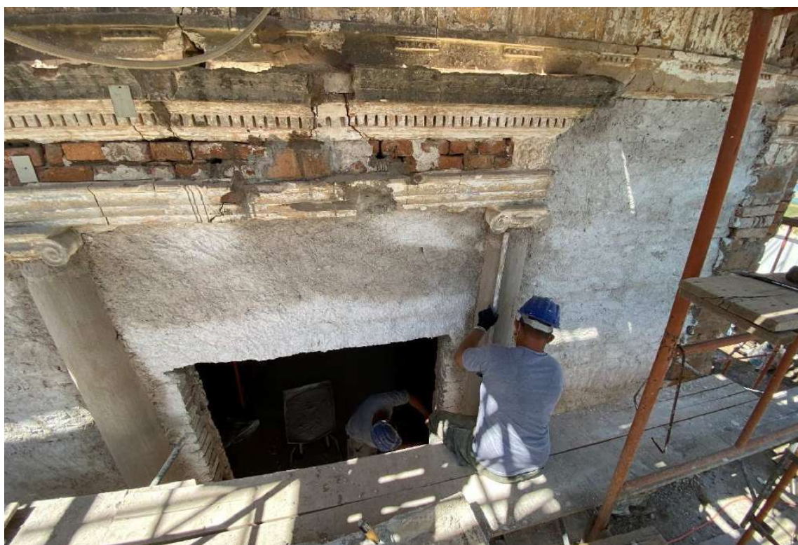
Foto 34 – Revestindo as colunas com argamassa de cal e areia 1:3.
