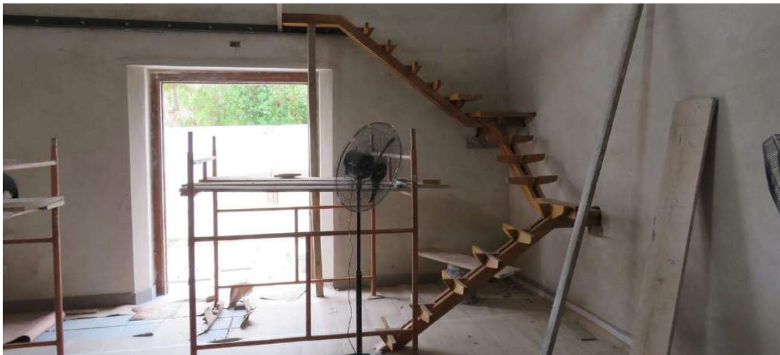
Foto 91 – Instalação da escada de acesso ao coro.
