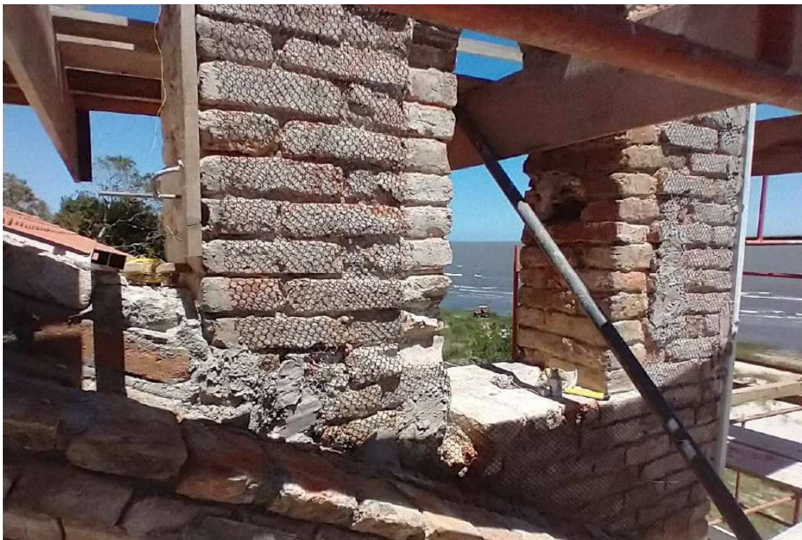
Foto 1 – Revestimentos antigos removidos, juntas rebaixadas, tela estuque plástica.
