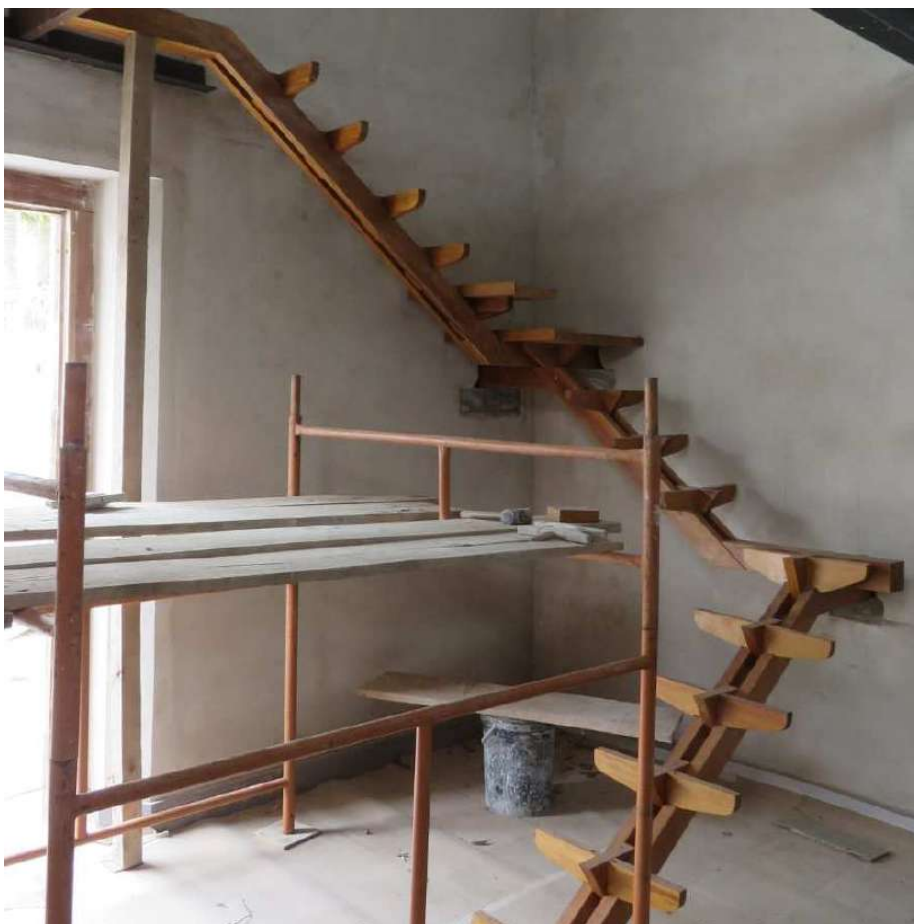
Foto 92 – Instalação da escada acesso ao coro.
