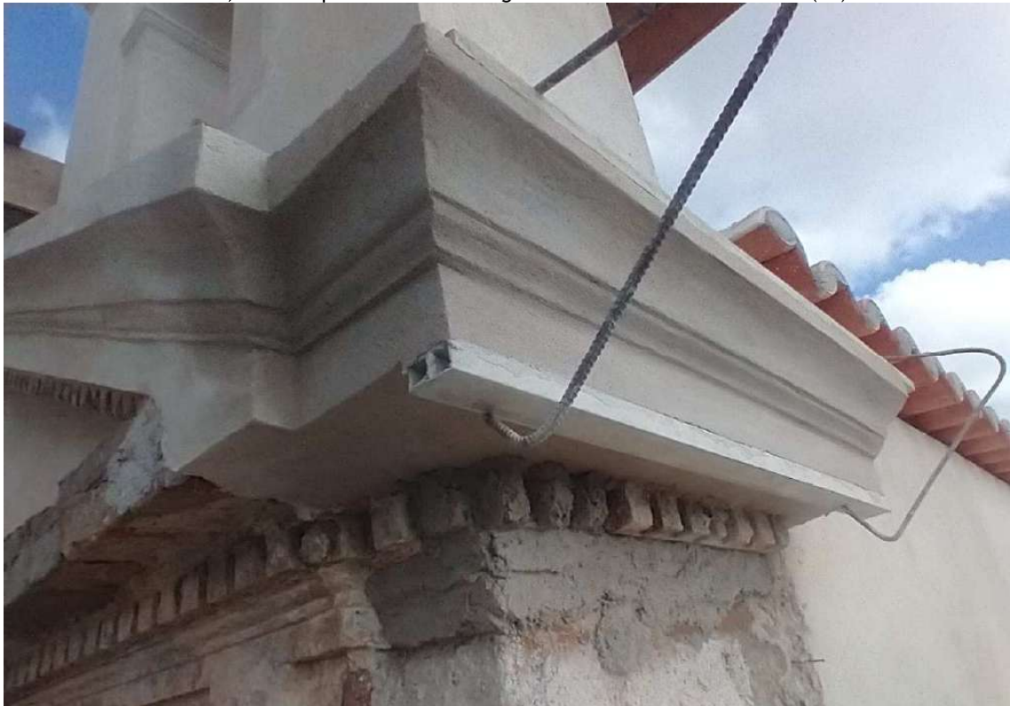
Foto 9 – Reintegração das molduras e frisos nos cantos superiores das pilastras laterais.
