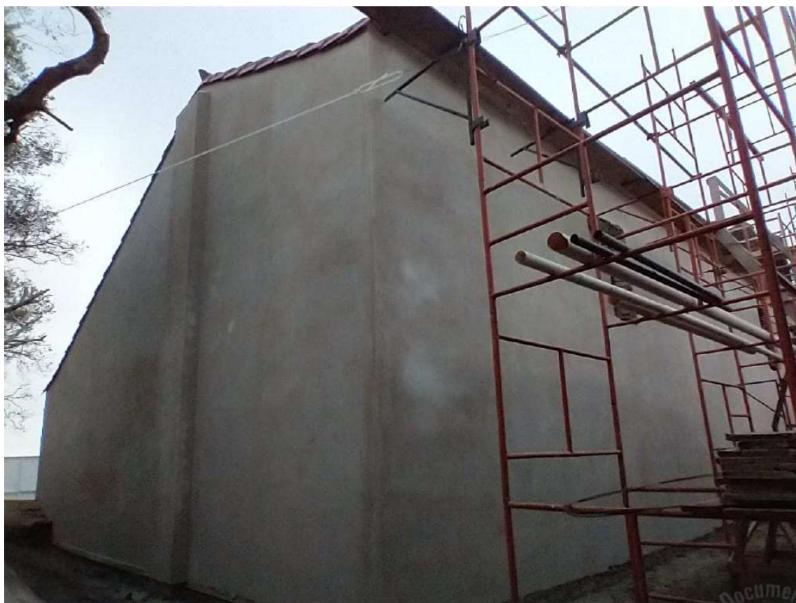
Foto 43 – Vista paredes sul e leste revestidas com argamassa de cal e areia 1:3
