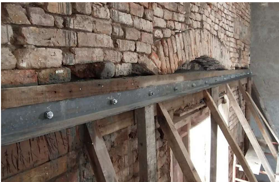
Foto 9 – Escoramento da forma da cinta e cantoneira. Cantoneira fixada com peças de barra rosca.
