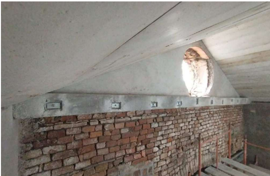
Foto 21 – Fixação da chapa metálica externa de reforço na cinta interna com barras roscadas.
