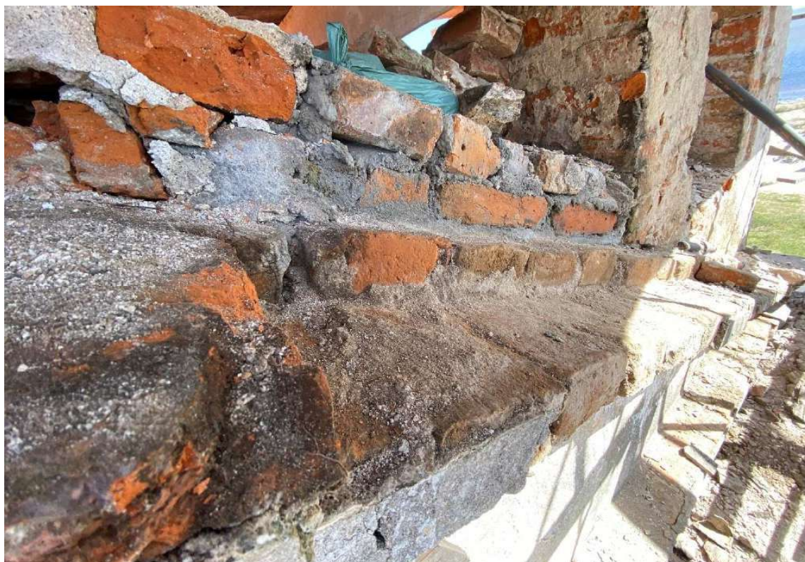
Foto 68 – Reconstituições de alvenarias junto a cimalha superior.
