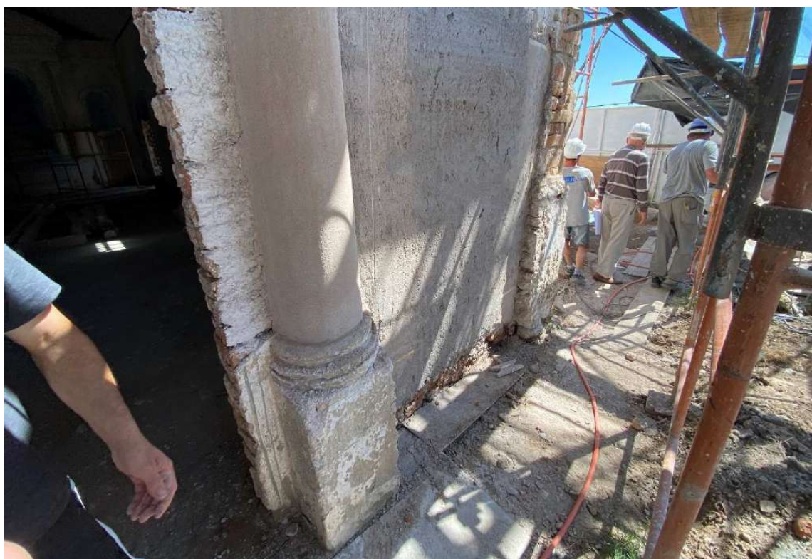
Foto 38 – Revestindo as colunas com argamassa de cal e areia 1:3.
