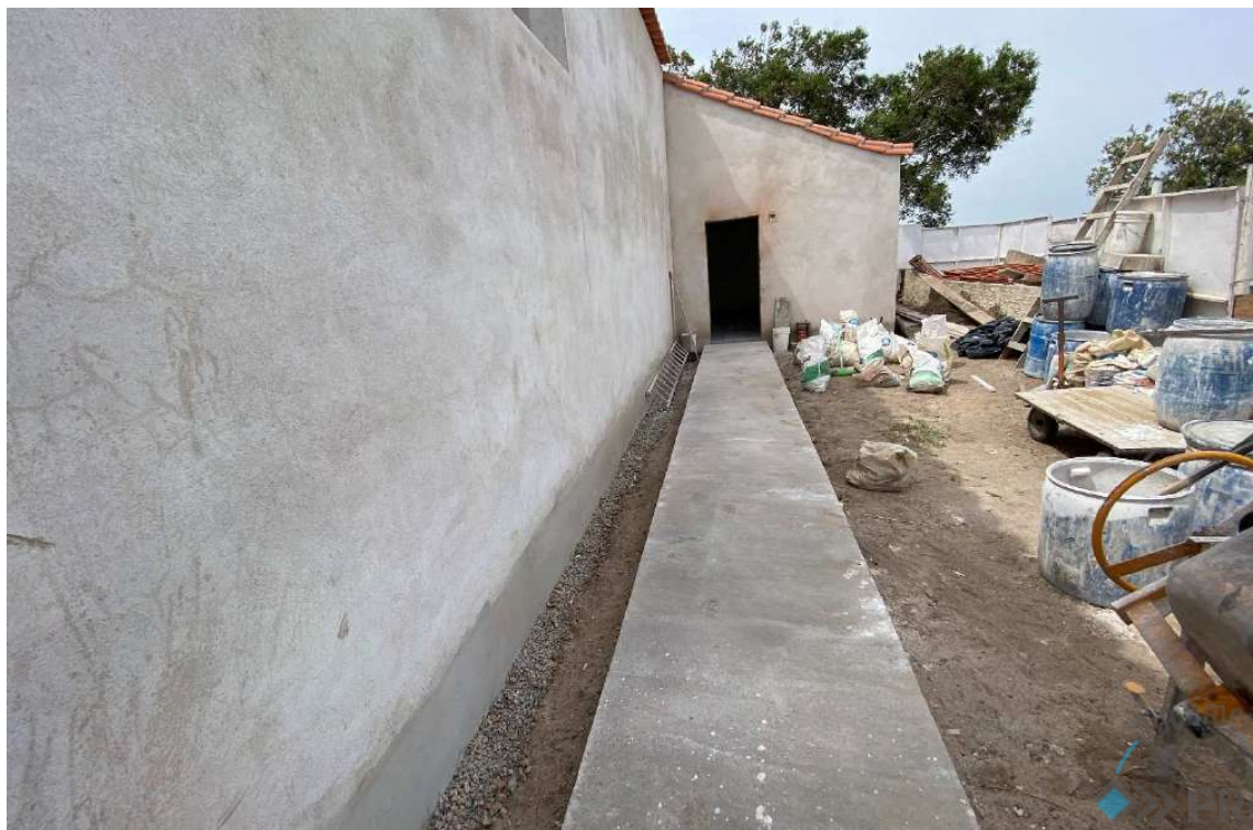
Foto 73 – Rampa externa acesso sacristia concretada.
