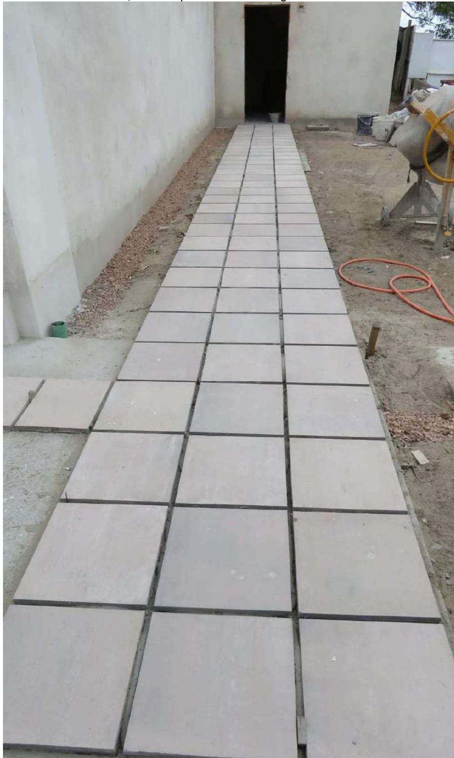
Foto 74 – Pavimentação externa em basalto levigado Tear.
