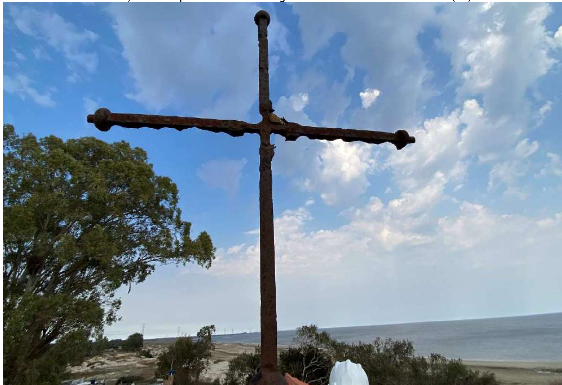
Foto 78 – Registro estado da cruz lado leste antes da remoção.
