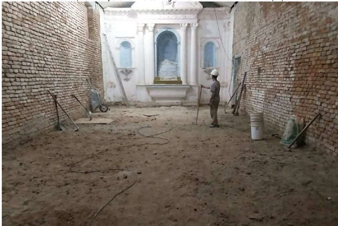
Foto 57 – Nivelando base para executar contrapiso na nave principal.
