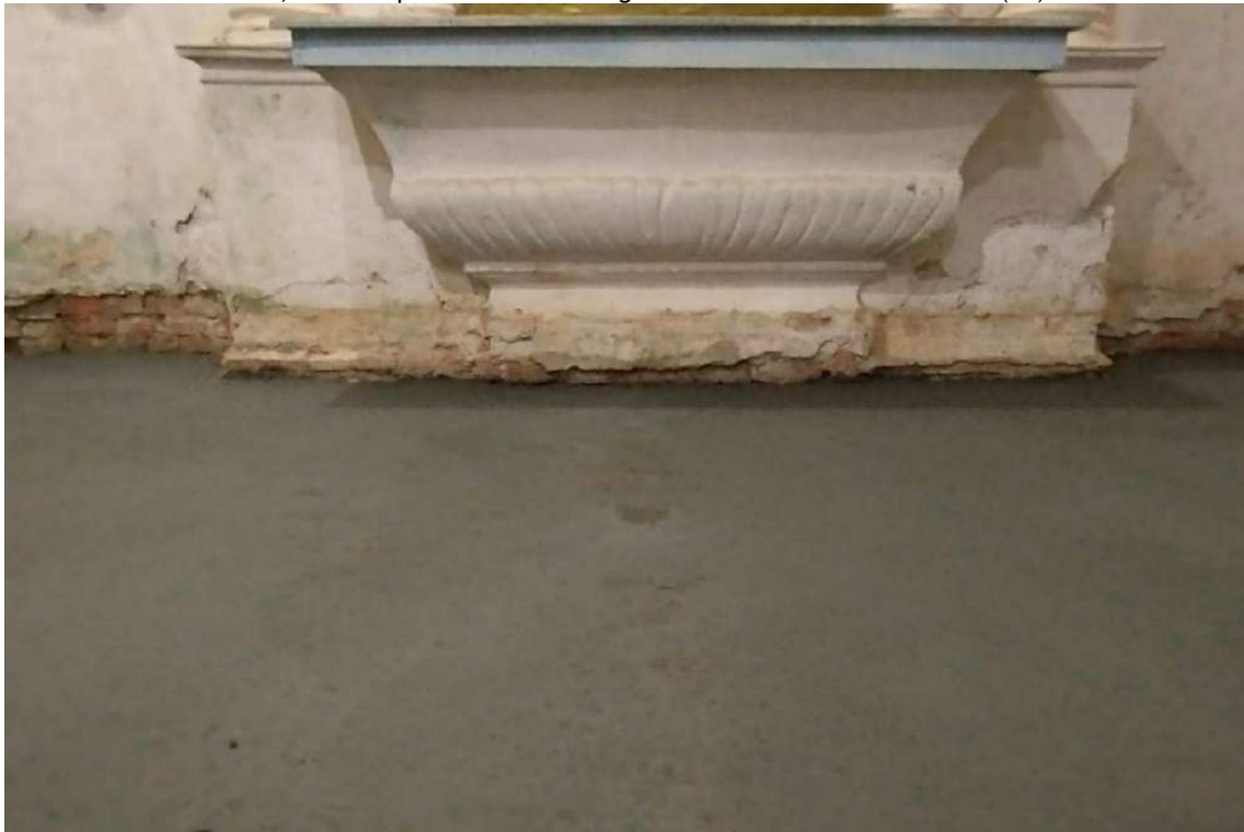
Foto 65 – Contrapiso nave principal, junto ao altar.
