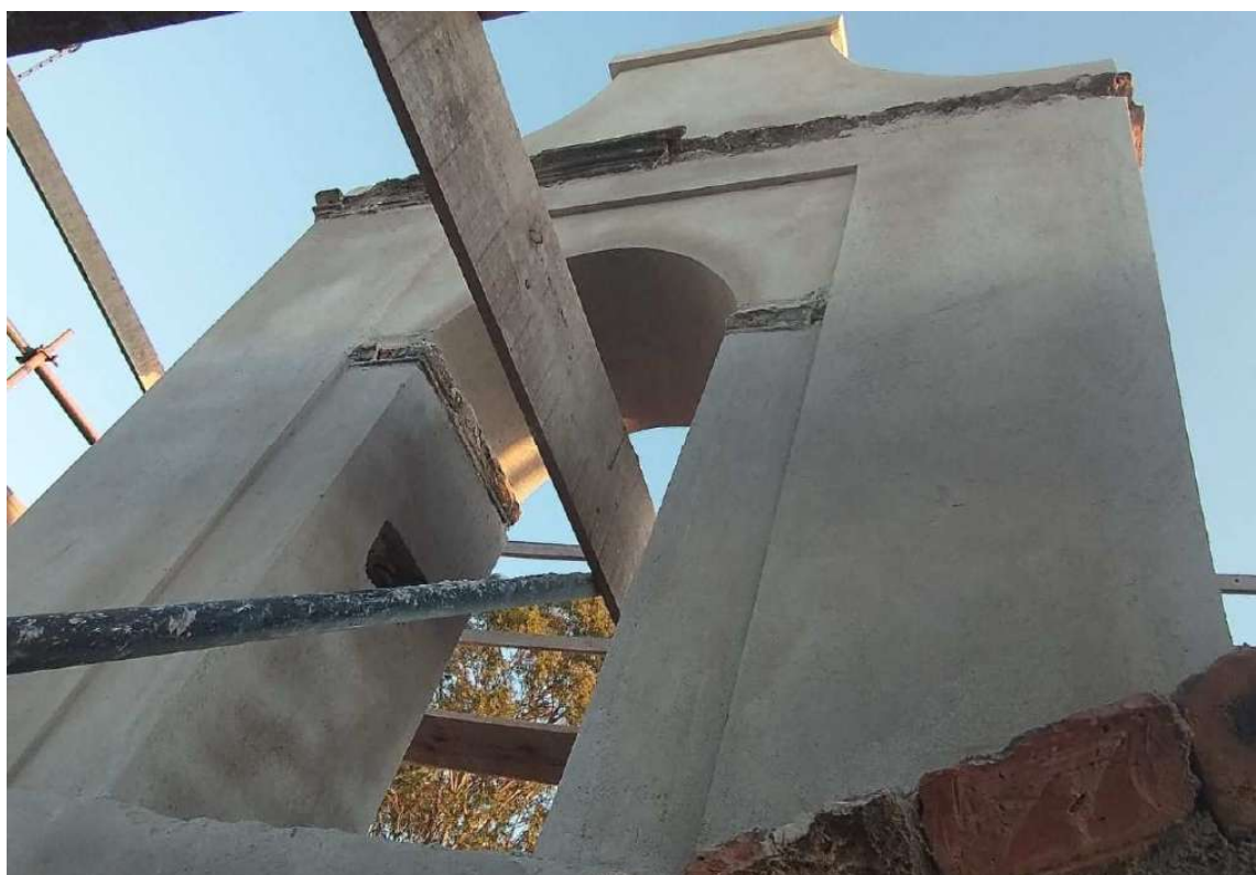
Foto 16 – Revestimento em argamassa de cal e areia 1:3.
