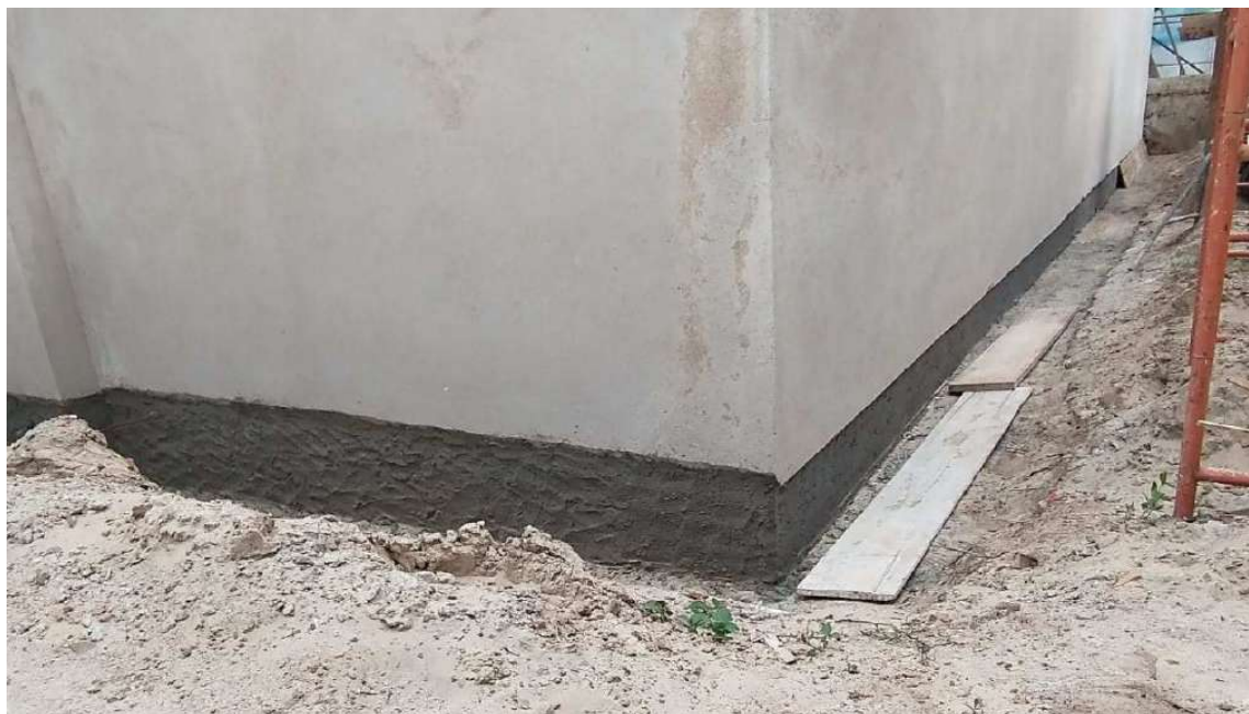
Foto 35 – Preparação da base para aplicação de argamassa transpirável.
