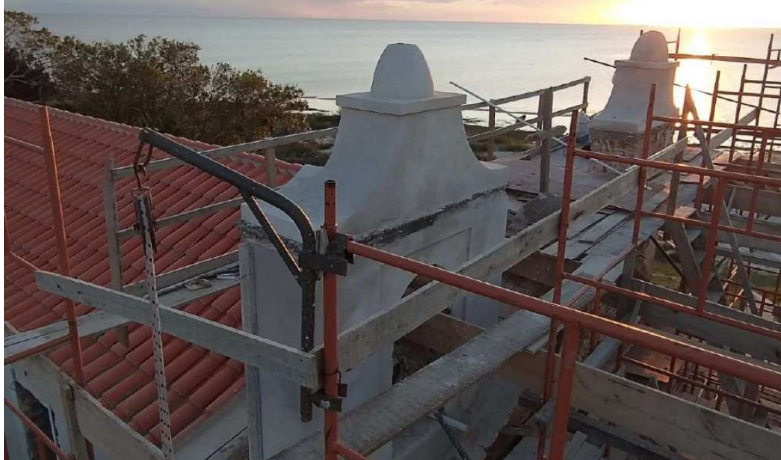
Foto 23 – Torres revestidas com argamassa de cal e areia 1:3.
