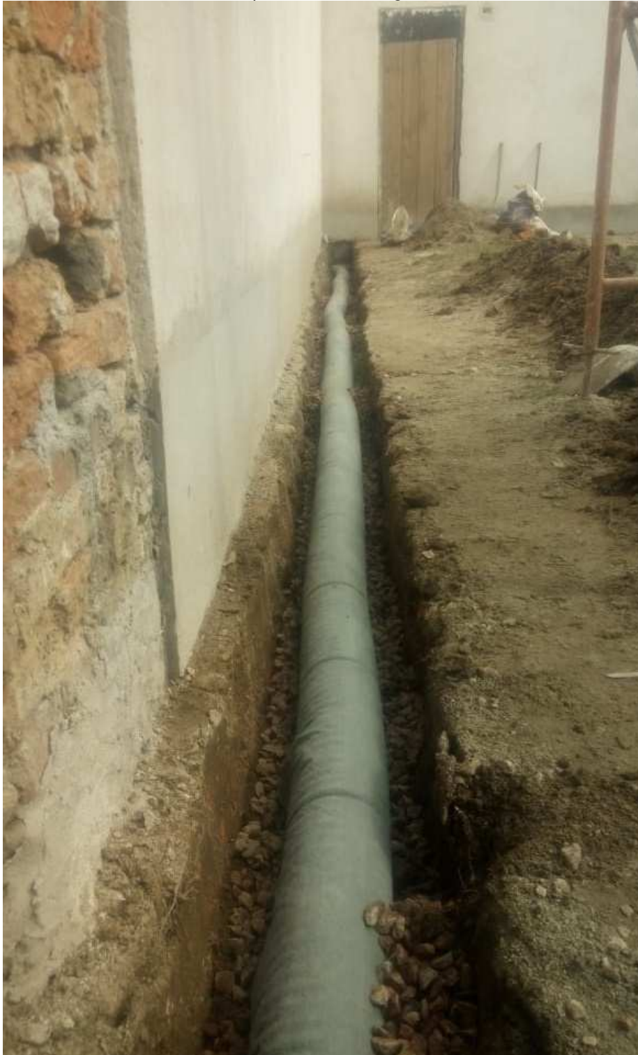
Foto 90 – Execução rede drenagem perímetro da Capela.
