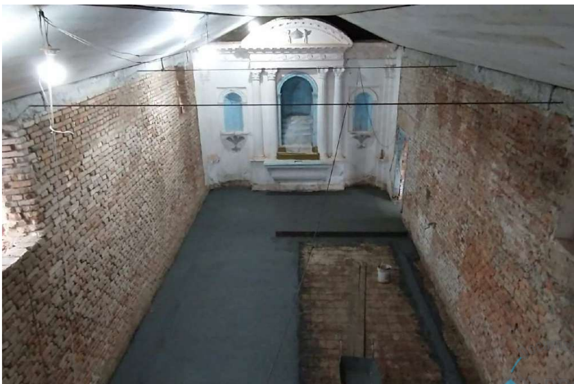
Foto 62 – Execução do contrapiso na nave principal.
