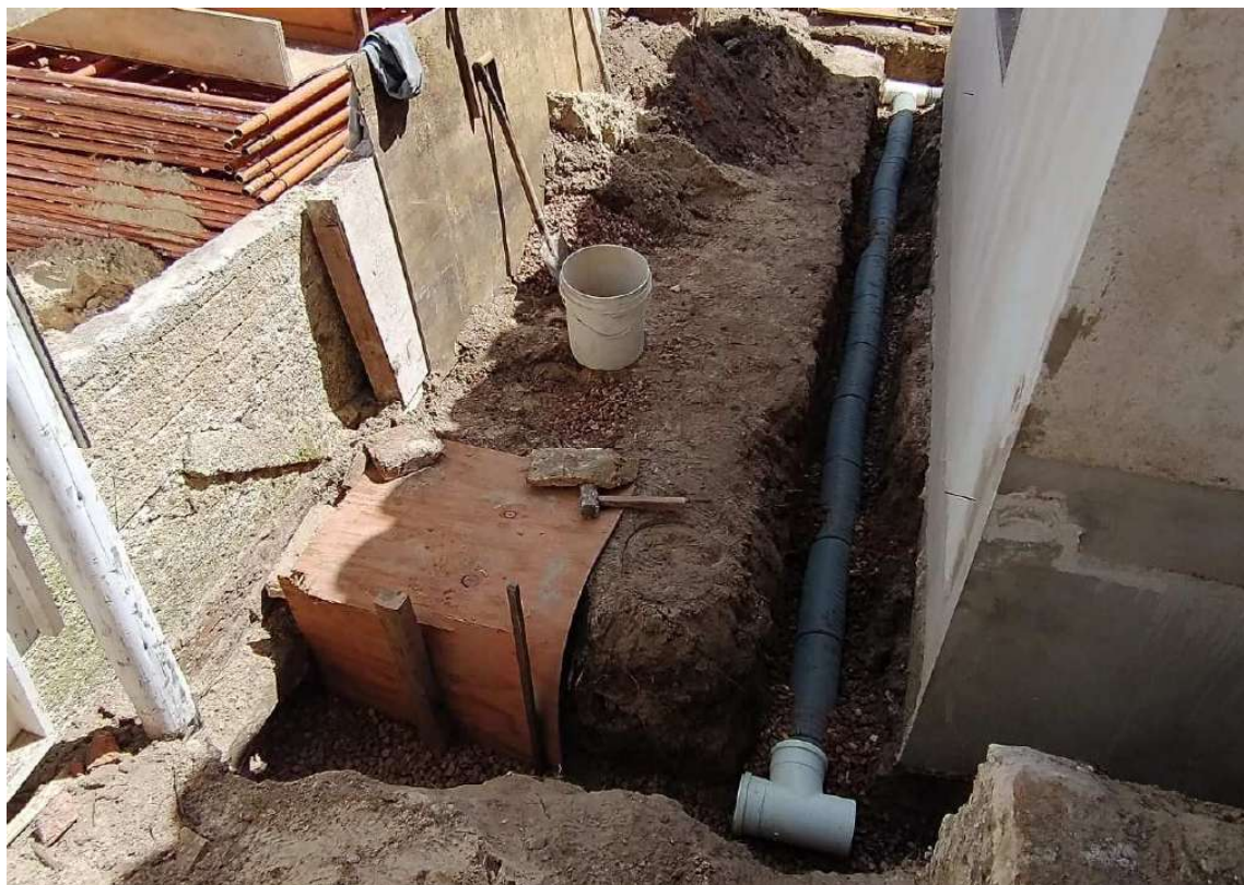
Foto 84 – Execução rede drenagem perímetro da Capela.
