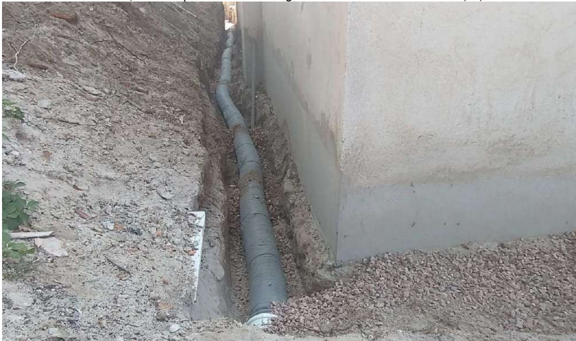
Foto 86 – Execução rede drenagem perímetro da Capela.
