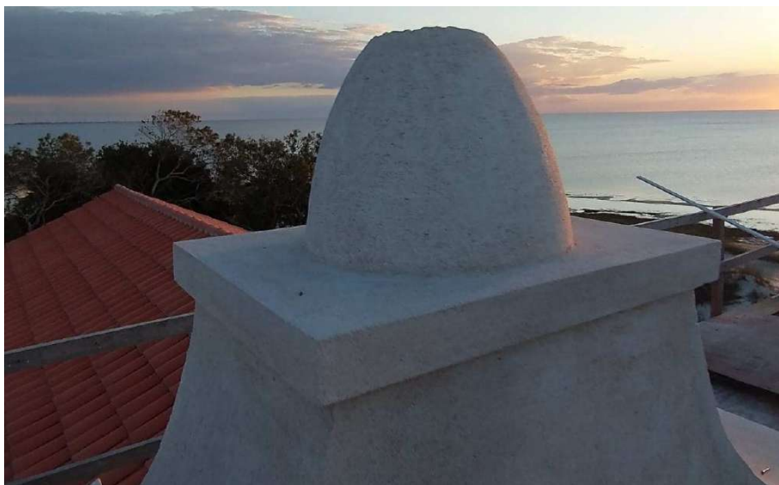
Foto 18 – Revestimento em argamssa de cal e areia 1:3.
