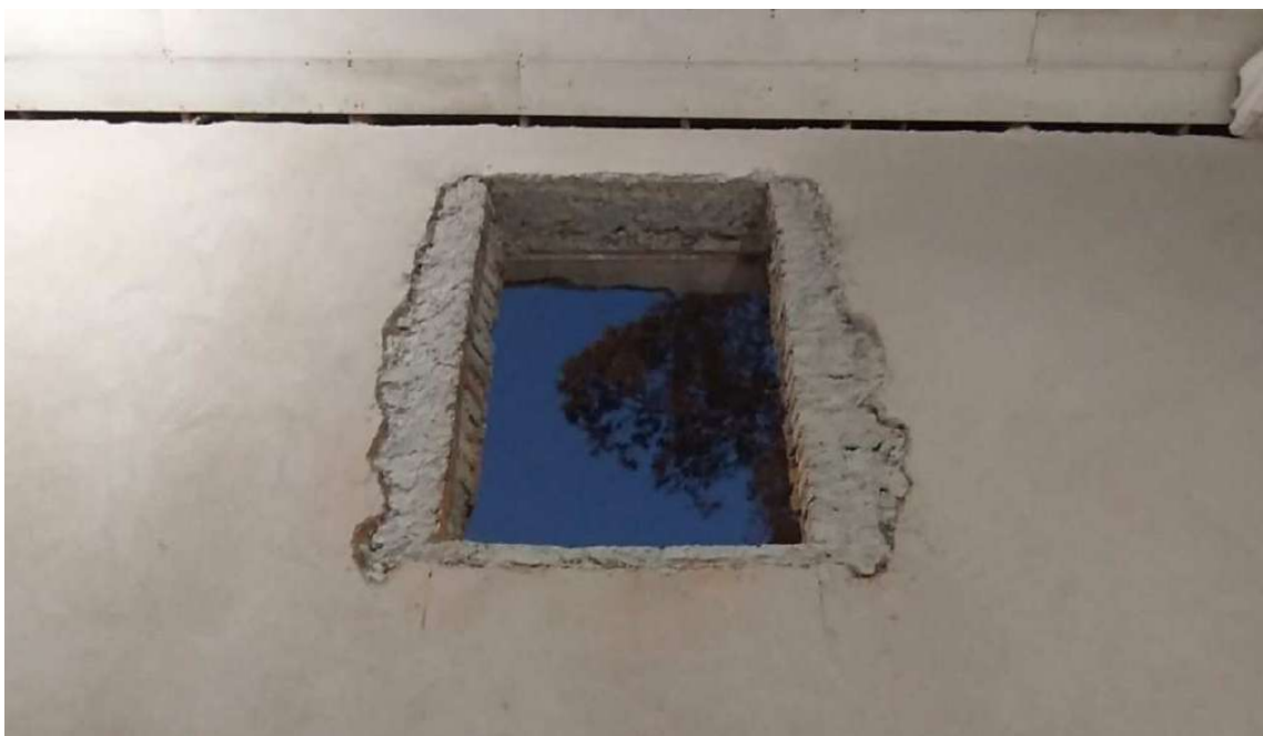
Foto 60 – Execução de ajuste dos vãos e arremates para instalação das janelas nave principal.
