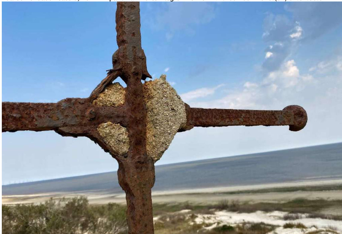
Foto 76 – Registro estado da cruz lado oeste antes da remoção.
