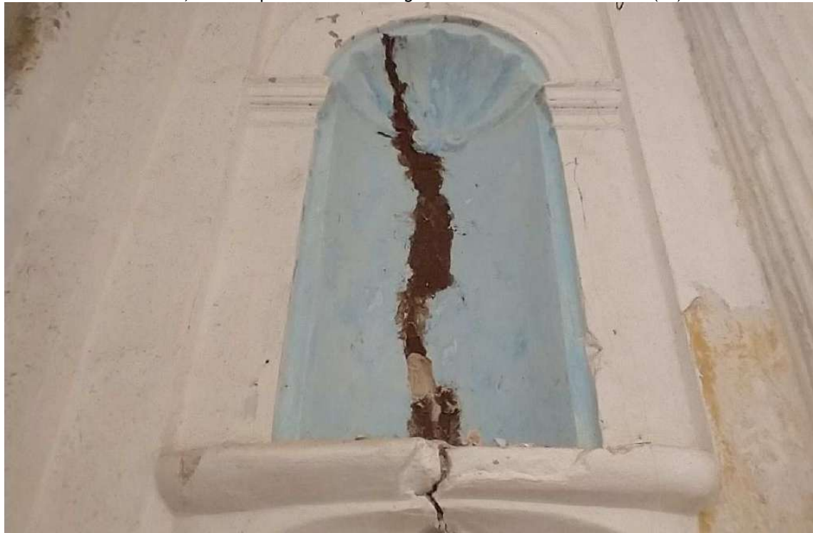
Foto 82 – Execução de grauteamento em rachadura do altar mor, pela parte de trás e tamponamento provisório com barro, para evitar escorrimentos.
