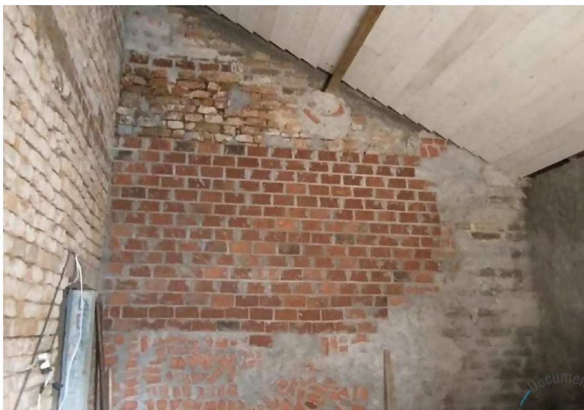
Foto 47 – Encasotamento e alvenaria de cutelo parede sul sacristia.
