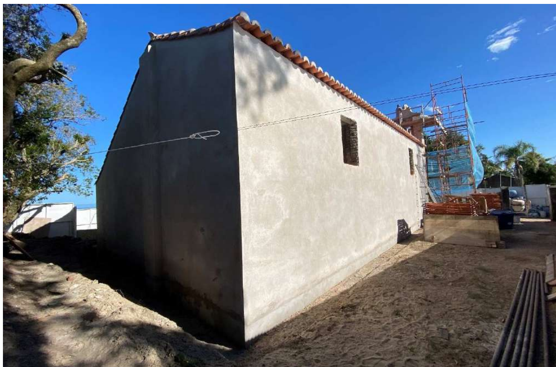
Foto 40 – Argamassa transpirável aplicada na base.
