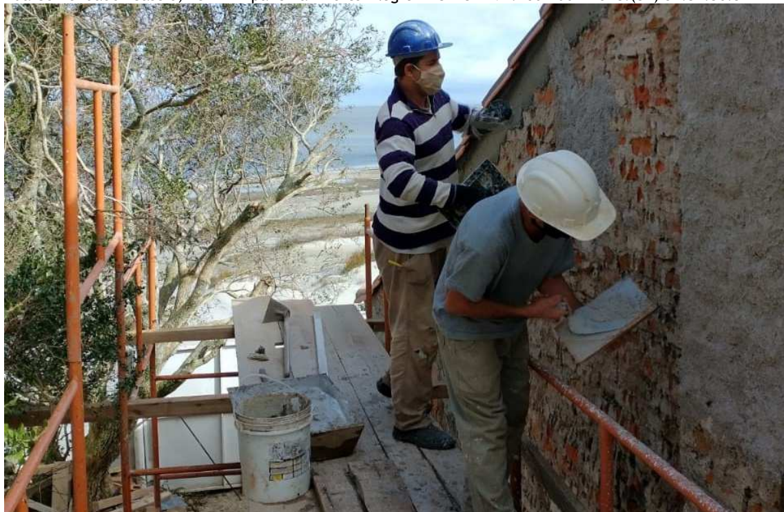
Foto 21 – Executando revestimentos sobre o encascotamento.
