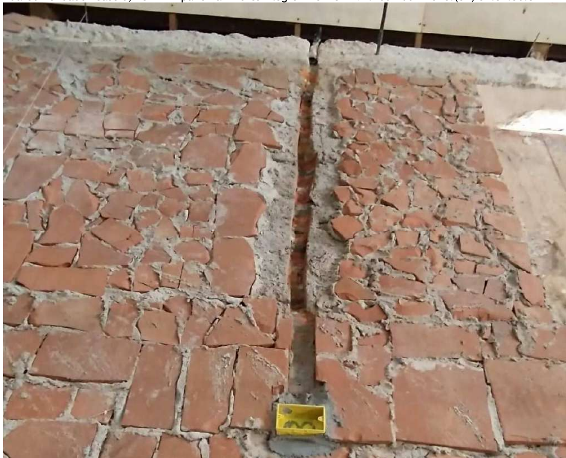
Foto 47 – Rasgos paredes e caixas.
