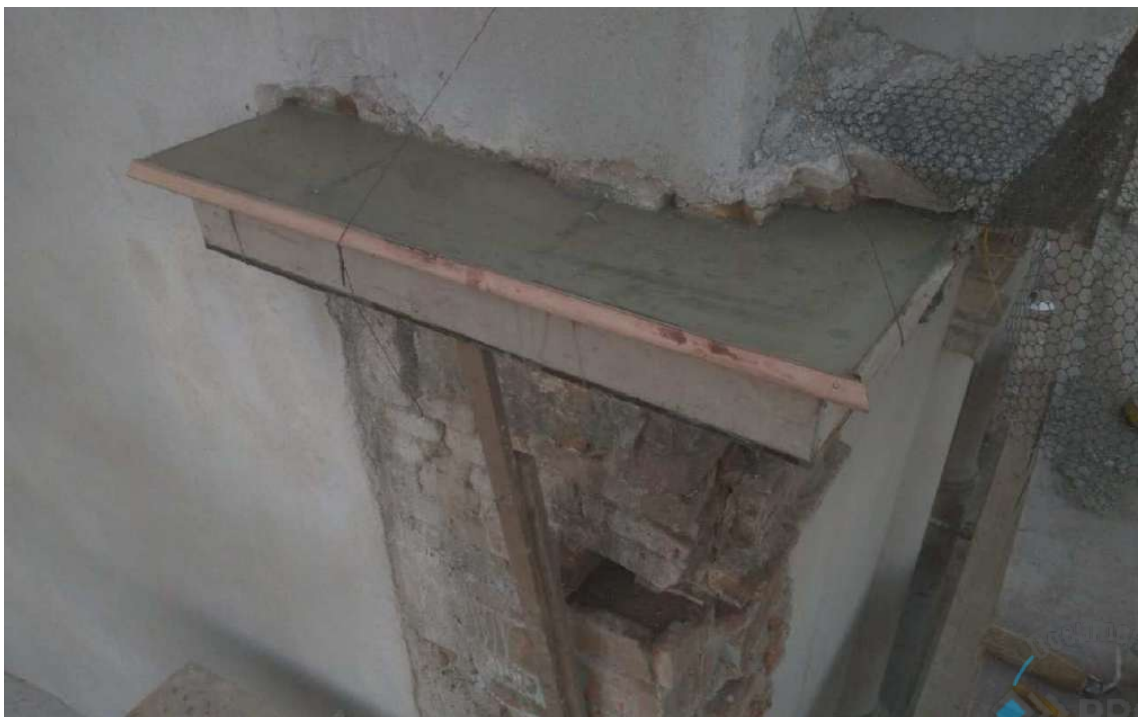
Foto 10 – Reconstrução das molduras nos cantos superiores das pilastras laterais.
