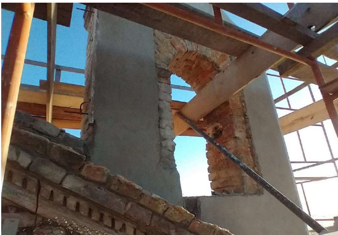
Foto 6 – Revestimento em argamassa de cal e areia 1:3.
