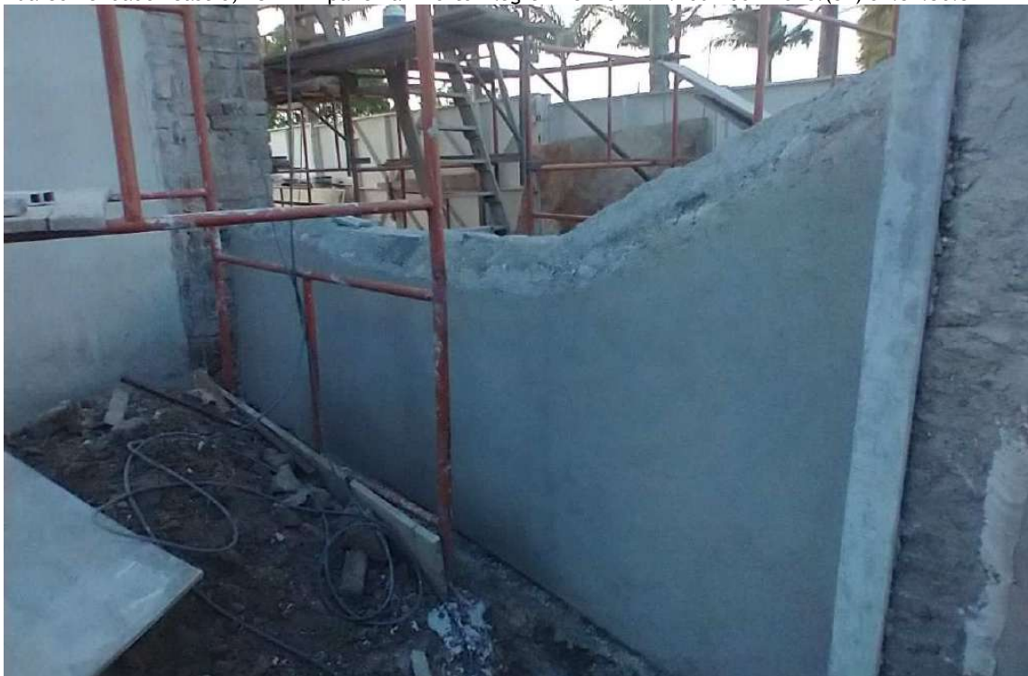
Foto 45 – Revestimento em cal e areia 1:3.
