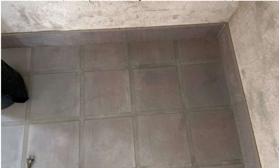
Foto 57 – Colocação de piso definitivo e rodapés - basalto fosco tear. Rejunte com cimento e areia - Sacristia.
