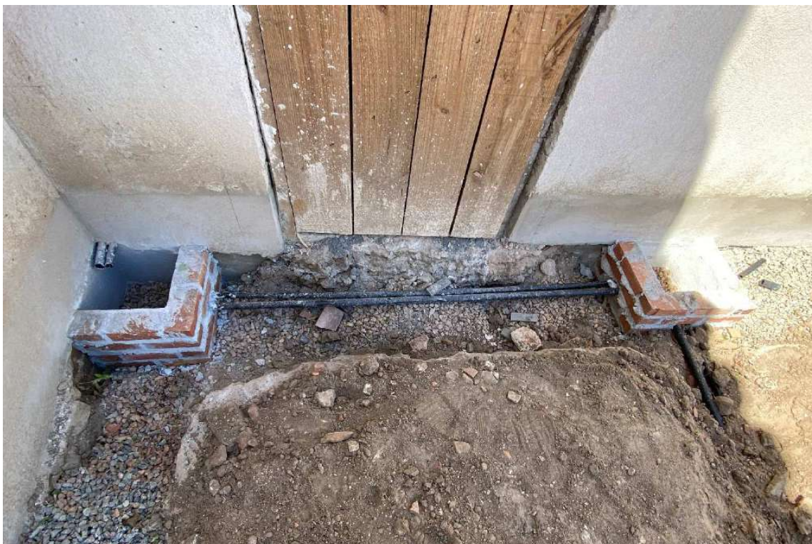
Foto 42 – Caixas de passagem e eletrodutos rede alimentação.
