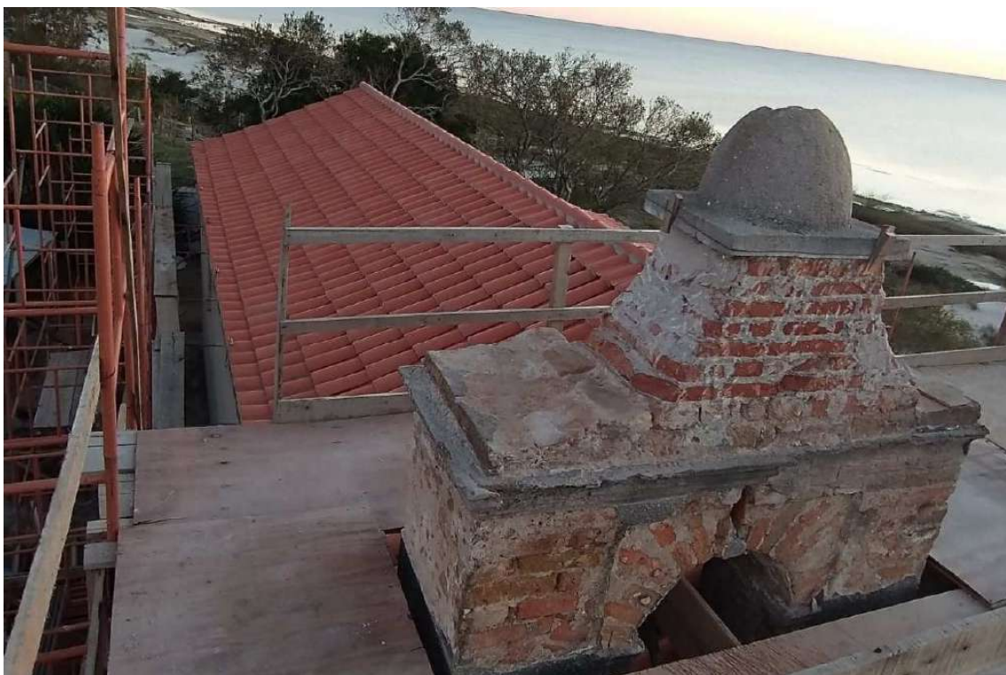
Foto 72 – Remoção revestimentos das torres.
