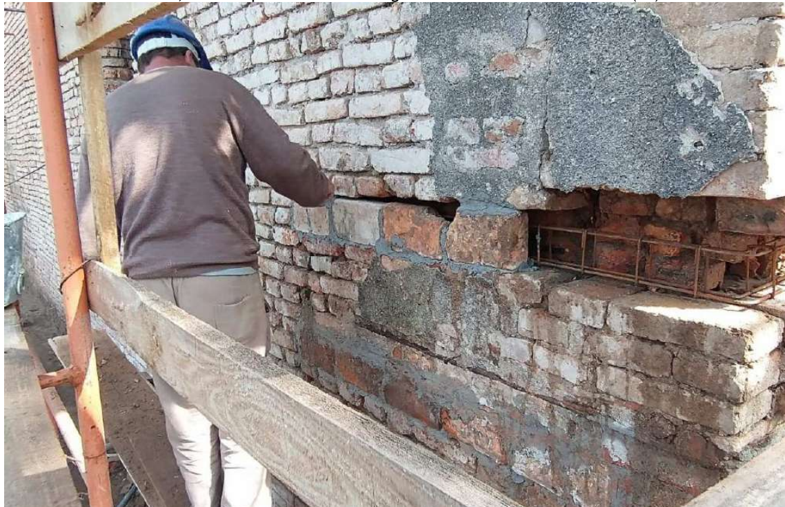
Foto 8 – Reforços no canto entre a parede fachada principal e parede Leste, amarração.
