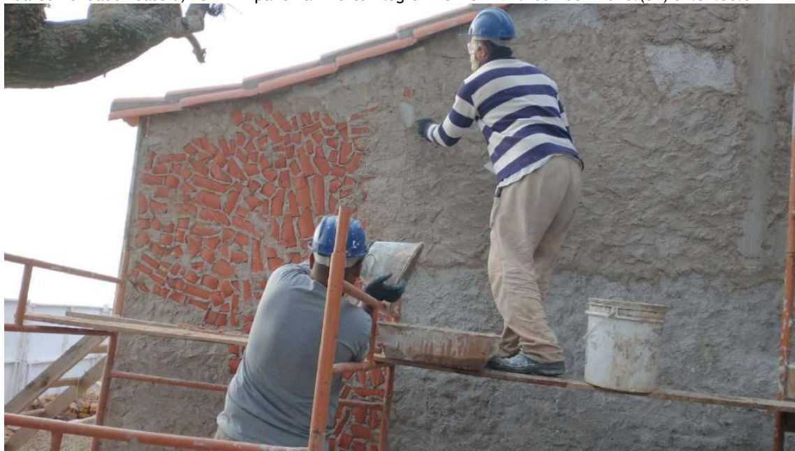
Foto 24 – Executando revestimento de cal e areia 1:3 sobre encascotamento.
