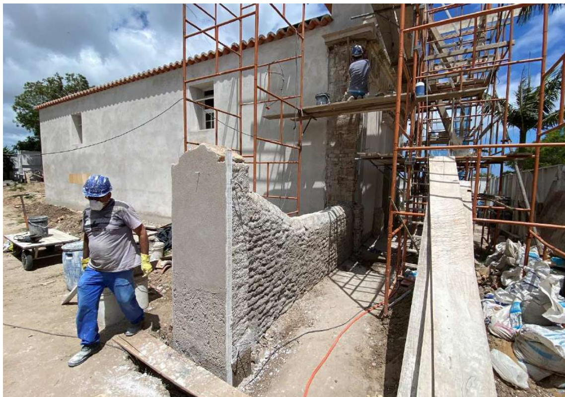
Foto 43 – Revestindo o muro em argamassa de cal e areia 1:3.
