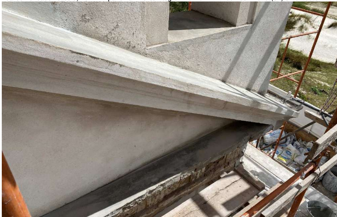
Foto 5 – Reintegração dos capeamentos com argamassa impermeabilizante e transpirável.
