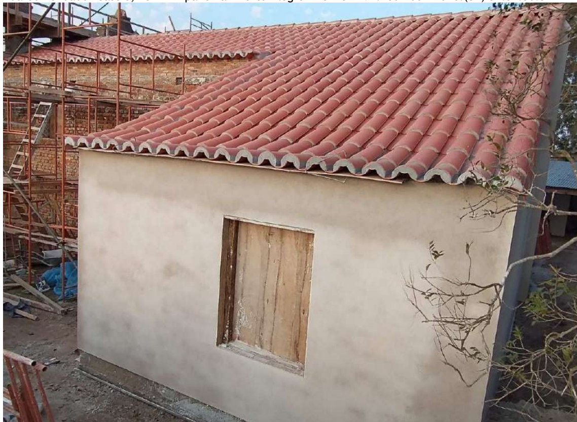
Foto 32 – Vista parede oeste da sacristia com revestimento em cal e areia 1:3 concluído.
