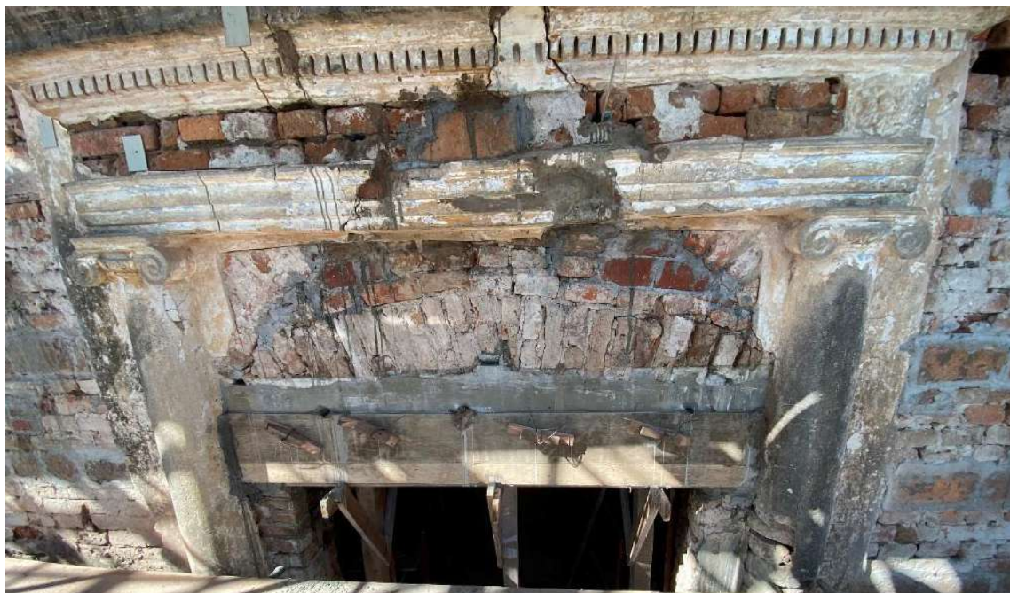
Foto 70 – Preenchimento de vazios com graute e reconstituição de elementos.
