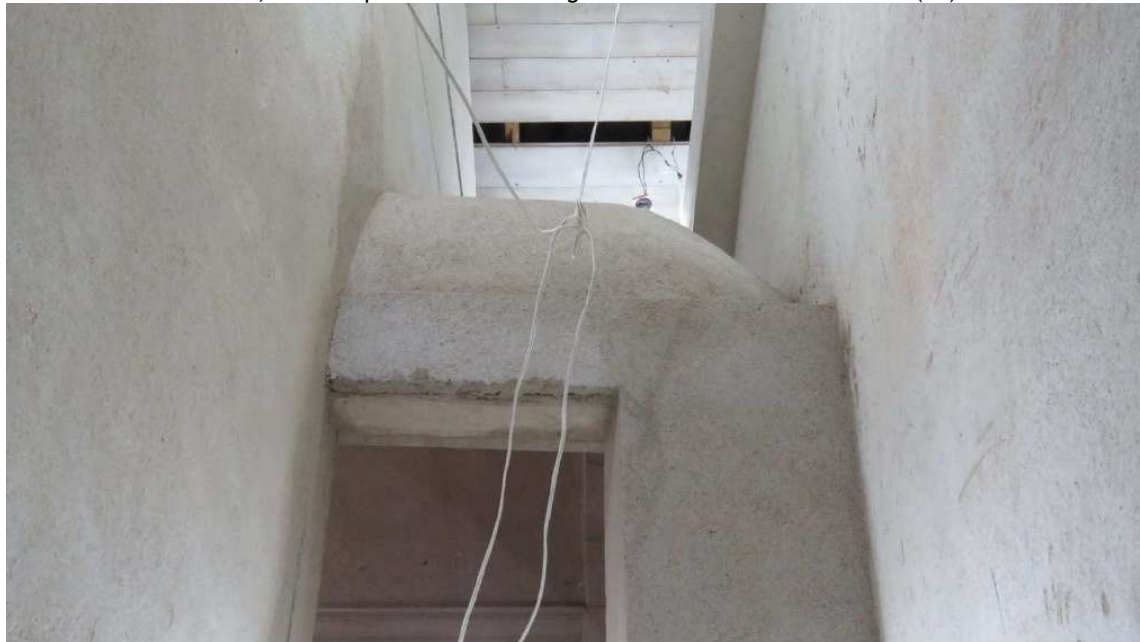
Foto 89 – Revestimentos lisos depois dos reforços estruturais da parede fundos do altar mor.
