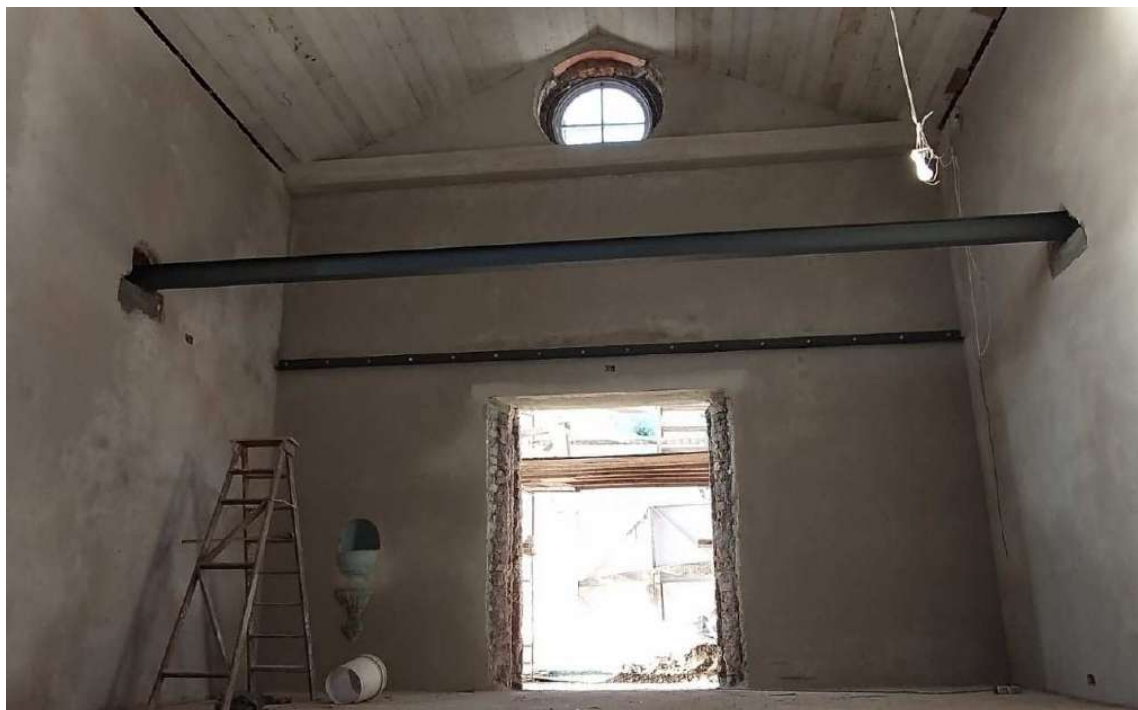
Foto 91 – Execução estrutura metálica coro.
