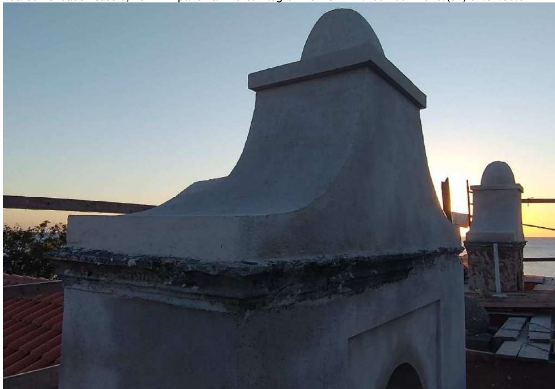
Foto 17 – Revestimento em argamssa de cal e areia 1:3.
