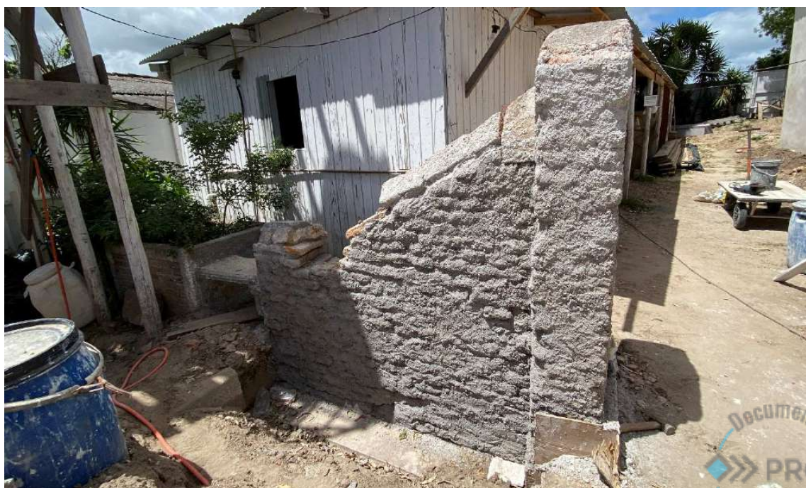
Foto 44 – Revestindo o muro em argamassa de cal e areia 1:3.
