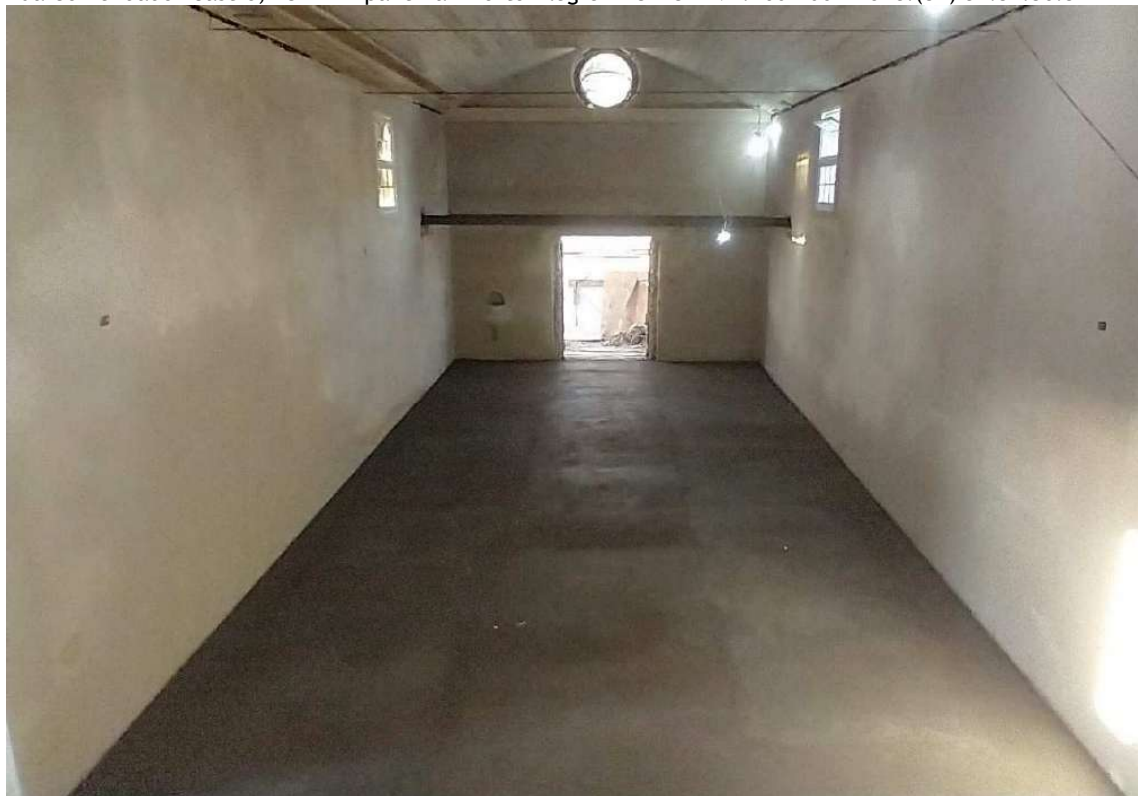
Foto 55 – Base em cimento e areia finalizado na nave principal.
