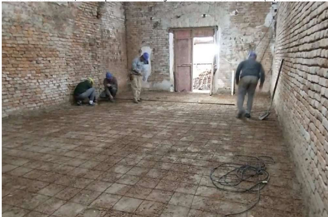
Foto 59 – Armadura para contrapiso nave principal.
