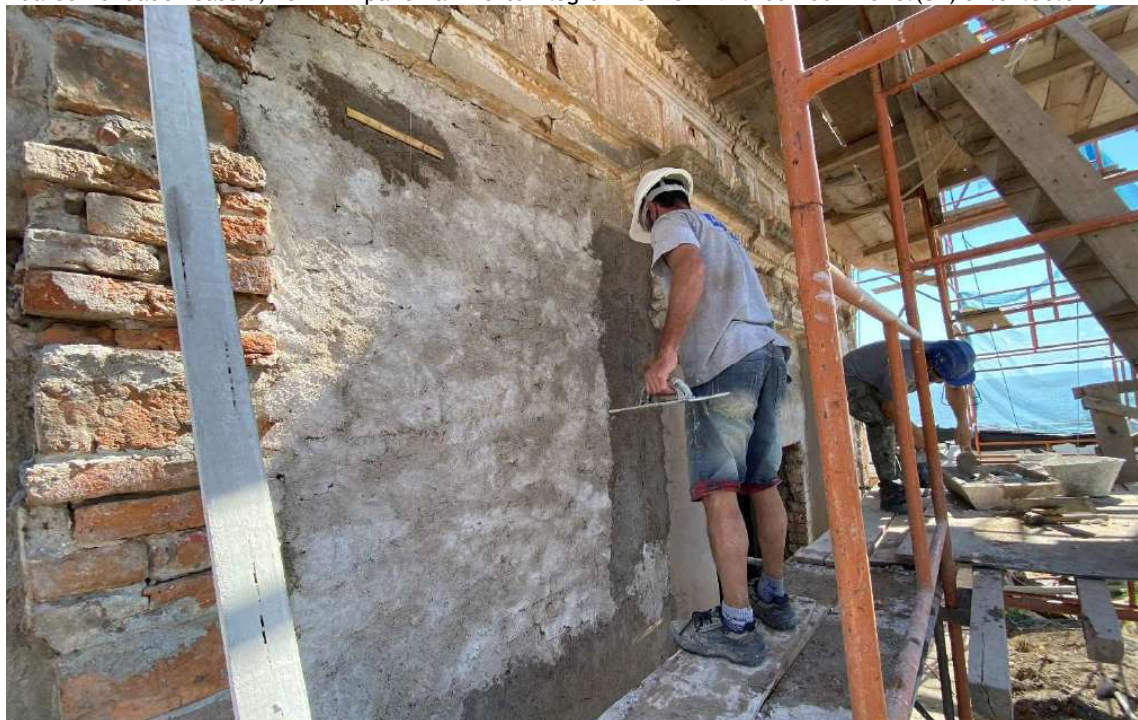
Foto 33 – Enchimento panos lisos e colocação de mestras.
