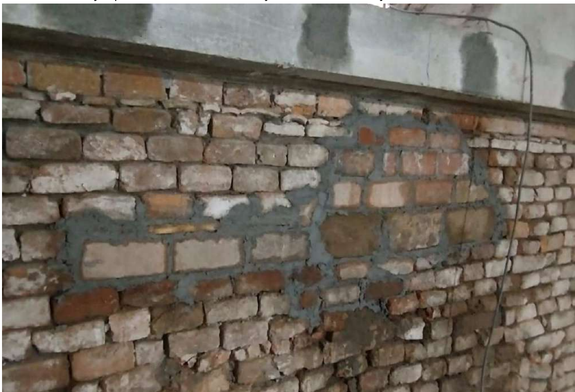
Foto 15 – Concretagem, grauteamento e fechamento com alvenarias.
