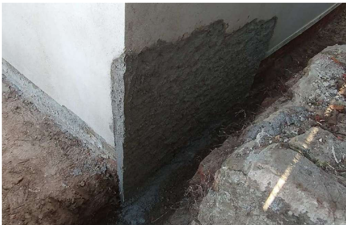
Foto 39 – Aplicação da argamassa transpirável.
