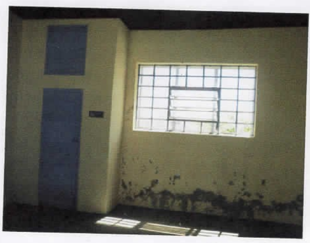
2 Esquadrias em madeira.
