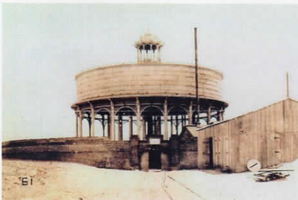
Foto histórica: Reservatório elevado concluído e edificação circular em tijolo à vista em construção Fonte: CORSAN/Sursul
