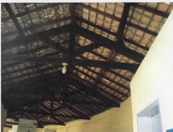
2 Tesouras de madeira com cobertura de telhas cerâmicas tipo capa e canal.
