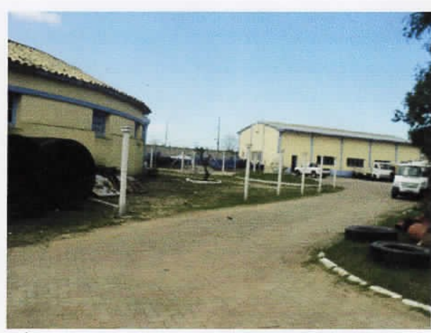
1 Pátio e acesso para veículos.
