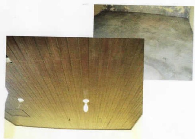
3 Piso cimento e forro em madeira tipo régua macho-fêmea.
