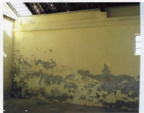
3 Paredes em alvenaria de tijolos maciços revestida com tinta amarela.
