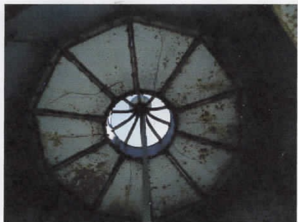
1 Detalhe do coroamento do Reservatório, (cúpula em ferro fundido).
