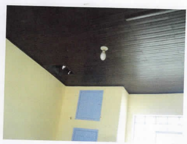
3 Forro em madeira tipo régua macho-fêmea. Detalhe do alçapão
