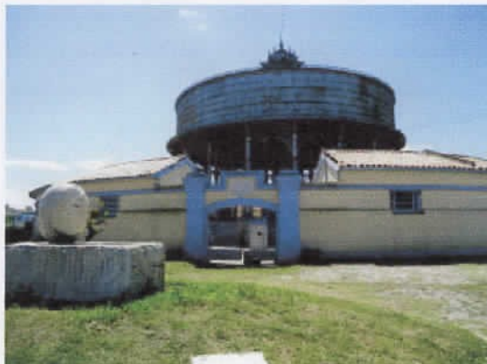
1 Pórtico de acesso à Hidráulica.
