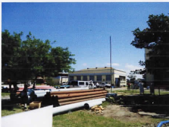
2 Prédio da Oficina em estilo Art Déco ainda preservado, térreo. Imagem IPHAE
