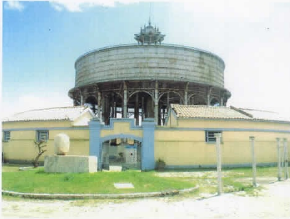
Vista geral do reservatório metálico de Rio Grande e edificação circular
