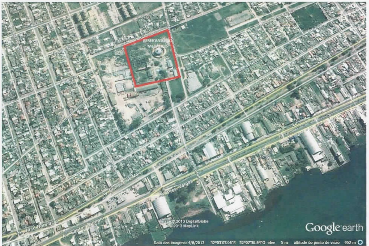
Reservatório metálico e Edificação periférica no terreno da Corsan
