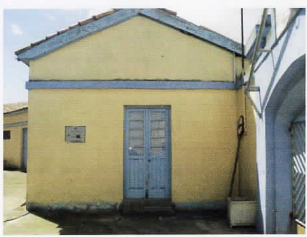
2 Área externa ao museu das águas. Esquadrias em madeira.
