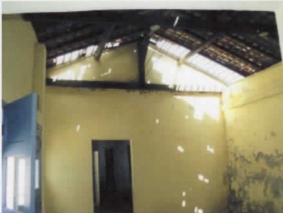
1 Bar e café. Detalhe do telhado.
