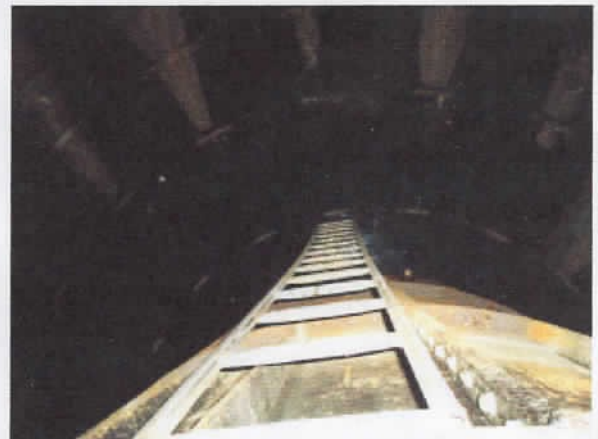
2 Escada de acesso ao fundo do Reservatório.
