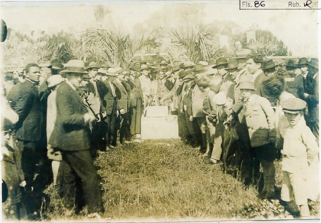
Lançamento da pedra fundamental do Theatro Independência
