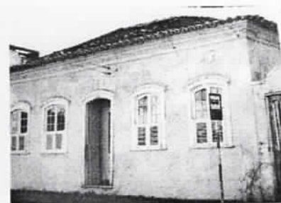
Figura 647: Casa já demolida na Rua Gonçalves Chaves. Fonte: http://www.flickr.com/photos/paralelo31/2729634777
