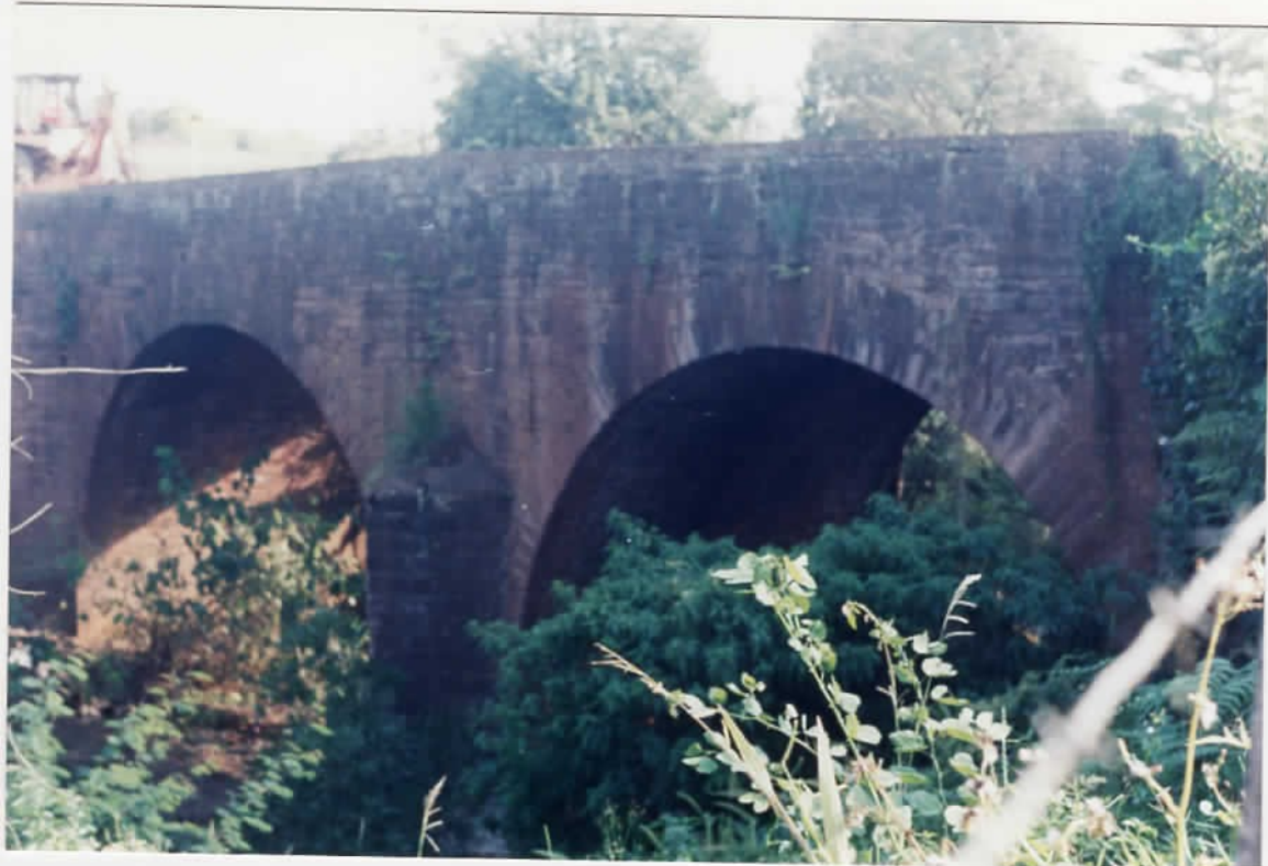
Ponte sobre o Arroio Feiteira - Dois Irmãos - RS
