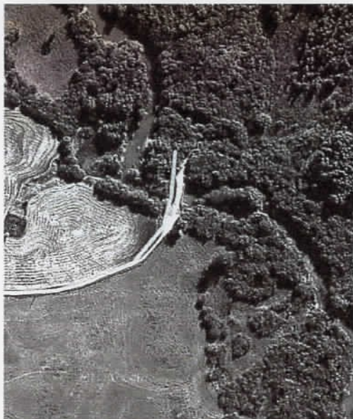
Acesso próximo à Estrada Ponte de Pedra
