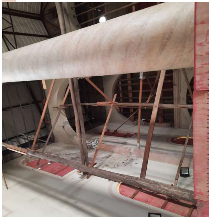
Imagem 48 - Vista do pé direito e as escoras da nave.
