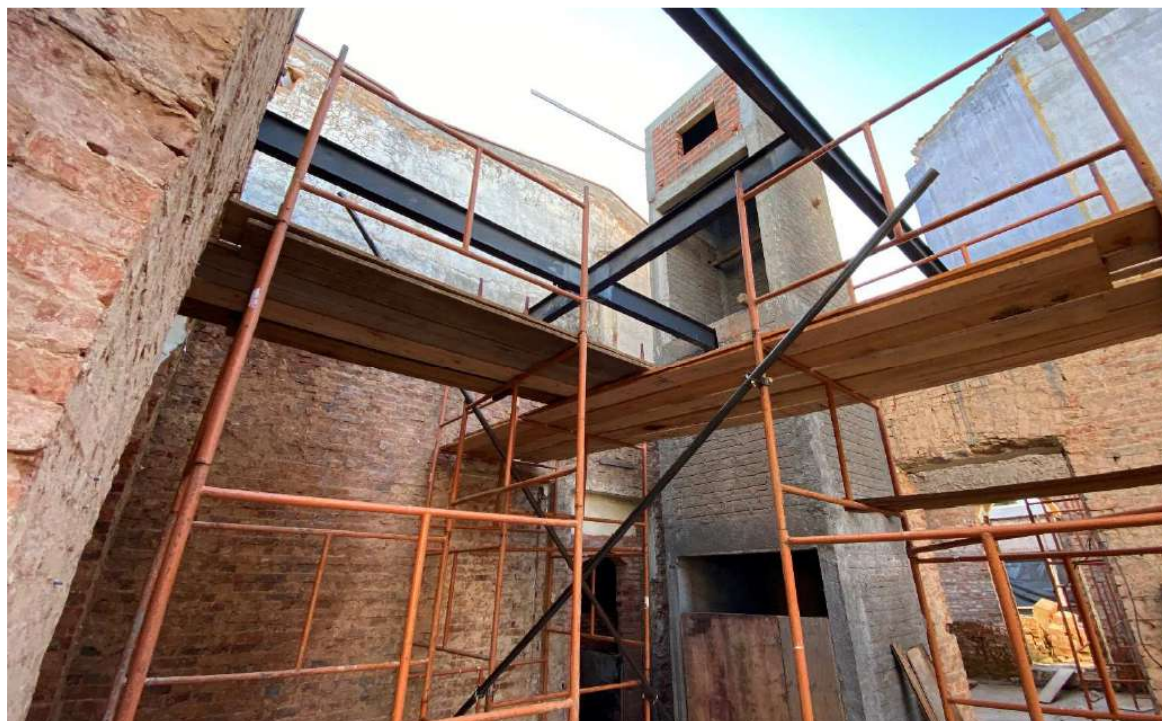
Foto 24 – Vigas metálicas apoio do barroteamento, serviço de solda das vigas.
