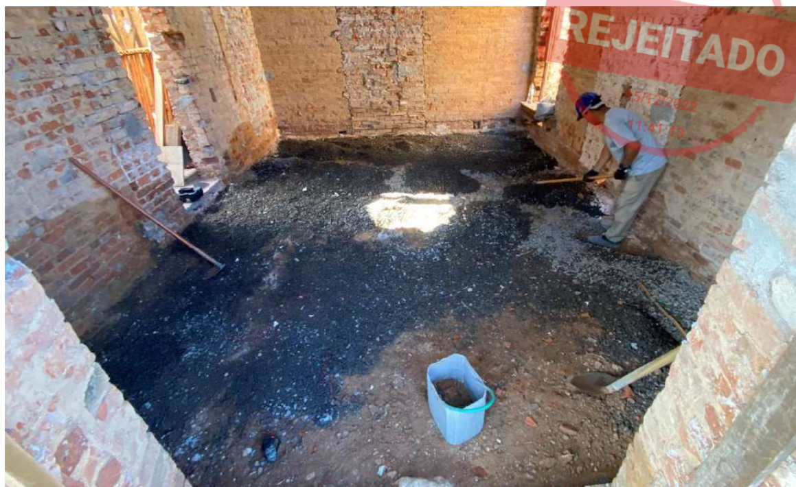
Foto 35 – Aterro concluído após compactação e colocando leito de brita do contrapiso.
