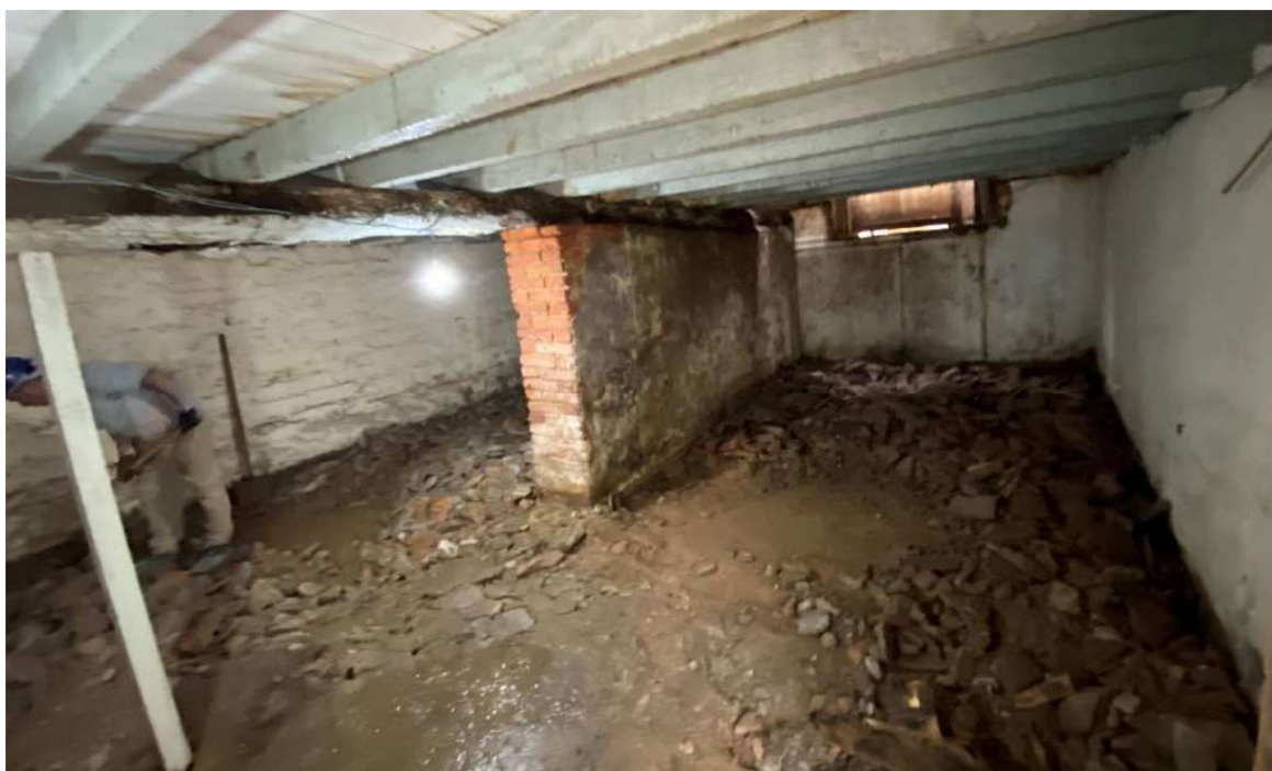
Foto 30 – Escavação do porão, e transporte aterro para salas arquivo histórico.
