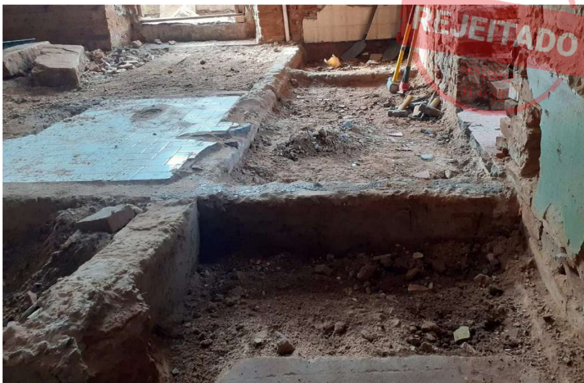
Foto 31 – Demolição de contrapiso, vigas de fundação, e aterro sala arquivo histórico.
