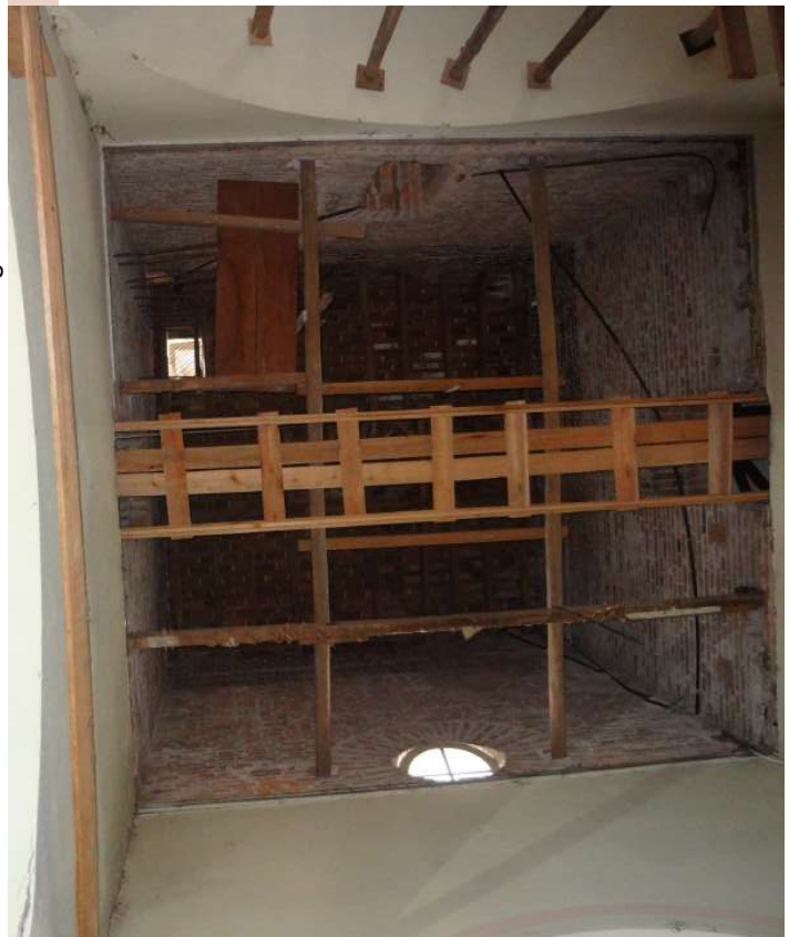
Imagem 97 - Vista para a torre.
