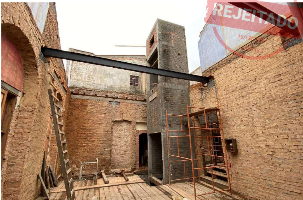
Foto 19 – Vigas metálicas apoio do barroteamento do entrepiso sobre os coxins.
