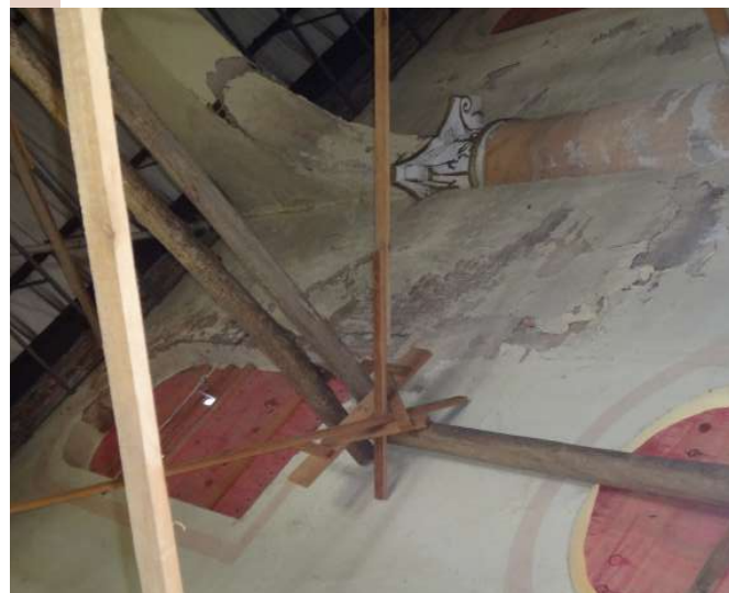
Imagem 51 - Detalhe da parede da fachada lateral.
