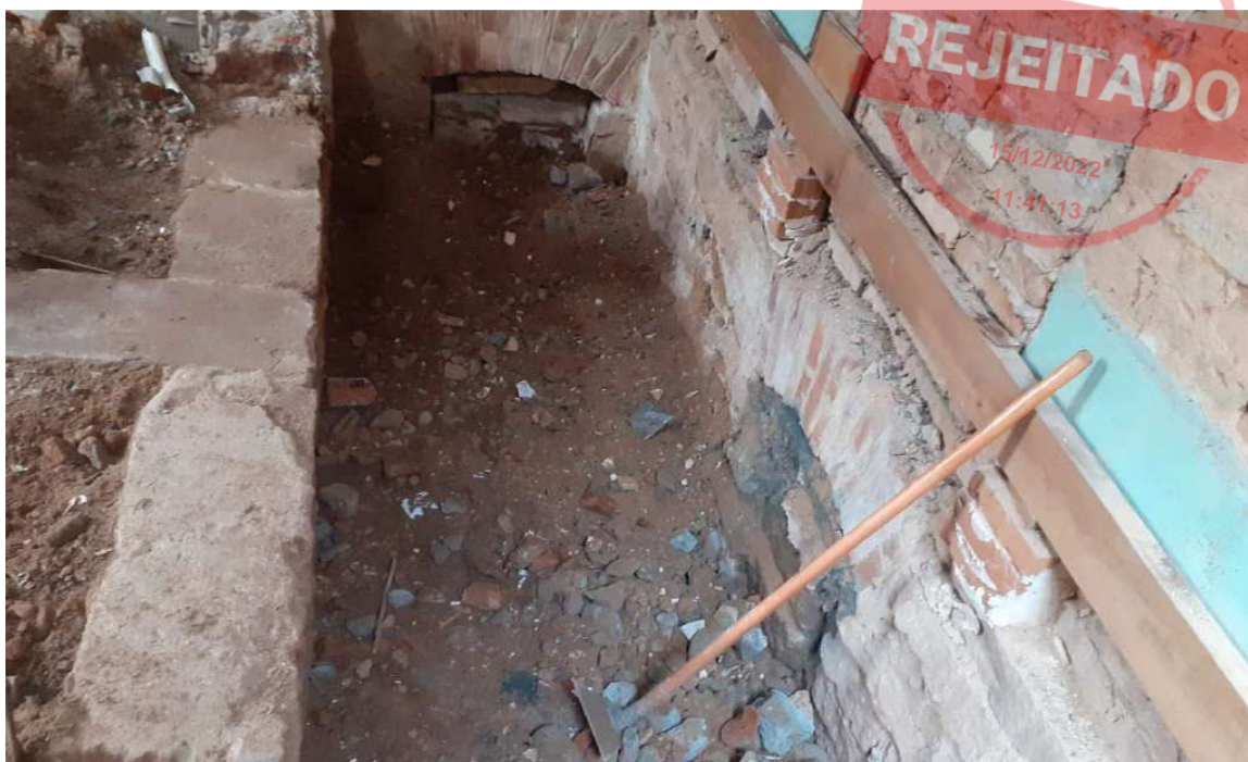
Foto 33 – Demolição de contrapiso, vigas de fundação, e aterro sala arquivo histórico.
