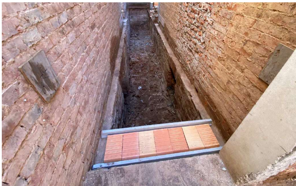
Foto 44 – Instalação de laje na circulação térreo.
