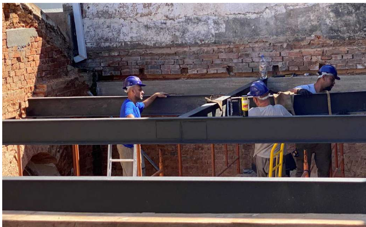
Foto 22 – Vigas metálicas apoio do barroteamento, serviço de solda das vigas.
