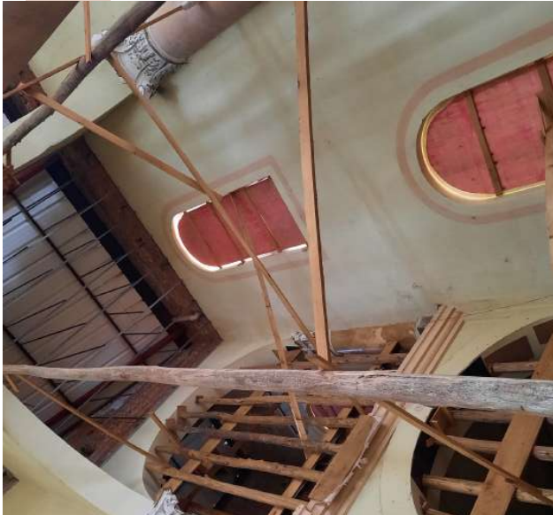
Imagem 53 - Vista ampla da nave.
