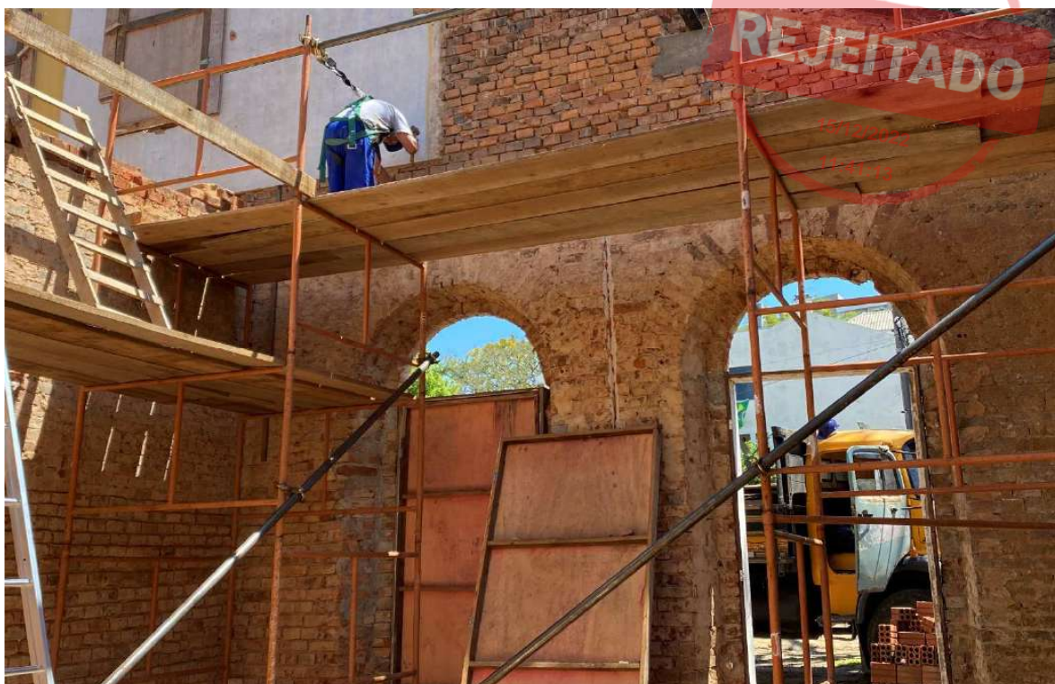
Foto 9 – Demolição parcial da alvenaria para execução das cintas e coxins, nível entrepiso.
