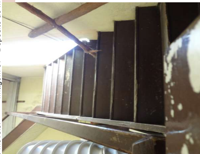
Imagem 69 - Vista da escada de acesso (bloqueado) a tribuna direita.
