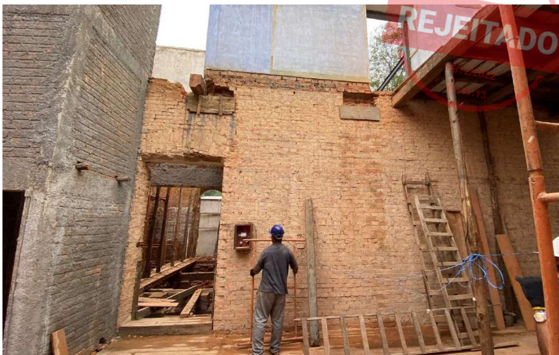
Foto 5 – Demolição parcial da alvenaria para execução das cintas e coxins nível entrepiso.
