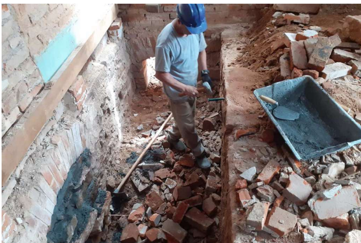
Foto 34 – Fechamento vãos internos e aterro sala arquivo histórico.
