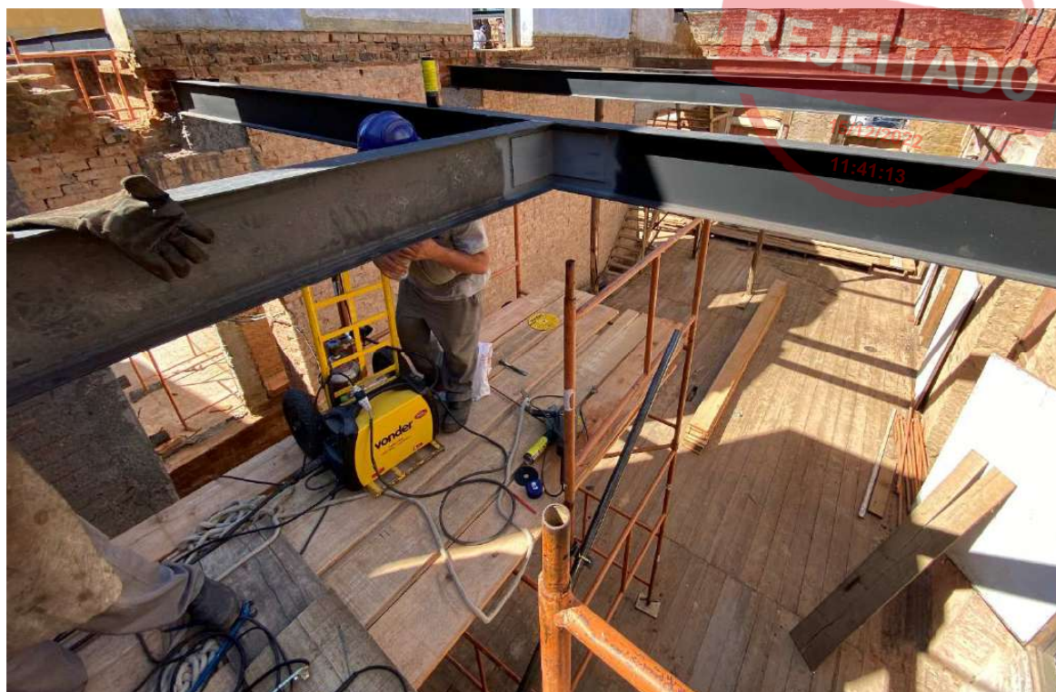
Foto 23 – Vigas metálicas apoio do barroteamento, serviço de solda das vigas.
