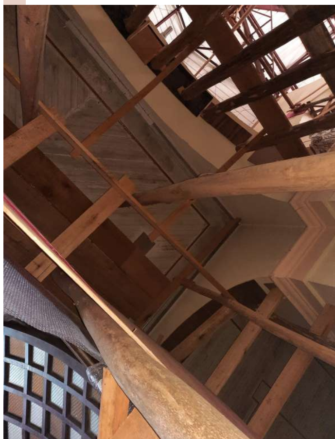
Imagem 29 - Detalhe do forro do ambiente.
