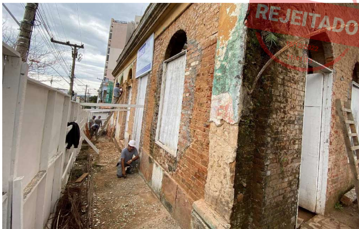
Foto 1 – Remoção revestimentos fachada Edmundo Saft.
