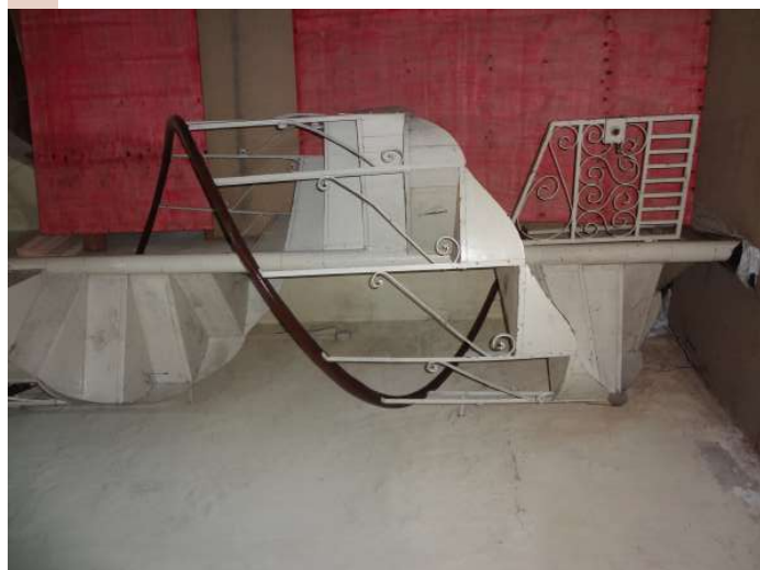
Imagem 34 - Escada de acesso ao Coro.
