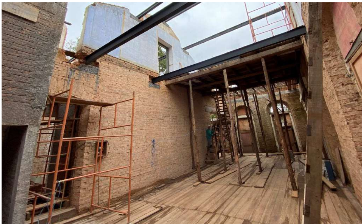
Foto 20 – Vigas metálicas apoio do barroteamento do entrepiso sobre os coxins.
