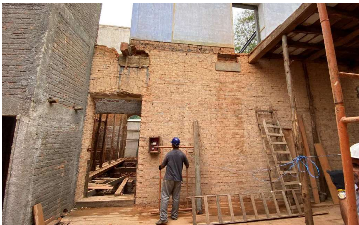
Foto 8 – Demolição parcial da alvenaria para execução das cintas e coxins, nível entrepiso
