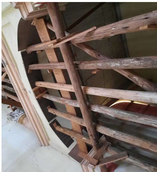
Imagem 32 - Detalhe das escoras no arco de acesso.
