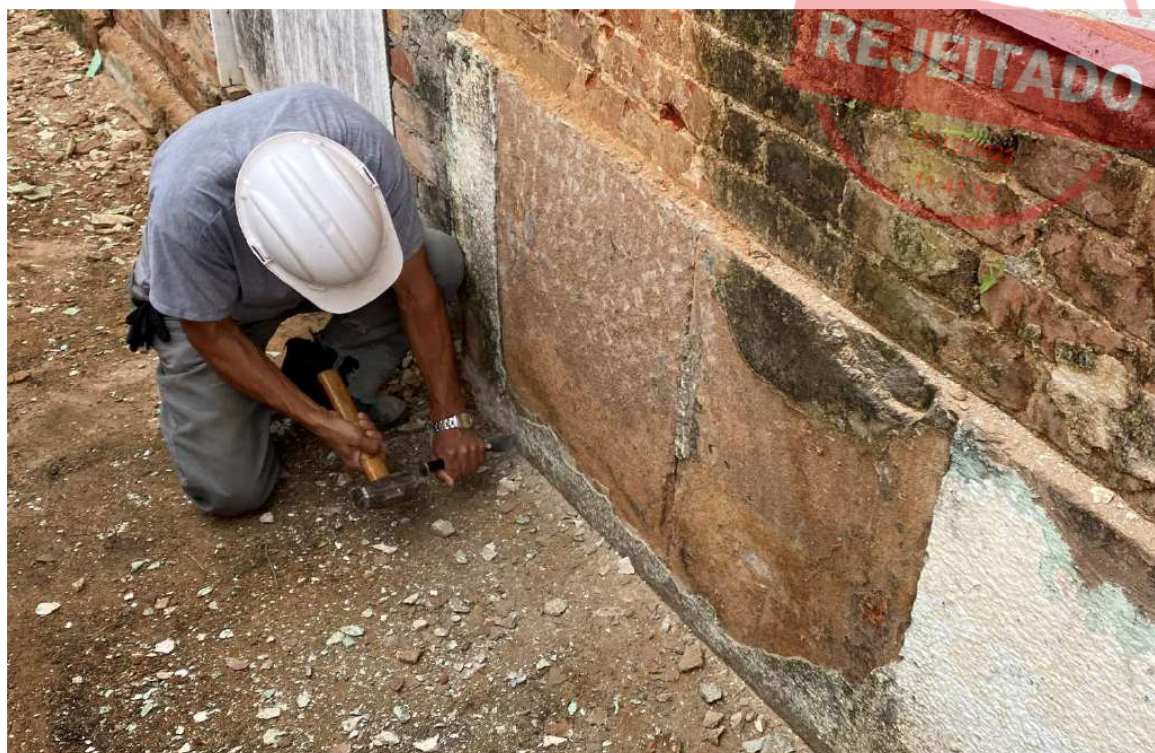
Foto 3 – Remoção revestimentos fachada Edmundo Saft.
