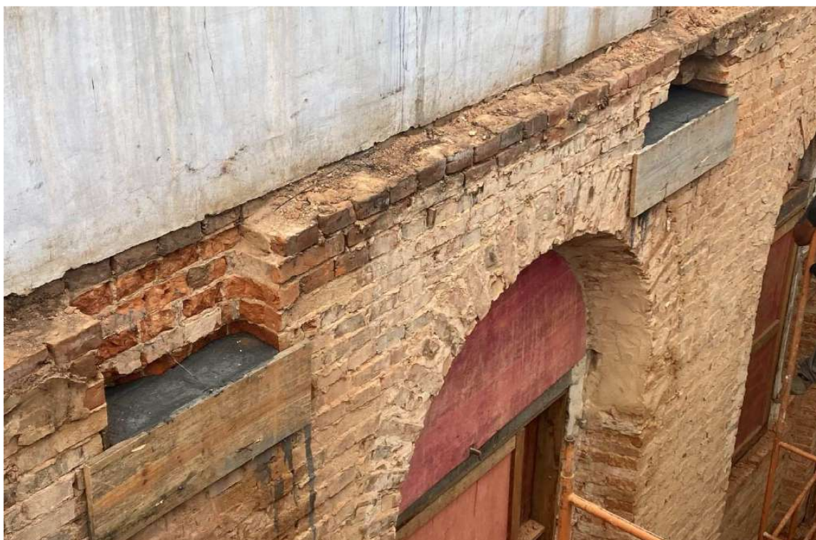
Foto 6 – Demolição parcial da alvenaria para execução das cintas e coxins, nível entrepiso
