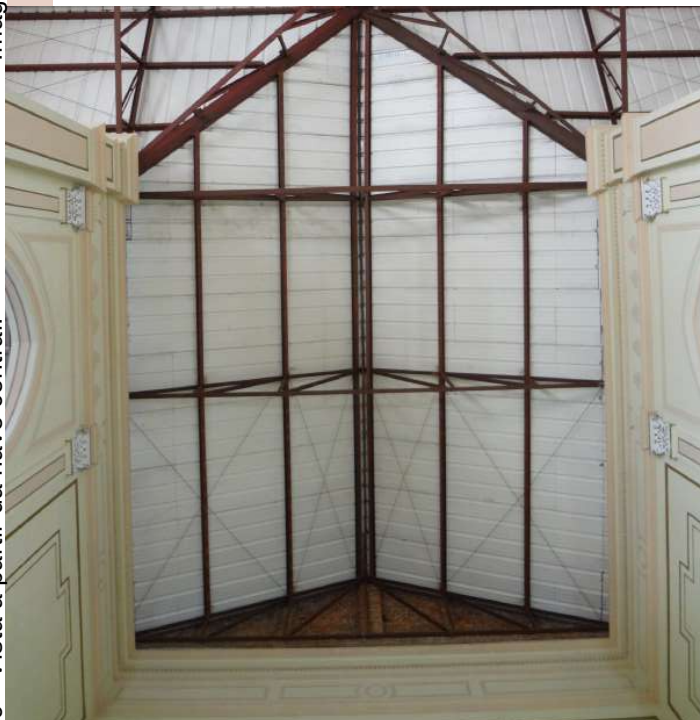
Imagem 62 - Estrutura do telhado acima.
