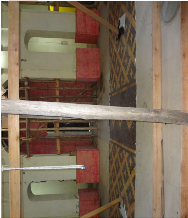
Imagem 39 - Vista a partir do tapume da área em obras.
