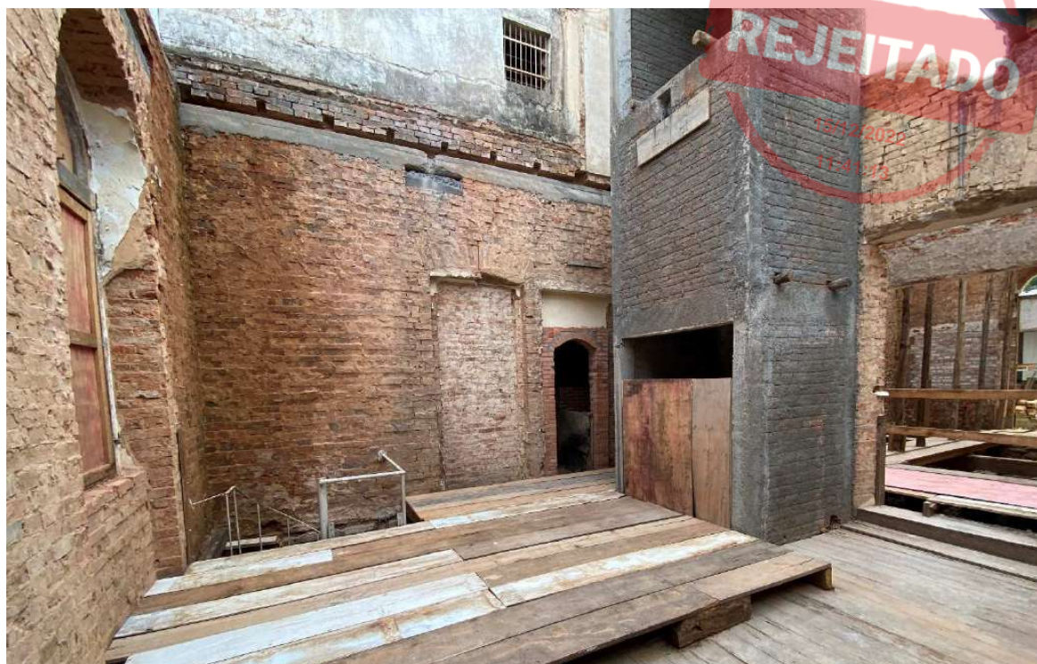
Foto 7 – Demolição parcial da alvenaria para execução das cintas e coxins, nível entrepiso
