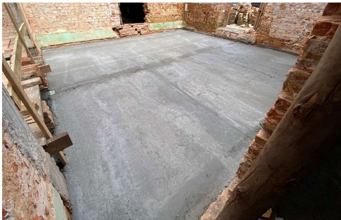
Foto 42 – Contrapiso executado sala do arquivo histórico.
