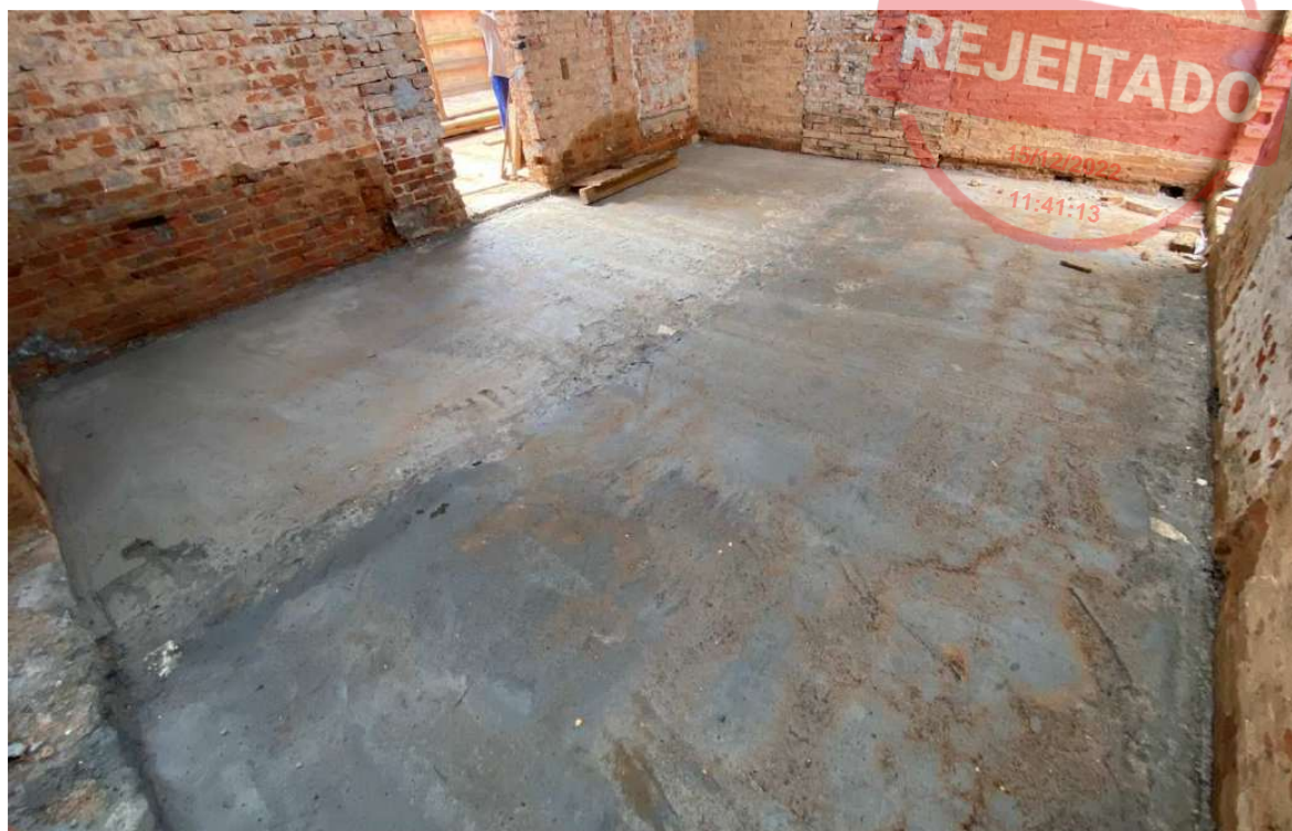
Foto 37 – Contrapiso de concreto pronto.
