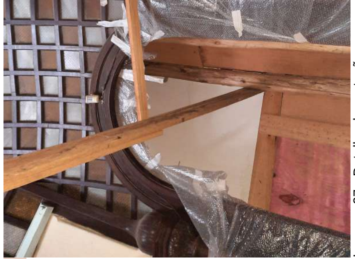
Imagem 27 - Detalhe da proteção aos ornatos.
