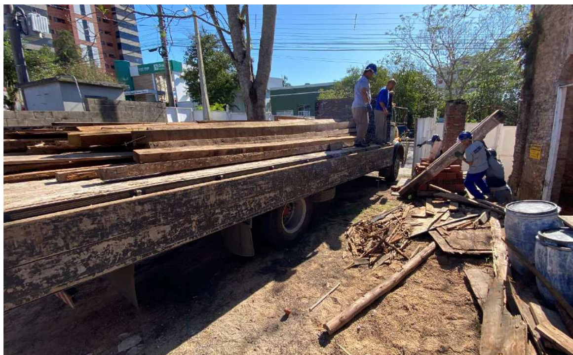
Foto 48 – Carga e transporte de entulhos e restos.
