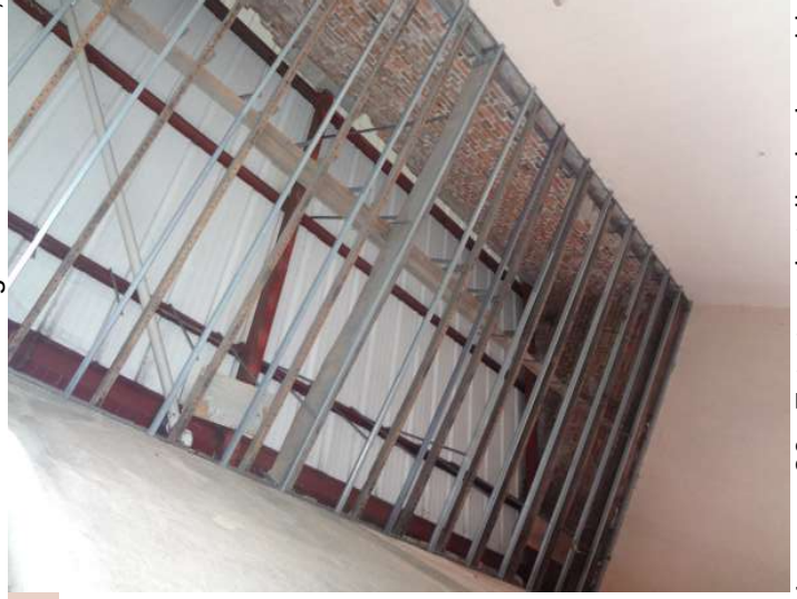
Imagem 86 - Estrutura do telhado do ambiente.
