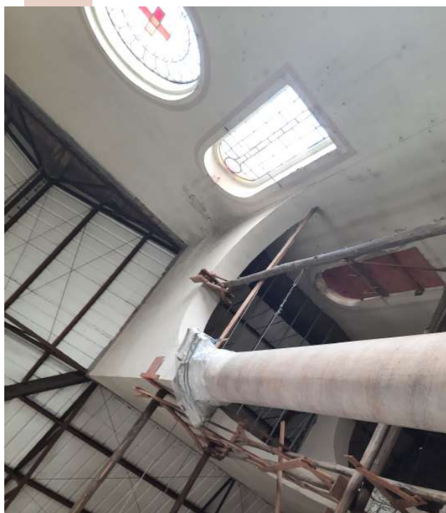
Imagem 56 - Estrutura do telhado e vitrais.
