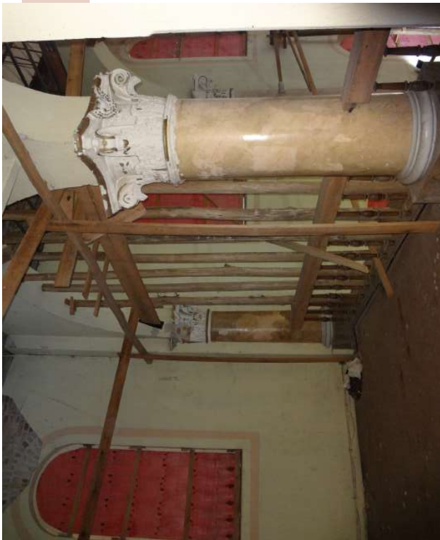
Imagem 95 - Detalhe coluna e escoras do lado esquerdo.
