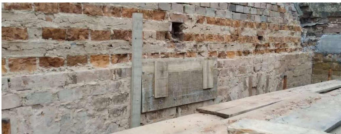
Foto 14 – Formas coxins apoio vigas metálicas.
