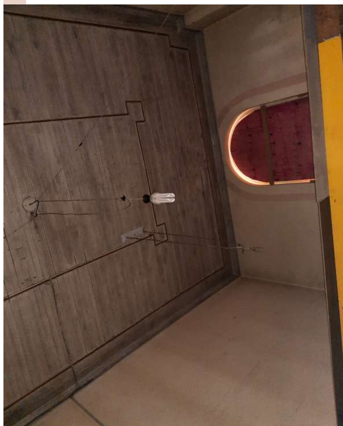
Imagem 37 - Forro e instalação elétrica do ambiente.
