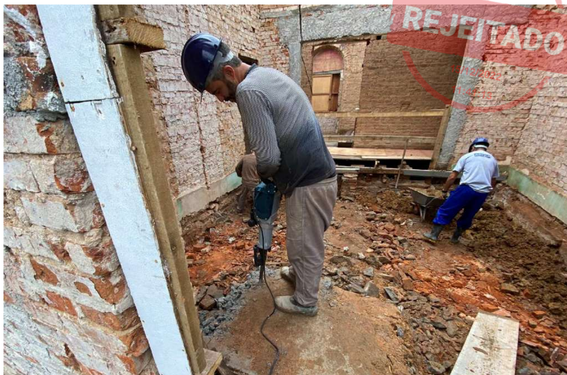
Foto 39 – Demolição de base de concreto, aterro e compactação.
