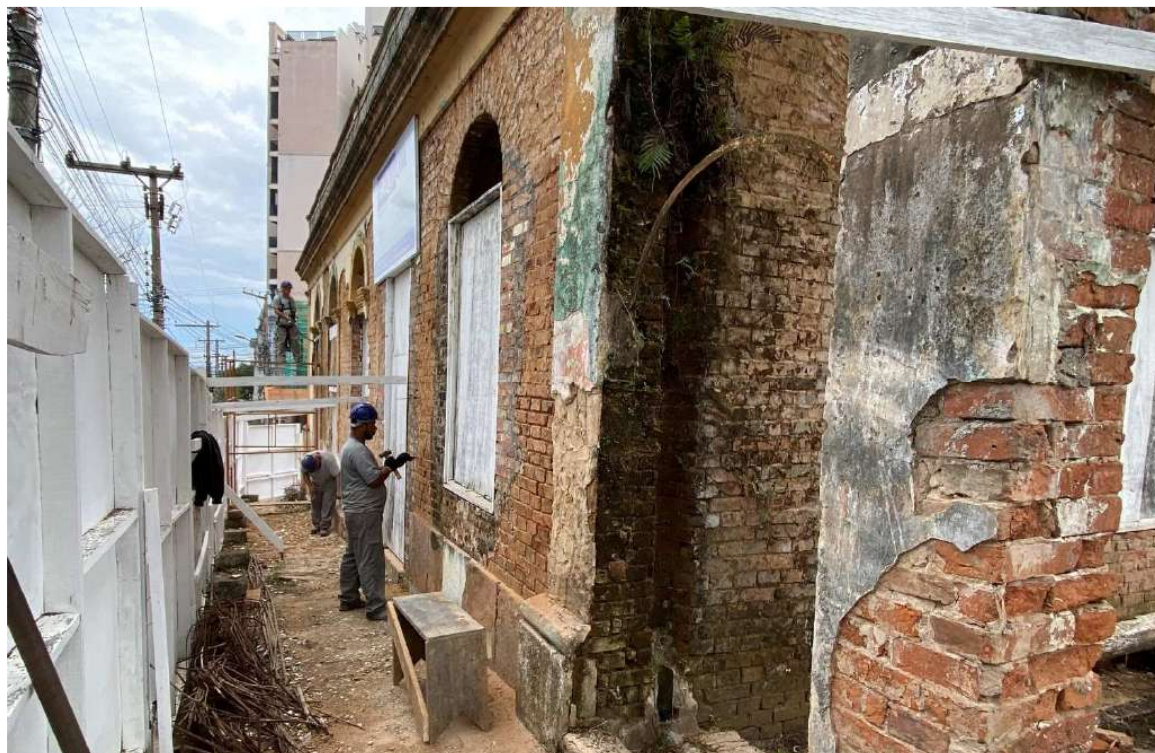
Foto 4 – Remoção revestimentos fachada Edmundo Saft
