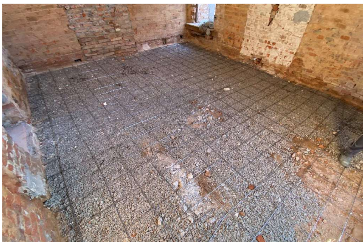
Foto 36 – Armadura do contrapiso colocada.
