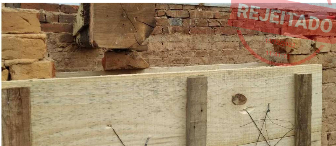
Foto 13 – Formas Coxins apoio vigas metálicas.
