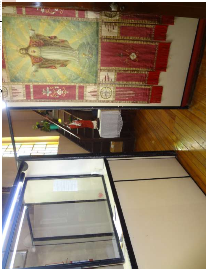
Imagem 76 - Vista da divisória leve que separa a secretaria do restante da sacristia.
