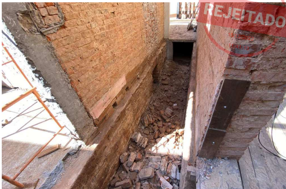
Foto 43 – Preparação alvenarias para laje circulação.
