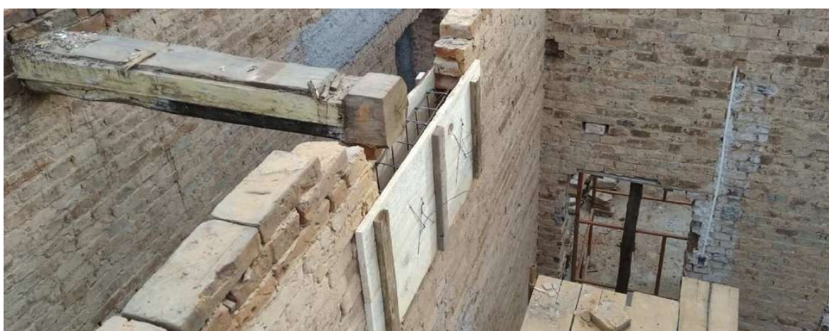
Foto 15 – Formas coxins apoio vigas metálicas.
