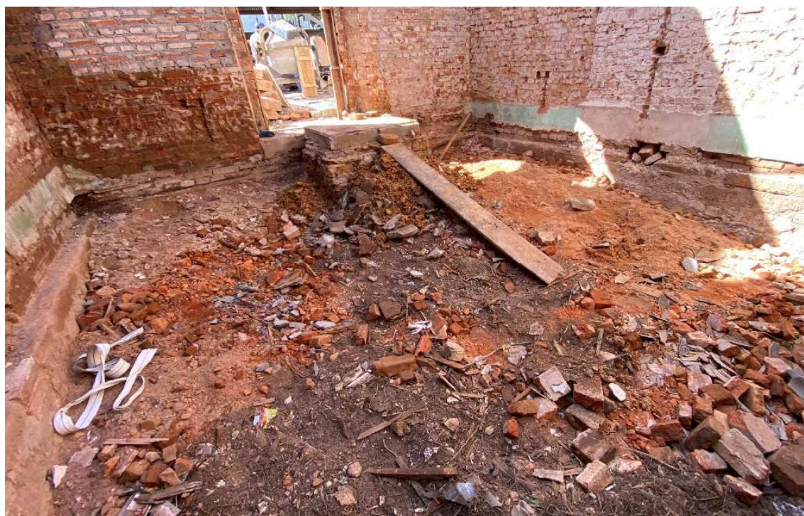
Foto 38 – Aterro e compactação sala arquivo histórico.
