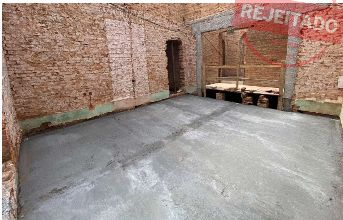
Foto 41 – Contrapiso executado sala do arquivo histórico.
