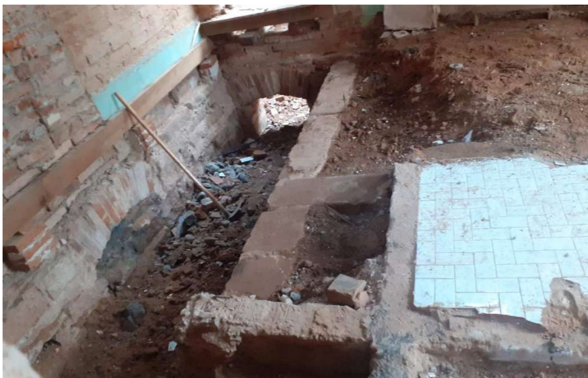
Foto 32 – Demolição de contrapiso, vigas de fundação, e aterro sala arquivo histórico.
