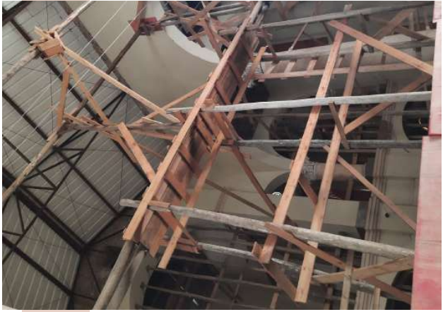
Imagem 40 - Vista das escoras.
