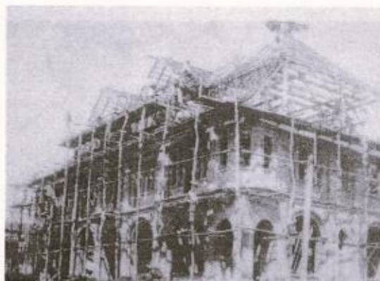
Edifício Sctorck em construção/ 1929 Fonte: Museu Detalhe: Alvenaria de tijolo maciço.
