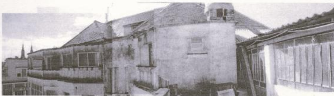
Panorâmica: Fachada Oeste
