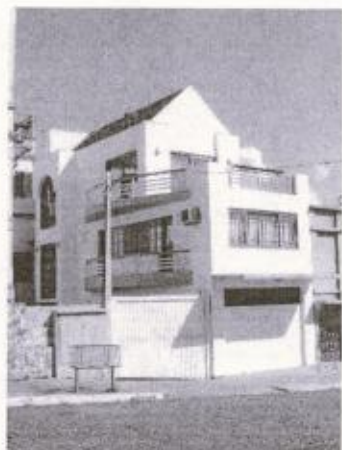
Anexo Posterior: Edifício Seibt Arquiteto: Júlio Ramos Fonte: Autora
