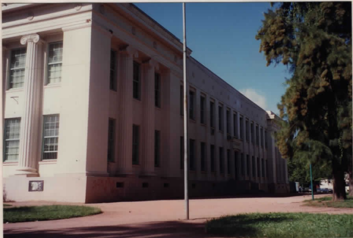
VISTA LATERAL DIREITA DO PRÉDIO DO 1º E 2º GRAU JUNTO A AV. PAULO GAMA
