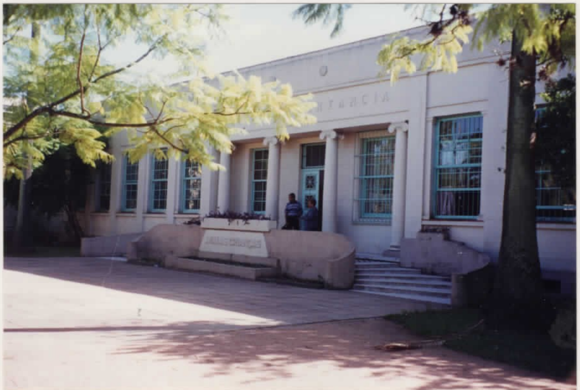
PRÉDIO DO JARDIM DE INFÂNCIA - ACESSO ELEVADO MANTÉM OS ELEMENTOS FORMAIS UTILIZADOS NO PRÉ- DIO PRINCIPAL ADAPTADOS PARA SUA DIMENSÕES MAIS REDUZIDAS.
