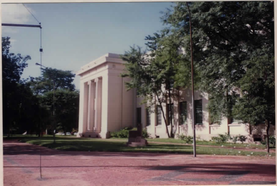
EXTREMIDADE DA FACHADA A AV. OSWALDO ARANHA O CORPO AVANÇA EM RELACÃO AO ALINHAMENTO.
