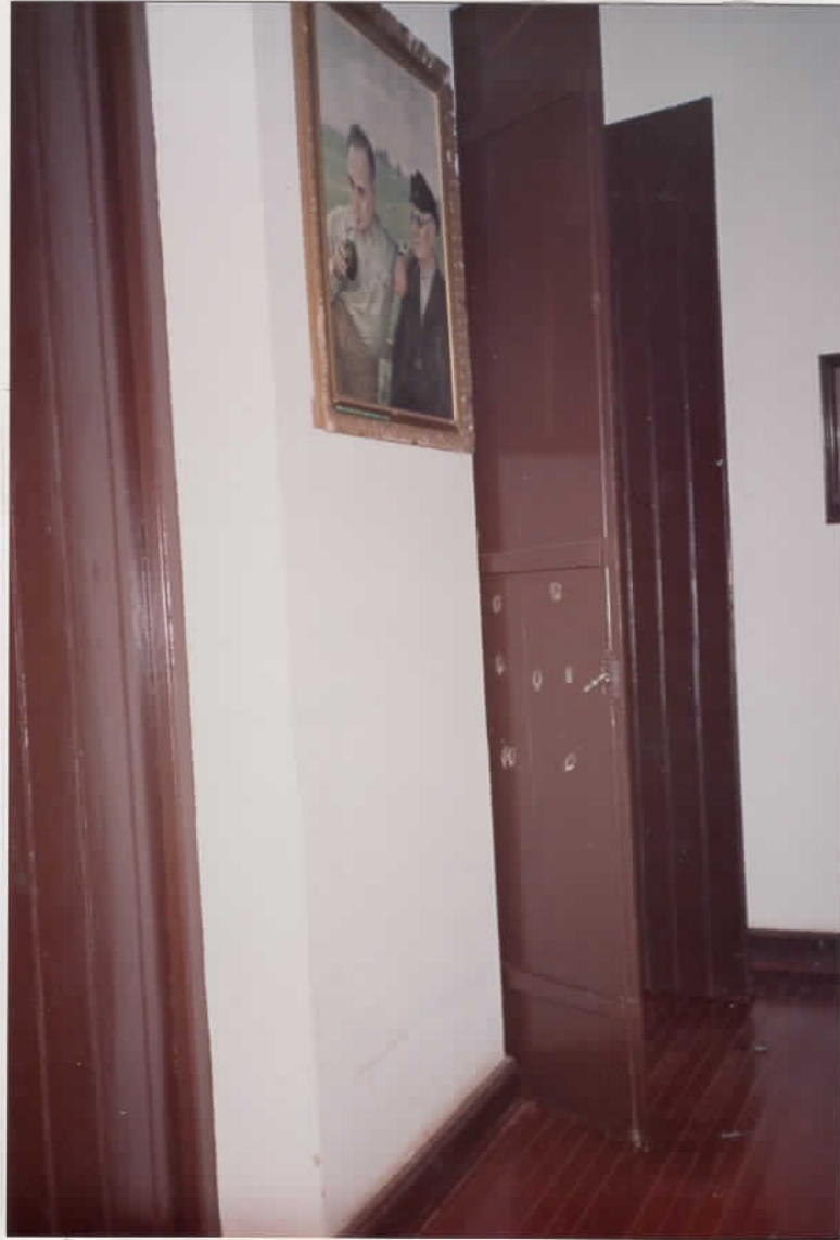
09 • VISTA DAS PORTAS DO TIPO TABUADO RELHADAS, QUE SEPARAM A ÁREA SOCIAL DA ÍNTIMA.
