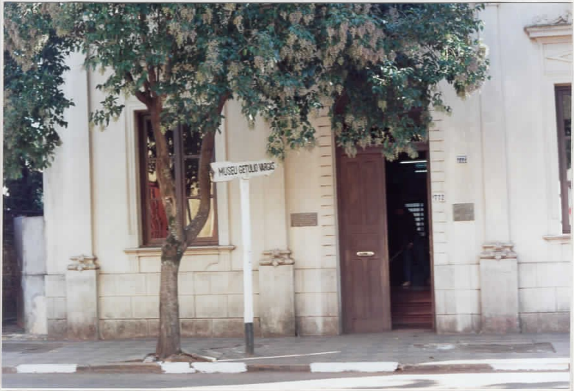
15 • FOTO DO LIGUSTRO, CUJAS RAÍZES DANIFICAM A CALÇADA E CUJA COPA IMPEDE A VISIBILIDADE DO IMÓVEL.
