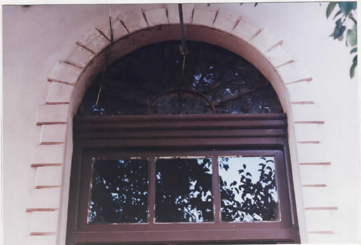
04 • DETALHE DA BANDEIRA FIXA DA PORTA DE ENTRADA
