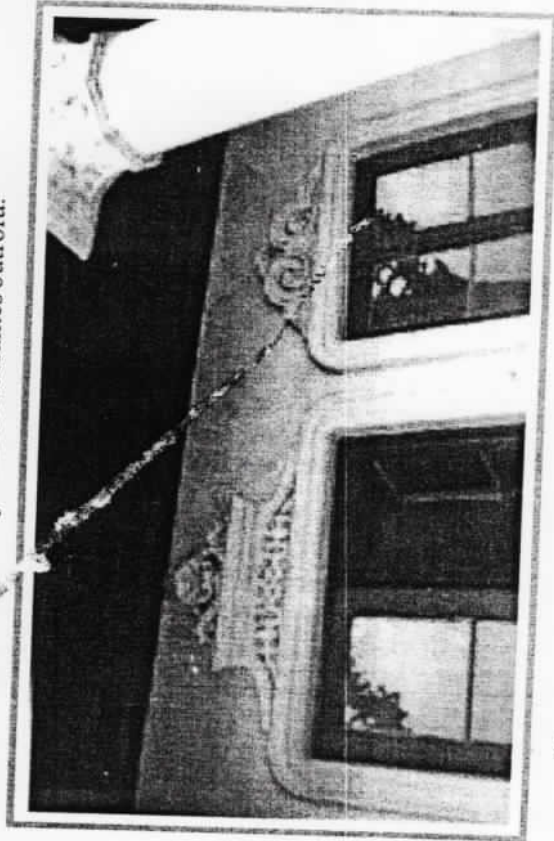
Vergas nas esquadrias que têm molduras em massa lisa, apliques de massa moldada nas pestanas, tudo em estilo mourisco.
