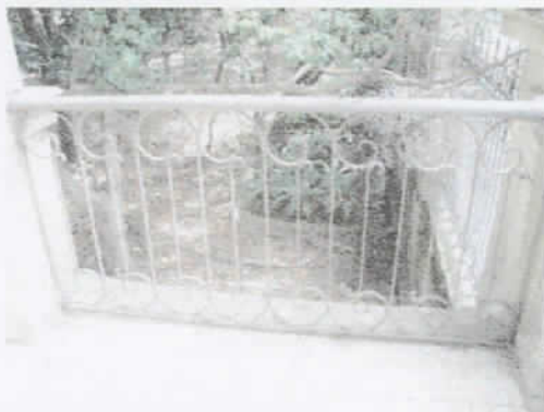
Foto 49- Detalhe do guarda corpo
