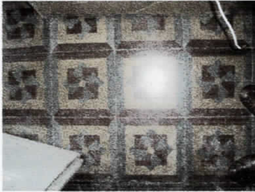
Foto 29- Detalhe do piso
