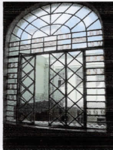
Foto 26- Det. Esquadria de ferro
