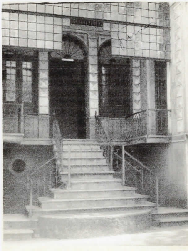
Figura 1 – Aspecto externo do Palacete Pedrinho Osório.
