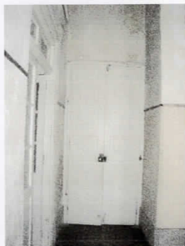
Foto 37- Detalhe da esquadria
