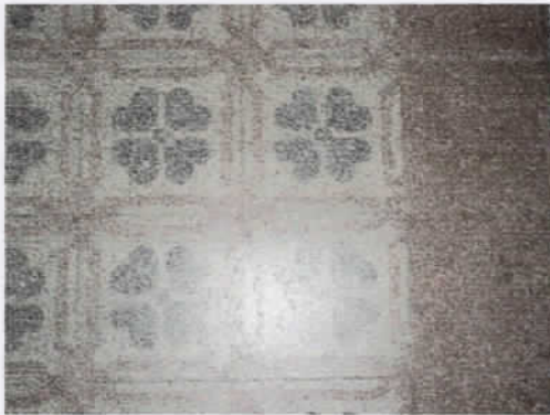
Foto 25- Detalhe do piso
