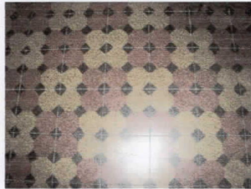
Foto 42- Detalhe do piso
