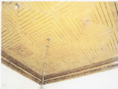
Foto 18- Detalhe do forro
