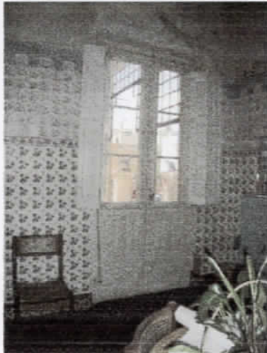
Foto 41 - Detalhe da esquadria
