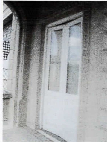
Foto 11- Detalhe de esquadria externa
