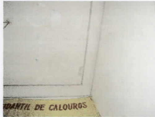
Foto 40- Detalhe do forro
