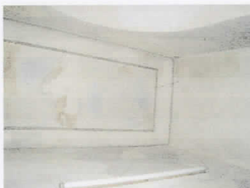
Foto 38- Detalhe do forro
