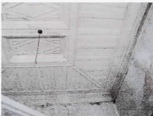
Foto12- Detalhe do forro
