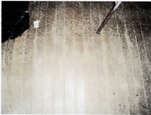
Foto 34- Detalhe do piso
