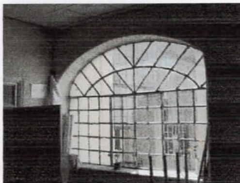
Foto 46- Detalhe da esquadria
