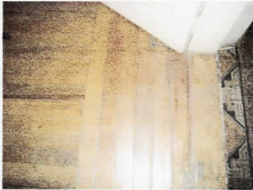
Foto 8- Detalhe do piso
