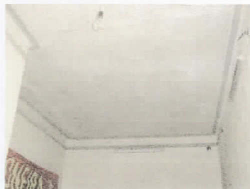
Foto 28- Detalhe do forro
