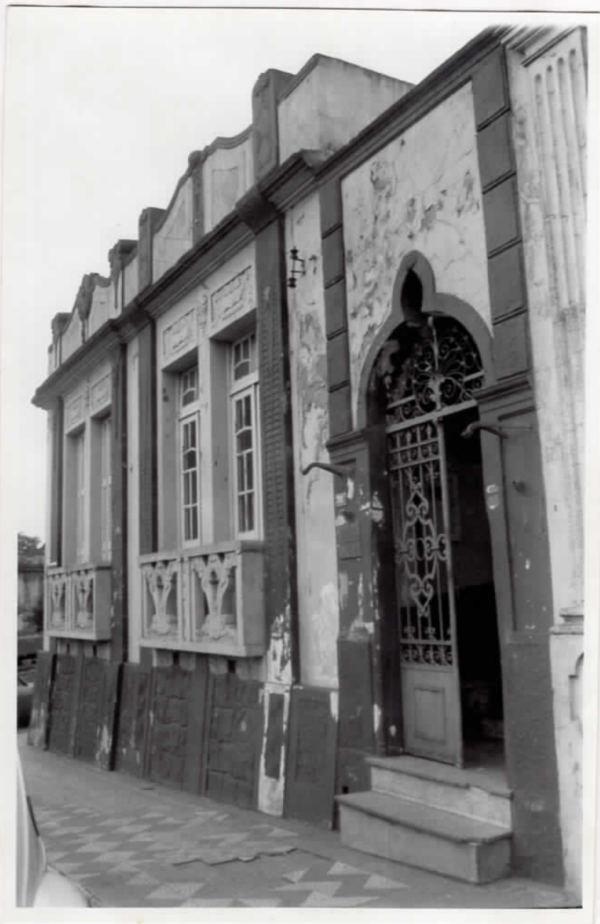
Entrada principal do Museu Érico Veríssimo. Av. Gal. Osório 380 lado norte
