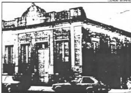
Ameaça em Pelotas: a casa de Simões Lopes Neto pode ser demolida
