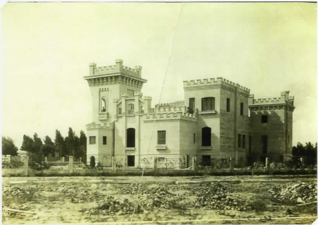
Castelo, no final de suas obras.
