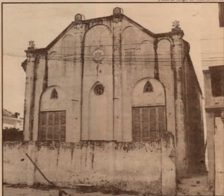
Deterioração: templo típico da arquitetura judaica sofre ação do tempo
