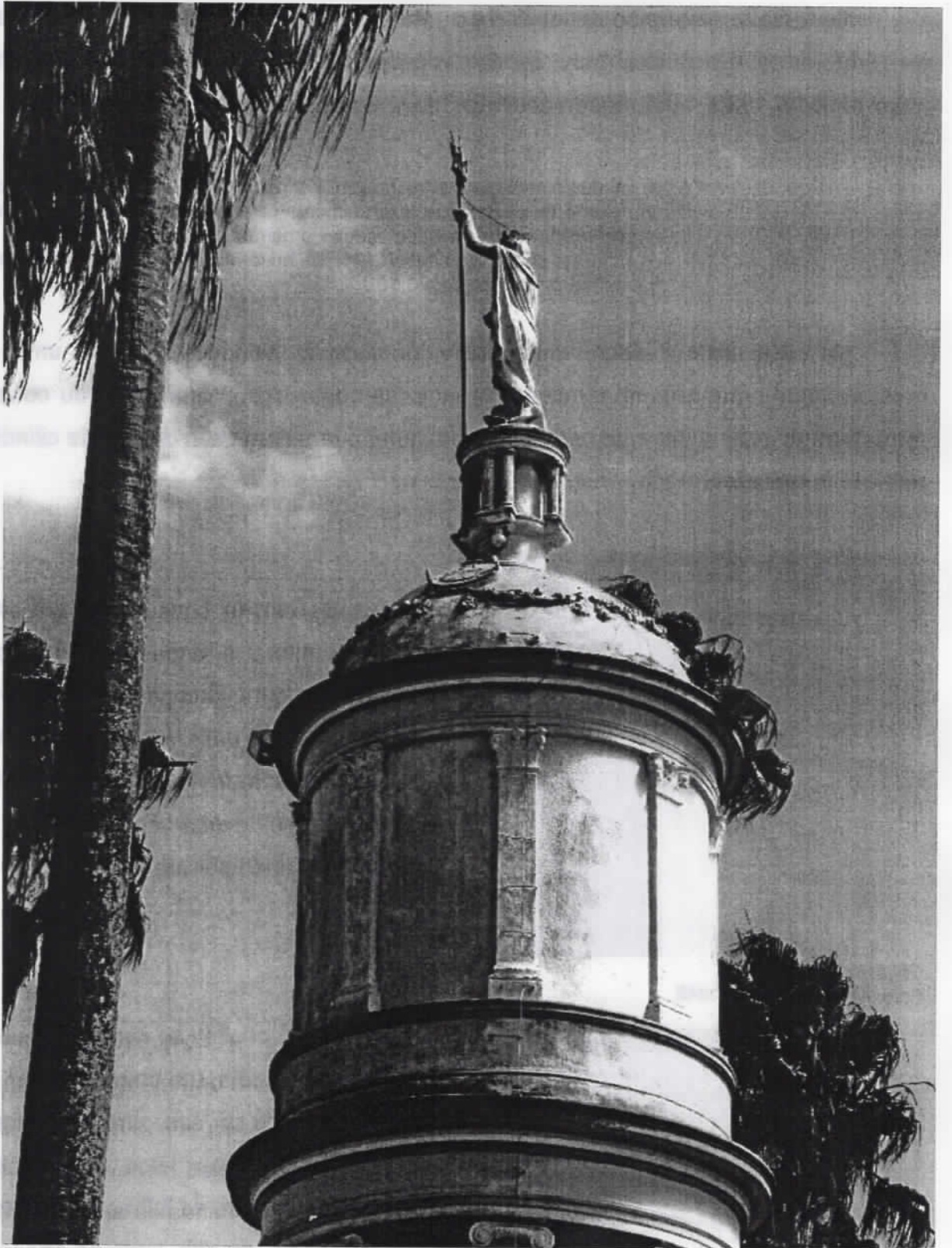
Terceiro piso: reservatório Foto: Regina G. Buss
