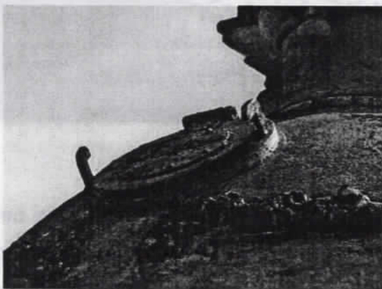
Tampa de acesso ao reservatório Foto: Regina G. Buss
