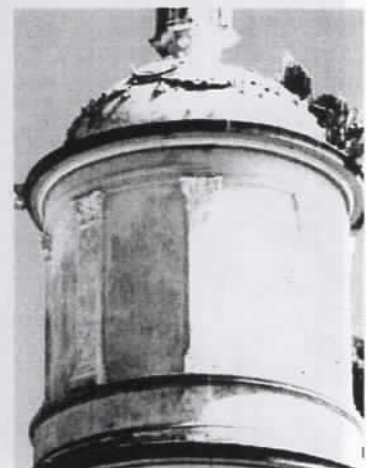
Cúpula do reservatório Foto: Regina G. Buss
