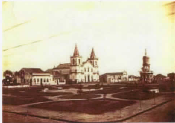
Figura 24 Vista oeste da praça. Acervo COMPAHC/Museu Municipal, sem data.
