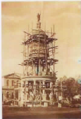
Figura 18 Construção do Chateau D' Eau. Acervo COMPAHC/Museu Municipal.
