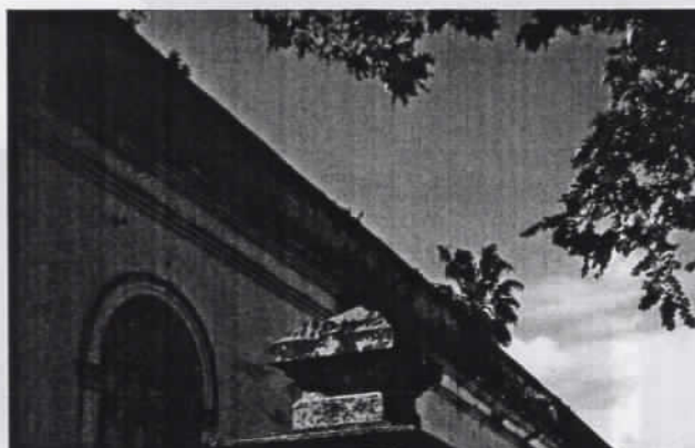
Platibanda lateral da Prefeitura, com vegetação Foto: Nelda Scheidt
