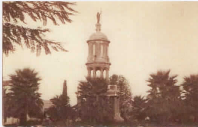
Figura 21 Vista do Chateau em meio a vegetação da Praça Balthazar de Bem. Acervo COMPAHC/Museu Municipal, sem data.
