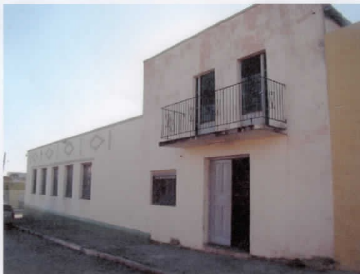
Foto da fachada lateral do clube – Rua General Marques
