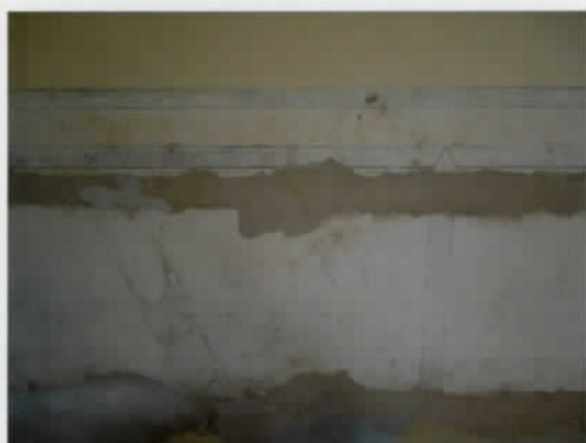
1 Escaiolas - Hall de entrada, à esquerda
