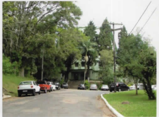
4 Vista do acesso principal e escadaria
