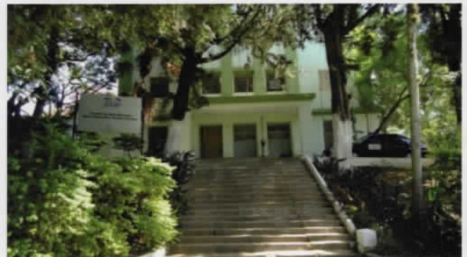
2 Escadaria de acesso ao prédio
