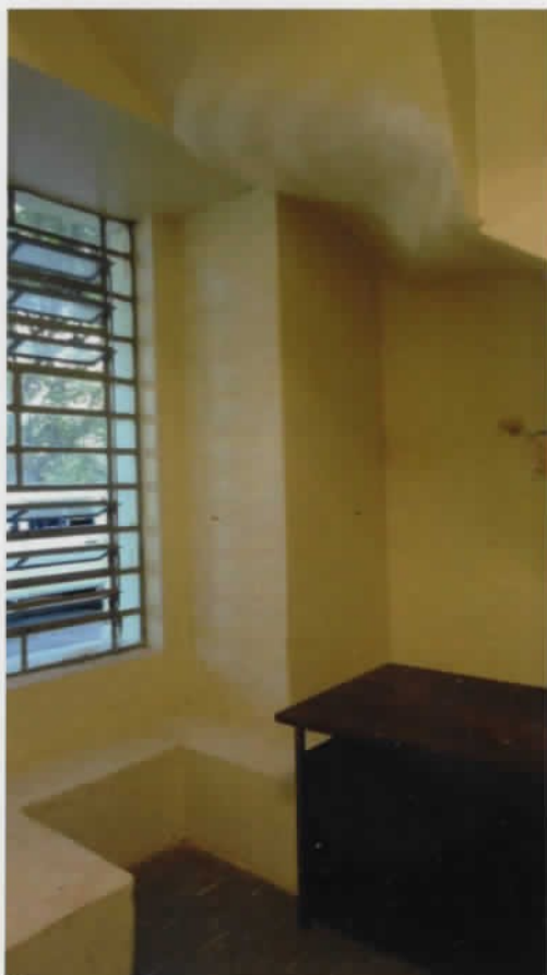
1 Espaço no térreo, observando-se a espessura das paredes originais
