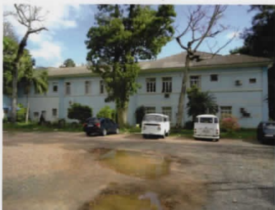
3 Lateral esquerda do prédio
