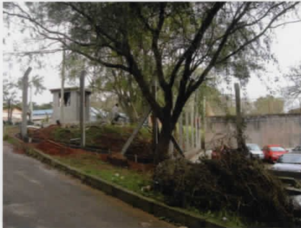
1 Estacionamento Prédio CASE
