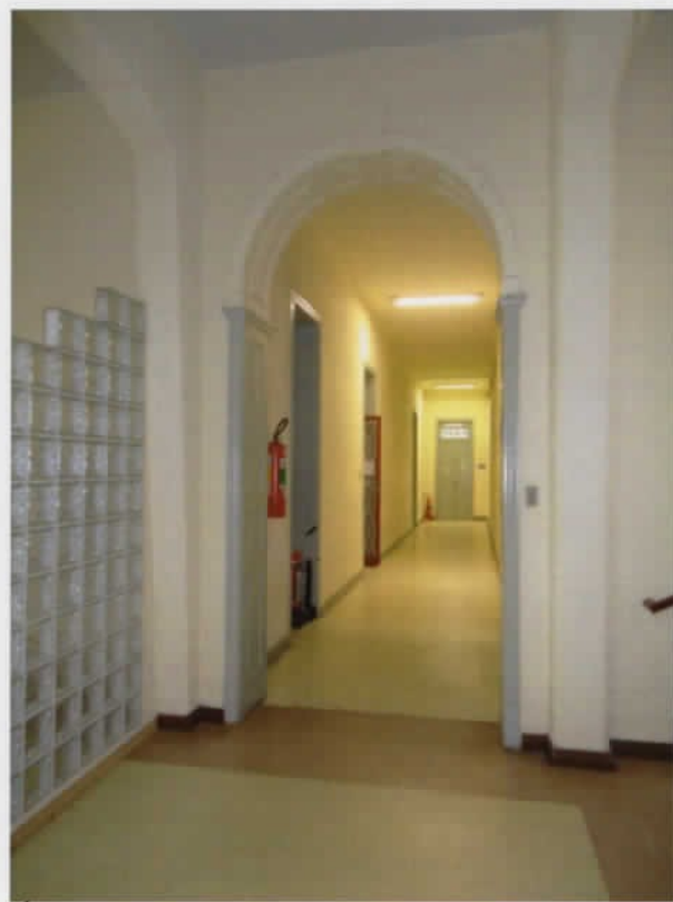
1 Corredor térreo - Vãos em arco pleno com elementos ornamentais e portas de madeira originais
