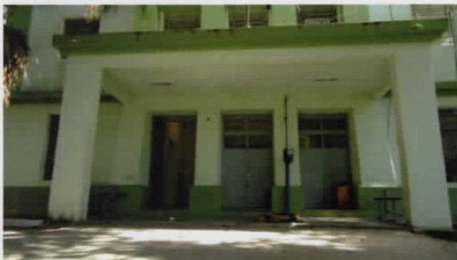
1 Pórtico com acesso principal
