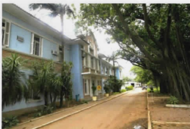
4 Fachada principal e arborização junto à rua
