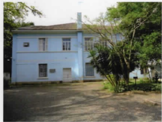
2 Lateral direita do prédio - vista do telhado
