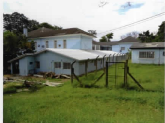
4 Prédio térreo nos fundos, à direita
