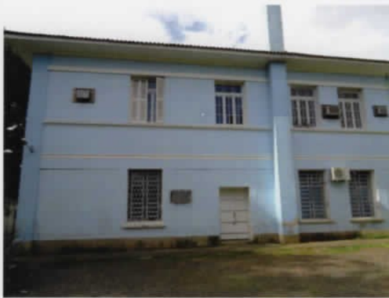
1 Lateral direita do prédio - descaracterizada por aparelhos de ar cond.
