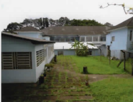
1 Prédio térreo nos fundos
