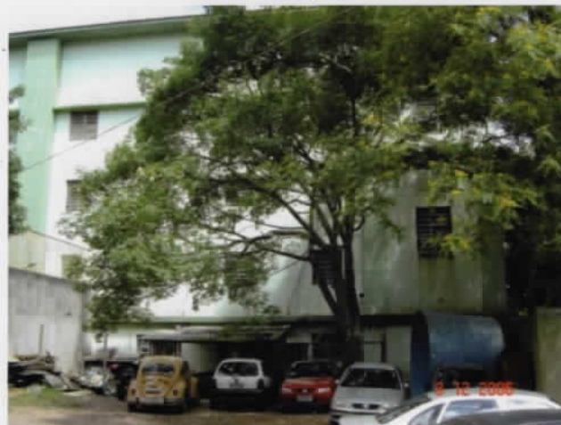
2 Lateral esquerda do prédio
