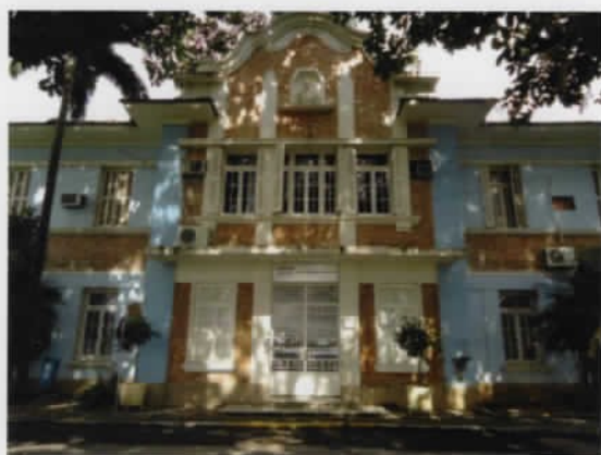
1 Fachada principal - detalhe
