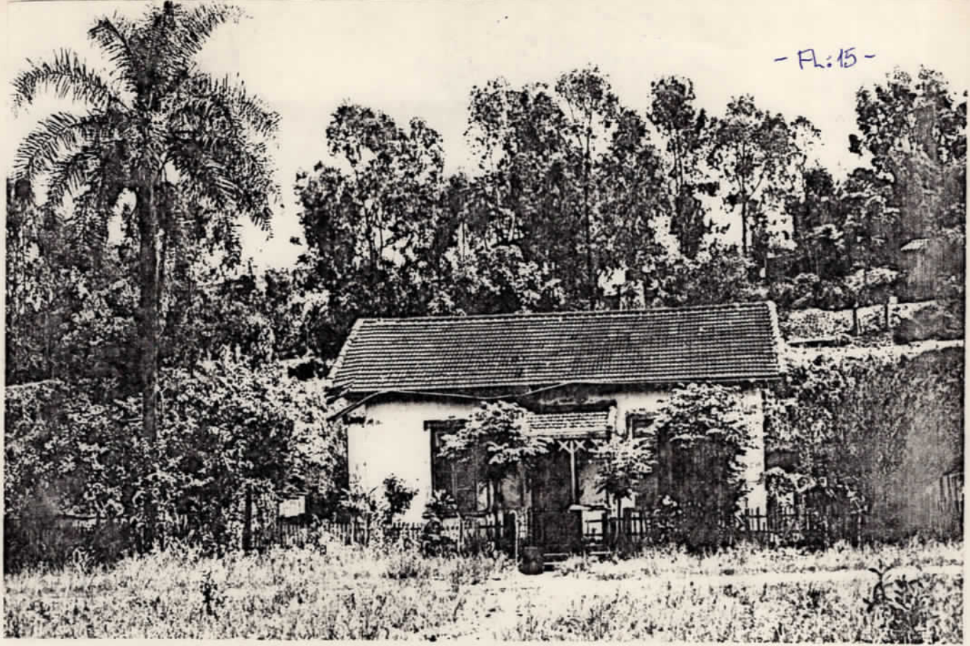
e) Residência de Ferroviários
