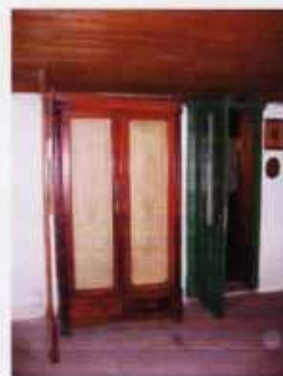
Sala Felizardo Júnior, com piso de cimento e forro de madeira.
