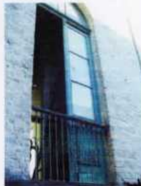
Lado externo: duas folhas com caixilhos de vidro e guarda-corpo de ferro
