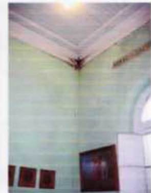
Forro e rodaforno em madeira
