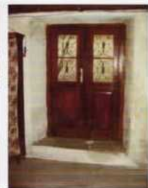
Sala Felizardo Jr. Esquadrias de madeira e vidro, com grade de ferro.
