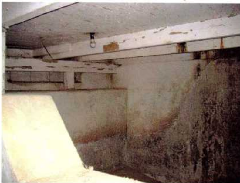
F15 Detalhe do Setor de Vinificação, no Pavimento Térreo.
