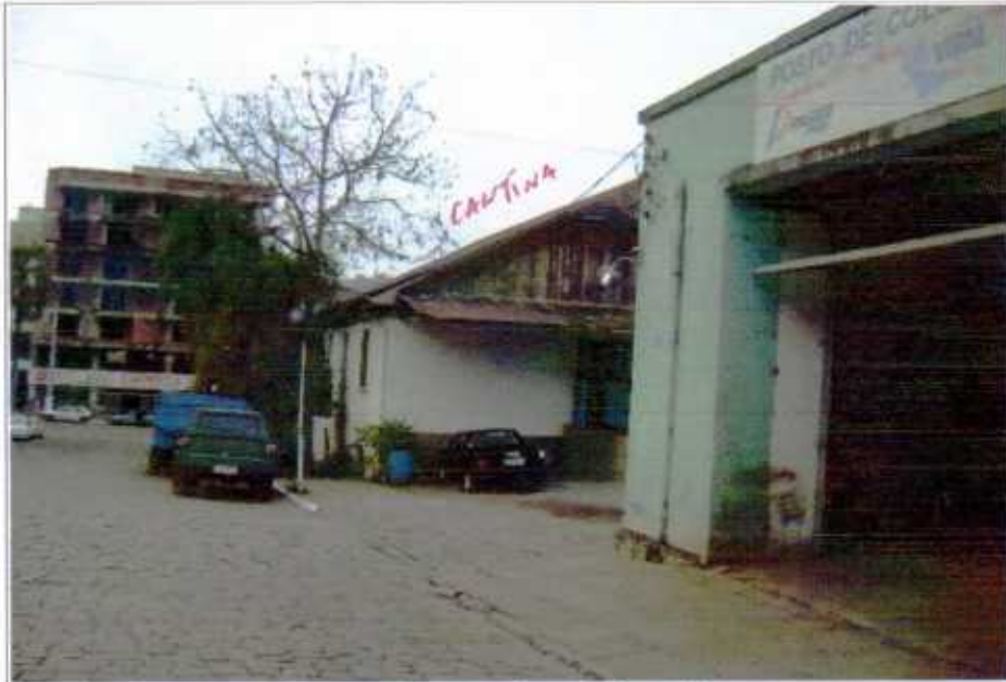
Imagem 05: vista lateral do prédio;
