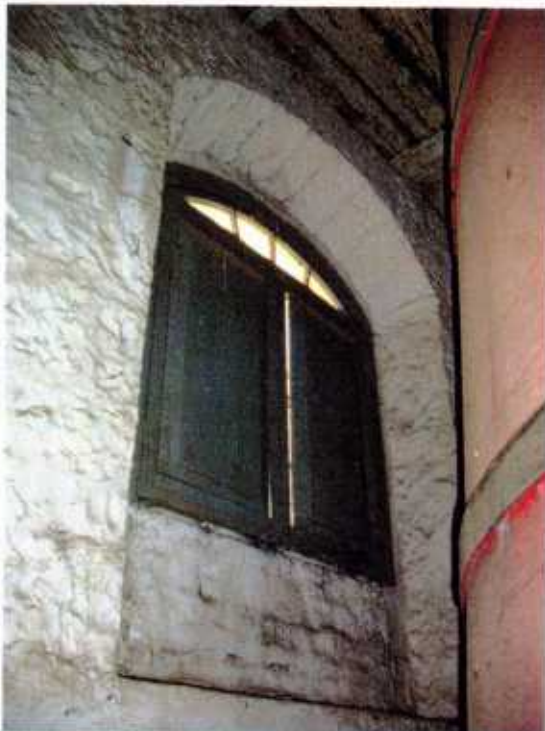
F18 Vista interna da esquadria do Pavimento Térreo.
