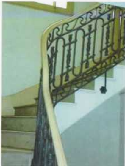
F10. Escada revestida de mármore com guarda-corpo de ferro.
