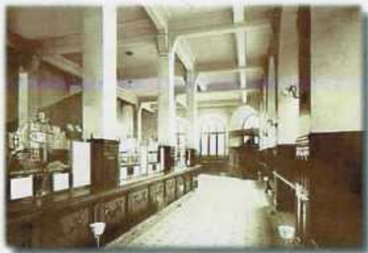
F8. Interior do prédio do Banco Pelotense. S/ data.
