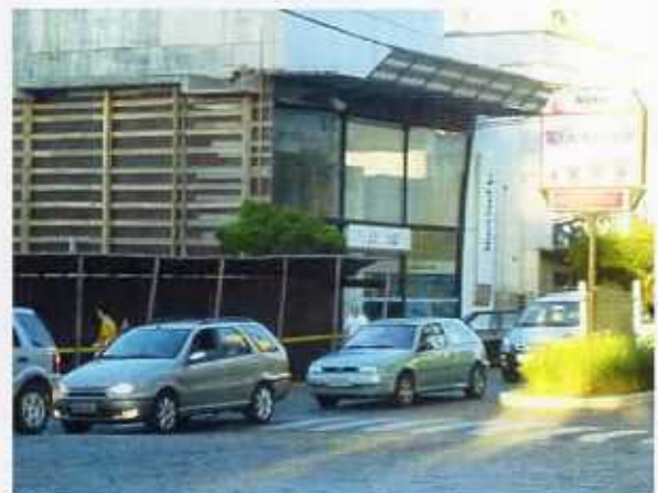
F5. Novo prédio comercial e Agência Bannisul em construção no mesmo endereço dos prédios anteriores, 08/12/2013.
