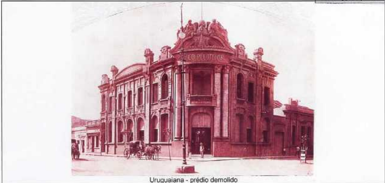
Uruguiana - prédio demolido
