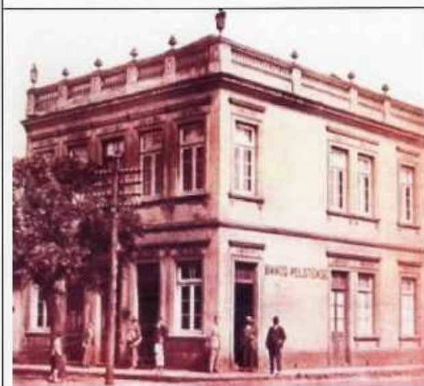
Carazinho prédio demolido
