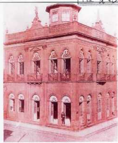
Jaguarão prédio demolido
