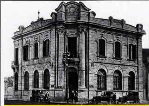
Alegrete prédio demolido
