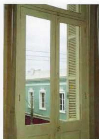
F16. Porta-janela de madeira e vidro com veneziana.
