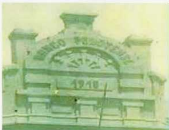
F2. Observa-se, no frontão, o provável ano da construção do prédio – 1918.
