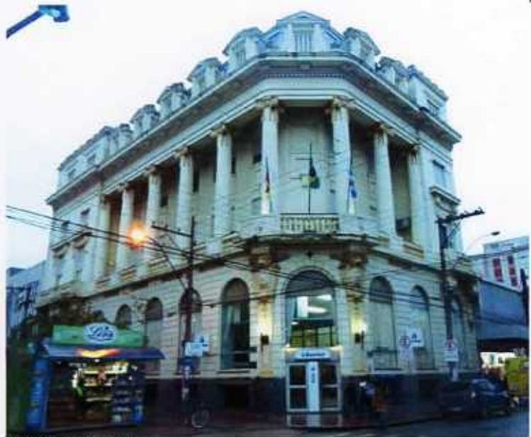
F23. Vista geral do prédio.
