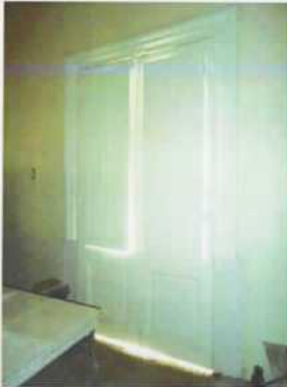
F12. Porta-janela da fachada - vista interna, 2013.
