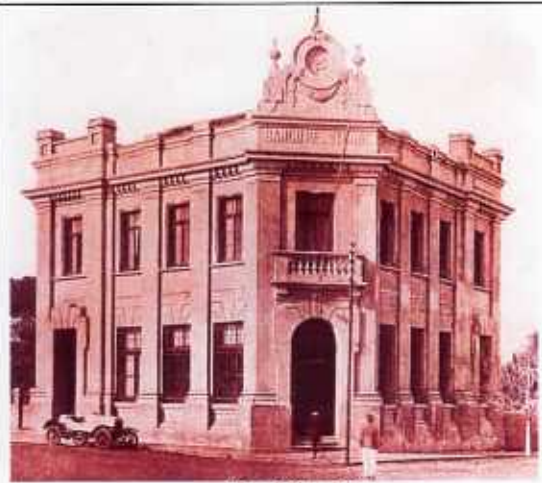
Rosário do Sul prédio demolido
