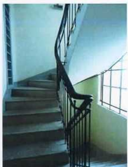
F17. Escada granítica – guarda-corpo de ferro com corrimão de madeira.
