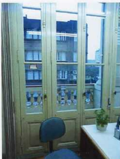
F18. Sala Administrativa segundo pav. – porta-janela de madeira/vidro, com persiana voltada para sacada.
