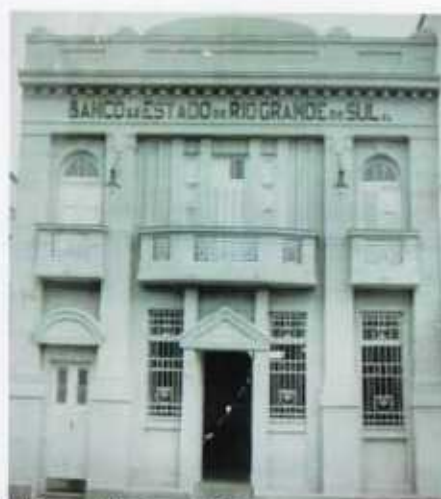
F3. Banco do Rio Grande do Sul no mesmo prédio, s/data.
