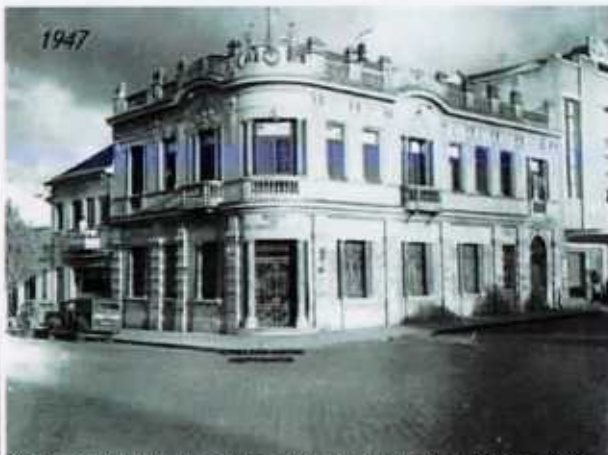
F3. Banco do Rio Grande do Sul no prédio do Antigo Banco Pelotense, 1947.
