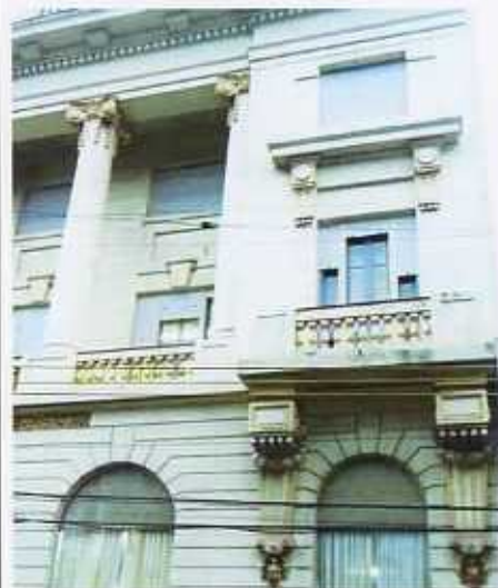
F26. Detalhes ornamentais fachada Marechal Floriano Paredes com rusticagem, capitéis, medalhões.
