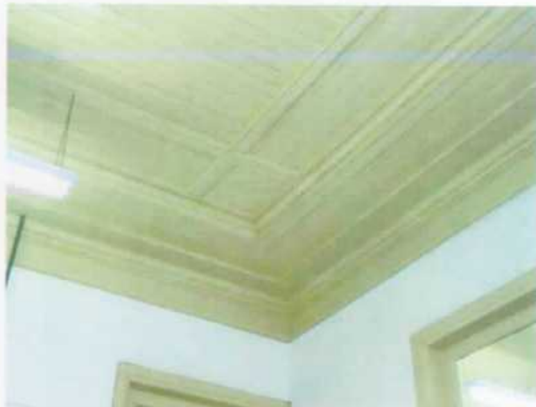
F11. Forro original em madeira - pavimento superior.
