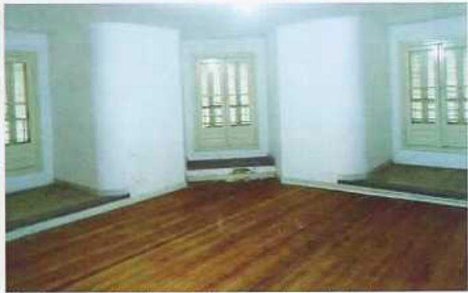
F21. Apartamento reformado – localizado na mansarda – janelas de abrir em madeira com venezianas.
