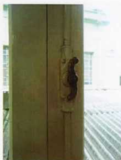
F15. Janela de madeira e vidro pavimento superior, ferragens originais.
