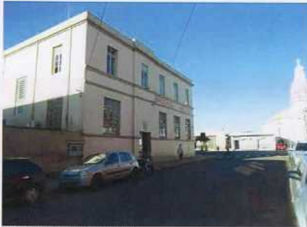
F4. Fachada Rua Paulo Aquino, 2014.
