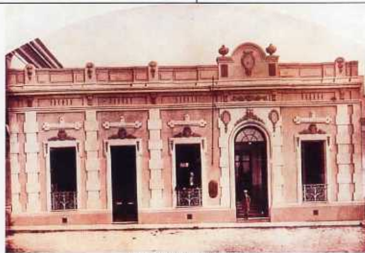
Santa Vitória do Palmar prédio demolido
