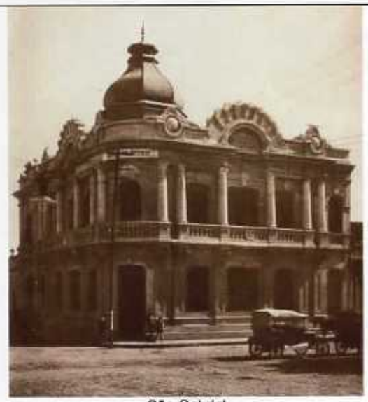
São Gabriel prédio demolido
