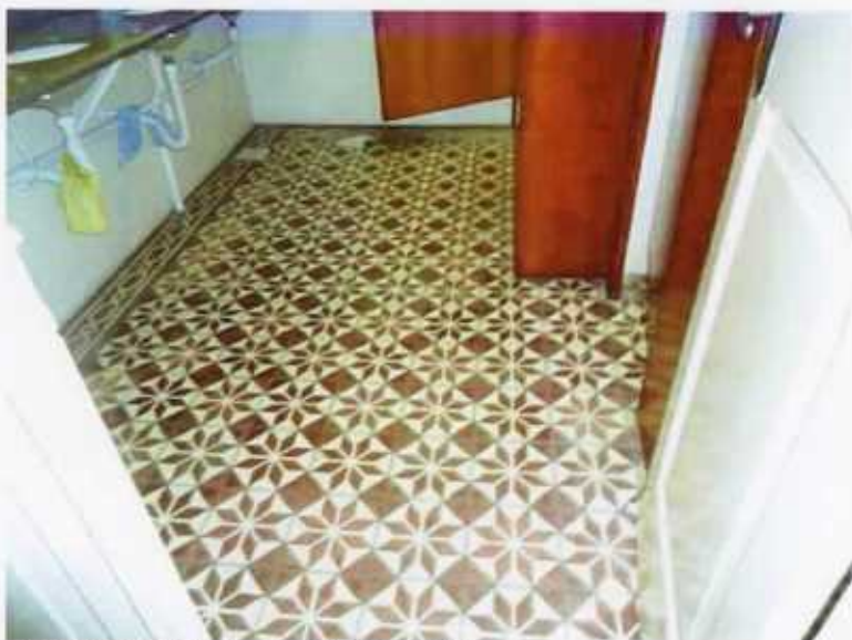
F12. Sanitário piso superior - piso de ladrilho hidráulico.
