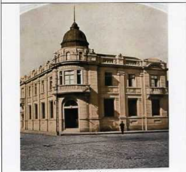
Santa Maria prédio demolido
