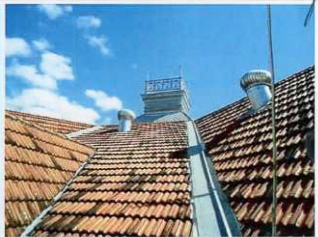
F8. Detalhe cobertura - telhado e cúpula com mirante ao fundo, 2013.
