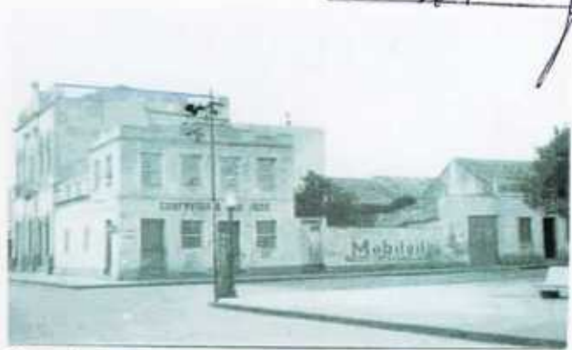
F3. Avenida 27 de Janeiro no sentido sul-norte. Banco Pelotense sem o mirante, s/data.
