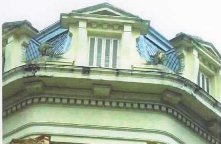
F25. Detalhe das mansardas e cobertura.
