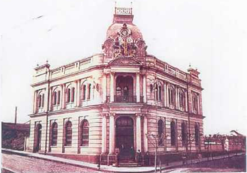
F2. Antigo Banco Pelotense. Rua Sete de Setembro esquina Av. Presidente Vargas, s/ data.
