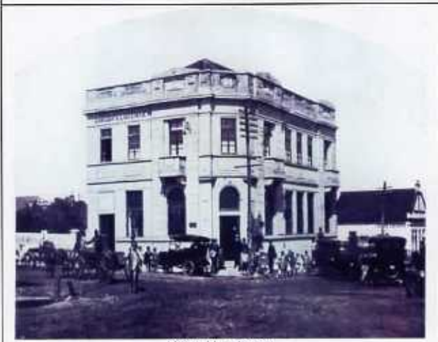
Novo Hamburgo prédio demolido
