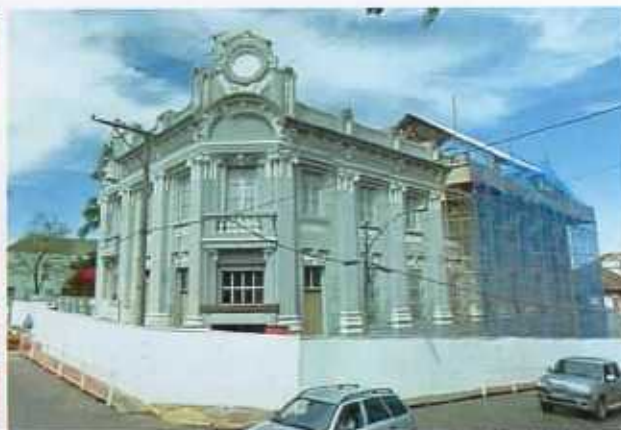
F18. Antigo Banco do Brasil, recentemente restaurado. Uso atual não definido, 2013.
