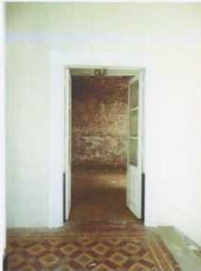
F15. Pisos de ladrilho hidráulico e portas provavelmente originais, 2013
