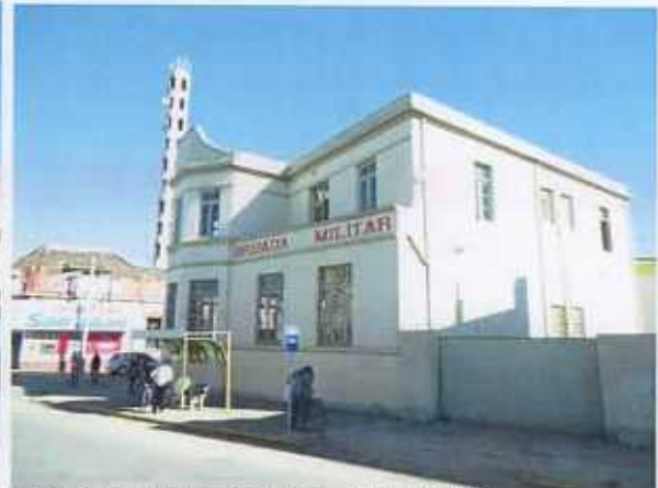
F5. Fachada Av. Vaz Ferreira e fachada lateral norte, 2014
