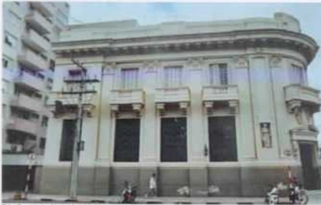
F3. Fachada lateral, s/data.
