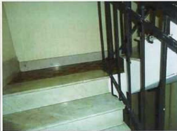
F20. Escada com degraus de mármore, guarda-corpo de ferro e corrimão, patamar com ladrilhos hidráulicos.
