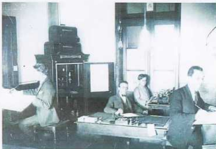
F1. Interior do Banco Pelotense de Ijuí, s/data.
