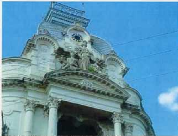
F7. Detalhe fachada - cúpula sobre acesso principal, 2013.
