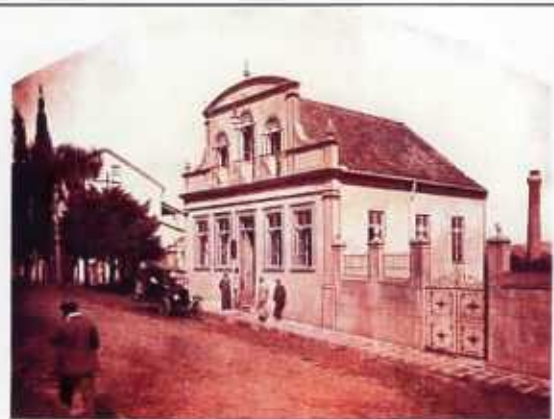
Estrela prédio demolido
