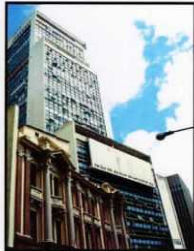
F19. Edifício Santa Cruz, 2013.
