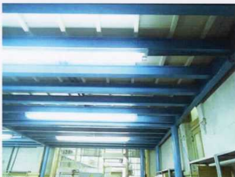
F8. Térreo – mezanino metálico, 2014.
