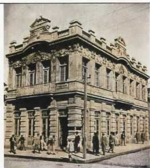
Caxias do Sul prédio demolido
