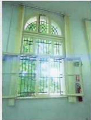
F11. Janela fachada lateral, interna.
