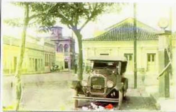
F2. Avenida 27 de Janeiro no sentido norte-sul. Banco Pelotense, ao fundo, à esquerda, s/data.
