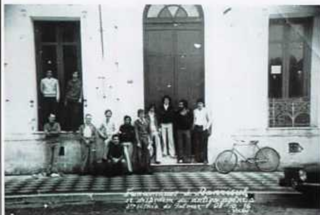
F2. Funcionários do Banrisul em frente ao prédio do Antigo Banco Pelotense, 08/10/1976.
