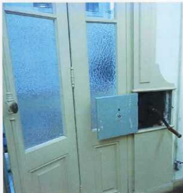
F19. Detalhe de porta – ferragens originais e manivela da persiana.
