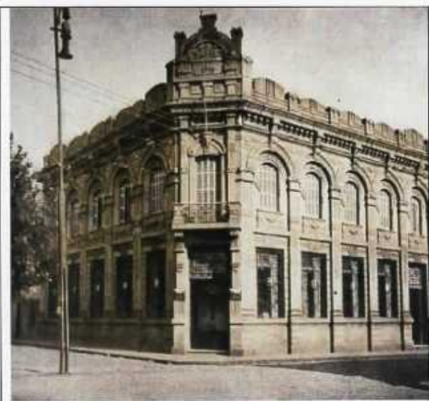
Cruz Alta prédio demolido
