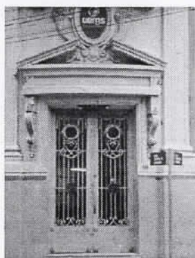
Porta de acesso principal
