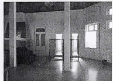
Interior da salão/refeitório da cobertura
