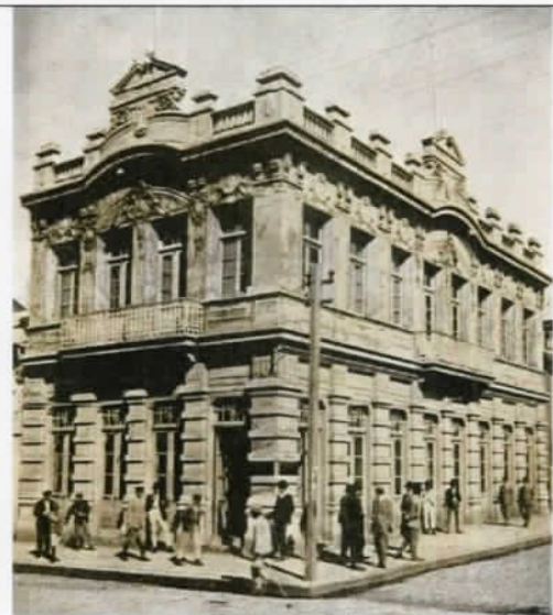
Caxias do Sul prédio demolido
