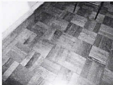
Piso de tacos em boas condições na sala de aula
