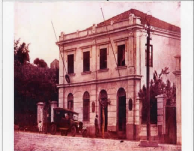
Bento Gonçalves - prédio demolido
