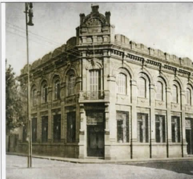
Cruz Alta prédio demolido
