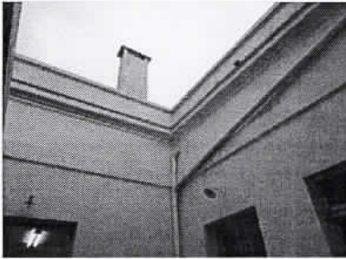
Área aberta interna 2º pavimento
