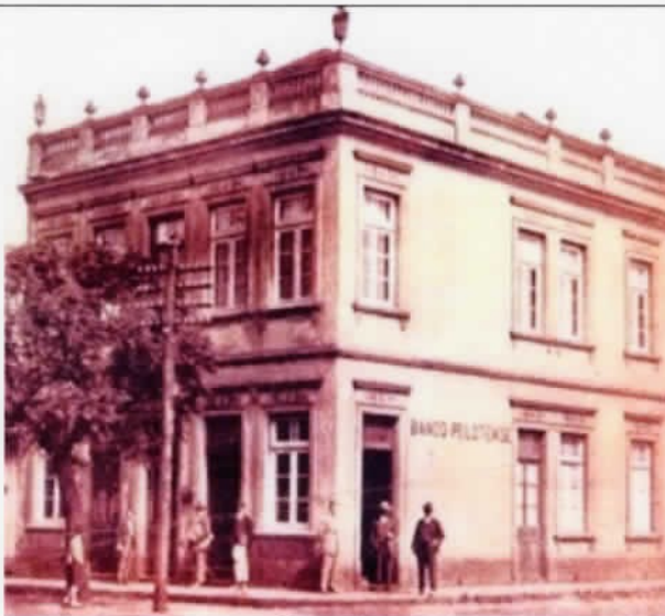
Carazinho prédio demolido
