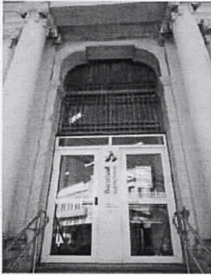
Porta de acesso principal ao prédio adaptada
