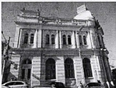
Vista Fachada Sudoeste
