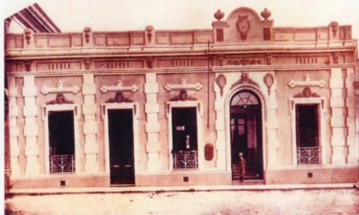
Santa Vitória do Palmar prédio demolido
