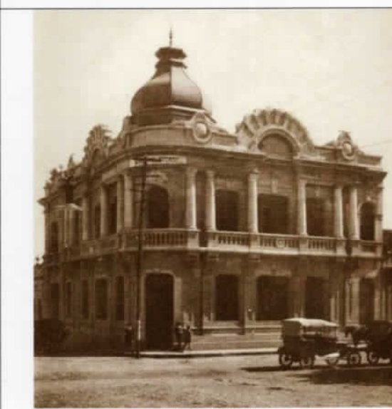
São Gabriel prédio demolido
