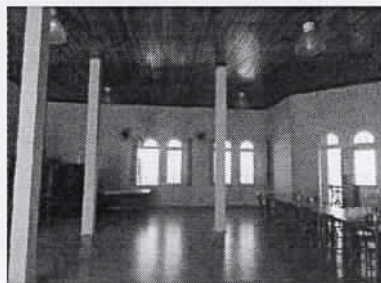
Interior da salão/refeitório da cobertura
