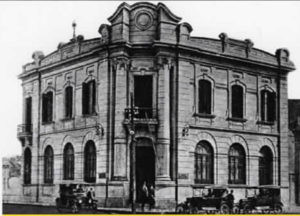
Alegrete prédio demolido
