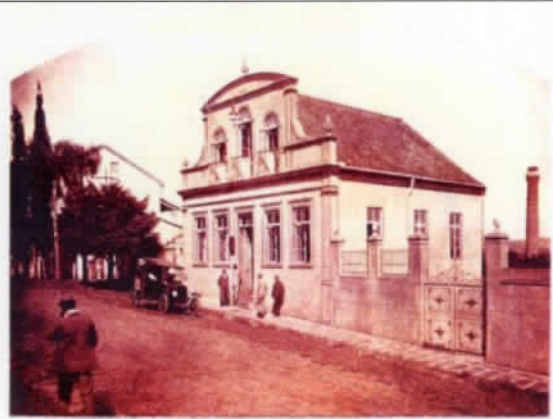
Estrela prédio demolido
