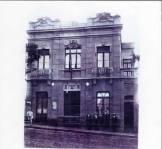
Passo Fundo - prédio demolido
