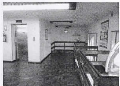
Vista elevador e acesso ao mezanino
