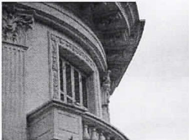
Vista em detalhe da sacada fachada
