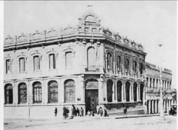
Bagé prédio demolido
