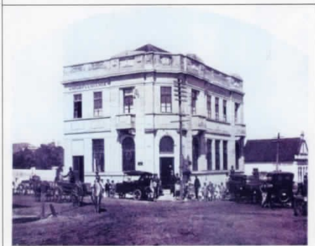
Novo Hamburgo prédio demolido
