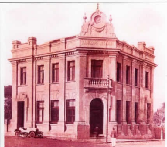
Rosário do Sul prédio demolido
