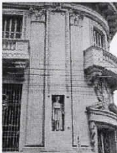
Vista parcial fachada Leste
