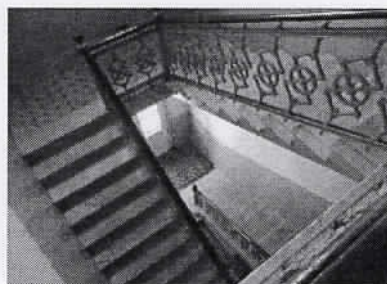
Escadaria de acesso à cobertura
