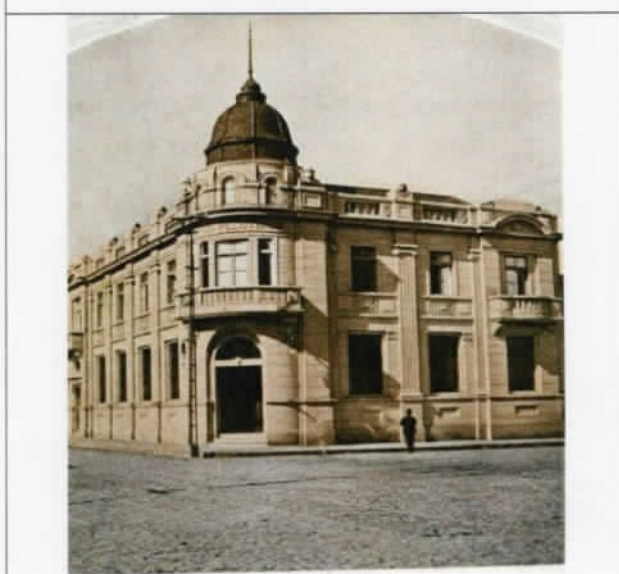
Santa Maria prédio demolido
