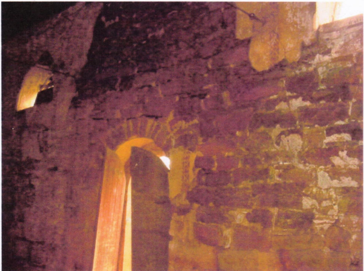
Vista Interna – Paredes
