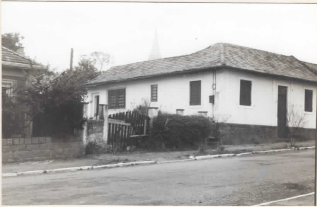
FOTO N.º 09 FACHADA DOS FUNDOS.
