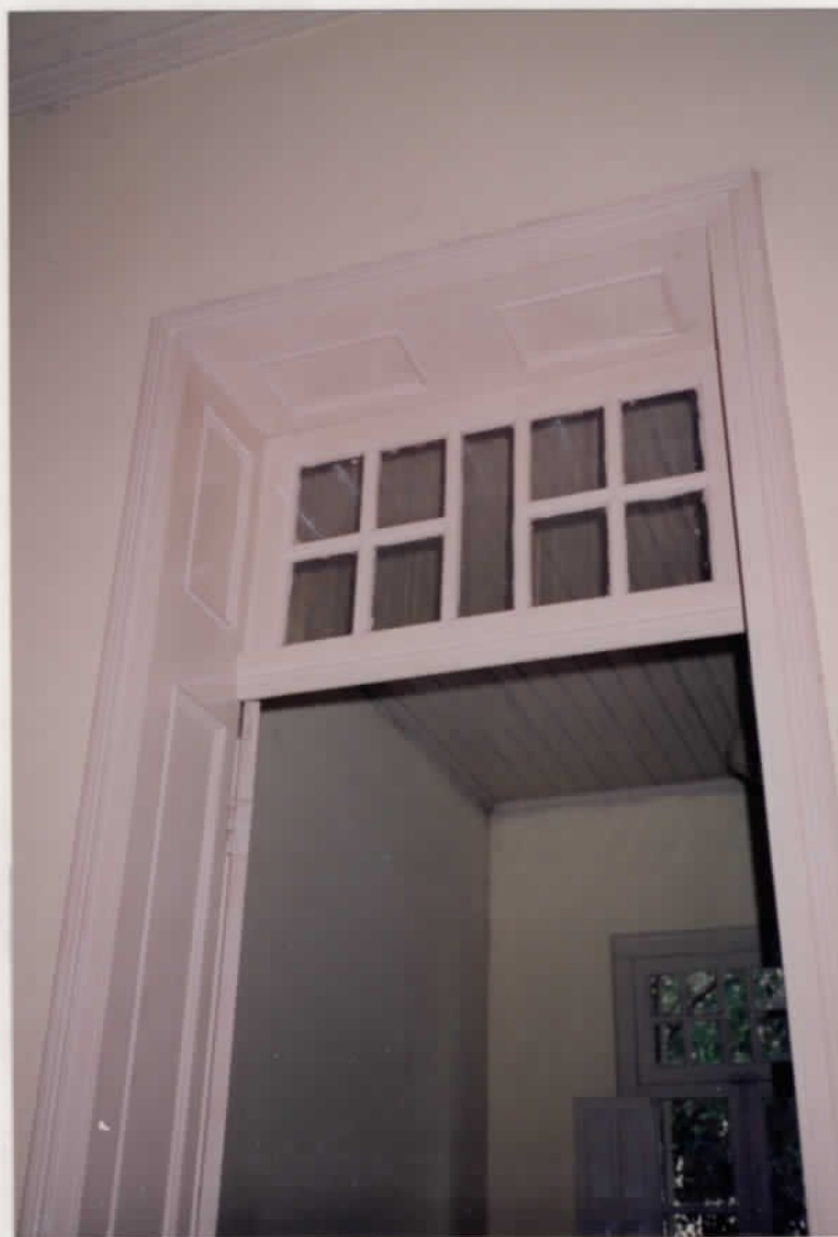
08 • DETALHE DO MARCO COM MOL- DURAS FRISADAS E DA BANDEIRA FIXA COM CAIXILHARIA DE VIDRO.
