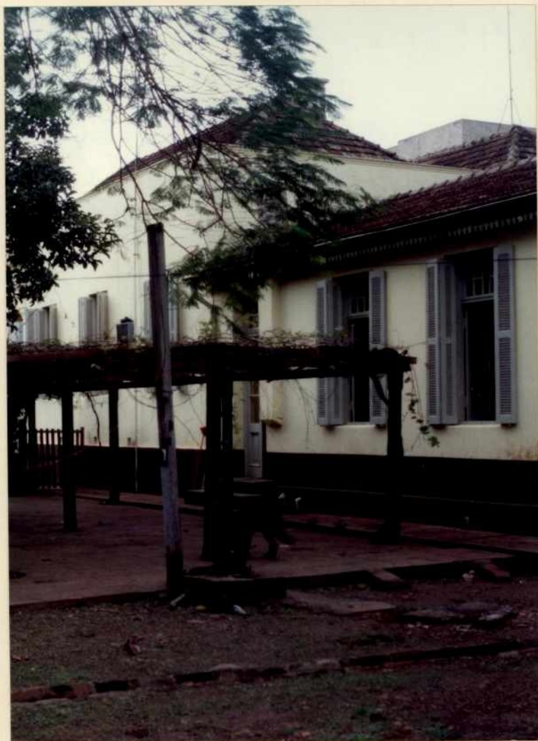
02-A • VISTA DA FACHADA LATERAL, ORIENTAÇÃO OESTE.
