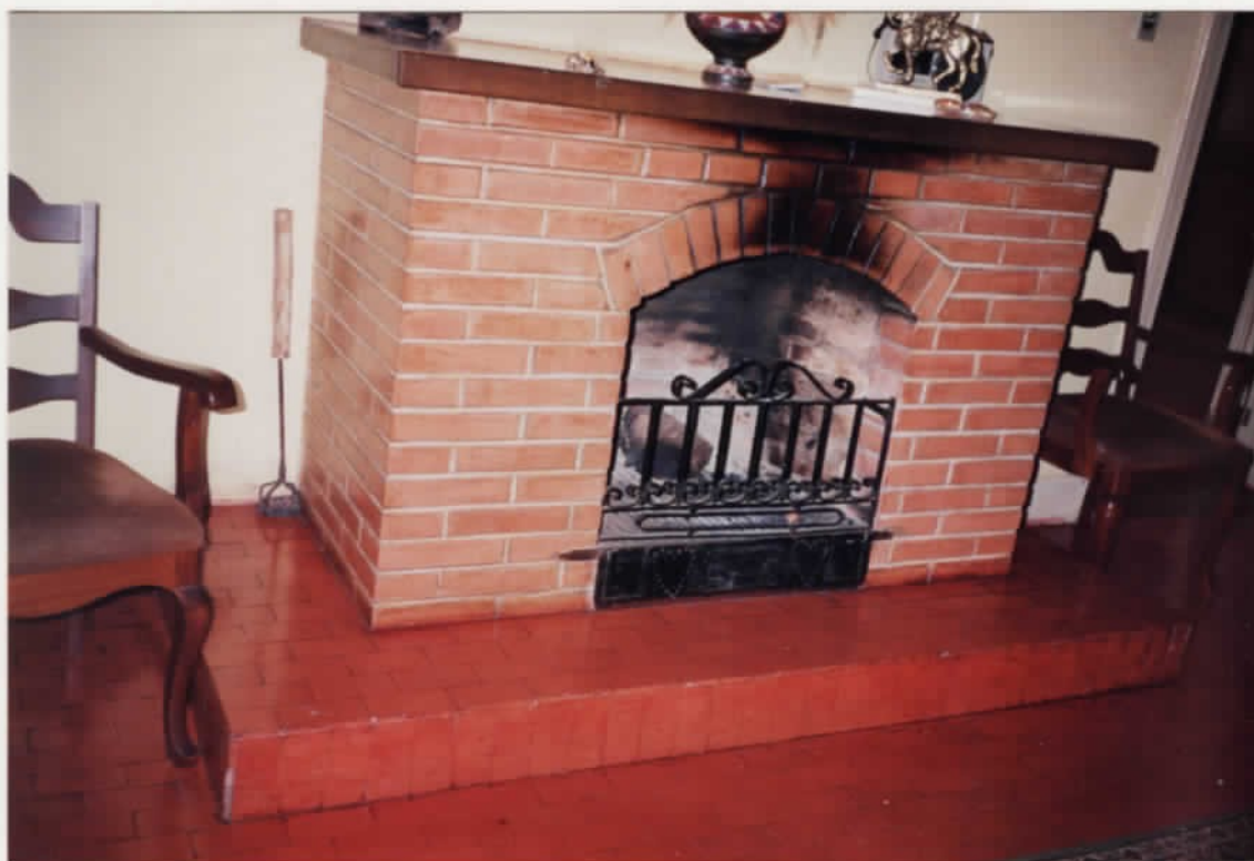
07 • VISTA DA LAREIRA CONSTRUÍDA POSTERIORMENTE E DETALHE DO PISO ENTÃO UTILIZADO.
