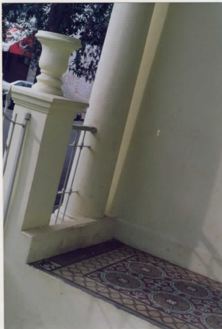
04 • VISTA DO PISO CERÂMICO DO ACESSO PRINCIPAL E DO MONTANTE DO PORTÃO QUE APOIA UM POTE DECORATIVO
