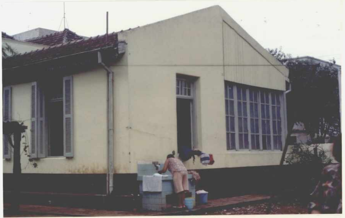
02 • VISTA DA FACHADA DE FUNDOS ; DETALHE DA EMPENA, BEIRAL E "JANELÃO"
