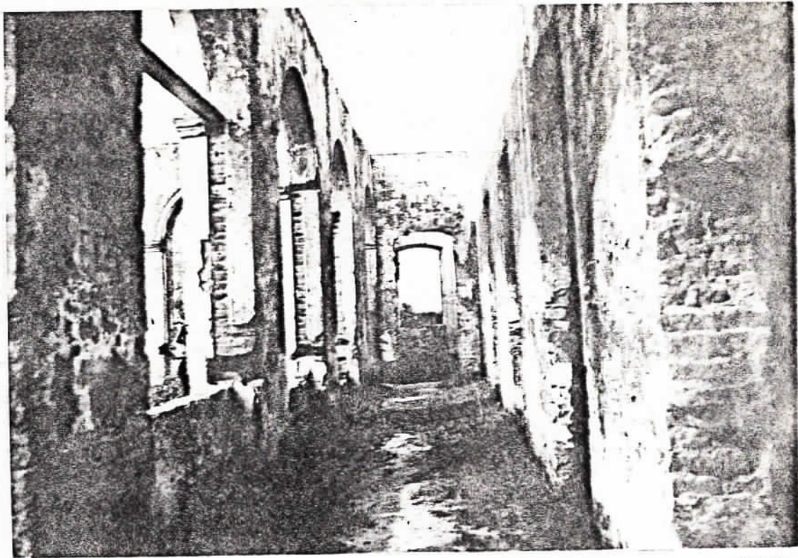
vista corredor ala frontal
