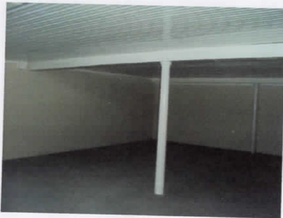
1 Forro de madeira tipo régua, com encaixe macho-fêmea.
