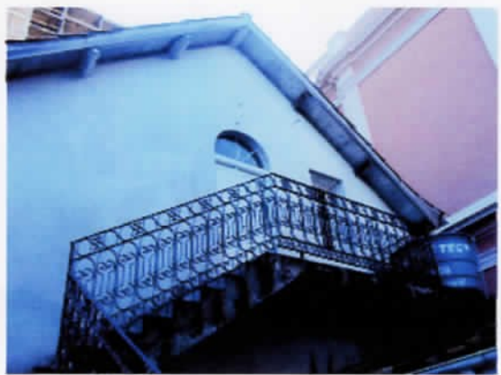
1 Escada de acesso do pátio interno ao pavimento superior.
