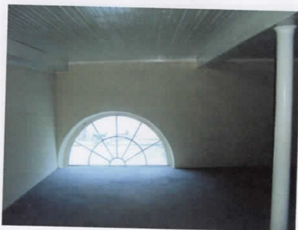
2 Bandeira fixa, em arco pleno com vidros transparentes.
