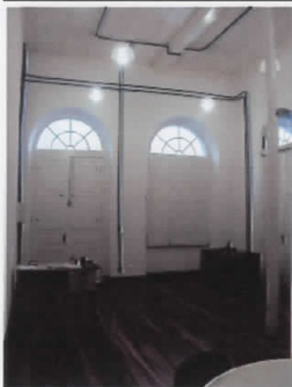
1 Esquadrias de madeira com bandeira fixa e acabamento em tinta branca.
