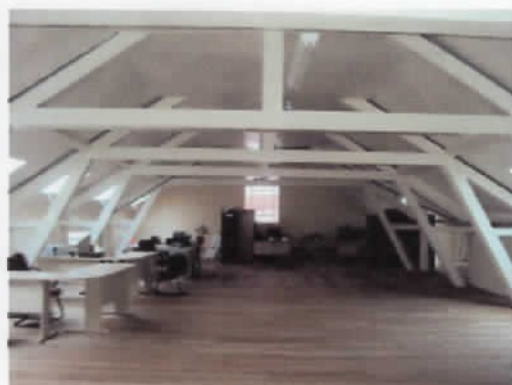
3 Telhado com estrutura de madeira aparente.
