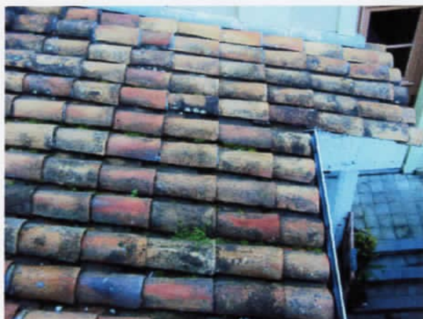
2 Telhamento em telhas cerâmicas tipo Capa e canal.
