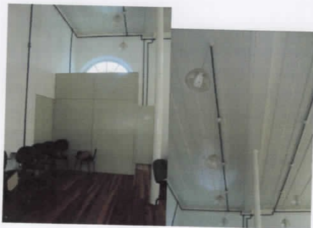
2 Forro tipo saia e camisa, em madeira, acabamento em tinta branca.
