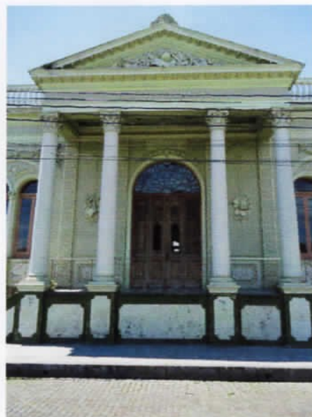
3 Detalhe do pórtico de acesso.
