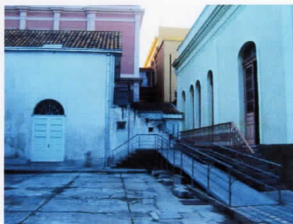
3 Pátio interno entre o anexo e o prédio sede. Detalhe da rampa e escada.
