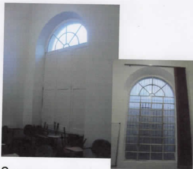
2 Esquadrias em madeira e ferro.
