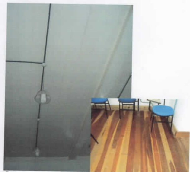
3 Forro tipo saia e camisa, em madeira, acabamento em tinta branca e piso de madeira.
