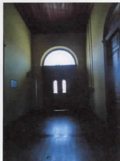
3 Piso em tábuas de madeira, sem acabamento. Paredes de alvenaria de tijolos maciços e argamassa com acabamento em reboco liso.
