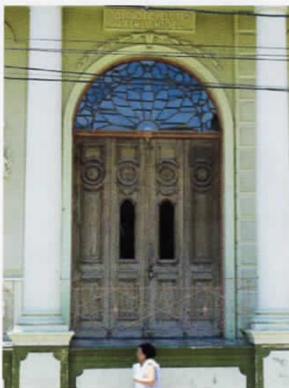
3 Porta de quatro folhas, em madeira, acabamento em verniz e bandeira fixa em arco pleno.
