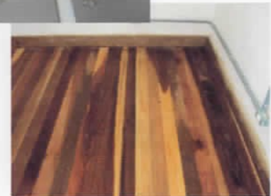
3 Sala 2: Forro tipo saia e camisa, em madeira, acabamento em tinta branca. Piso em madeira
