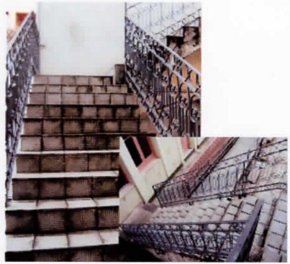
3 Revestimento dos degraus em ladrilho hidráulico.
