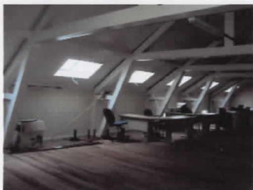
2 Piso em madeira.
