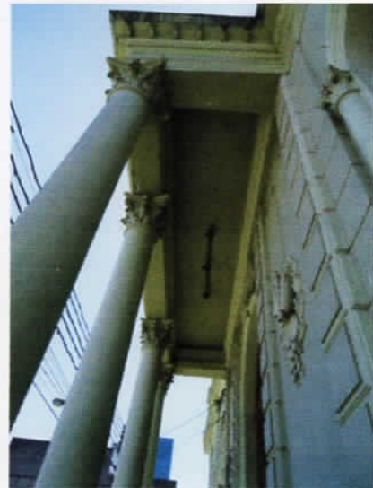
2 Forro em laje de concreto e acabamento em tinta. Pé-direito de 5,85 metros.
