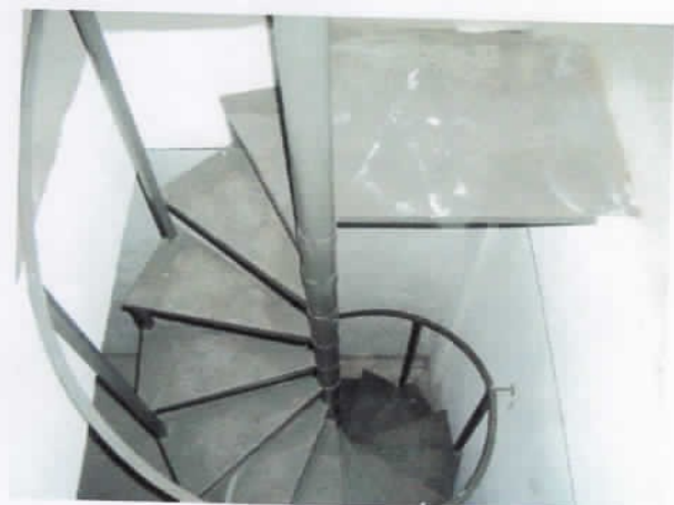
3 Acesso por escada helicoidal em ferro.
