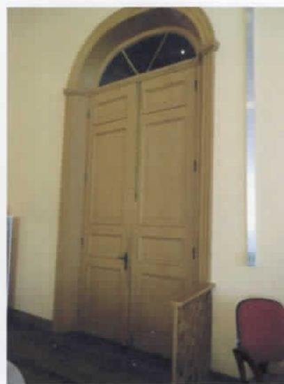
3 Paredes em alvenaria de tijolos maciços e reboco liso. Função estrutural e vedação.
