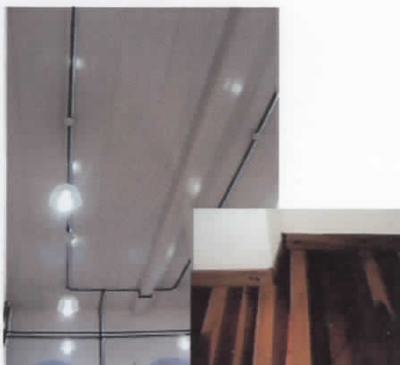
3 Forro em madeira tipo saia e camisa e piso em madeira.
