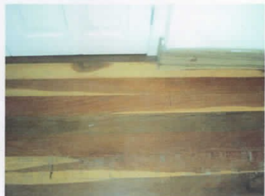
4 Piso de madeira
