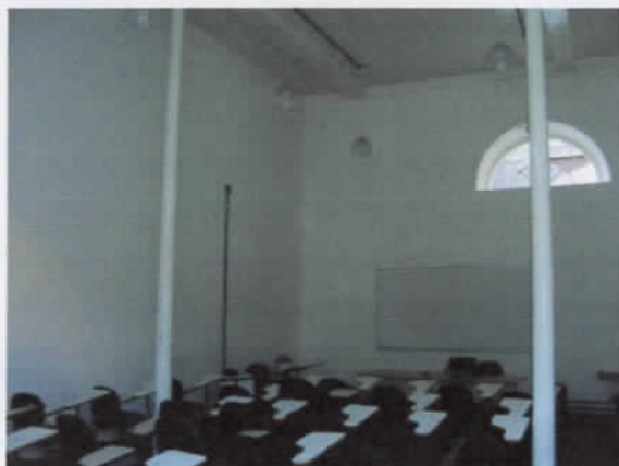
3 Forro tipo saia e camisa, em madeira, acabamento em tinta branca.
