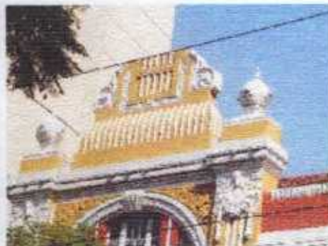
Corpo lateral mais elevado com platibanda em forma de lira estilizada
