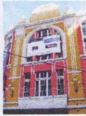
No mesmo módulo lateral à esquina, janela com verga reta (2º piso) e em arco pleno (3º e 4º pisos)
