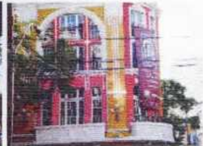
Corpo lateral: Janelas do 2º e 3º pisos em verga reta e em arco no 4º piso
