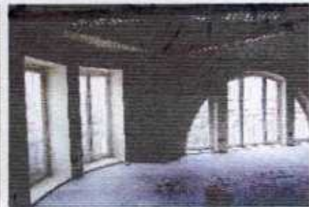
Vista interna das esquadrias do 4º piso: janelas com verga reta no módulo de esquina e em arco nos módulos laterais
