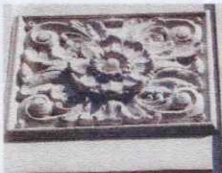
Elemento ornamental em massa entre as janelas do 2º e 3º pavimentos
