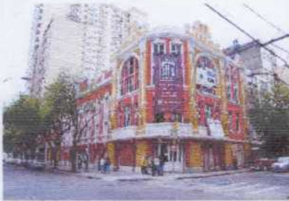
Vista atual do prédio – 2006
