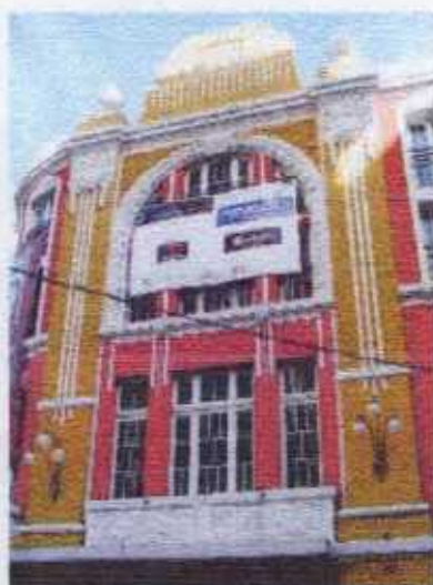
Módulo contíguo à esquina com platibanda, grande janela em arco e molduras, pilastras com luminárias e ornamentos
