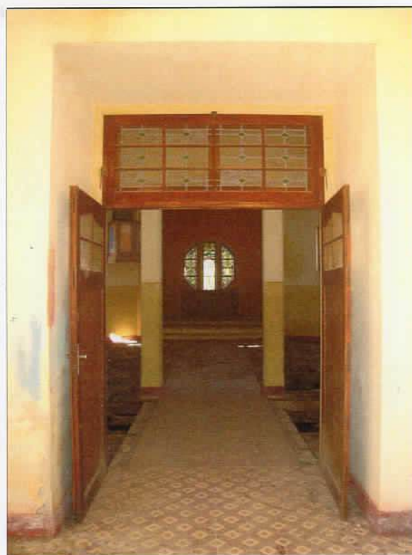
DESCRIÇÃO Porta que liga o hall da Igreja à nave central.
