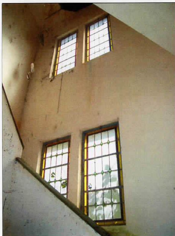
DESCRIÇÃO Escada de acesso ao coro.
