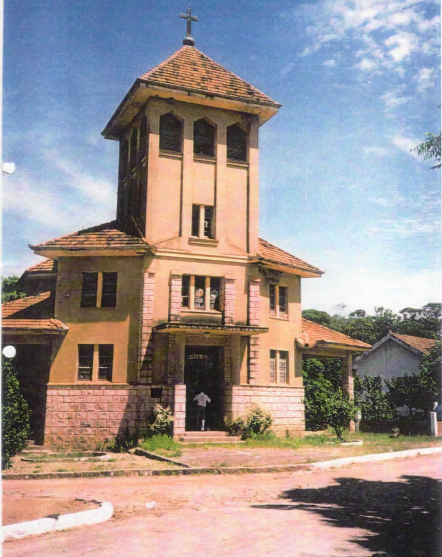
VISTA FRONTAL DA IGREJA EVANGÉLICA, ÚLTIMO PROJETO DO ARQUITETO ALEMÃO THEO WIEDERSPHAN - DESATIVADA
