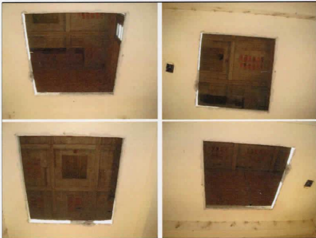
DESCRIÇÃO Vista da estruturação da cobertura.
