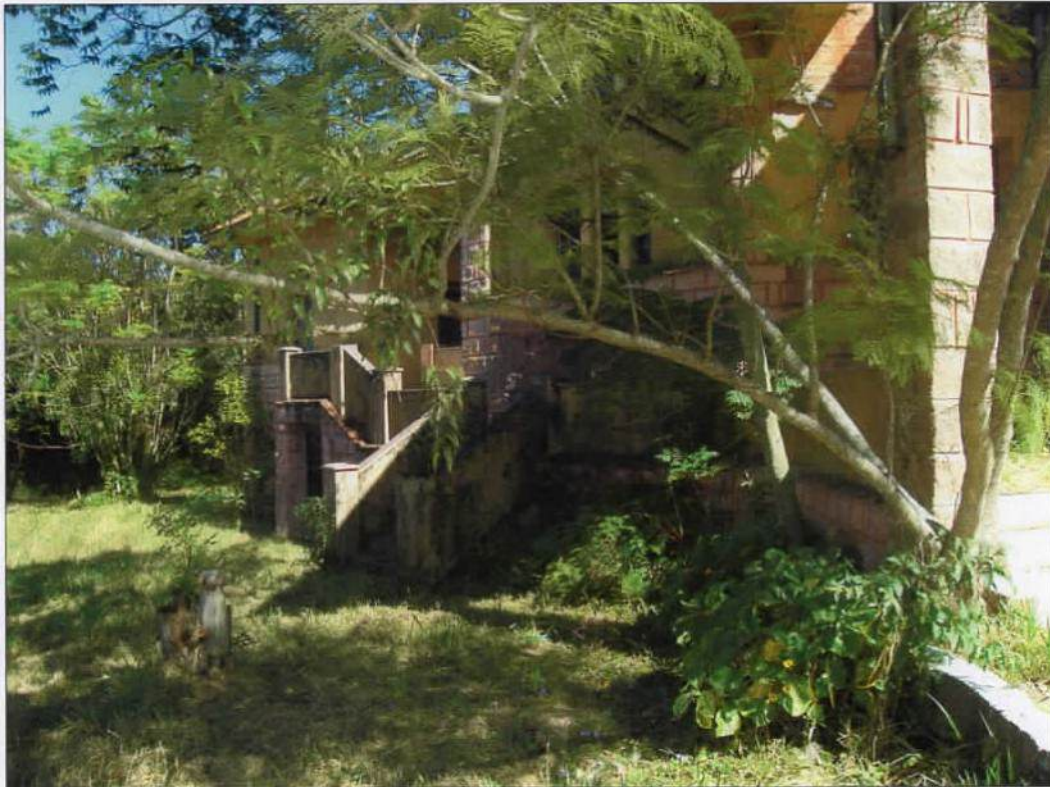
DESCRIÇÃO Vista lateral da Igreja e situação do entorno imediato.
