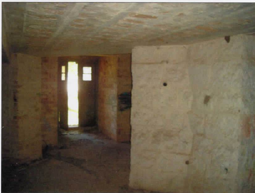
DESCRIÇÃO Pilares estruturadores da edificação.
