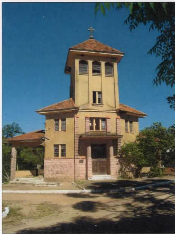
DESCRIÇÃO Vista da fachada principal da Igreja Evangélica.
