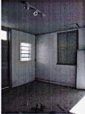
4 Segundo Pavimento - Sala 7
