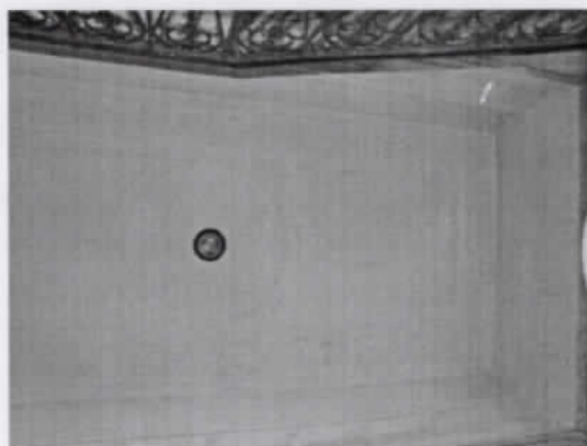
3 Vista do forro da Sala 1 - Pavimento Térreo
