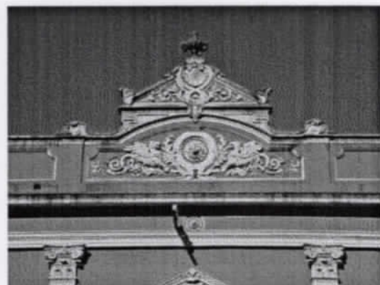
4 Frontão da Fachada Norte
