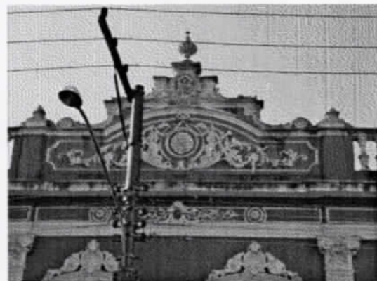
4 Frontão da Fachada Leste
