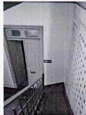
4 Segundo Pavimento - Sala 4 - Escada que dá acesso à sala 26 no Pavimento Térreo
