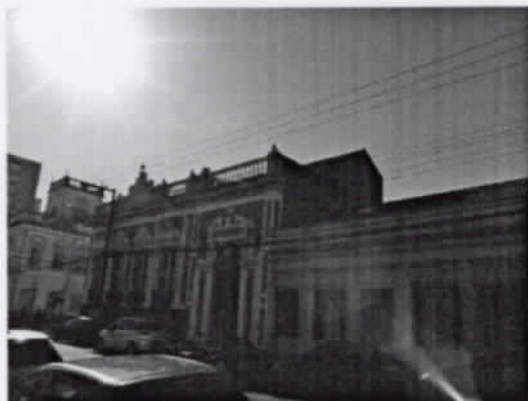
2 Fachada Oeste e Fachada Sul
