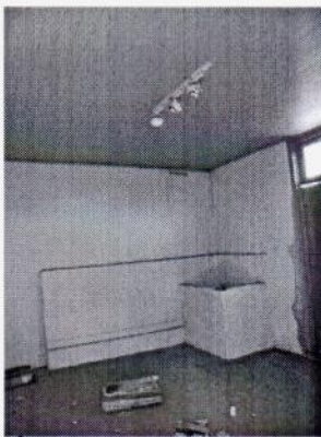
1 Segundo Pavimento - Sala 7
