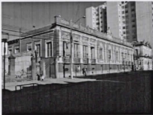
1 Fachada Norte e Fachada Oeste
