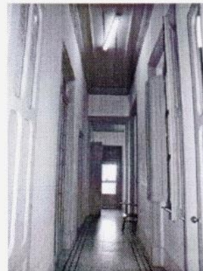
4 Pavimento Térreo - Corredor 16/17
