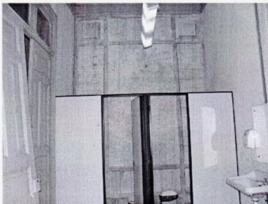
3 Pavimento Térreo - Sala 21
