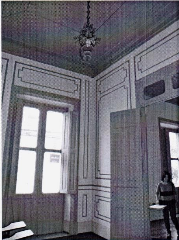
1 Pavimento Térreo - Sala 2
