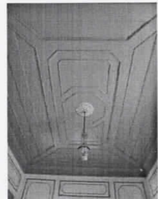
4 Vista do forro da Sala 4 - Pavimento Térreo
