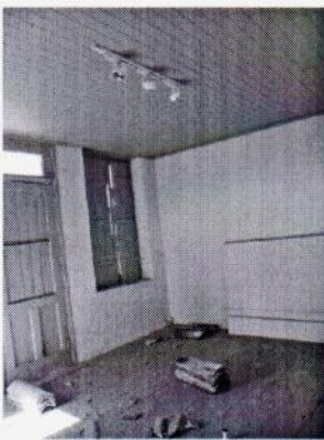
2 Segundo Pavimento - Sala 7
