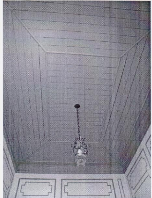
2 Pavimento Térreo - vista do forro da Sala 2
