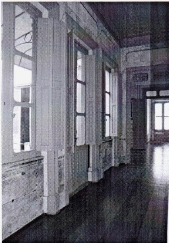
1 Pavimento Térreo - Corredor 23
