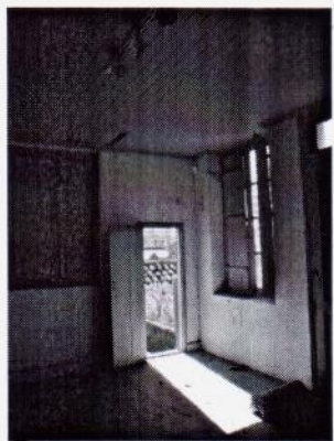
3 Segundo Pavimento - Sala 7
