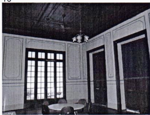
3 Pavimento Térreo - Sala 11 com vista da Sala 10 ao fundo
