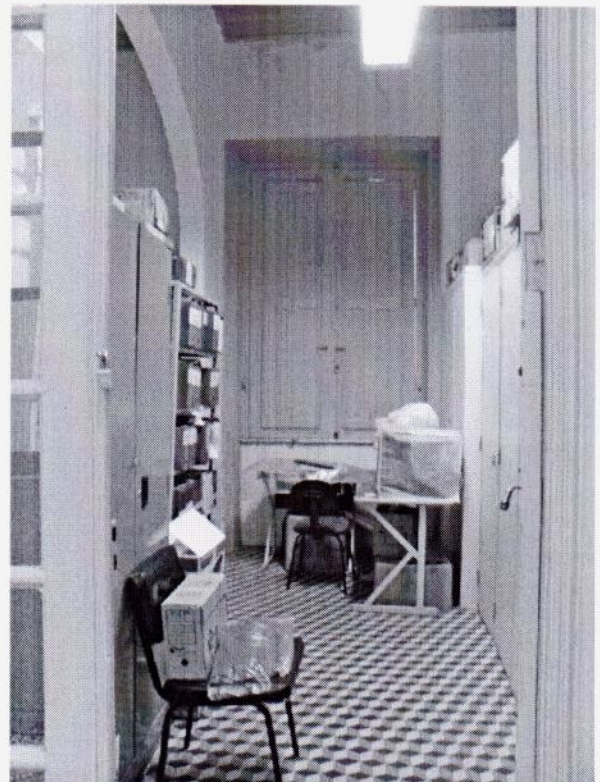
2 Pavimento Térreo - Sala 14
