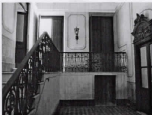
1 Pavimento Térreo - Sala 1
