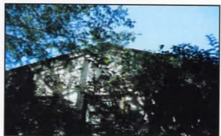
Fachada Norte Atual
