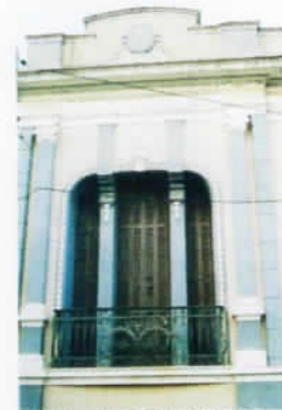
DETALHE FACHADA: PORTA-JANELA COM VENEZIANAS E SACADA COM GRADIL DE FERRO
