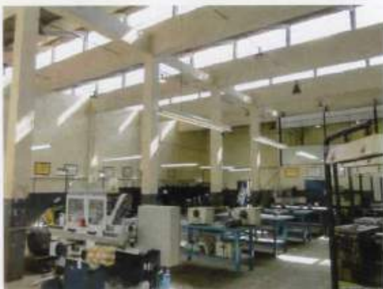
Vista interior do prédio – área utilizada pelo SENAI
