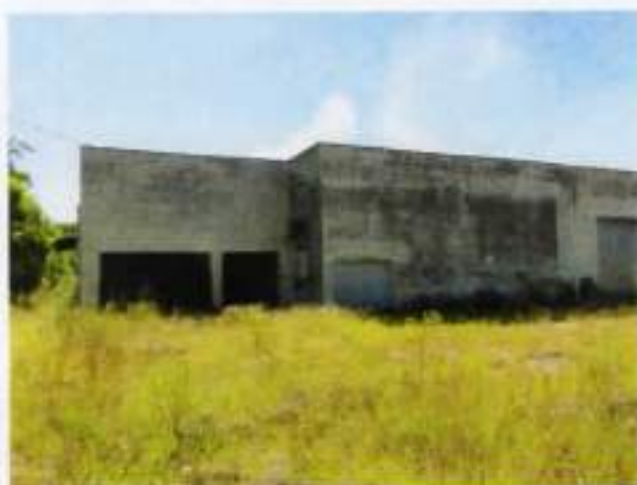
Vista lateral do prédio
