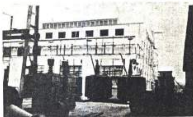
MARÇO DE 1957 - sequência da montagem da subestação da Usina de Candioti I.
