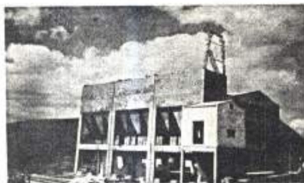
NOVEMBRO DE 1957 - vista da Usina de Candioti I, já praticamente no final de construção do prédio e montagem.
