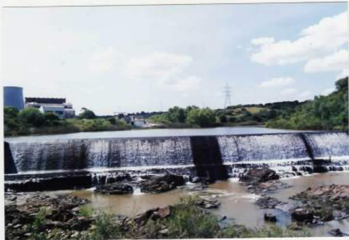
Junto à Usina, a barragem continua sendo usada pela Fase A e B da Usina Presidente Médici e abastecimento das hidráulicas da Vila Residencial.
