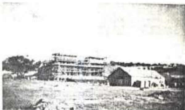
NOVEMBRO DE 1956 - Construção do prédio da Usina de Candiota I. pela Empresa Construtora Ernesto Voebcke S/A.
