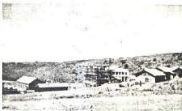
NOVEMBRO DE 1956 - sequência da construção do prédio da Usina de Candiota I, vendo-se os depósitos de material e escritório da Empresa Ernesto Voebcke S/A.
