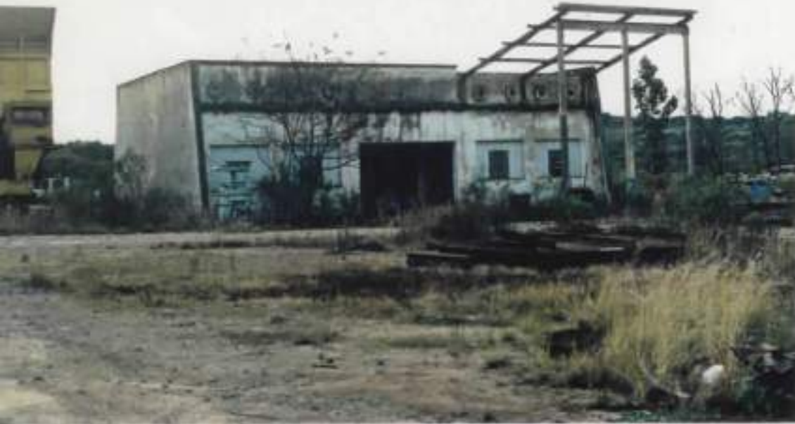
VISTA DOS PRÉDIOS QUE COMPÕE A ÁREA USO-OFICINAS
