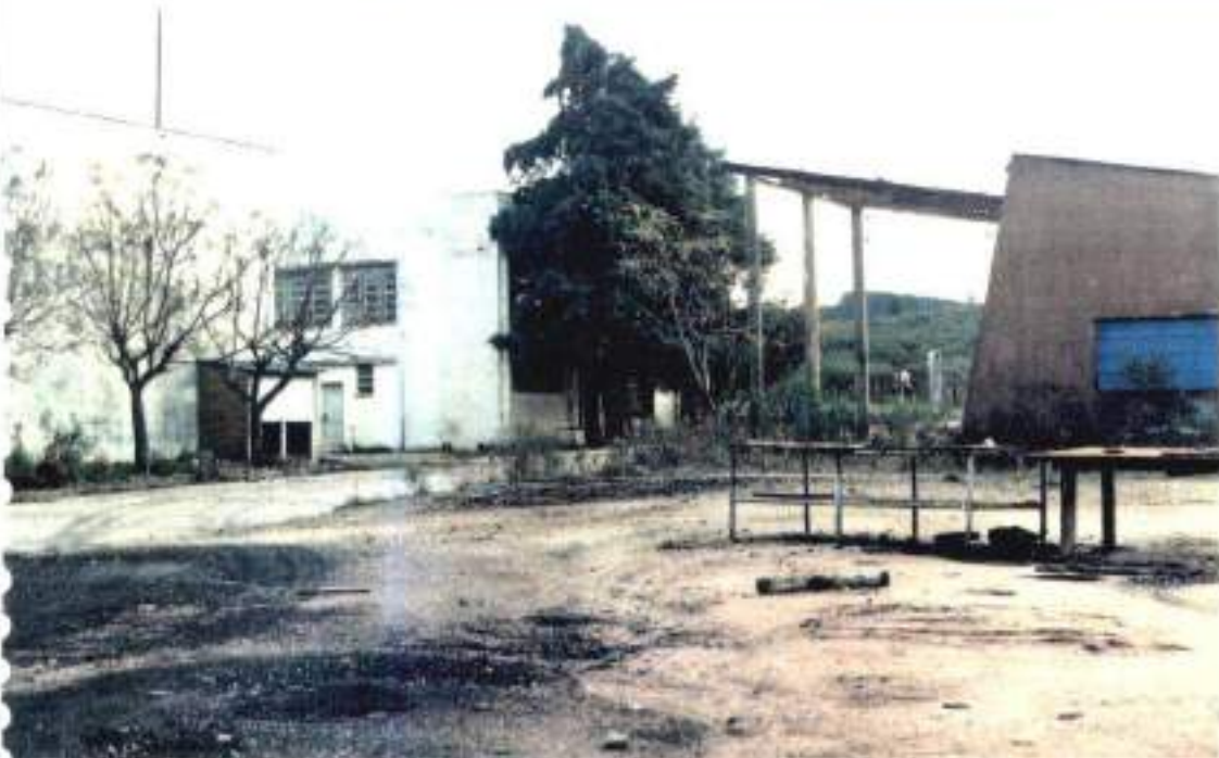
VISTA LATERAL PRÉDIO ADMINISTRATIVO E OFICINA
