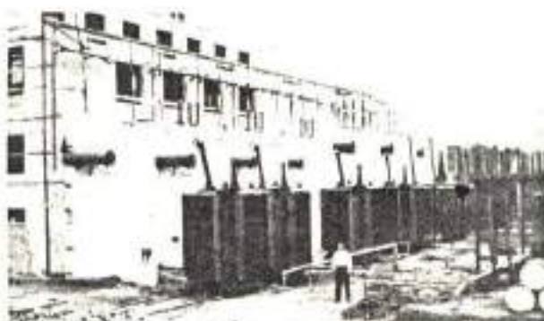
FEBREIRO DE 1957 - fase de continuação da montagem da Subestação da Usina de Candiota I, vendo-se na fotografia o Sr. Walter de Souza então funcionário do INEP.
