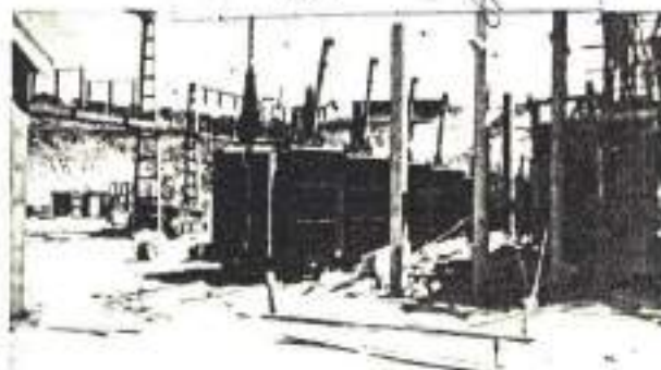
DEZEMBRO DE 1956 - início da montagem da Subestação da Usina de Candiota I.
