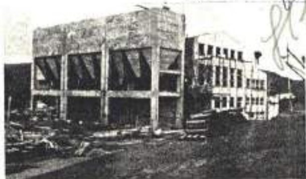
FEVREIRO DE 1957 - etapa conclusiva das obras de construção do prédio da Usina de Candioti I vedando-as, em primeiro plano, os pilares de carvão.
