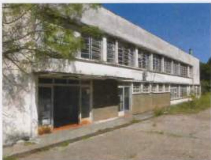
Vista da entrada do prédio
