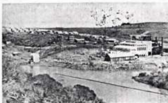
Dezembro de 1957 - Vista parcial da Usina de Candiota I, Vila Residencial, arroio Candiota e casa de bombas da barragem.
