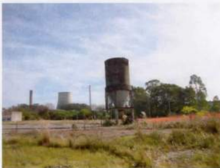
Foto do silo
