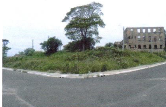
2 Prédio Principal - Rua G e Rua A
