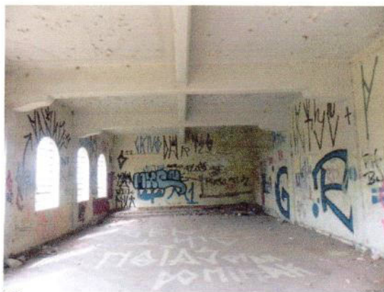
3 Prédio 1 - pavimento térreo - Capela
