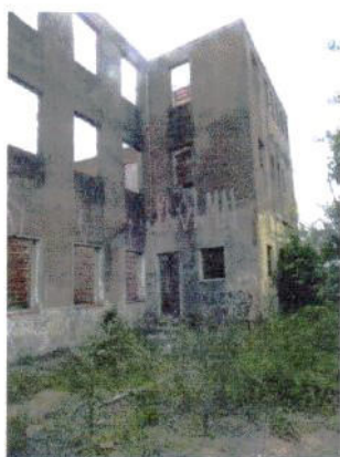
1 Prédio Principal - junho/2012
