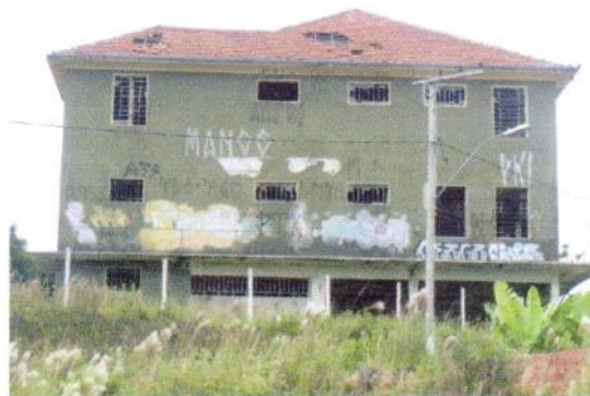
2 Prédio 1 - fachada sudoeste
