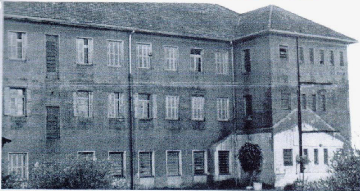
O Seminário em completo abandono, em março de 2005
