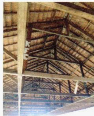
4 Pavimento Superior - Cobertura aparente - estrutura de madeira e telhas francesas
