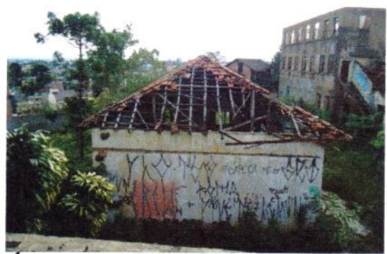
4 Prédio 3 - Antiga Lavanderia - Fachada cega sudeste
