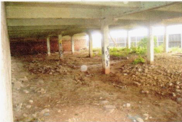
1 Prédio 1 - Subsolo - pilotis
