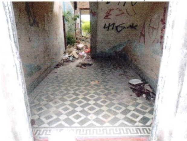
1 Prédio Principal - Saguão com piso de ladrilho hidráulico
