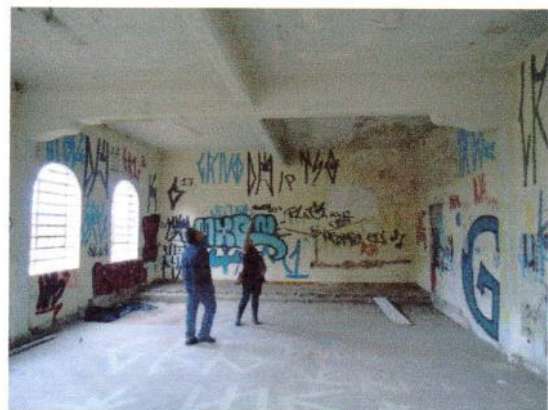
4 Prédio 1 - pavimento térreo - Capela
