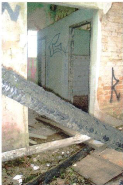
1 Prédio Principal - Vestiário
