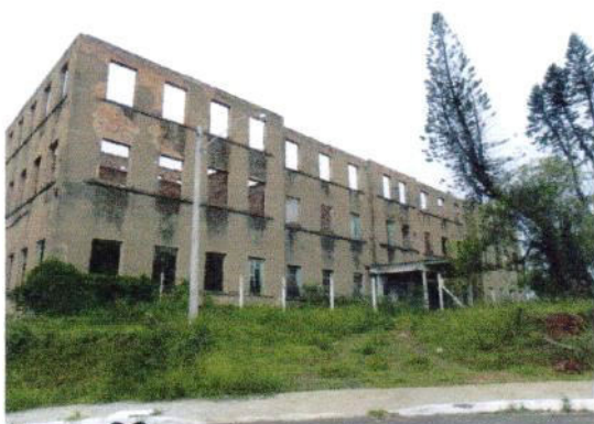
3 Prédio Principal - Fachada frontal e acesso
