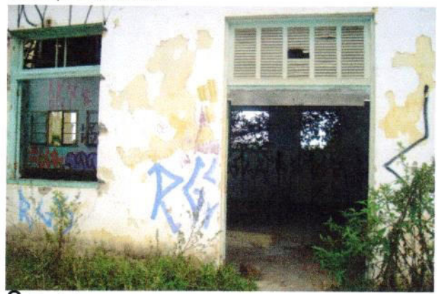
3 Prédio 3 - Antiga Lavanderia
