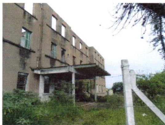
2 Prédio Principal - Cobertura de acesso
