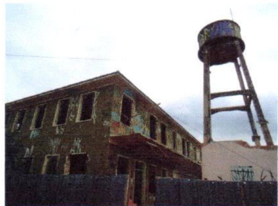
2 Prédio 1 e Caixa d'água
