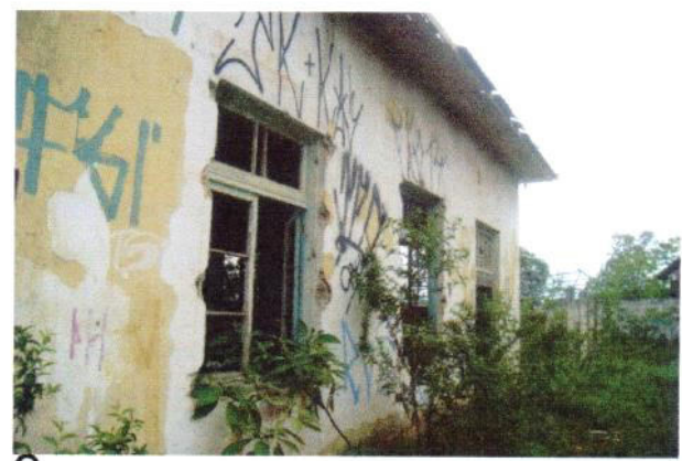
2 Prédio 3 - Antiga Lavanderia
