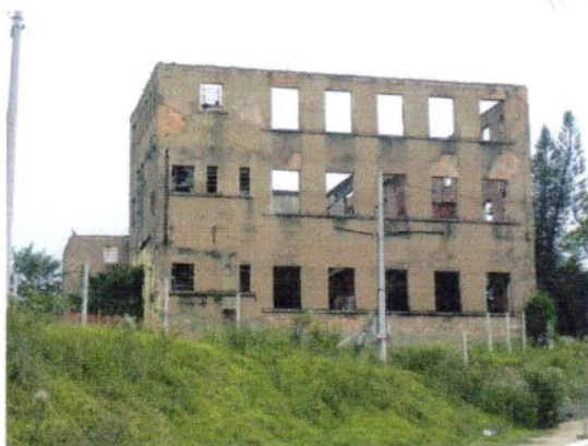
1 Prédio Principal - Fachada lateral nordeste
