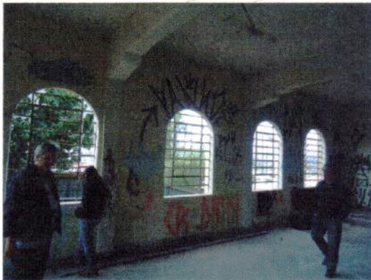
1 Capela - Pavimento Térreo
