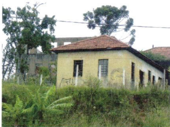
3 Prédio 5 - Fachada sudoeste
