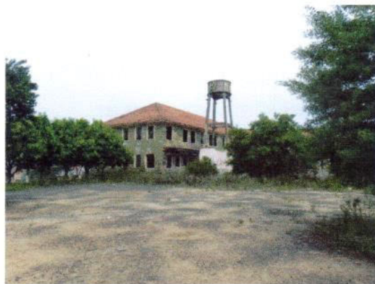
4 Prédio 1 e Caixa d'água
