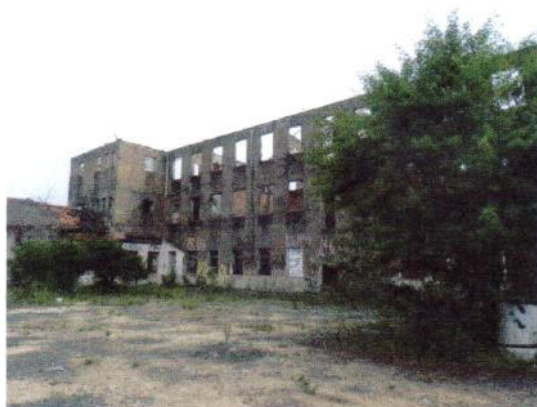
4 Prédio Principal - Parte do Prédio 4
