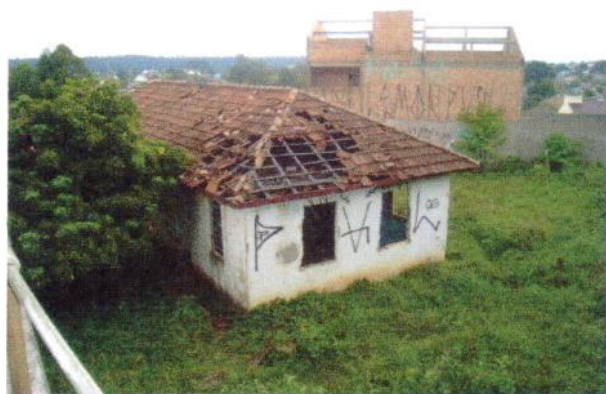
2 Prédio 5 - Fachada Nordeste
