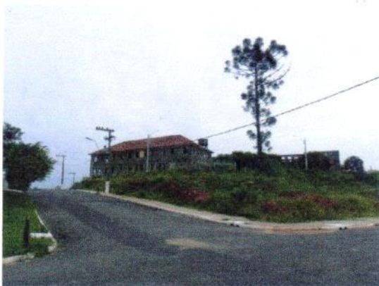
1 Prédio 1 e Prédio Principal - Rua B
