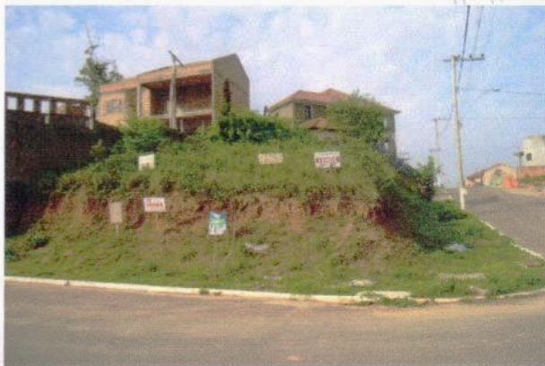
1 Entorno - Foto tirada da esquina das ruas D e B
