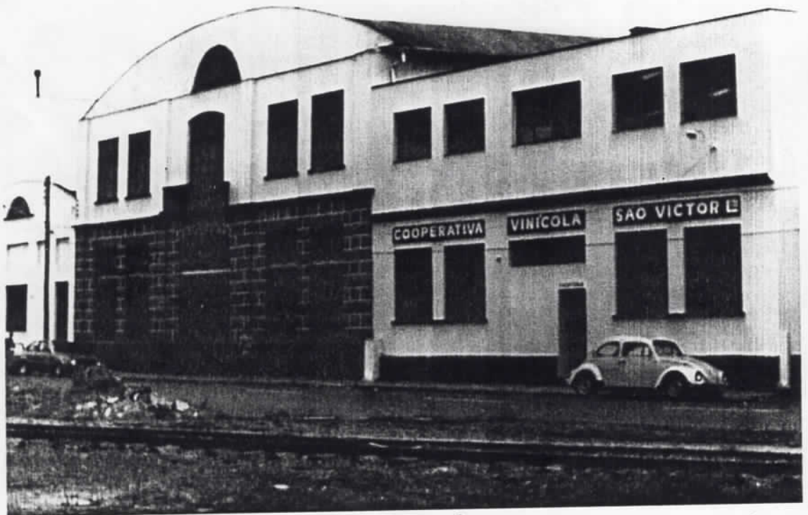
rua Augusto Pestana: entrans que necessita compor com a Estação Férrea.
