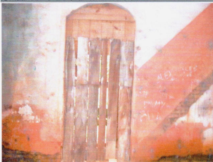
Foto: Interior do Sobrado
