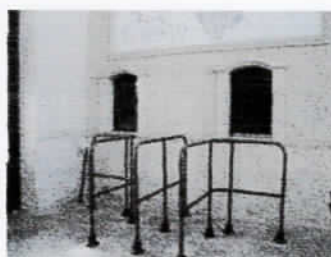
Guarda corpo metálico
